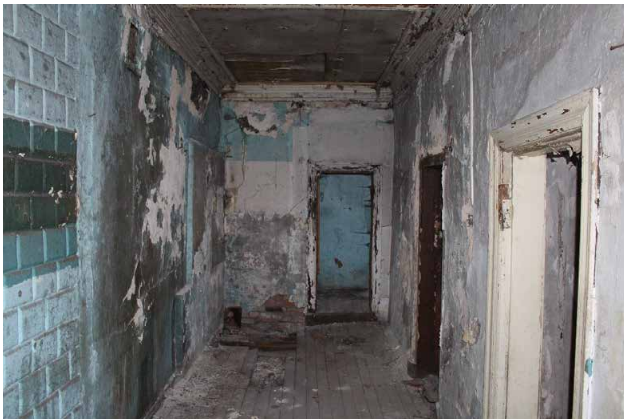
Фото 16. Объект культурного наследия регионального значения «Жилой дом (деревянный двухэтажный)». Внутренние помещения 1-го этажа.
