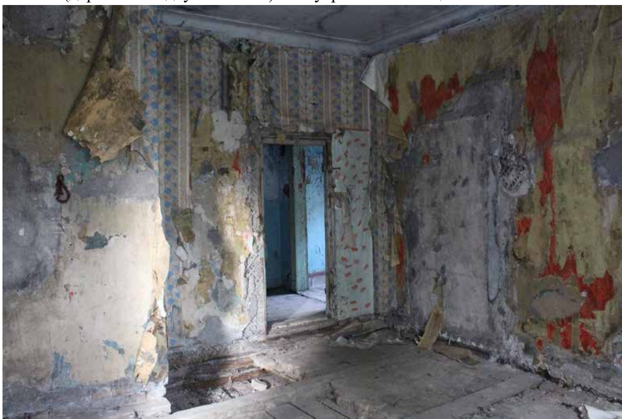
Фото 70. Объект культурного наследия регионального значения «Жилой дом (деревянный двухэтажный)». Внутренние помещения 2-го этажа.
