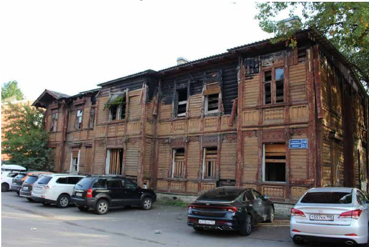
Фото 1. Вид на северный фасад объекта культурного наследия регионального значения «Жилой дом (деревянный двухэтажный)».
