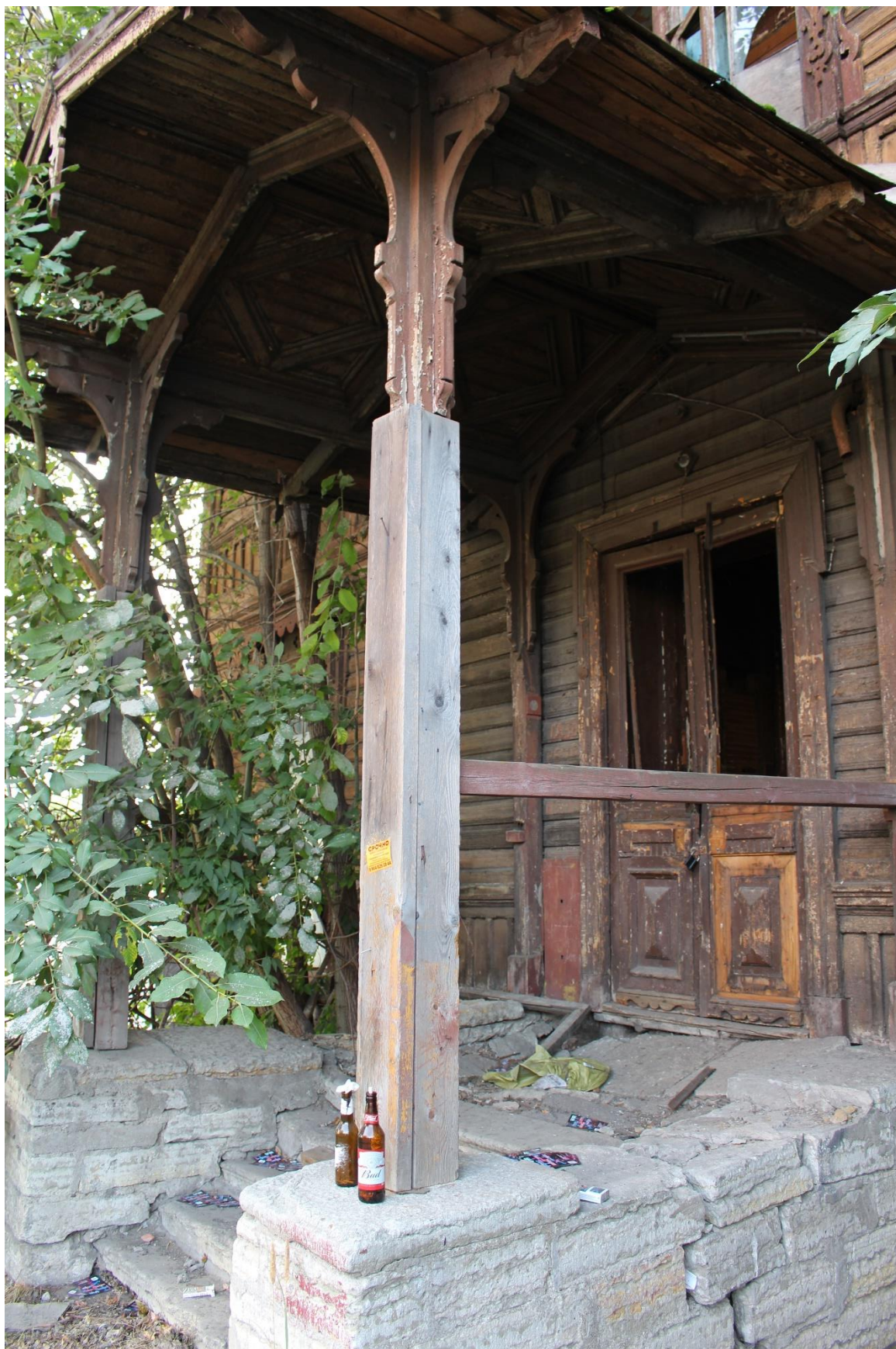
Фото 4. Вид на крыльцо со стороны восточного фасада объекта культурного наследия регионального значения «Жилой дом (деревянный двухэтажный)».
