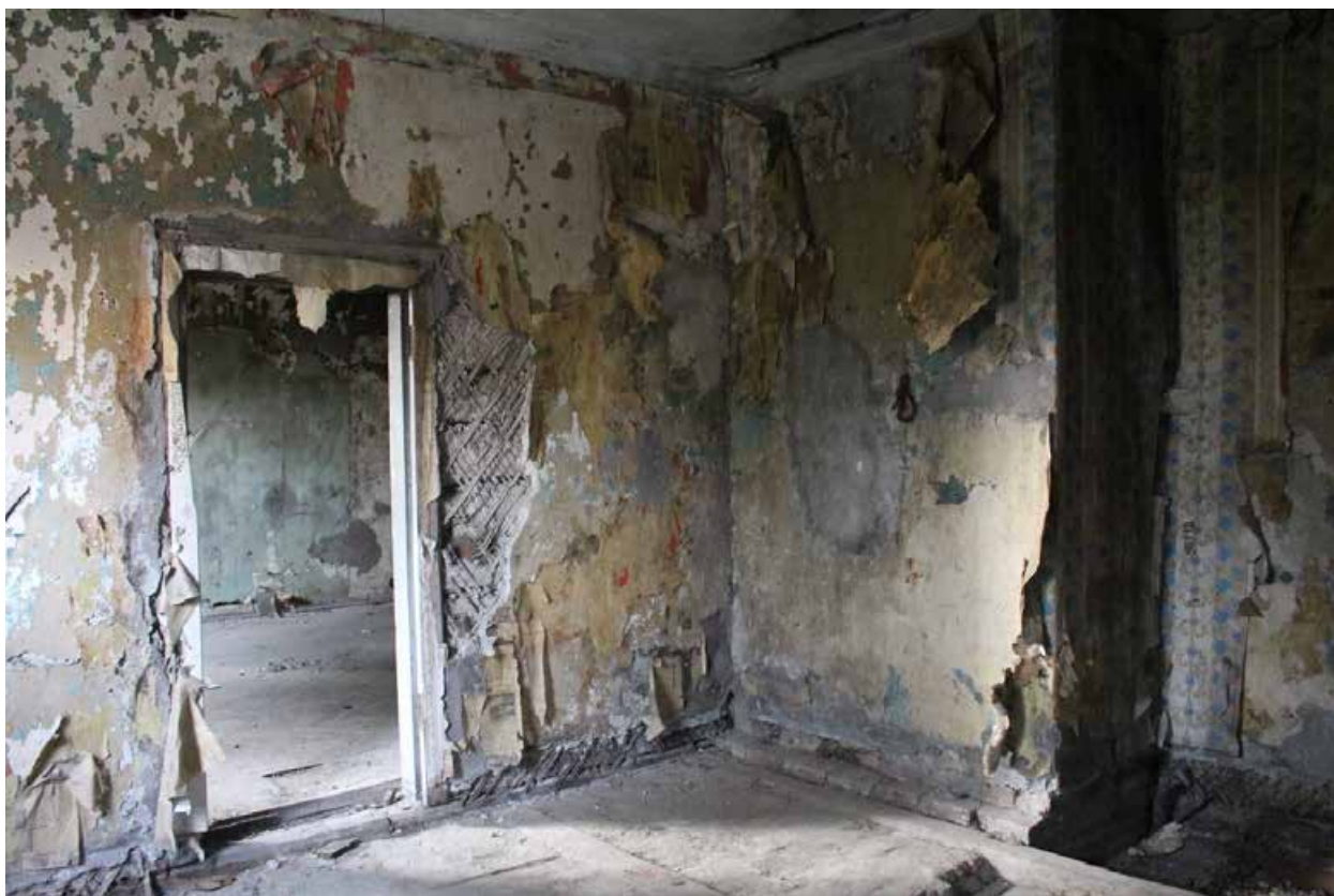
Фото 71. Объект культурного наследия регионального значения «Жилой дом (деревянный двухэтажный)». Внутренние помещения 2-го этажа.
