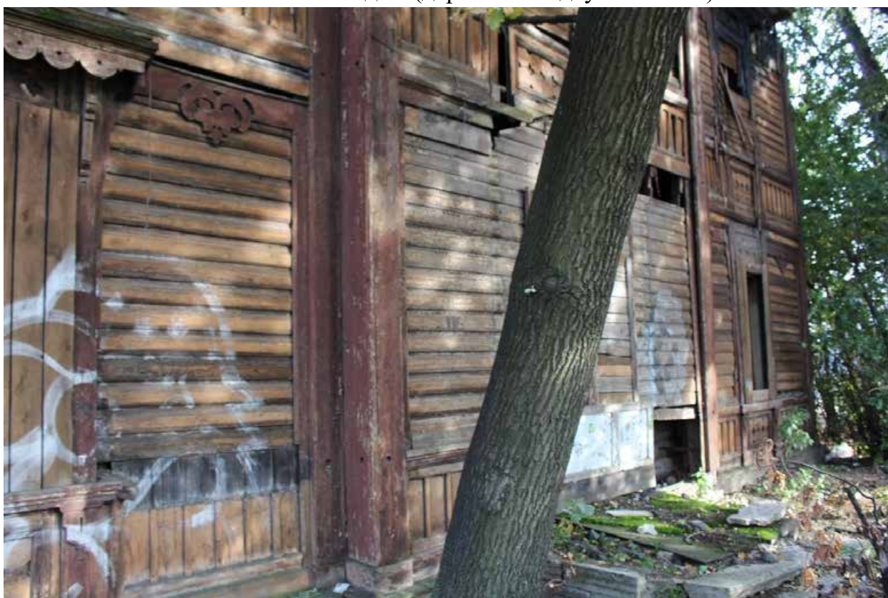
Фото 10. Вид на западный фасад объекта культурного наследия регионального значения «Жилой дом (деревянный двухэтажный)».
