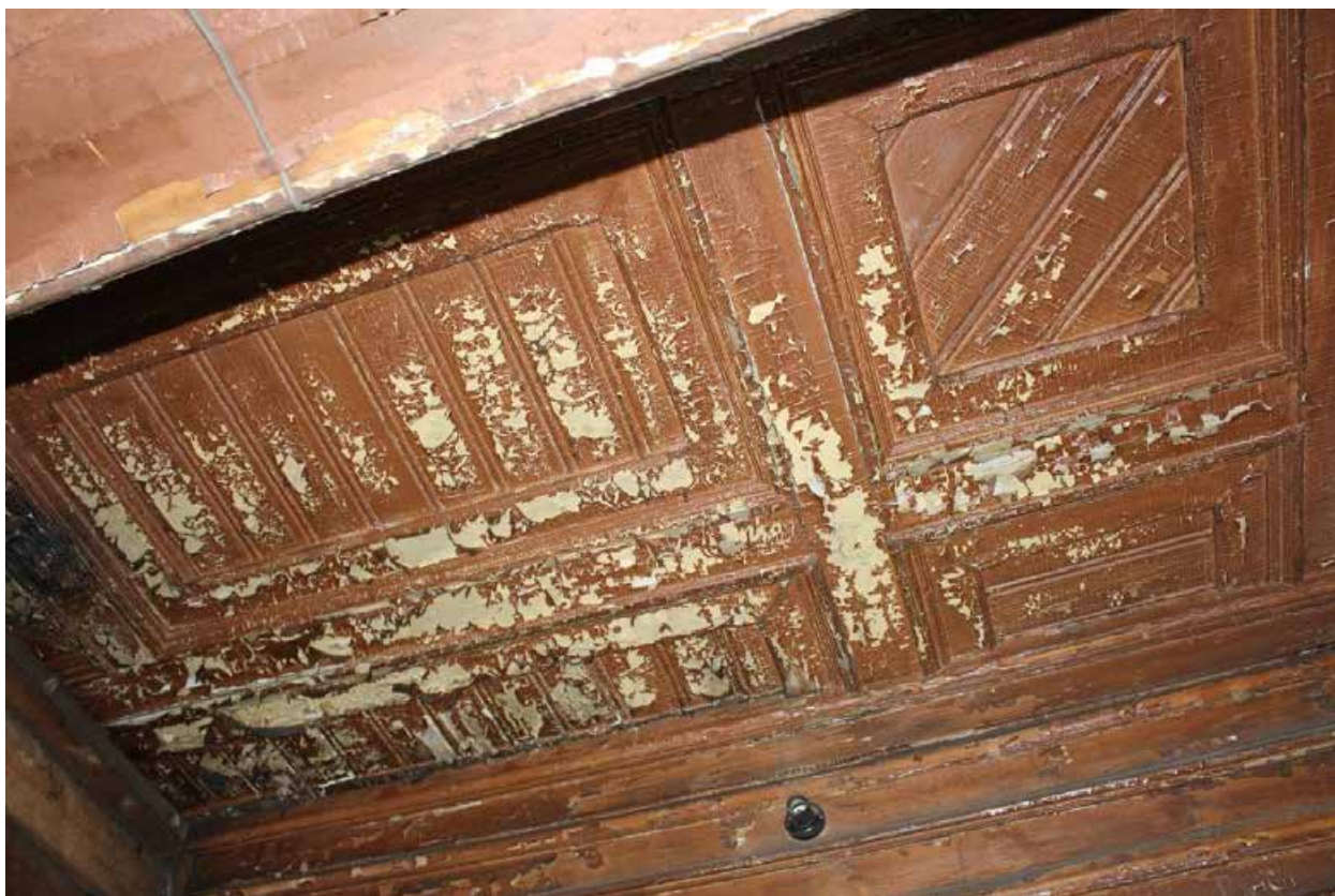
Фото 12. Объект культурного наследия регионального значения «Жилой дом (деревянный двухэтажный)». Внутренние помещения 1-го этажа.
