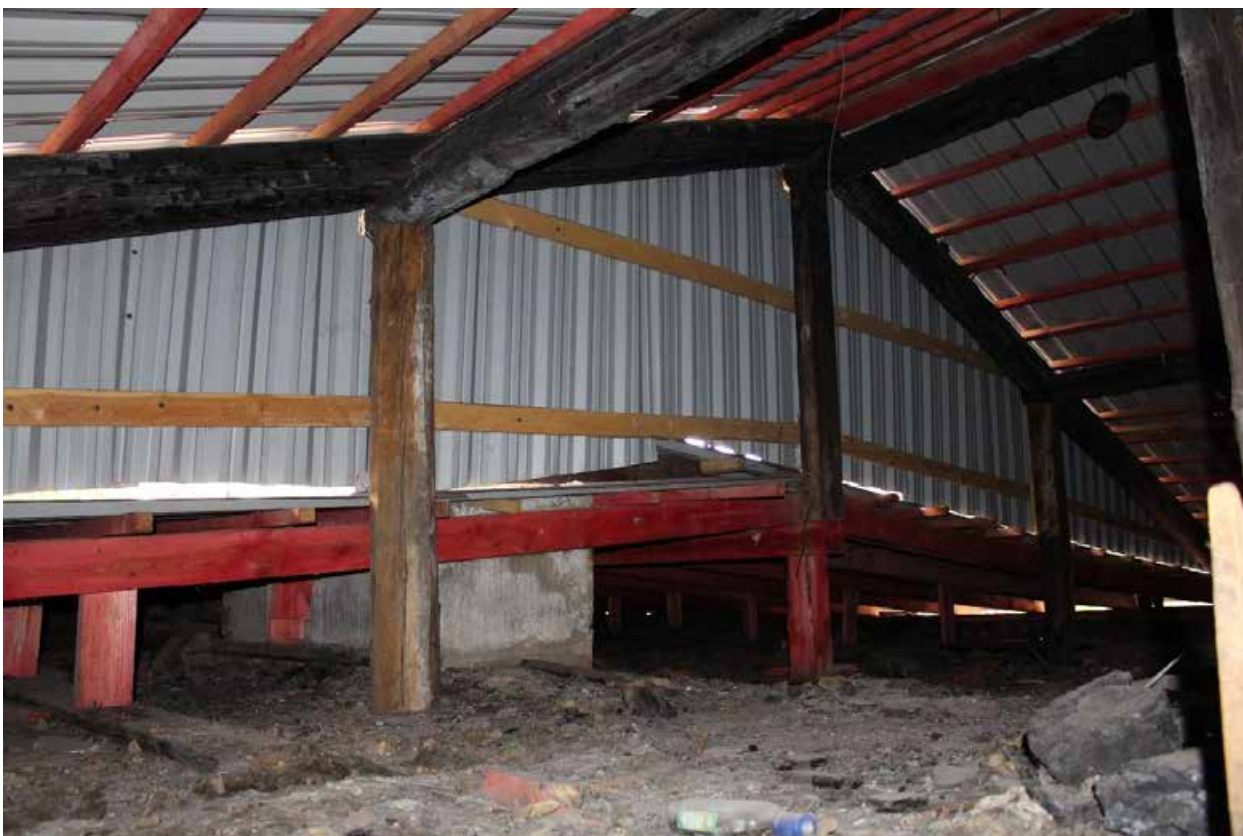
Фото 88. Объект культурного наследия регионального значения «Жилой дом (деревянный двухэтажный)». Чердак.
