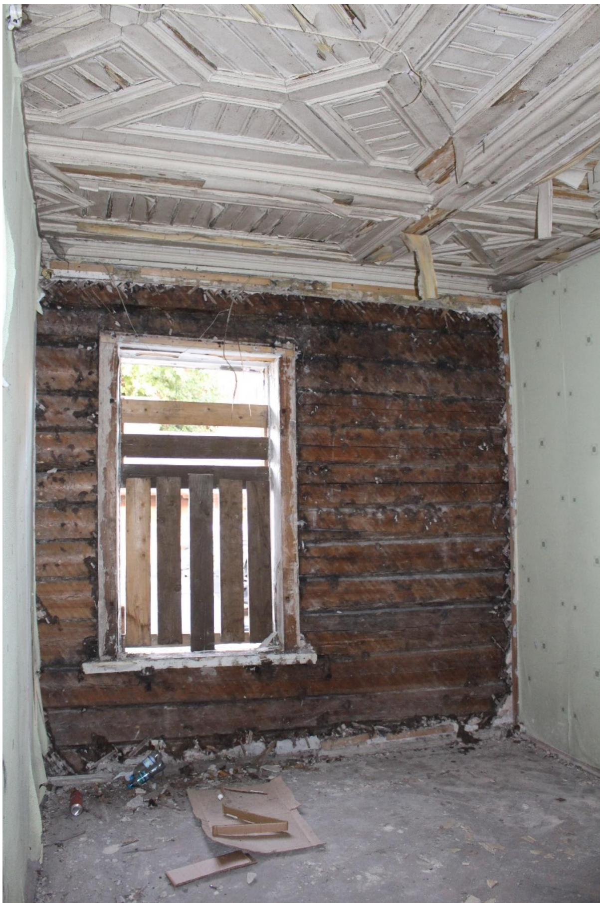
Фото 47. Объект культурного наследия регионального значения «Жилой дом (деревянный двухэтажный)». Внутренние помещения 1-го этажа.
