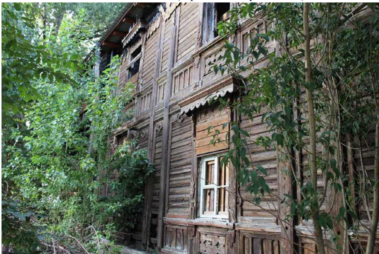
Фото 6. Вид на южный фасад объекта культурного наследия регионального значения «Жилой дом (деревянный двухэтажный)».
