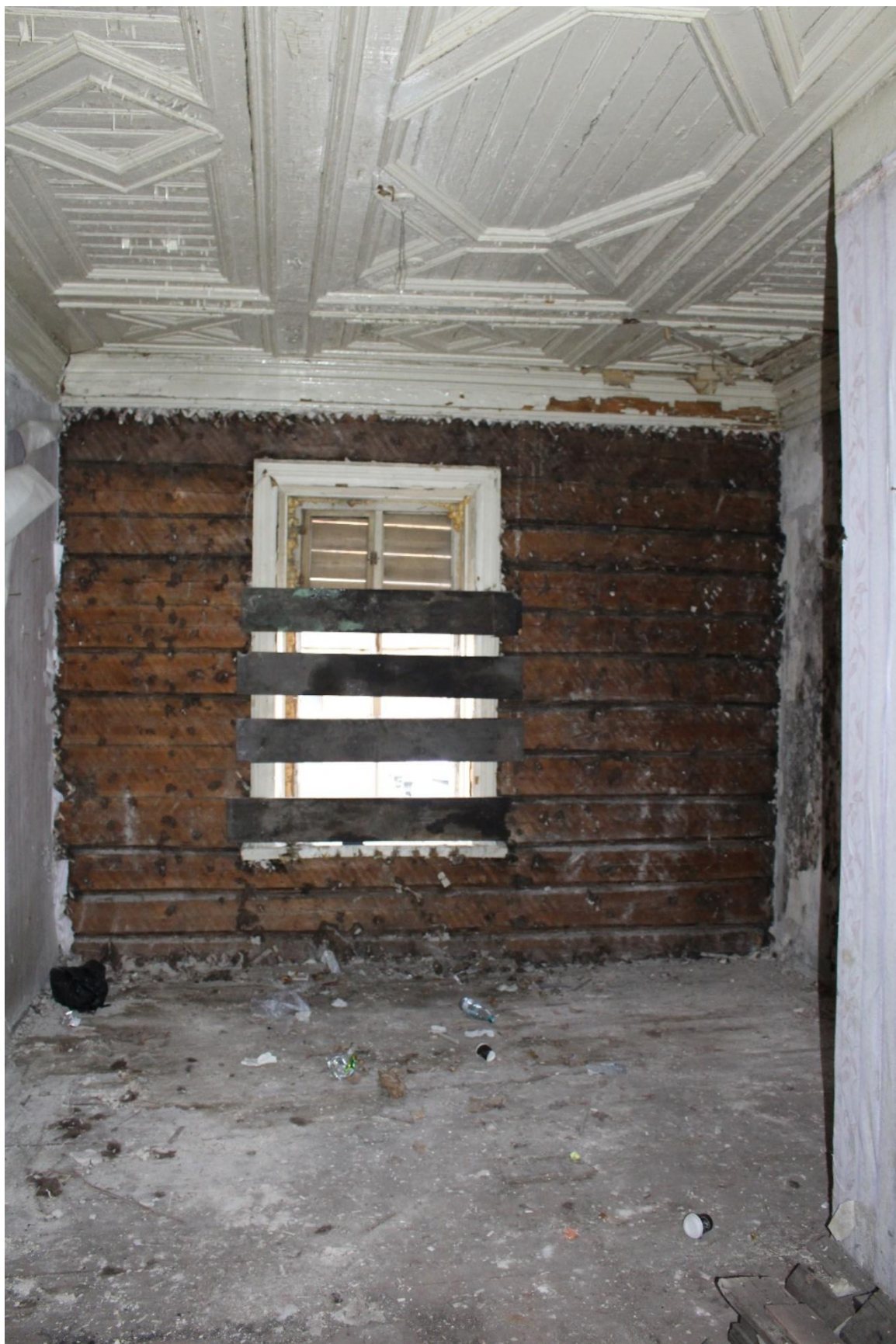
Фото 21. Объект культурного наследия регионального значения «Жилой дом (деревянный двухэтажный)». Внутренние помещения 1-го этажа.
