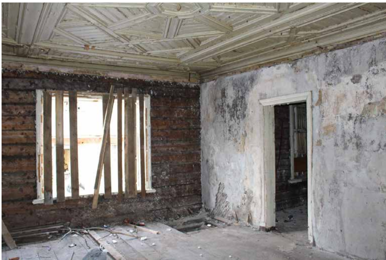
Фото 26. Объект культурного наследия регионального значения «Жилой дом (деревянный двухэтажный)». Внутренние помещения 1-го этажа.
