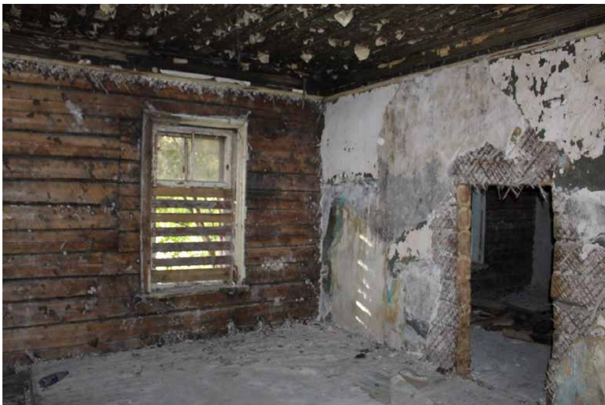
Фото 28. Объект культурного наследия регионального значения «Жилой дом (деревянный двухэтажный)». Внутренние помещения 1-го этажа.
