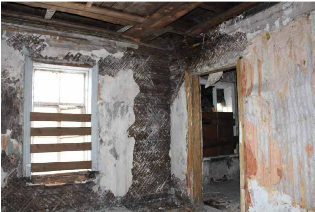
Фото 78. Объект культурного наследия регионального значения «Жилой дом (деревянный двухэтажный)». Внутренние помещения 2-го этажа.
