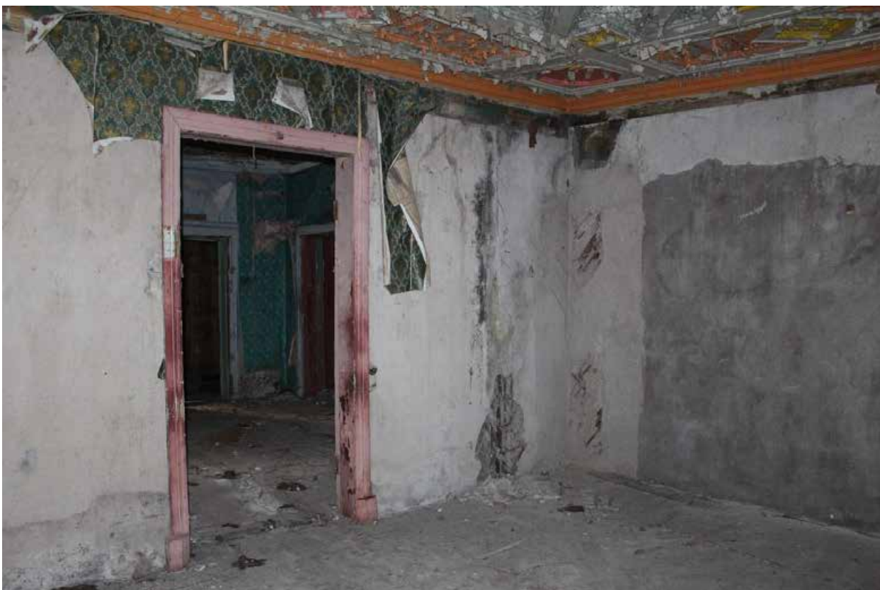
Фото 32. Объект культурного наследия регионального значения «Жилой дом (деревянный двухэтажный)». Внутренние помещения 1-го этажа.
