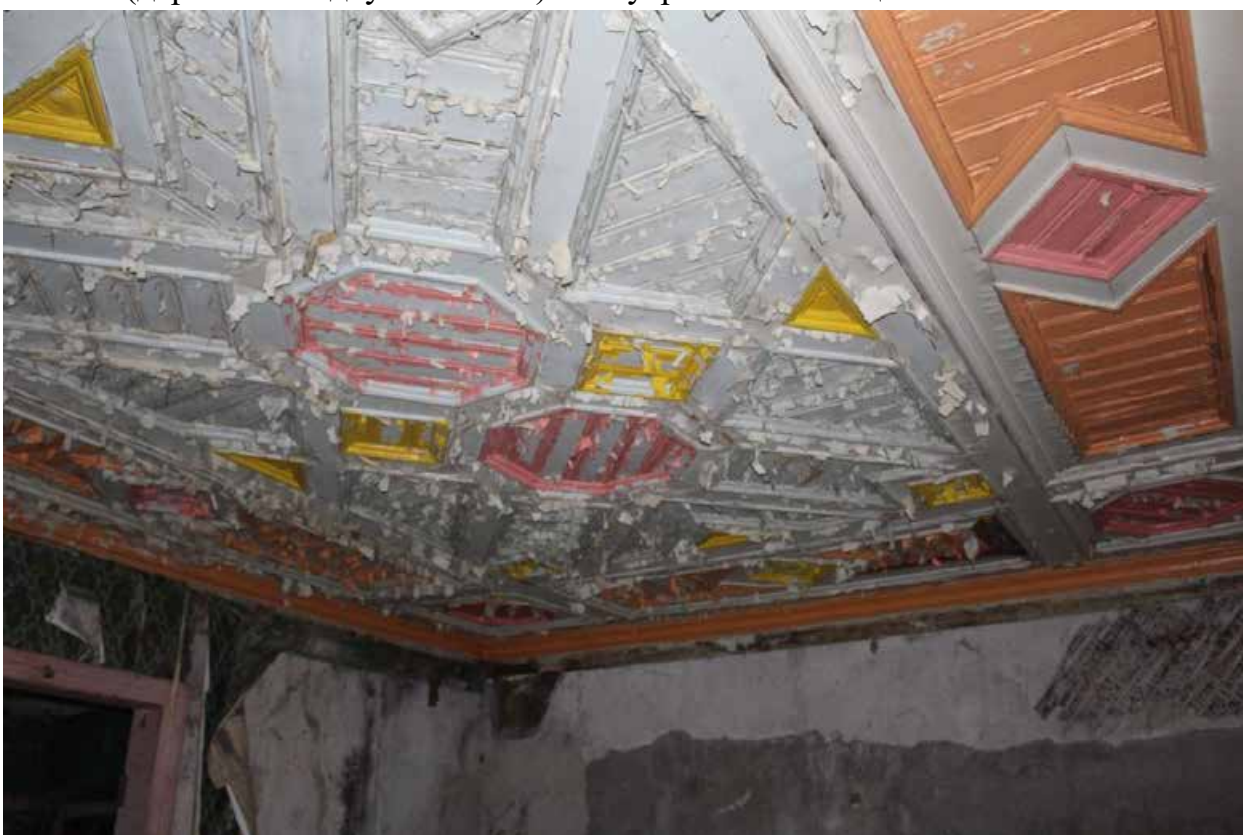
Фото 33. Объект культурного наследия регионального значения «Жилой дом (деревянный двухэтажный)». Внутренние помещения 1-го этажа.
