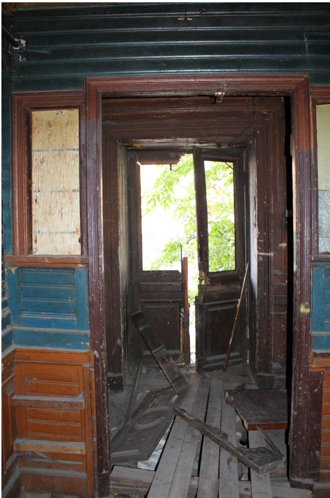
Фото 13. Объект культурного наследия регионального значения «Жилой дом (деревянный двухэтажный)». Внутренние помещения 1-го этажа.
