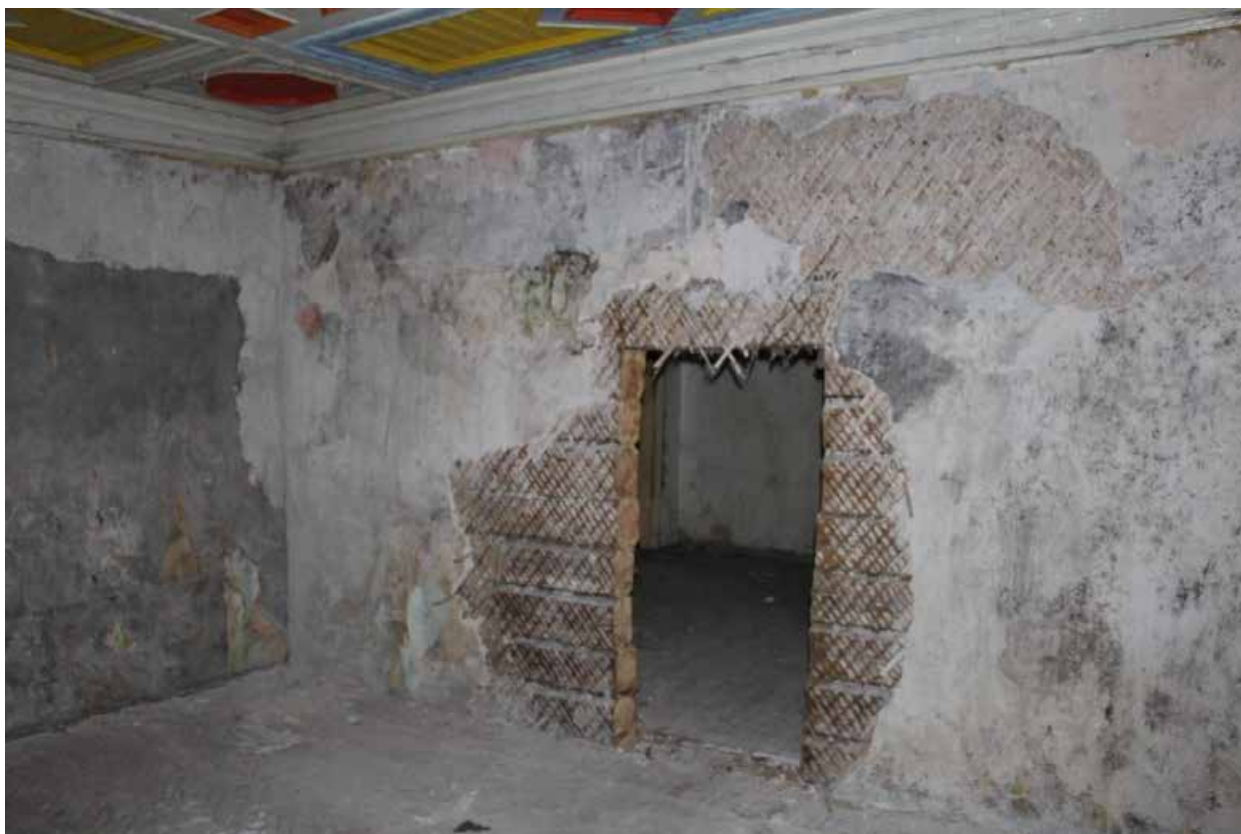
Фото 30. Объект культурного наследия регионального значения «Жилой дом (деревянный двухэтажный)». Внутренние помещения 1-го этажа.
