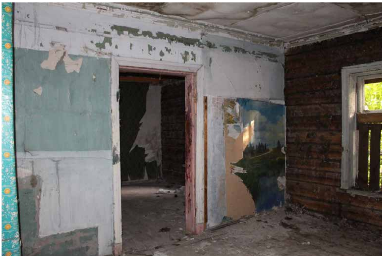
Фото 36. Объект культурного наследия регионального значения «Жилой дом (деревянный двухэтажный)». Внутренние помещения 1-го этажа.
