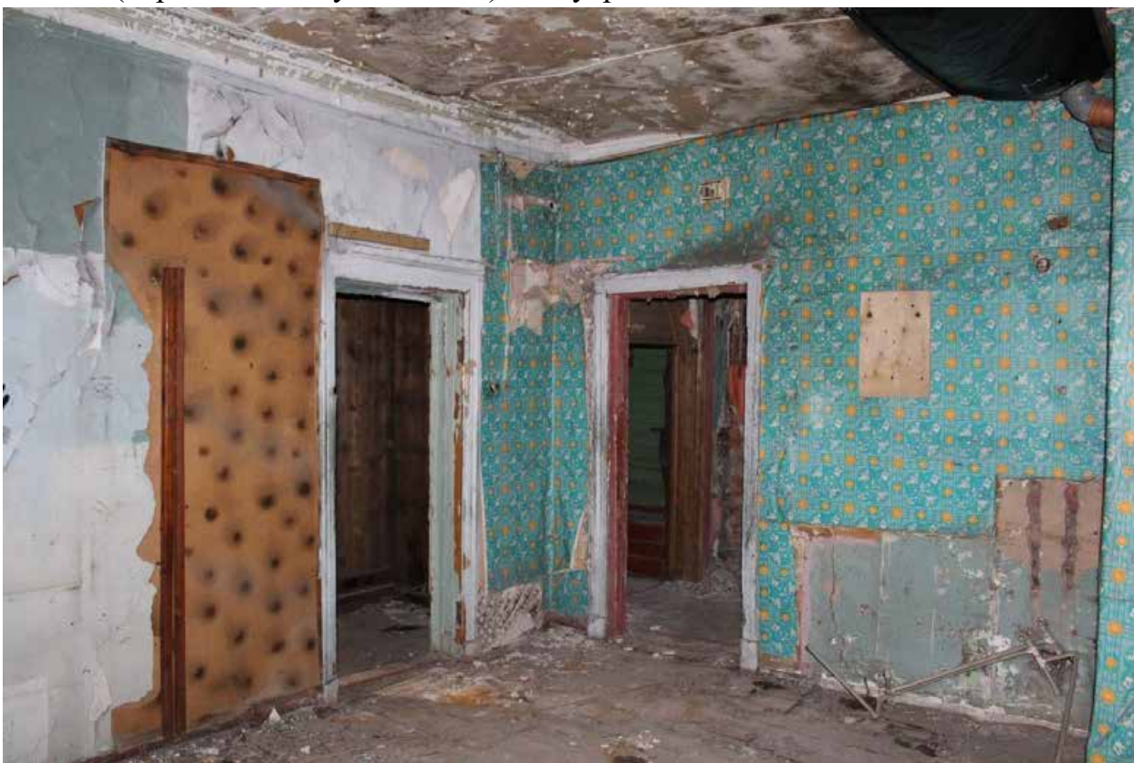
Фото 35. Объект культурного наследия регионального значения «Жилой дом (деревянный двухэтажный)». Внутренние помещения 1-го этажа.
