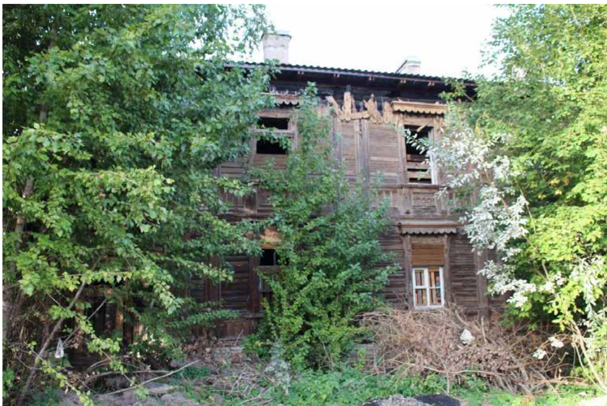
Фото 7. Вид на южный фасад объекта культурного наследия регионального значения «Жилой дом (деревянный двухэтажный)».
