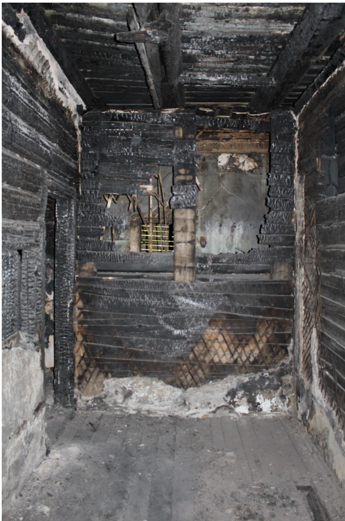
Фото 61. Объект культурного наследия регионального значения «Жилой дом (деревянный двухэтажный)». Внутренние помещения 2-го этажа.
