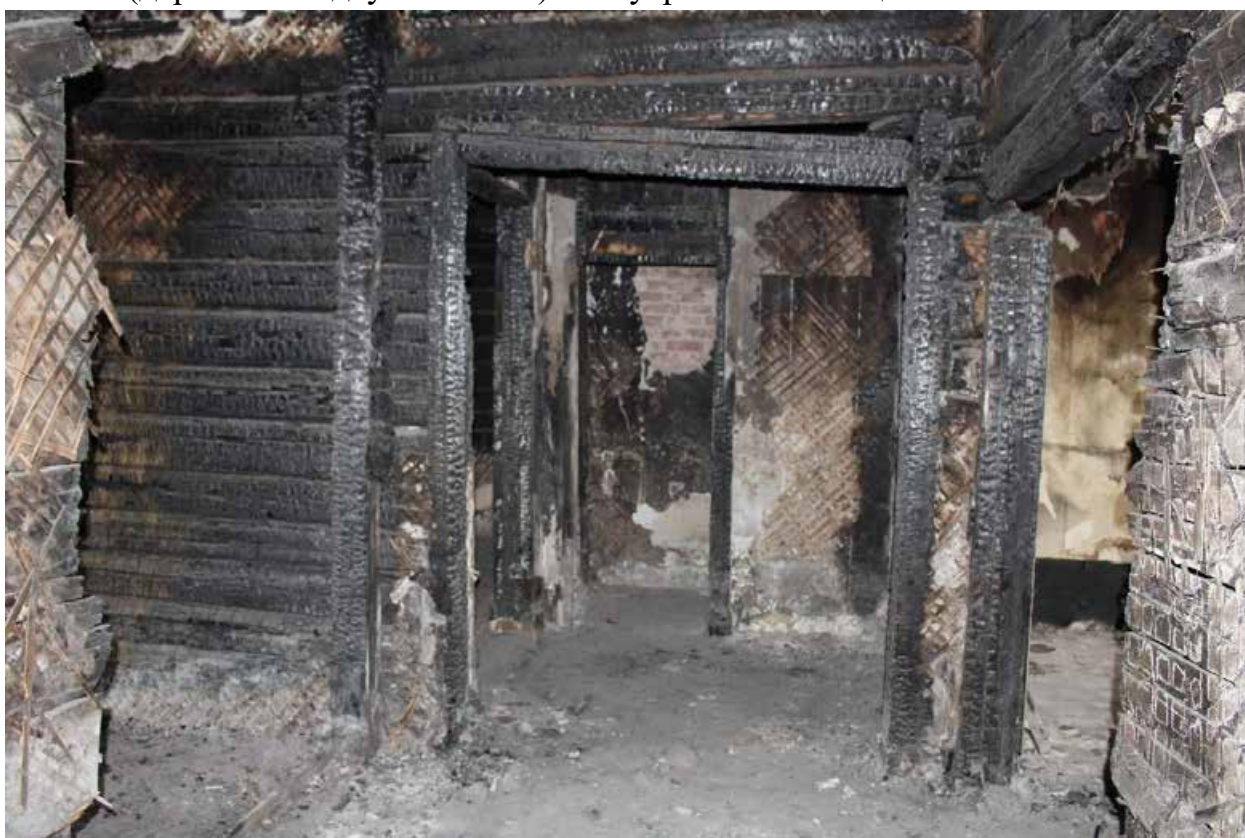
Фото 64. Объект культурного наследия регионального значения «Жилой дом (деревянный двухэтажный)». Внутренние помещения 2-го этажа.
