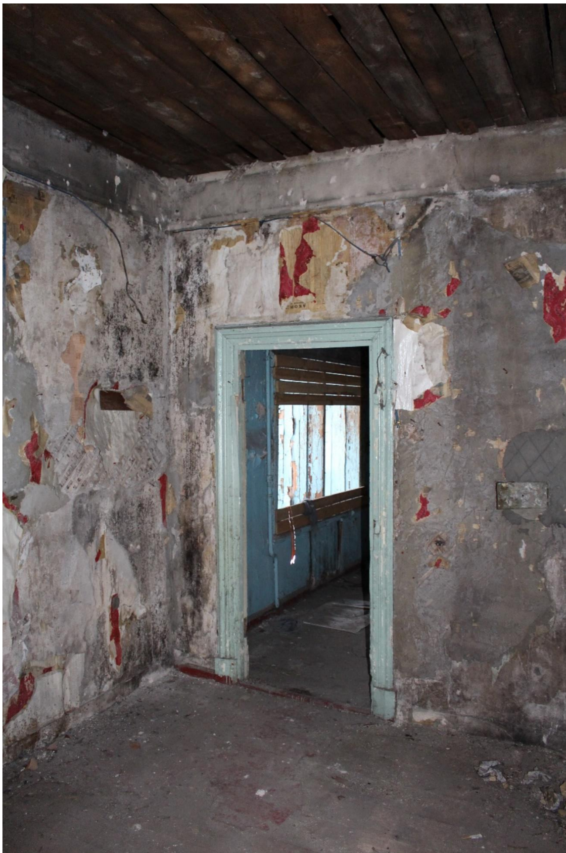
Фото 76. Объект культурного наследия регионального значения «Жилой дом (деревянный двухэтажный)». Внутренние помещения 2-го этажа.
