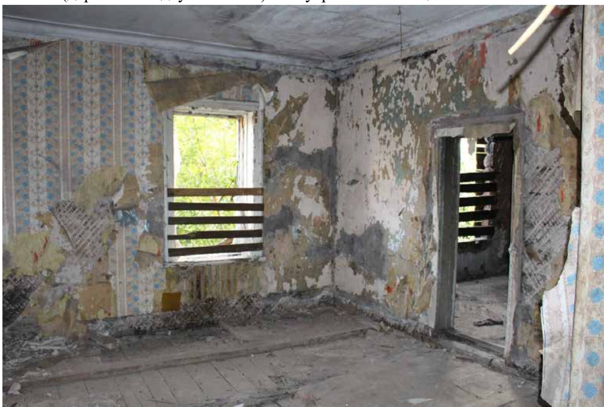
Фото 72. Объект культурного наследия регионального значения «Жилой дом (деревянный двухэтажный)». Внутренние помещения 2-го этажа.
