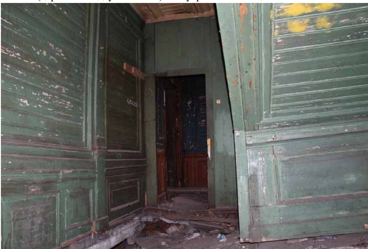
Фото 15. Объект культурного наследия регионального значения «Жилой дом (деревянный двухэтажный)». Внутренние помещения 1-го этажа.
