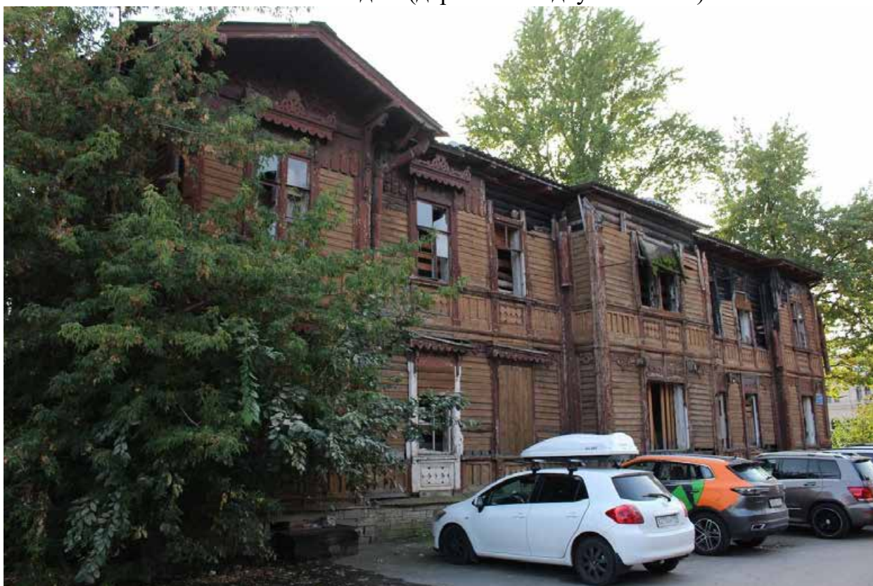
Фото 2. Вид на северный фасад объекта культурного наследия регионального значения «Жилой дом (деревянный двухэтажный)».
