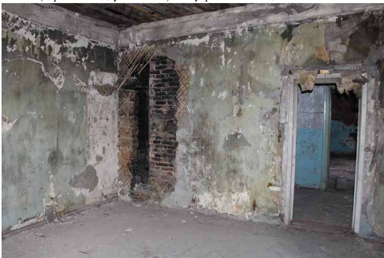
Фото 68. Объект культурного наследия регионального значения «Жилой дом (деревянный двухэтажный)». Внутренние помещения 2-го этажа.
