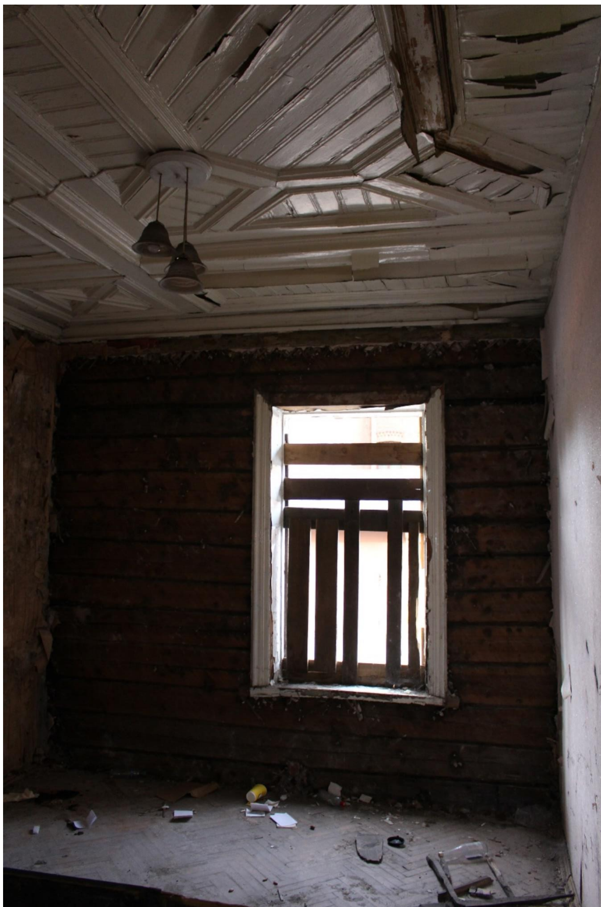
Фото 46. Объект культурного наследия регионального значения «Жилой дом (деревянный двухэтажный)». Внутренние помещения 1-го этажа.
