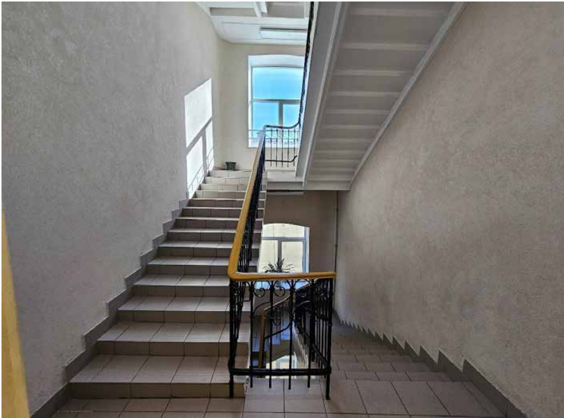
124. Объект культурного наследия регионального значения «Высшие женские естественные курсы и гимназия Лохвицкой-Скалон М.А. Здесь проходила VII (Апрельская) конференция РСДРП (б)», по адресу: г. Санкт-Петербург, Кузнечный переулок, дом 9/27, литера А. Общий вид пом. 1-Н (243) в уровне 6-го этажа – объем двухмаршевой лестницы в центральной части здания.
