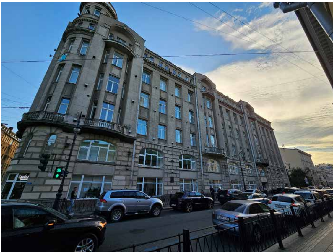
3. Объект культурного наследия регионального значения «Высшие женские естественные курсы и гимназия Лохвицкой-Скалон М.А. Здесь проходила VII (Апрельская) конференция РСДРП (б)», по адресу: г. Санкт-Петербург, Кузнечный переулок, дом 9/27, литера А. Общий вид северного лицевого фасада по Кузнечному переулку.
