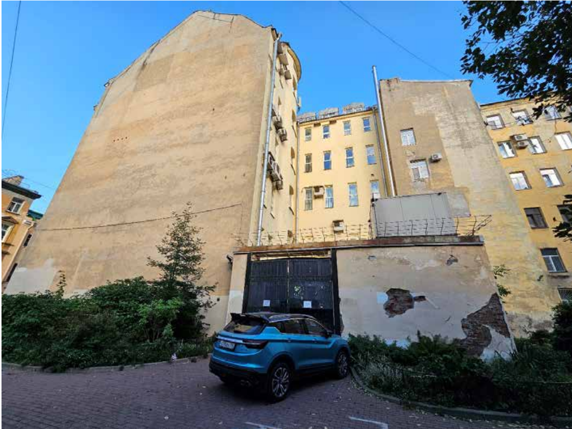
7. Объект культурного наследия регионального значения «Высшие женские естественные курсы и гимназия Лохвицкой-Скалон М.А. Здесь проходила VII (Апрельская) конференция РСДРП (б)», по адресу: г. Санкт-Петербург, Кузнечный переулок, дом 9/27, литера А. Общий вид западного торцевого и дворового фасадов.
