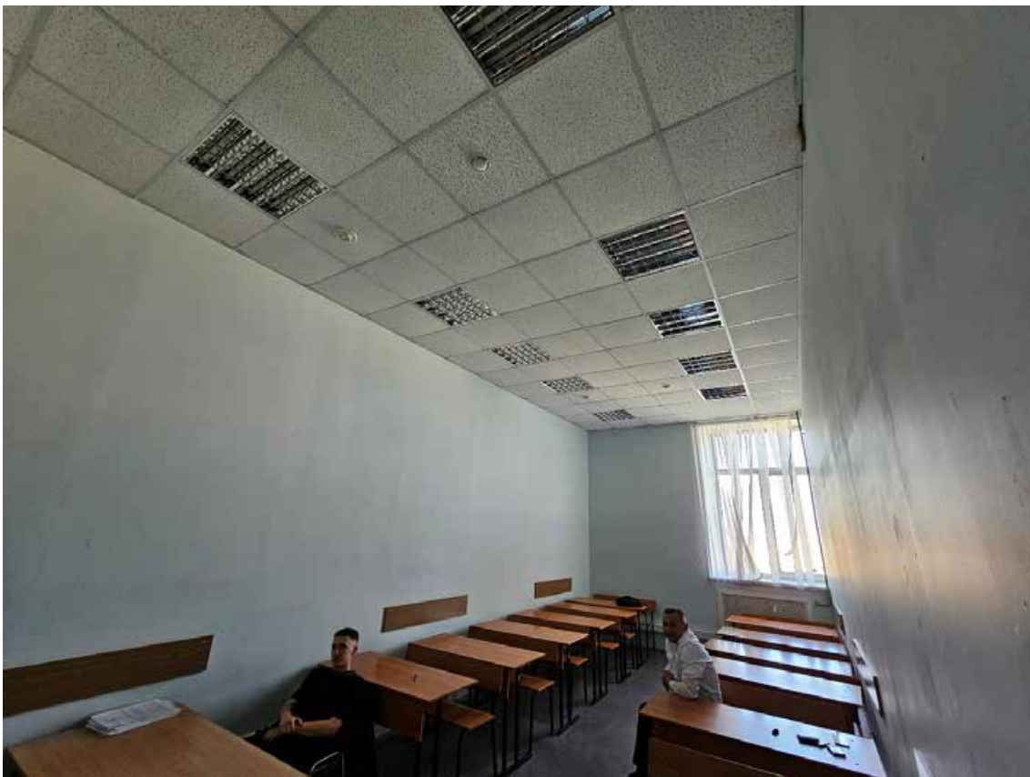
106. Объект культурного наследия регионального значения «Высшие женские естественные курсы и гимназия Лохвицкой-Скалон М.А. Здесь проходила VII (Апрельская) конференция РСДРП (б)», по адресу: г. Санкт-Петербург, Кузнечный переулок, дом 9/27, литера А. Фрагмент пом. 1-Н (183) в уровне 5-го этажа.
