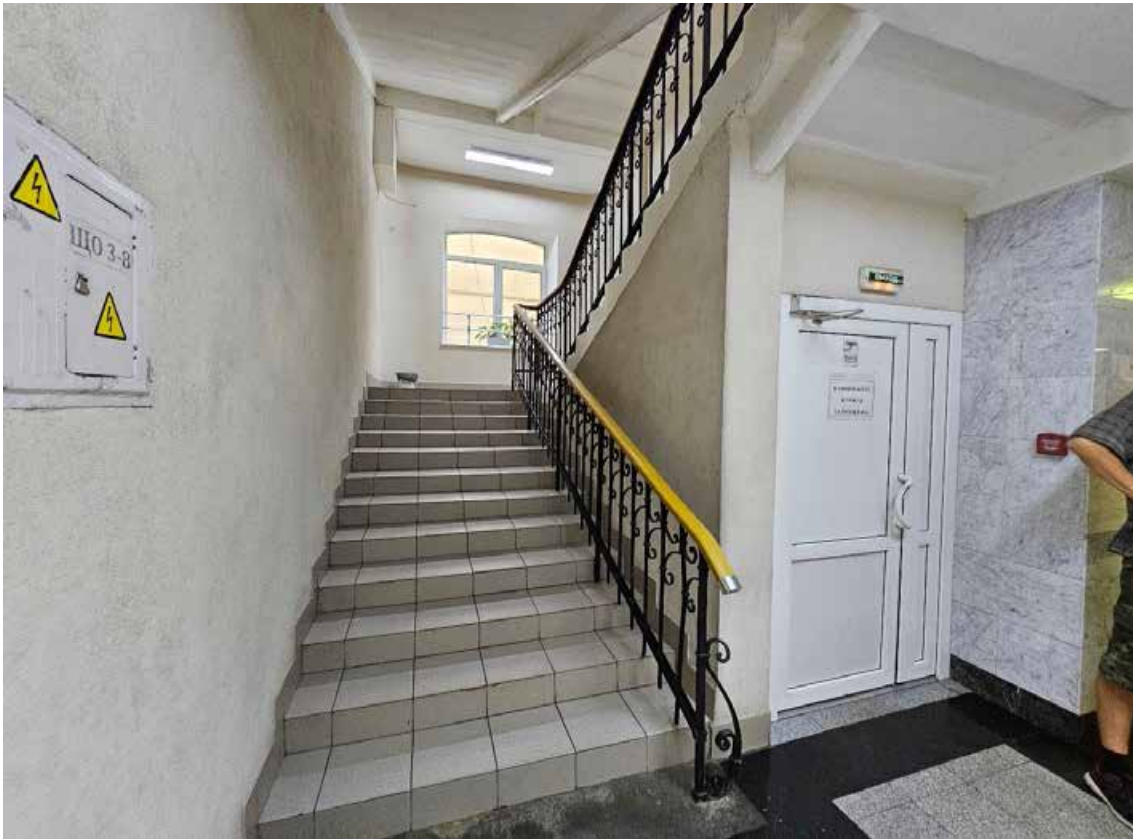
14. Объект культурного наследия регионального значения «Высшие женские естественные курсы и гимназия Лохвицкой-Скалон М.А. Здесь проходила VII (Апрельская) конференция РСДРП (б)», по адресу: г. Санкт-Петербург, Кузнечный переулок, дом 9/27, литера А. Общий вид пом. 1-Н (51) в уровне 1-го этажа – двухмаршевая лестница в центральной части здания.
