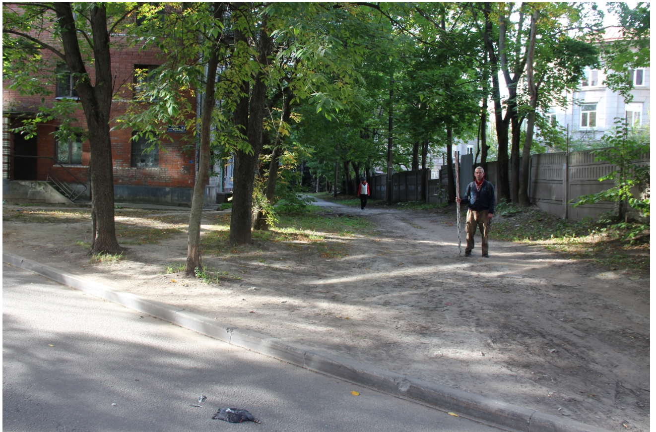
Рис. 19. Санкт-Петербург, Выборгский район. Пархоменко ул. Точка съёмки 6. Вид на З.
