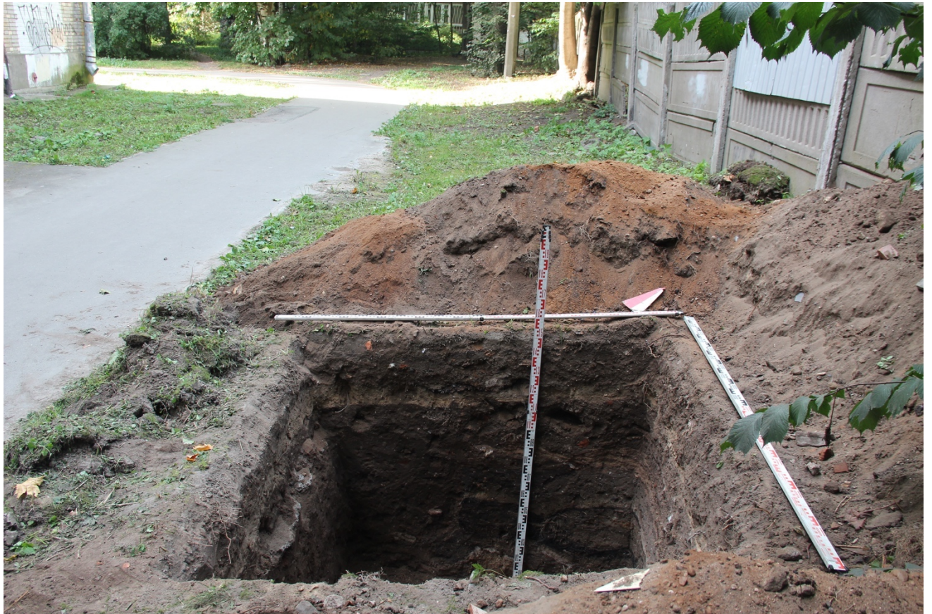
Рис. 32. Санкт-Петербург, Выборгский район. Пархоменко ул. Шурф 1. Общий вид шурфа.
