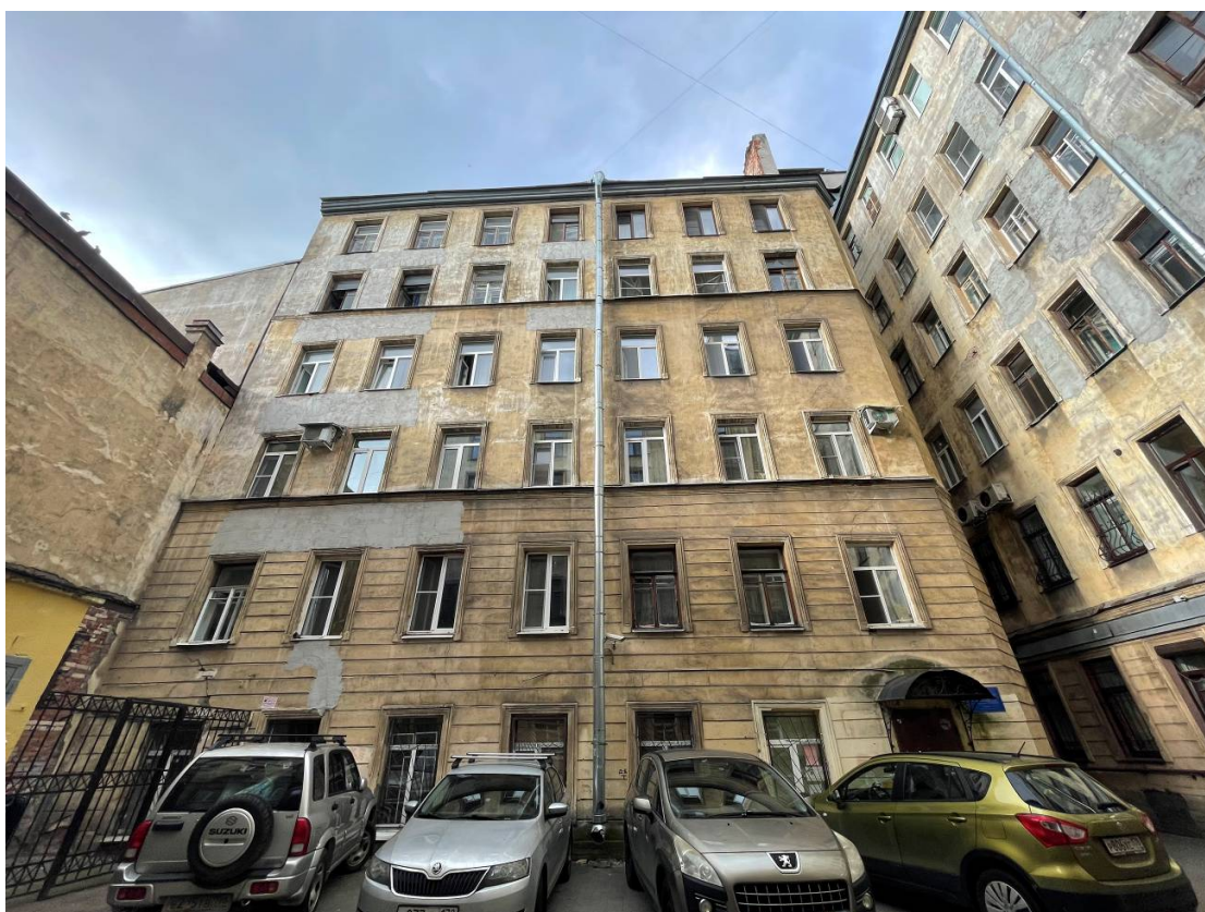
Фото 6. Фрагмент дворового фасада выявленного объекта культурного наследия «Дом П.К. Симонова (А.А. и И.А. Орловых)»
