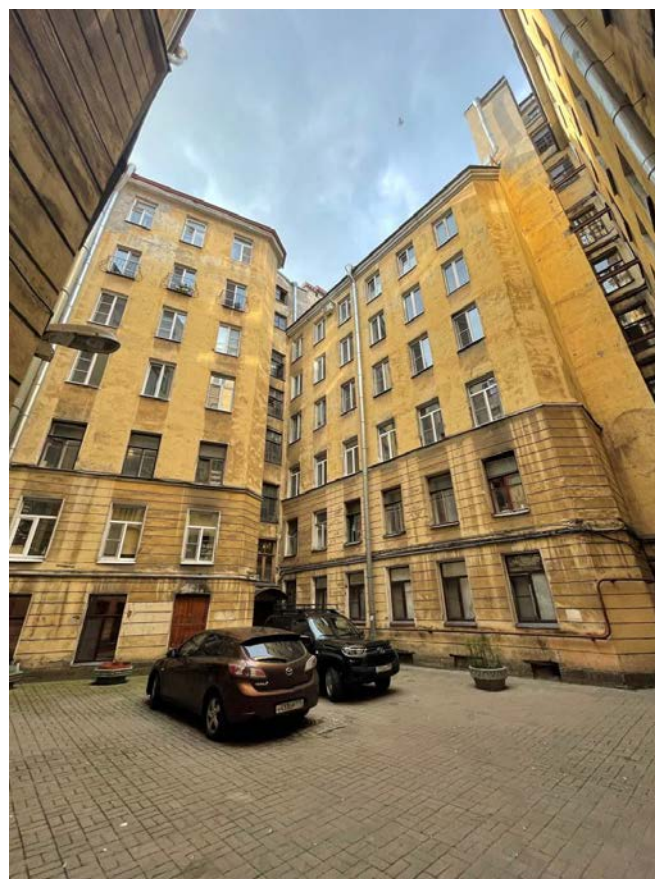
Фото 14. Фрагмент дворового фасада выявленного объекта культурного наследия «Дом П.К. Симонова (А.А. и И.А. Орловых)»
