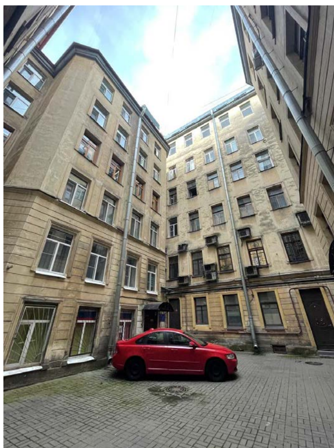
Фото 10. Фрагмент дворового фасада выявленного объекта культурного наследия «Дом П.К. Симонова (А.А. и И.А. Орловых)»
