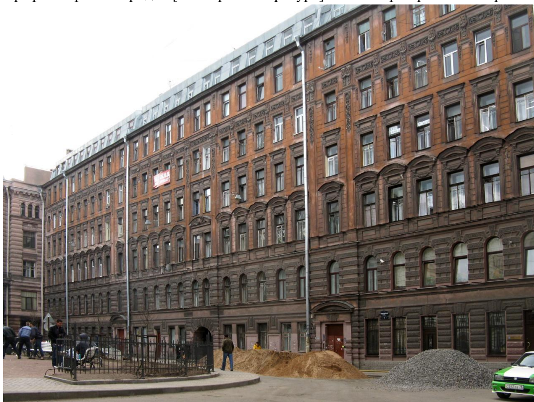
17. 2011 г. — Дом П. К. Симонова - Дом Евментьева - Дом Орловых // Citywalls.ru – архитектурный сайт Петербурга [Электронный ресурс]. URL: https://www.citywalls.ru/house4966.html
