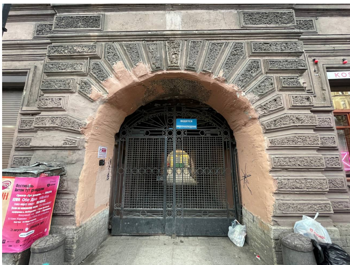
Фото 4. Фрагмент лицевого фасада выявленного объекта культурного наследия «Дом П.К. Симонова (А.А. и И.А. Орловых)», воротный проезд
