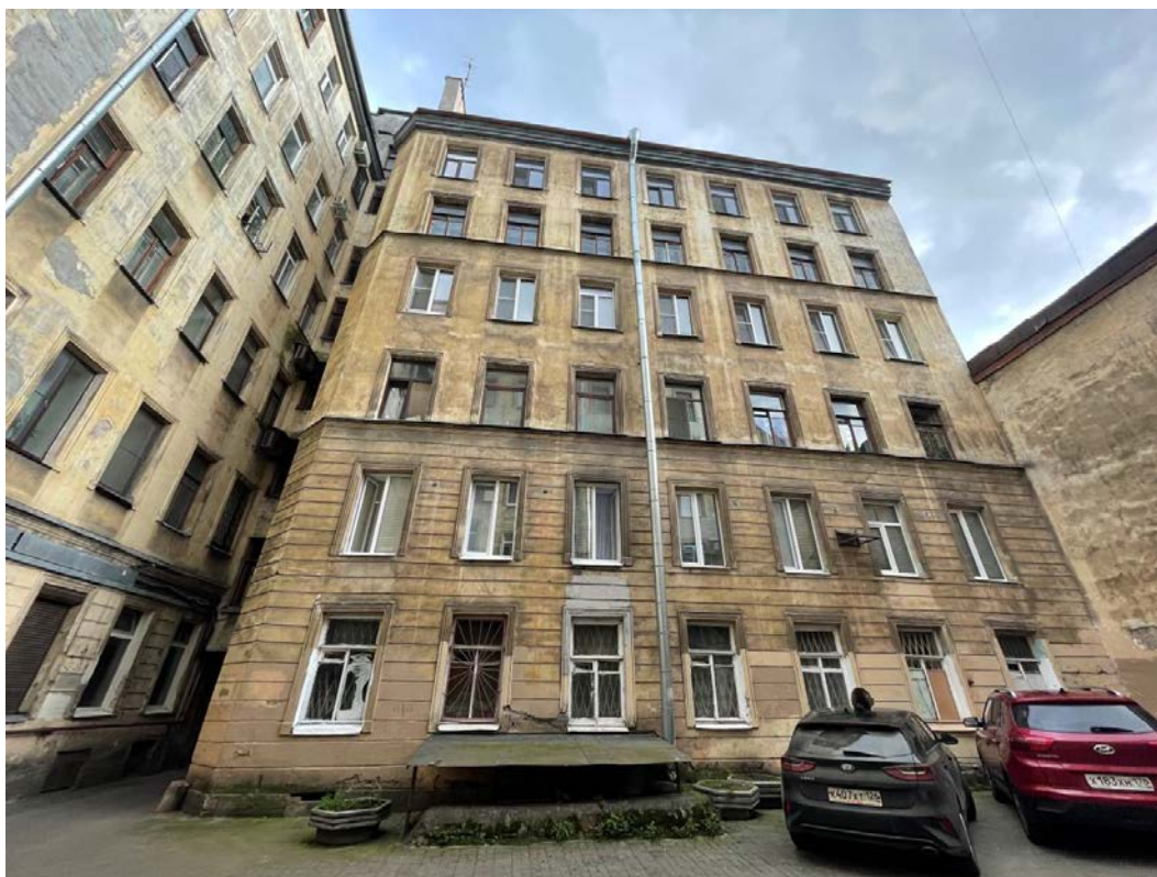
Фото 7. Фрагмент дворового фасада выявленного объекта культурного наследия «Дом П.К. Симонова (А.А. и И.А. Орловых)»
