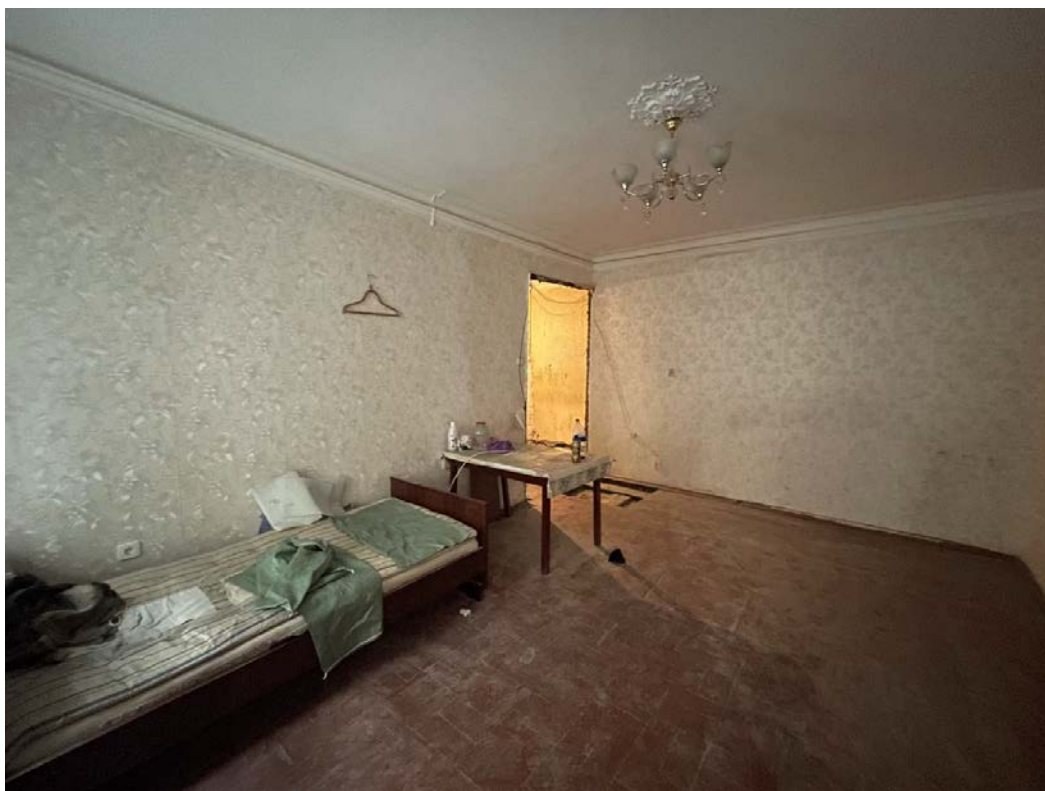
Фото 20. Интерьер квартиры № 32 выявленного объекта культурного наследия «Дом П.К. Симонова (А.А. и И.А. Орловых)»
