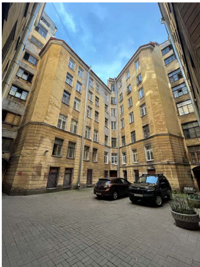
Фото 13. Фрагмент дворового фасада выявленного объекта культурного наследия «Дом П.К. Симонова (А.А. и И.А. Орловых)»
