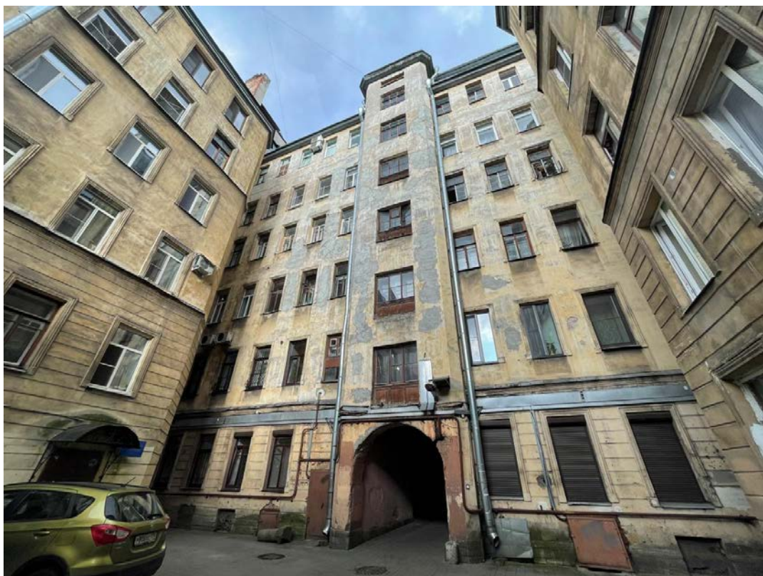
Фото 5. Фрагмент дворового фасада выявленного объекта культурного наследия «Дом П.К. Симонова (А.А. и И.А. Орловых)»
