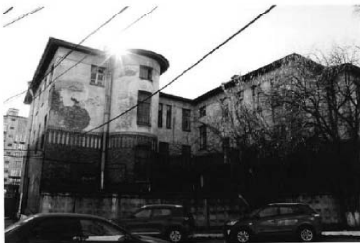
44. Вид на здание по адресу: Ждановская улица, 39, литера А
