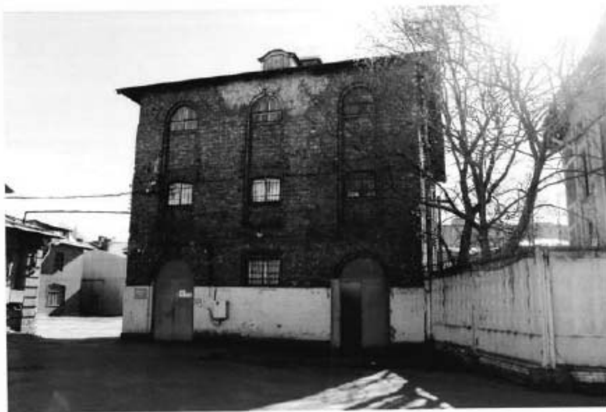
43. Вид на здание по адресу: улица Красного Курсанта, 34, №18/14
