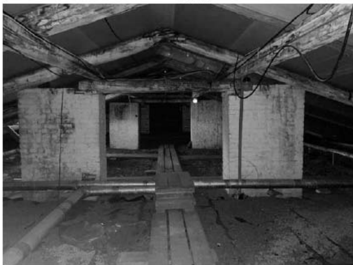
74. Фрагмент интерьера здания по адресу: улица Красного Курсанта, 34, литера Б
