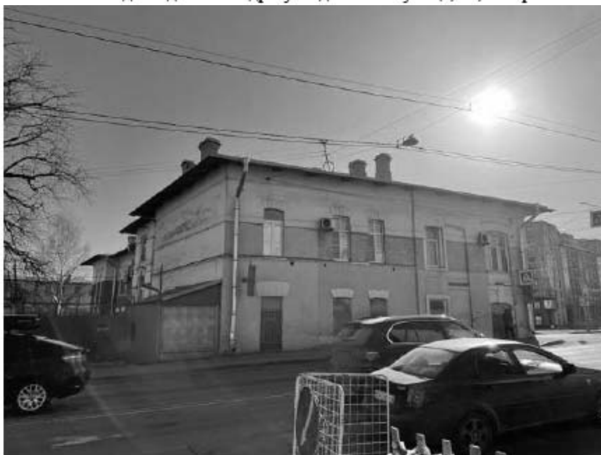
12. Вид на здание по адресу: Ждановская улица, 41, литера А
