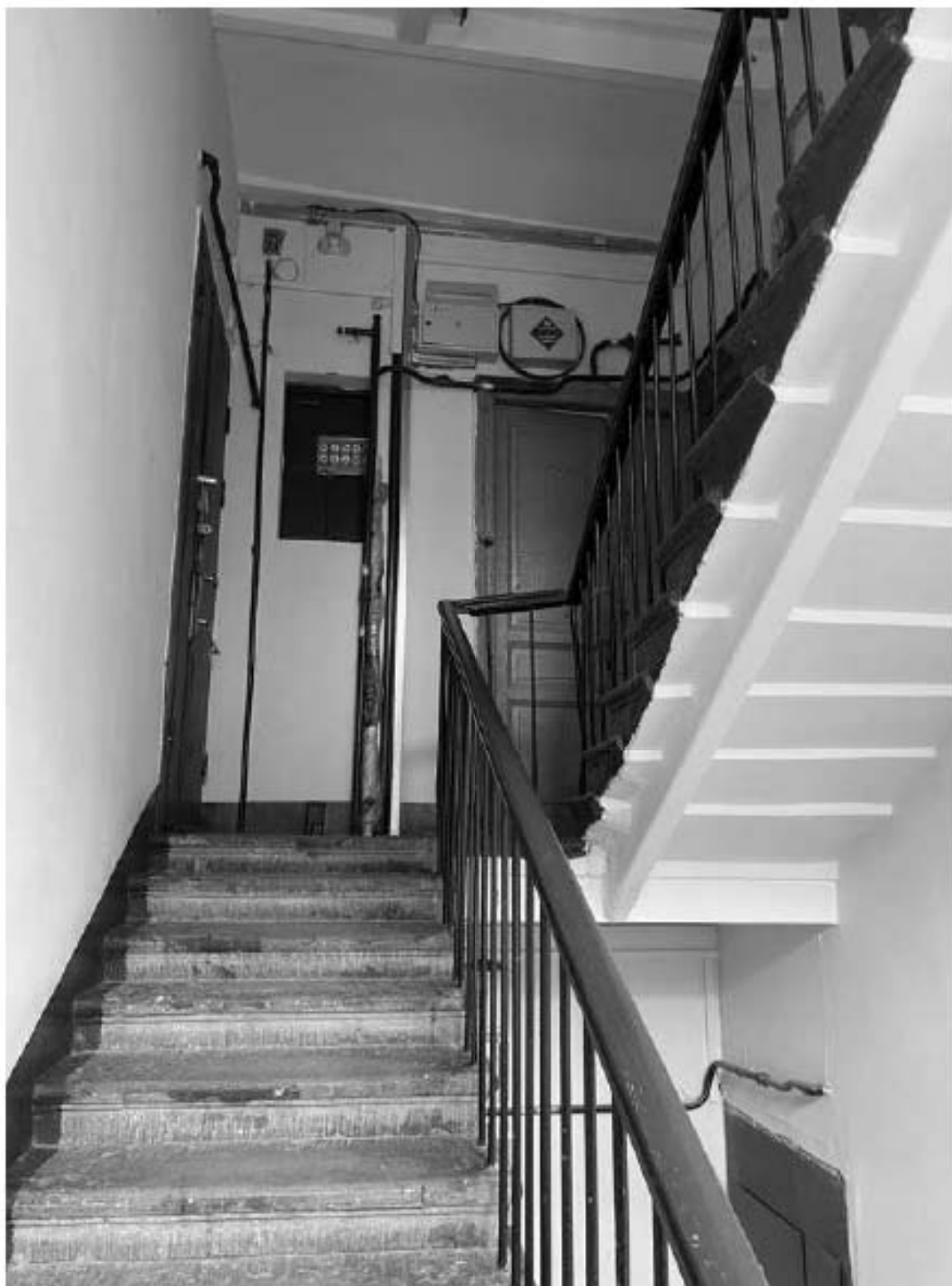
115. Фрагмент интерьера здания по адресу: улица Красного Курсанта, 34, литера А
