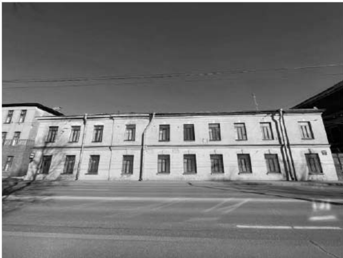
7. Вид на здание по адресу: Ждановская улица, 37, литера А
