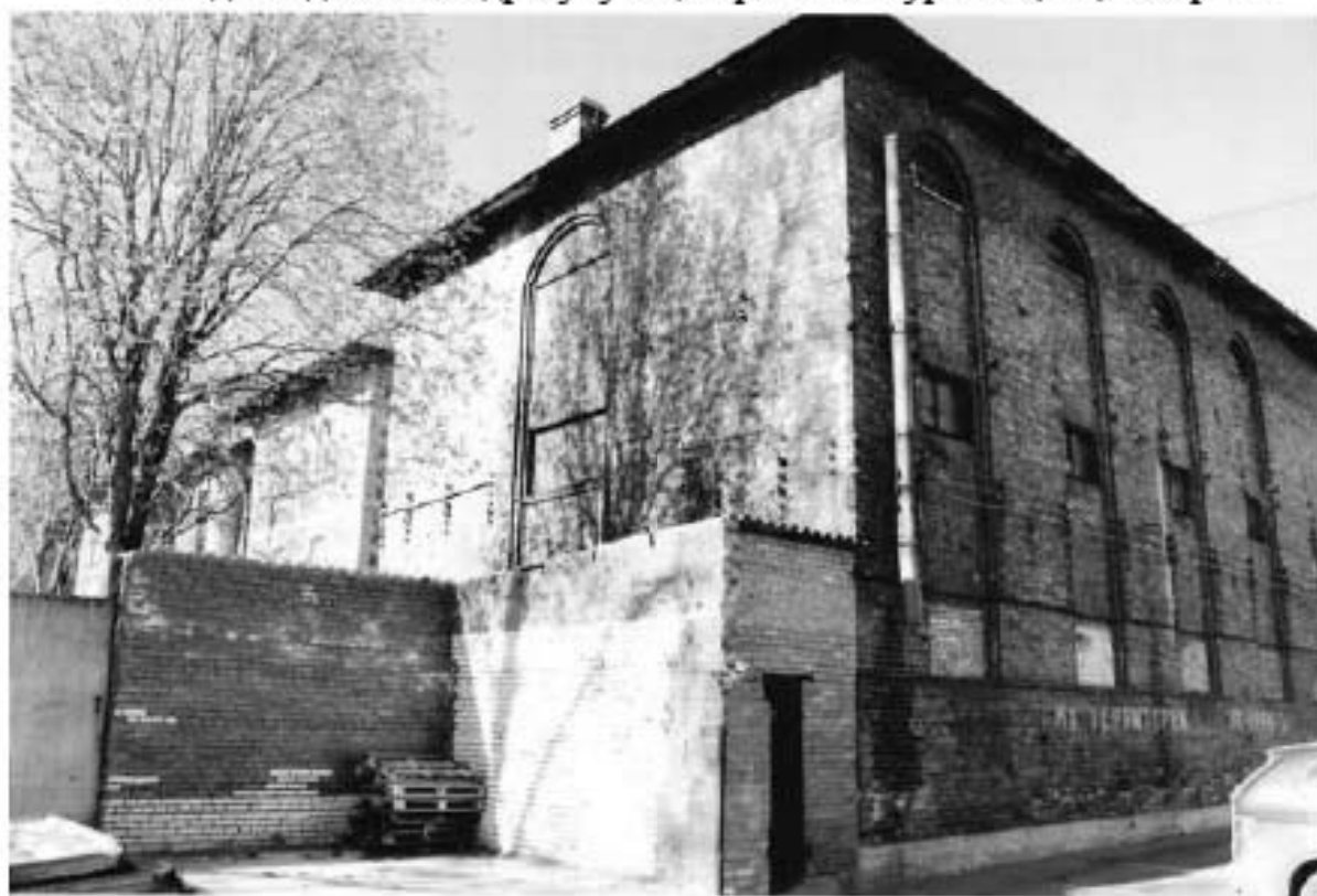
60. Вид на здание по адресу: улица Красного Курсанта, 34, №18/14
