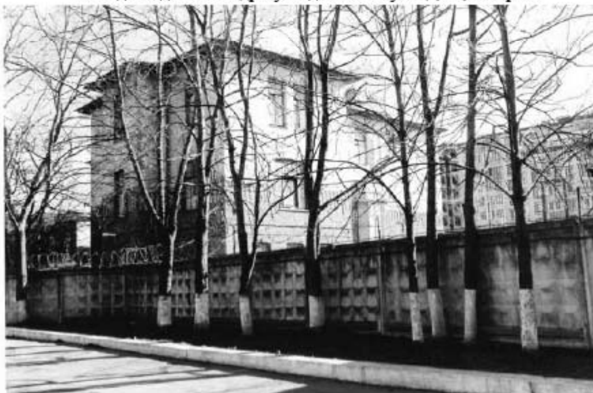
46. Вид на здание по адресу: Ждановская улица, 39, литера А
