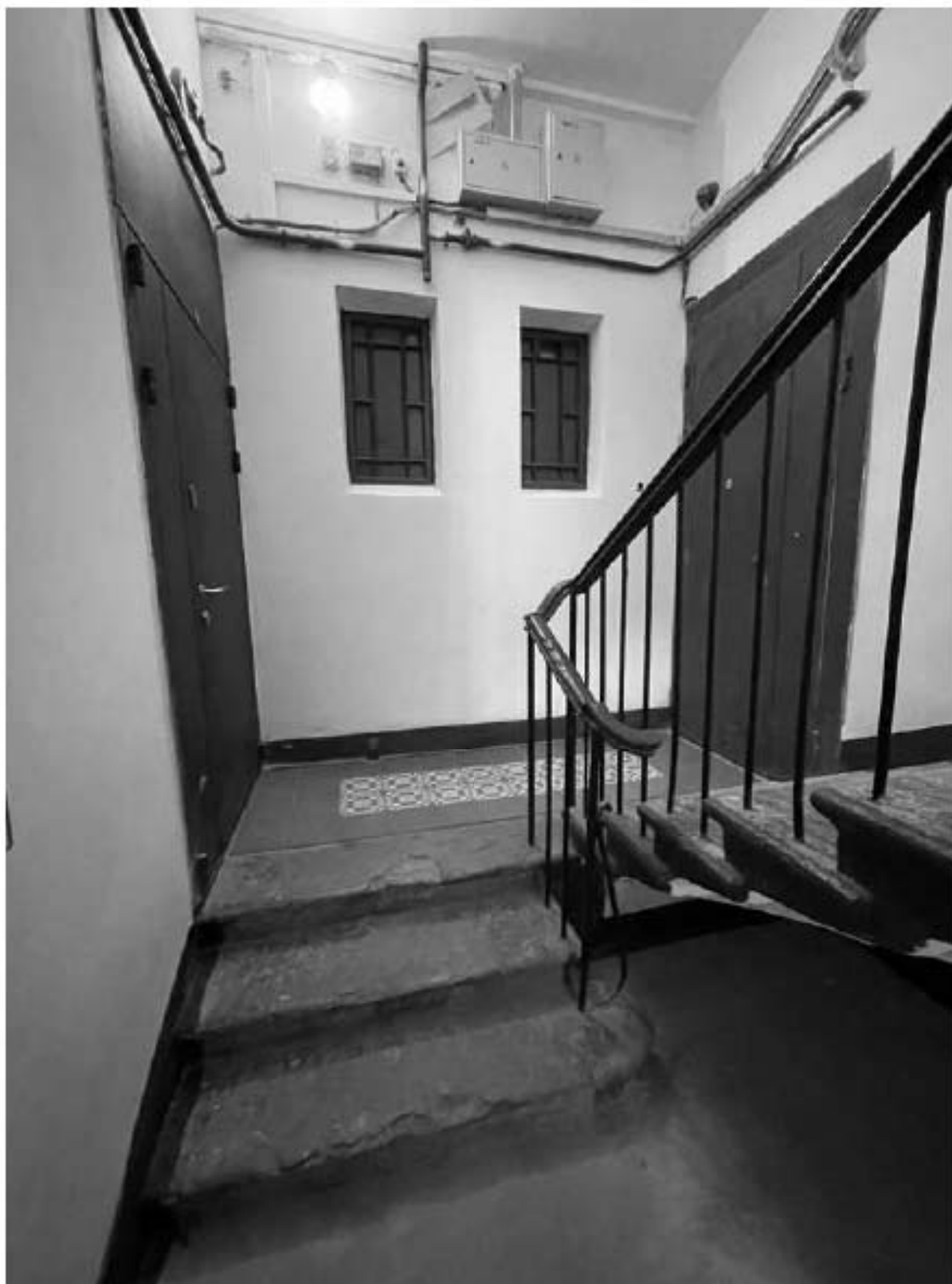
108. Фрагмент интерьера здания по адресу: улица Красного Курсанта, 34, литера А
