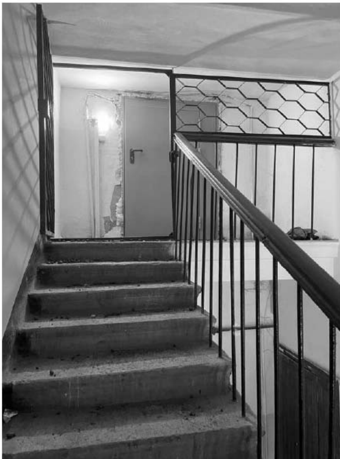
96. Фрагмент интерьера здания по адресу: улица Красного Курсанта, 34, литера А
