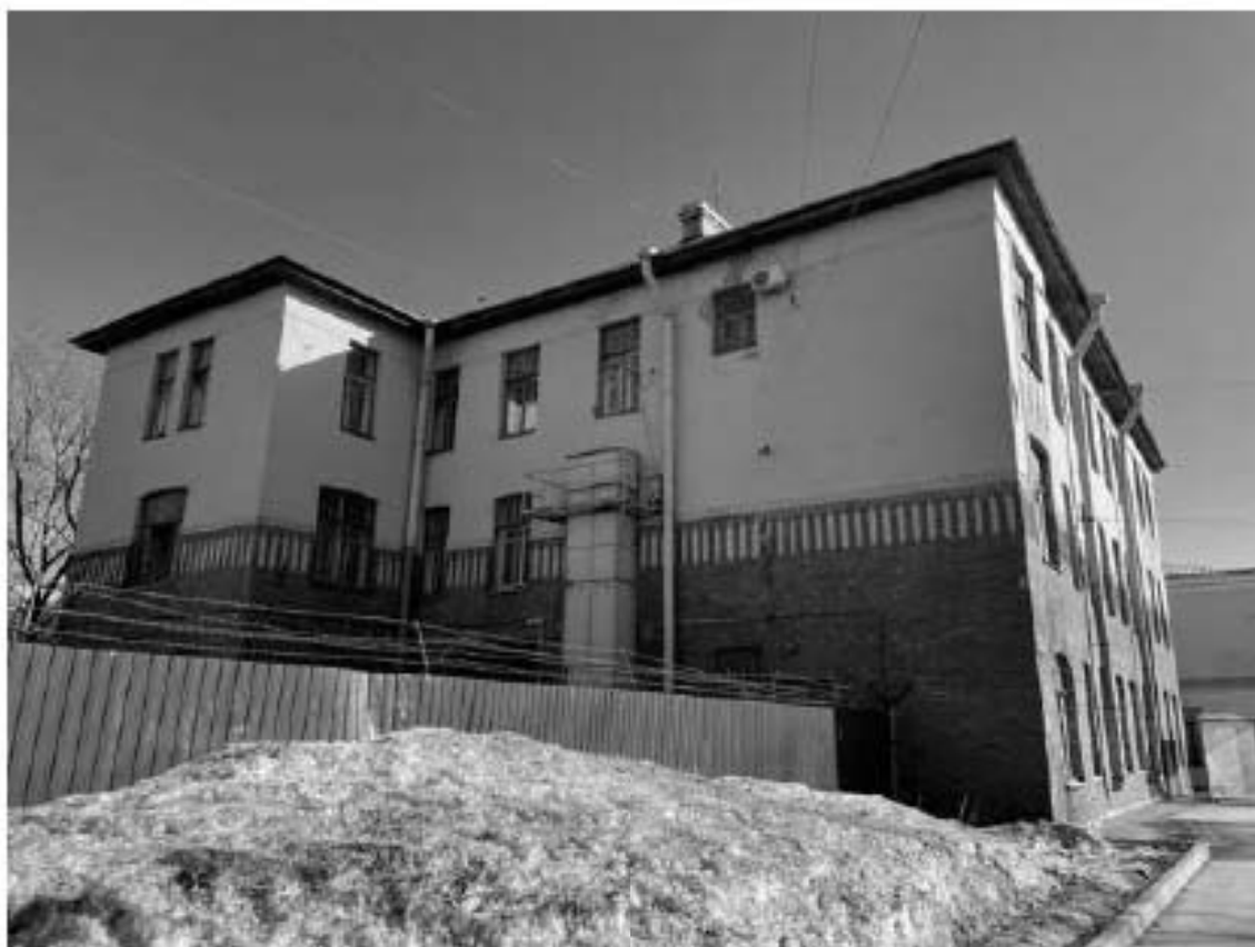
1. Вид на здание по адресу: Ждановская улица, 39, литера А
