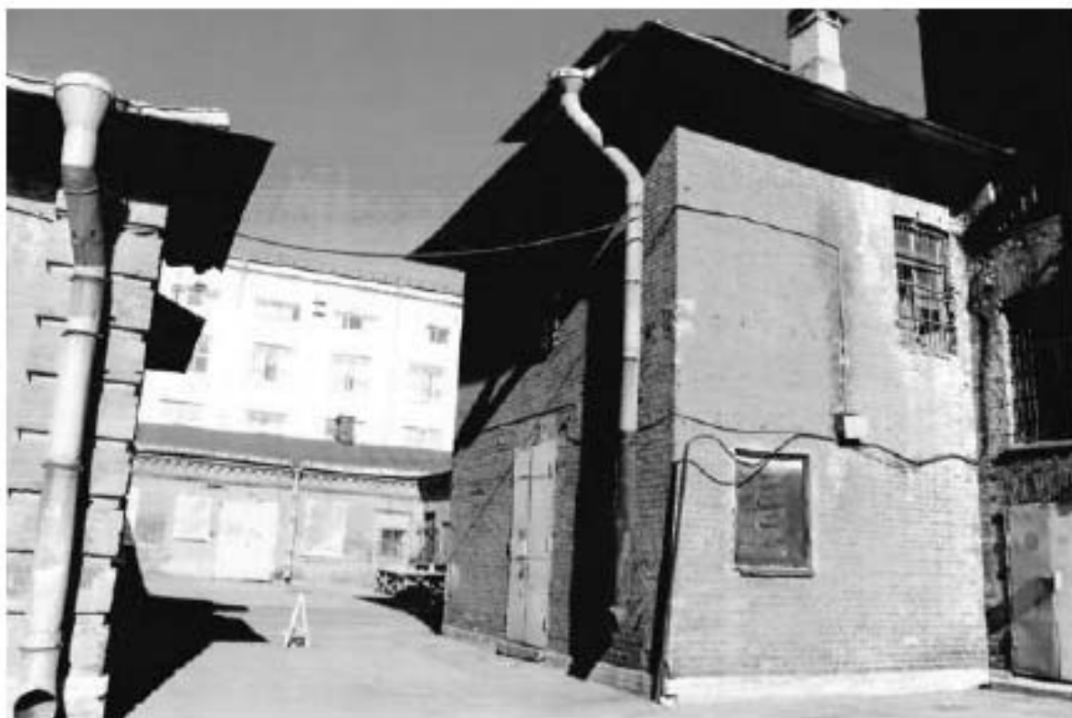
55. Вид на проход между зданиями по адресу: улица Красного Курсанта, 32, литера Б и литера В
