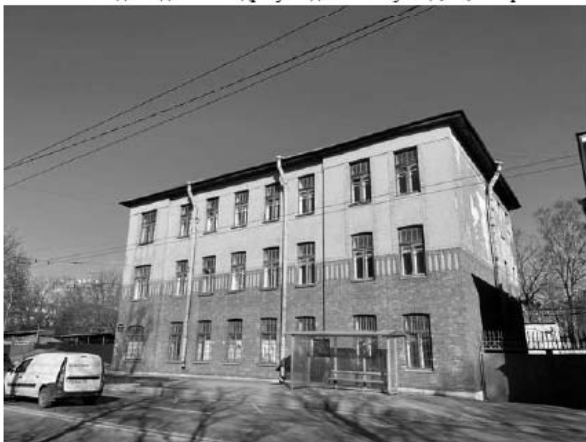
6. Вид на здание по адресу: Ждановская улица, 39, литера А
