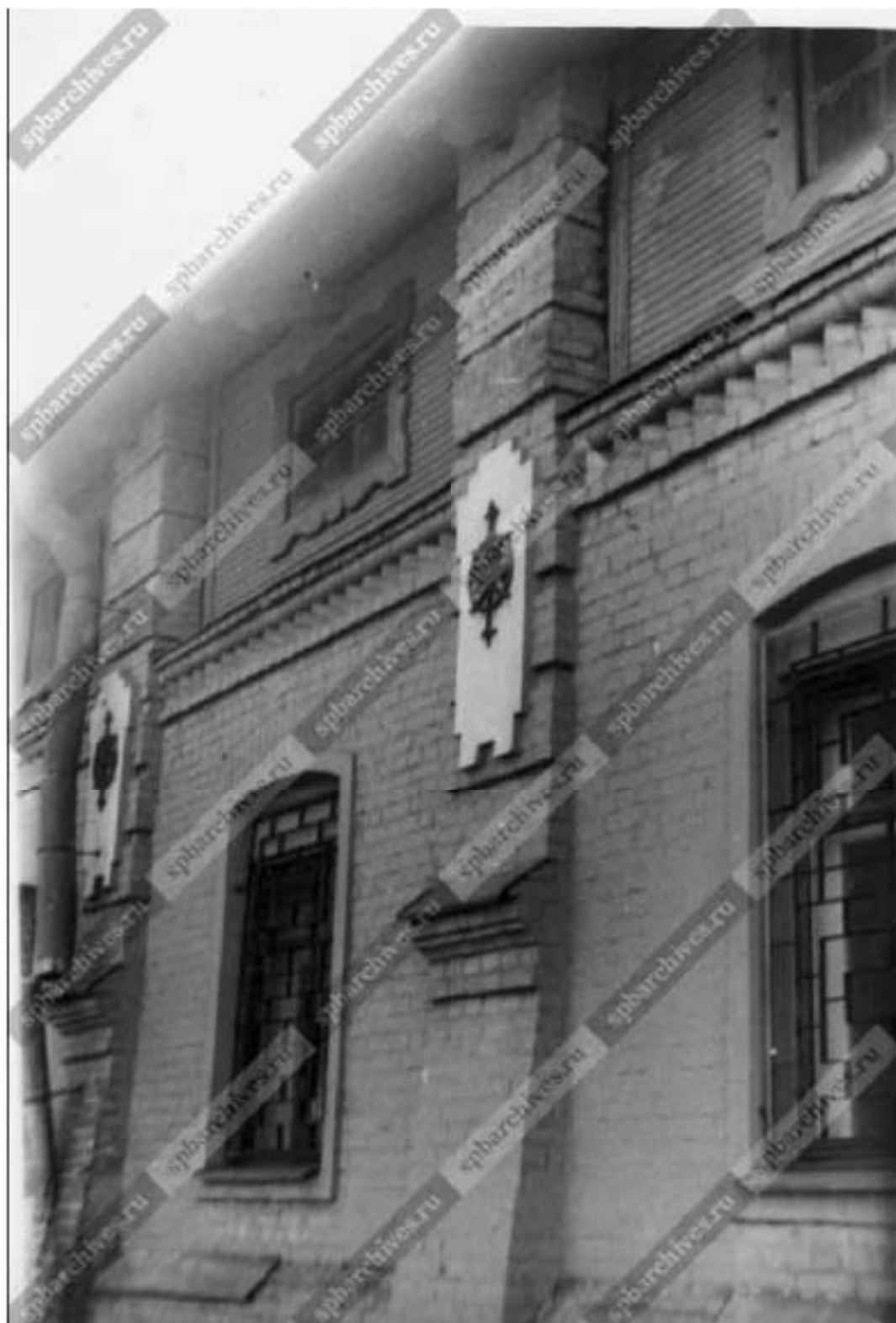
87. Декоративная деталь из металла на кирпичном фасаде дома № 32 по улице Красного Курсанта ( здание Военно -Космической академии им. А.Ф.Можайского, бывший дом Санкт - Петербургской бригады Отдельного корпуса пограничной стражи, архитектор В.А.Шевалев, 1890 -1910 гг.)гг.). 2004 г. ЦГАКФФД СПб. Фотодокументы. Оп.1АР-154. Ед.хр.215827
