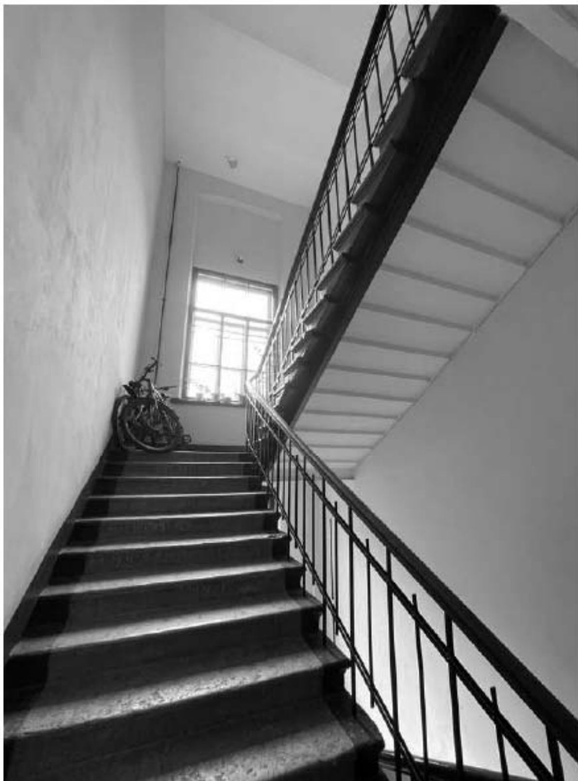
86. Фрагмент интерьера здания по адресу: улица Красного Курсанта, 34, литера Б
