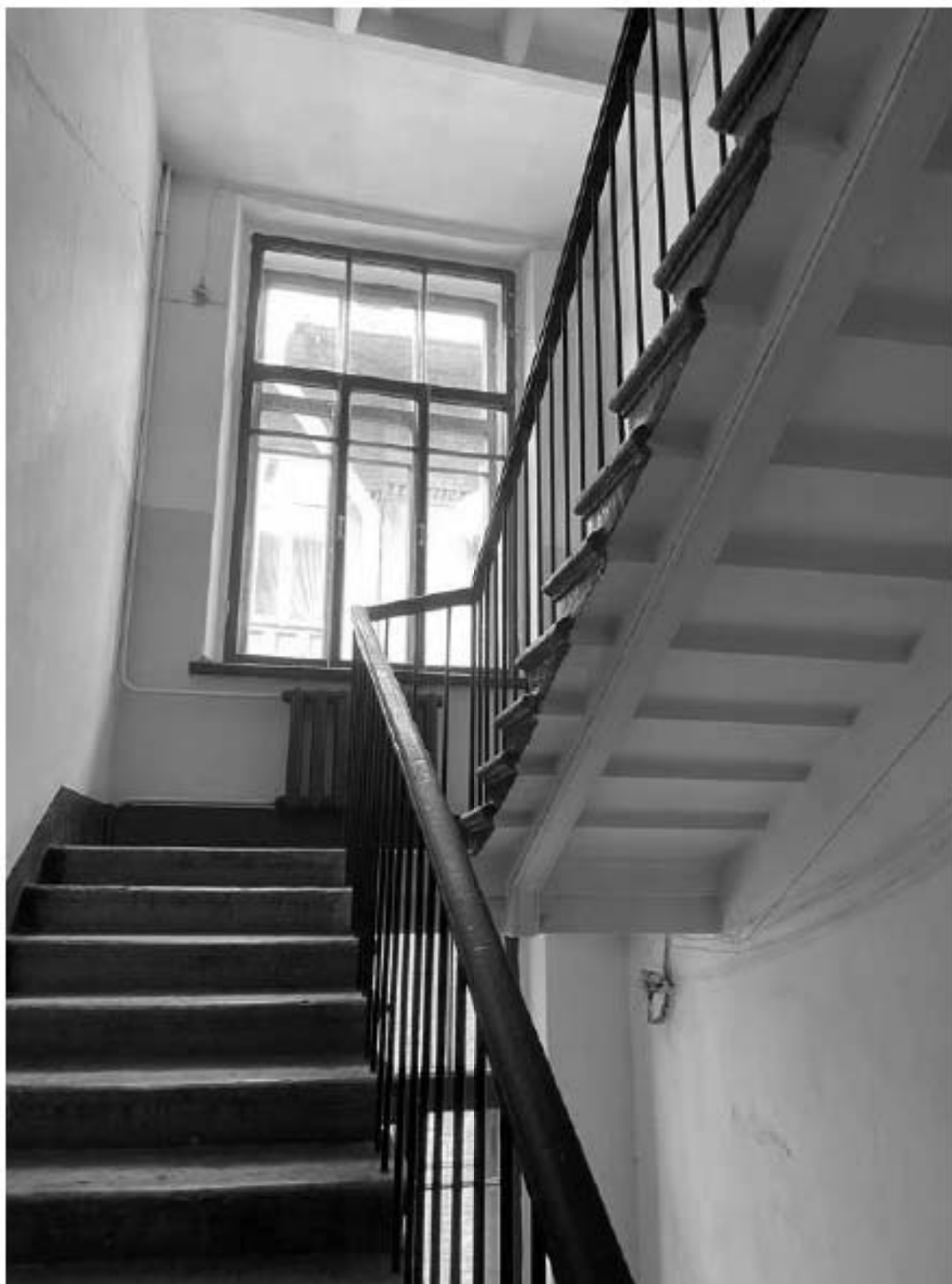
93. Фрагмент интерьера здания по адресу: улица Красного Курсанта, 34, литера А
