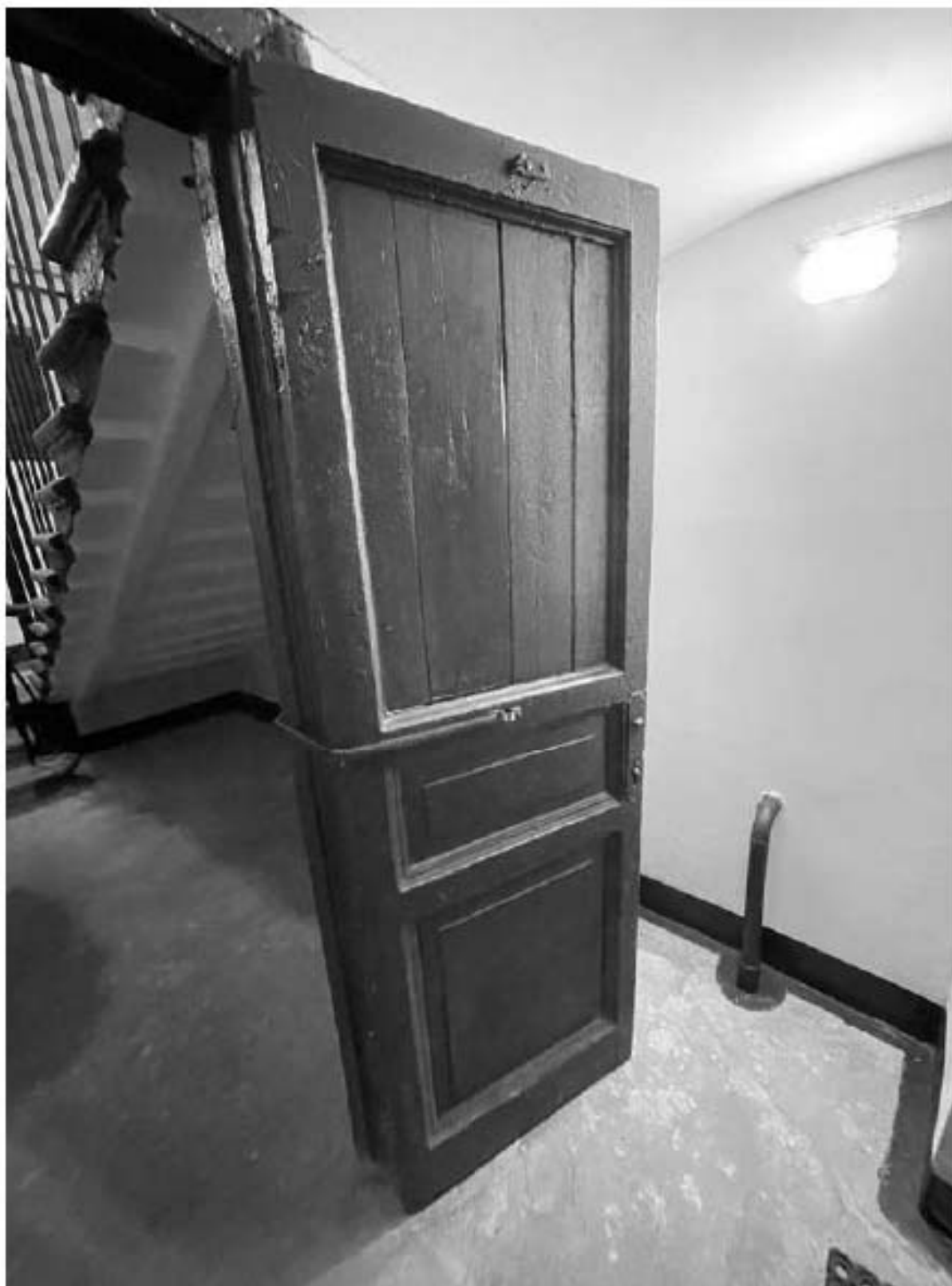
109. Фрагмент интерьера здания по адресу: улица Красного Курсанта, 34, литера А
