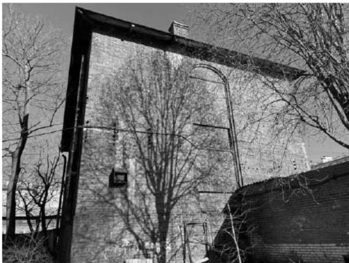
37. Вид на здание по адресу: улица Красного Курсанта, 34, №18/14
