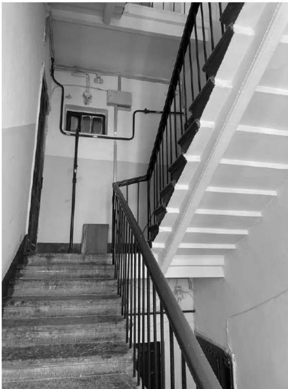
94. Фрагмент интерьера здания по адресу: улица Красного Курсанта, 34, литера А
