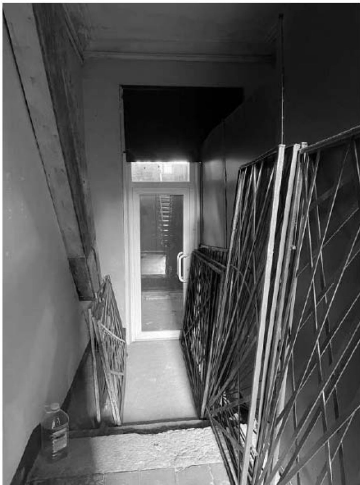
100. Фрагмент интерьера здания по адресу: улица Красного Курсанта, 34, литера А
