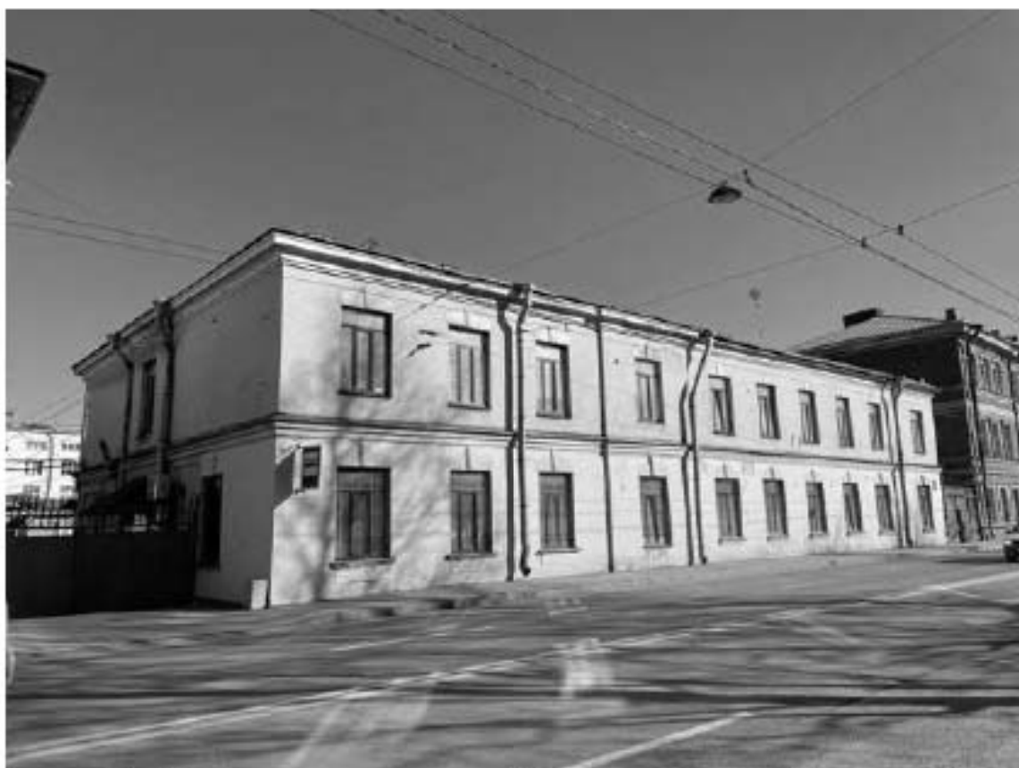
5. Вид на здание по адресу: Ждановская улица, 37, литера А
