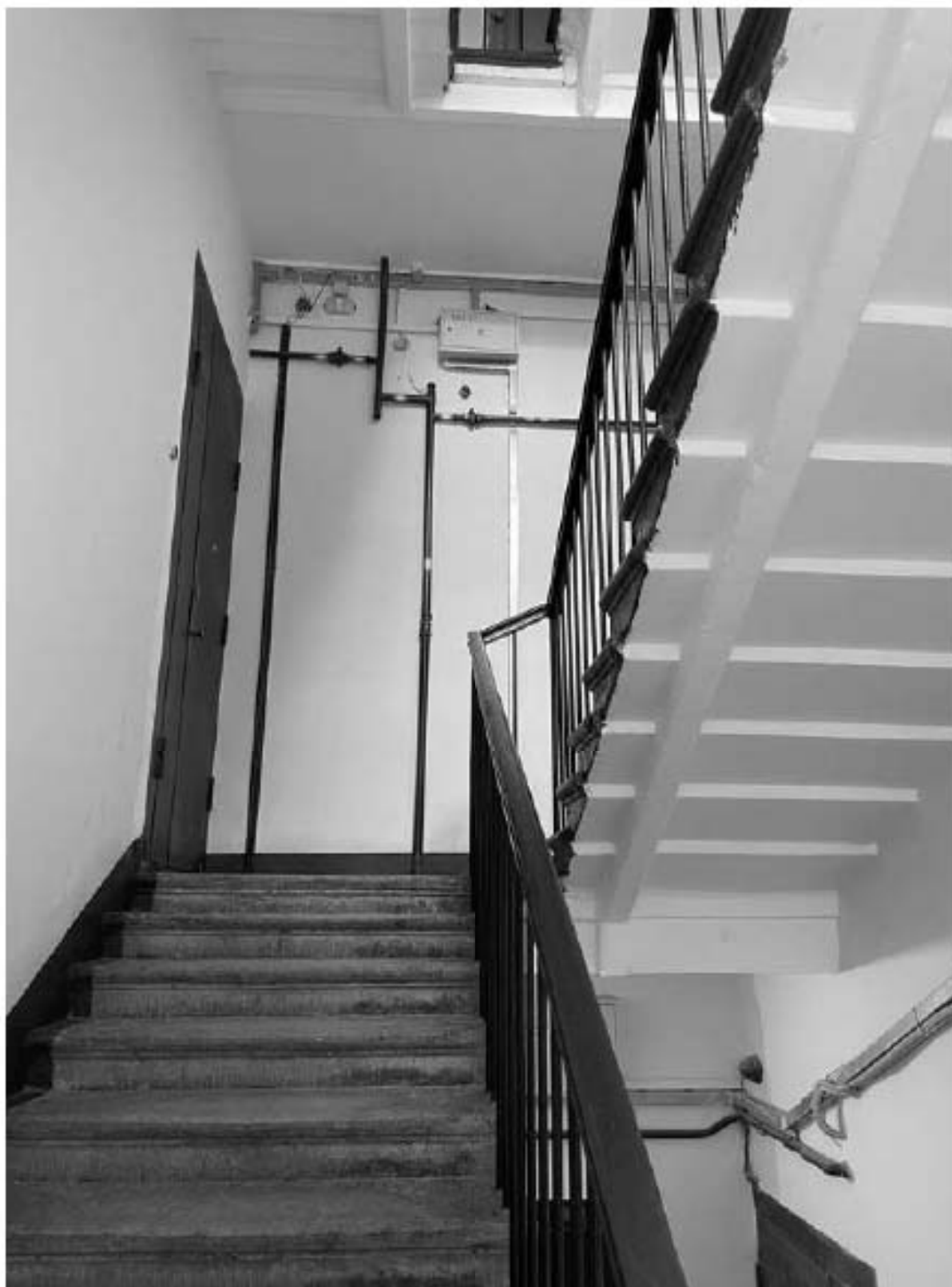
113. Фрагмент интерьера здания по адресу: улица Красного Курсанта, 34, литера А
