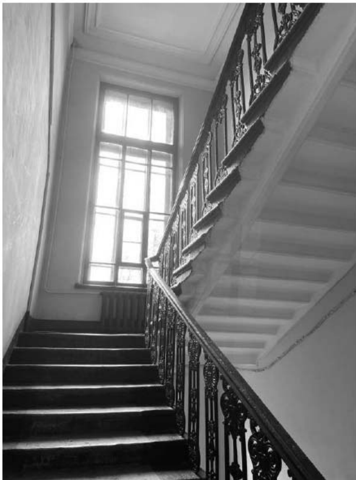
105. Фрагмент интерьера здания по адресу: улица Красного Курсанта, 34, литера А
