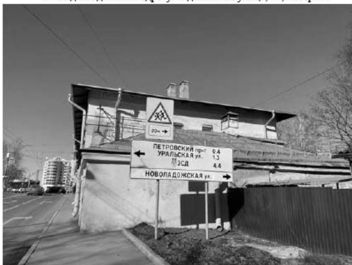
2. Вид на здание по адресу: Ждановская улица, 41, литера А
