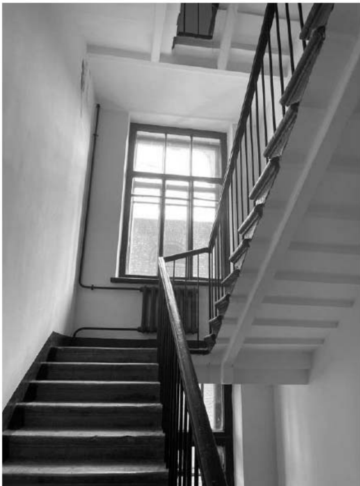
114. Фрагмент интерьера здания по адресу: улица Красного Курсанта, 34, литера А
