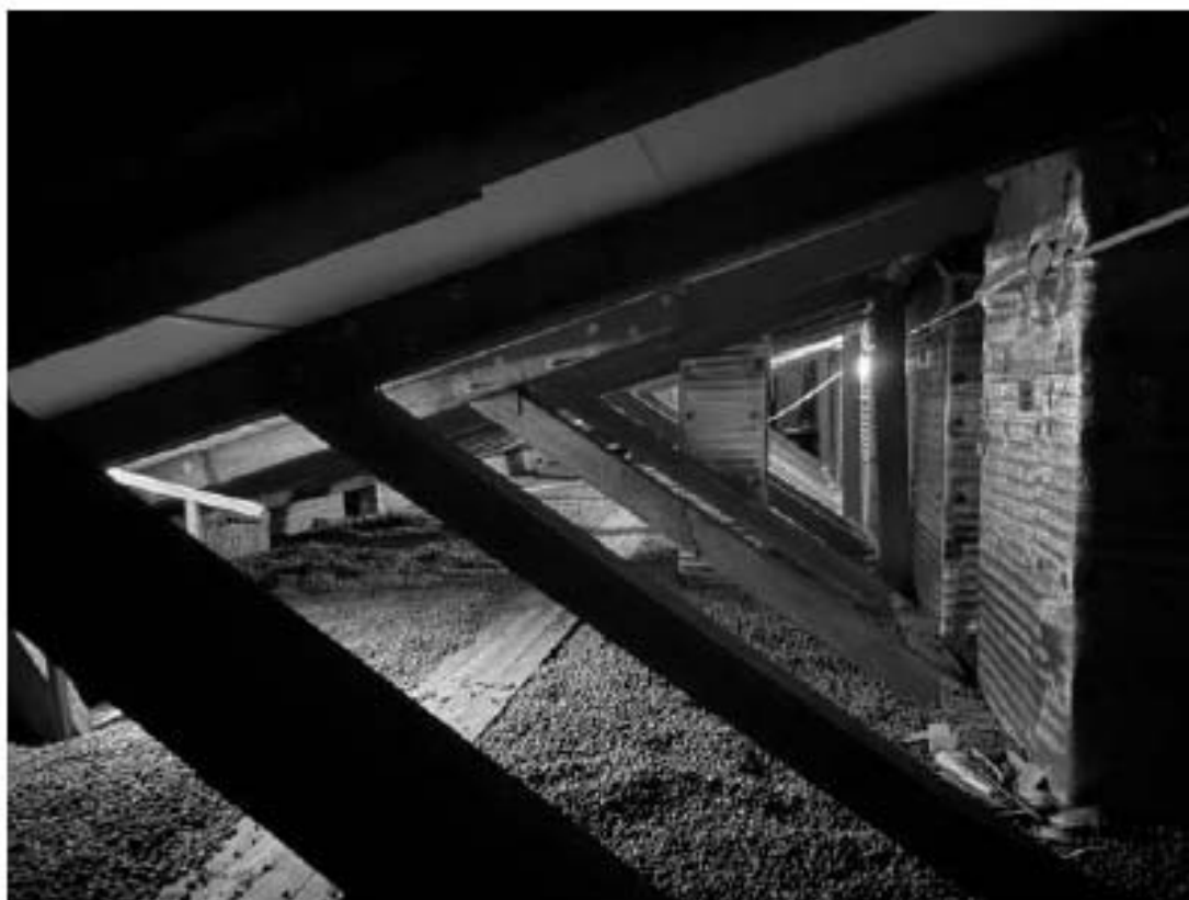
97. Фрагмент интерьера здания по адресу: улица Красного Курсанта, 34, литера А
