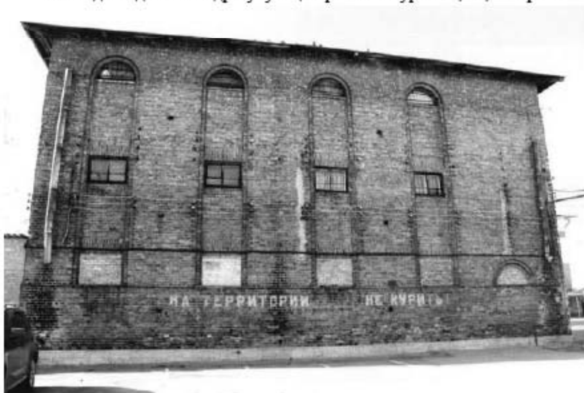
62. Вид на здание по адресу: улица Красного Курсанта, 34, №18/14
