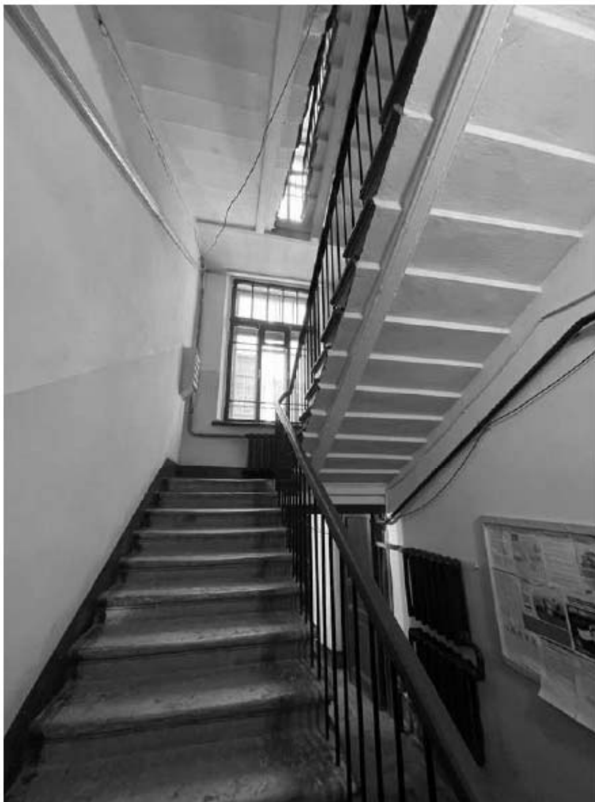
90. Фрагмент интерьера здания по адресу: улица Красного Курсанта, 34, литера А
