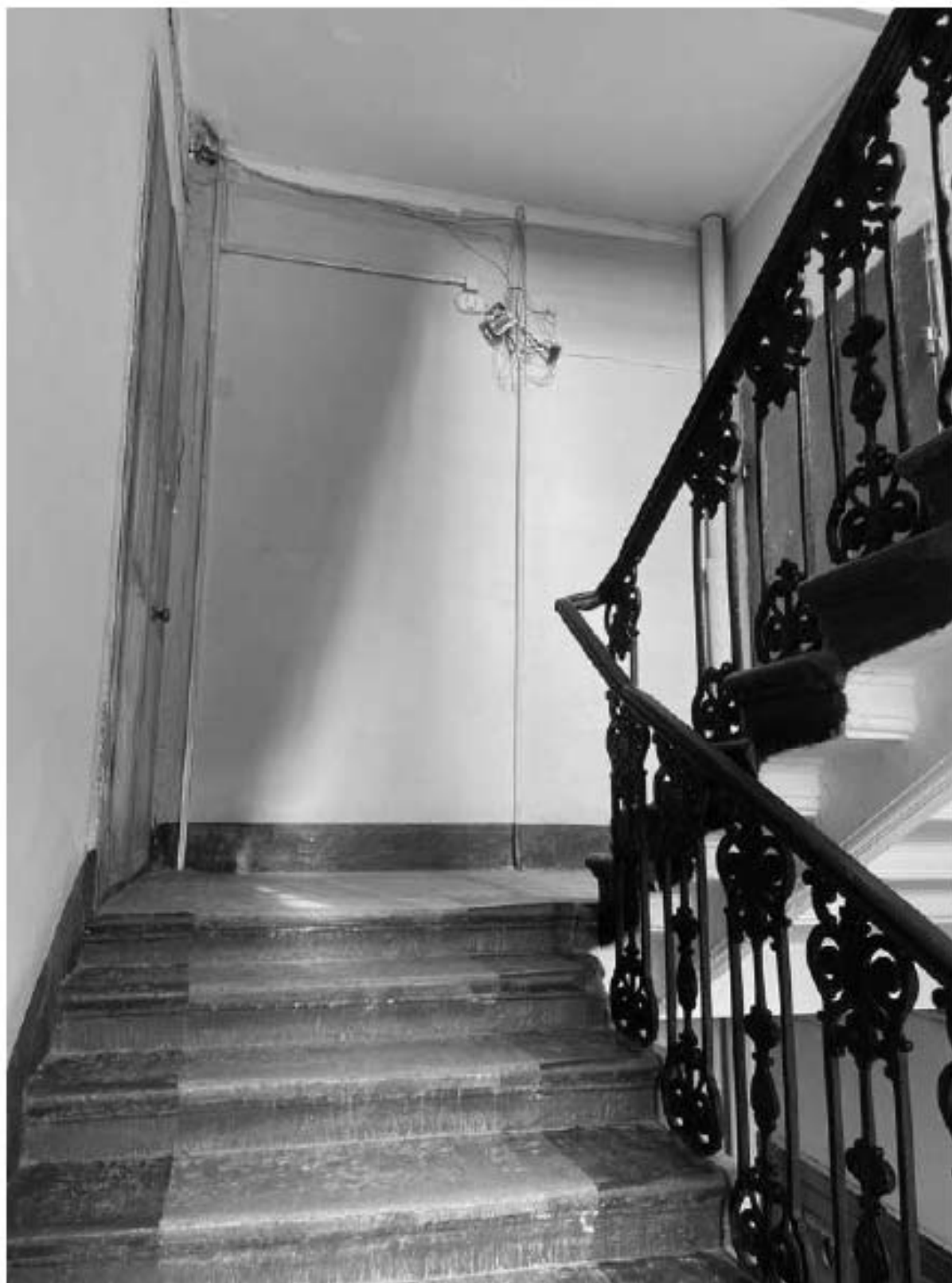
103. Фрагмент интерьера здания по адресу: улица Красного Курсанта, 34, литера А
