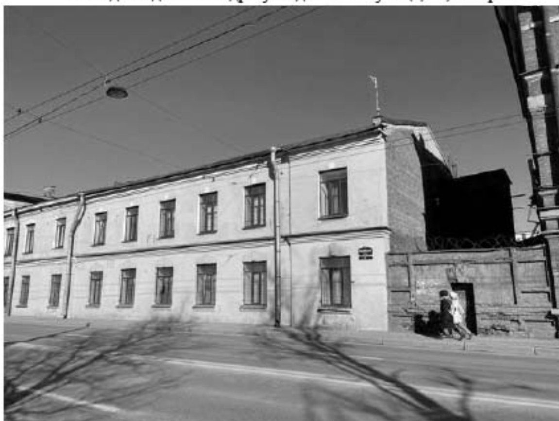
8. Вид на здание по адресу: Ждановская улица, 37, литера А
