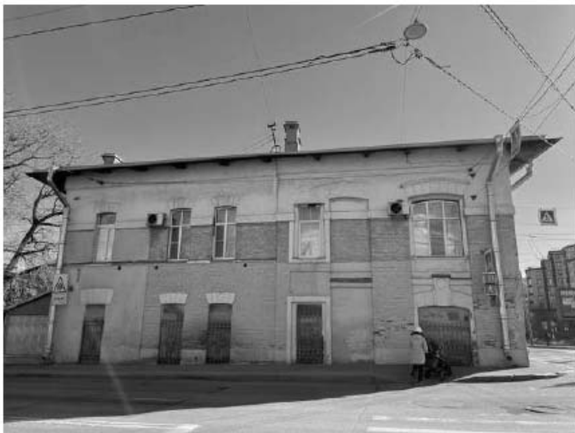
11. Вид на здание по адресу: Ждановская улица, 41, литера А
