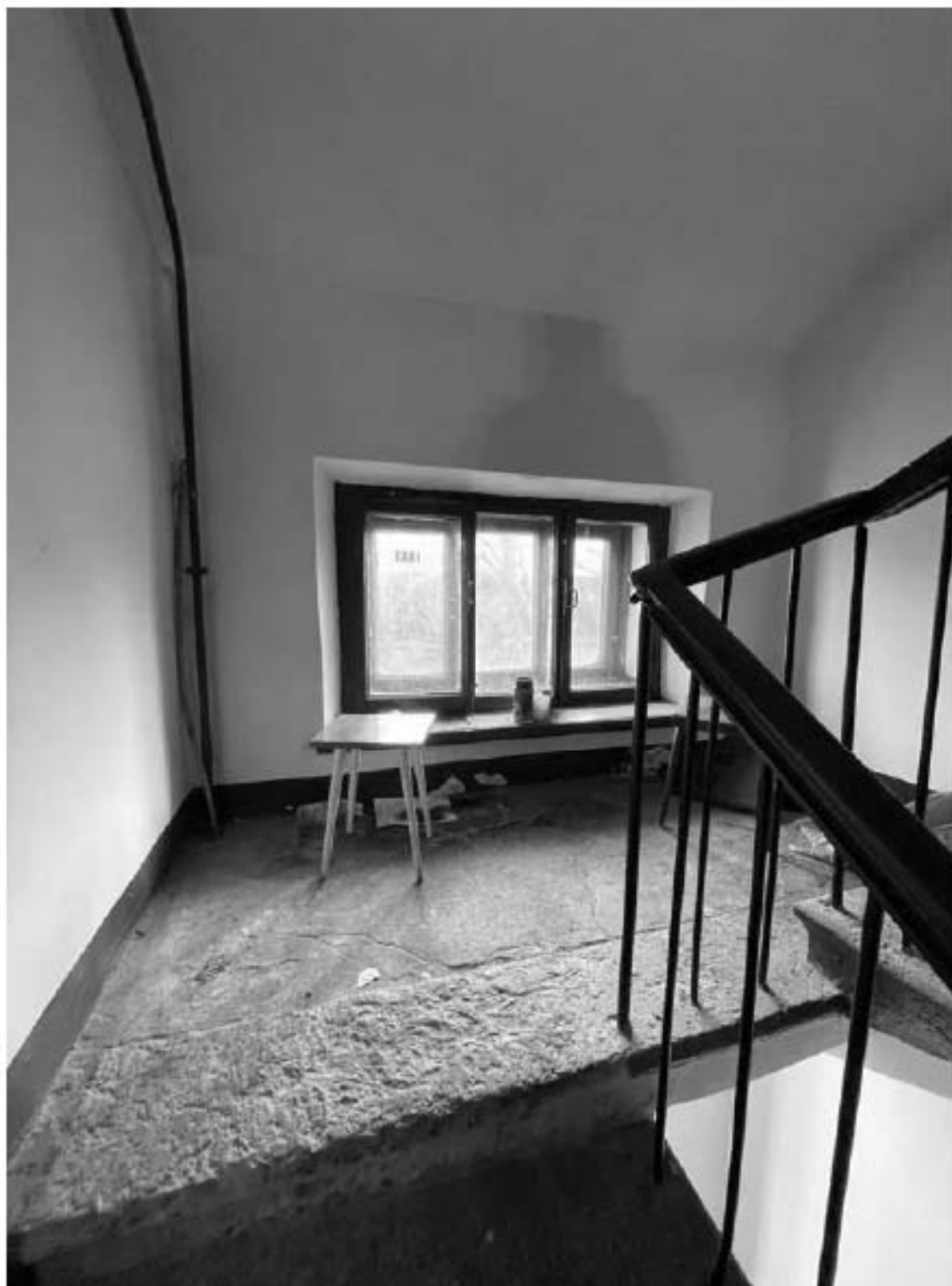
117. Фрагмент интерьера здания по адресу: улица Красного Курсанта, 34, литера А
