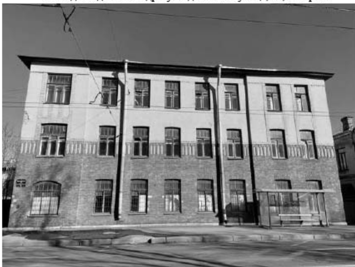
4. Вид на здание по адресу: Ждановская улица, 39, литера А
