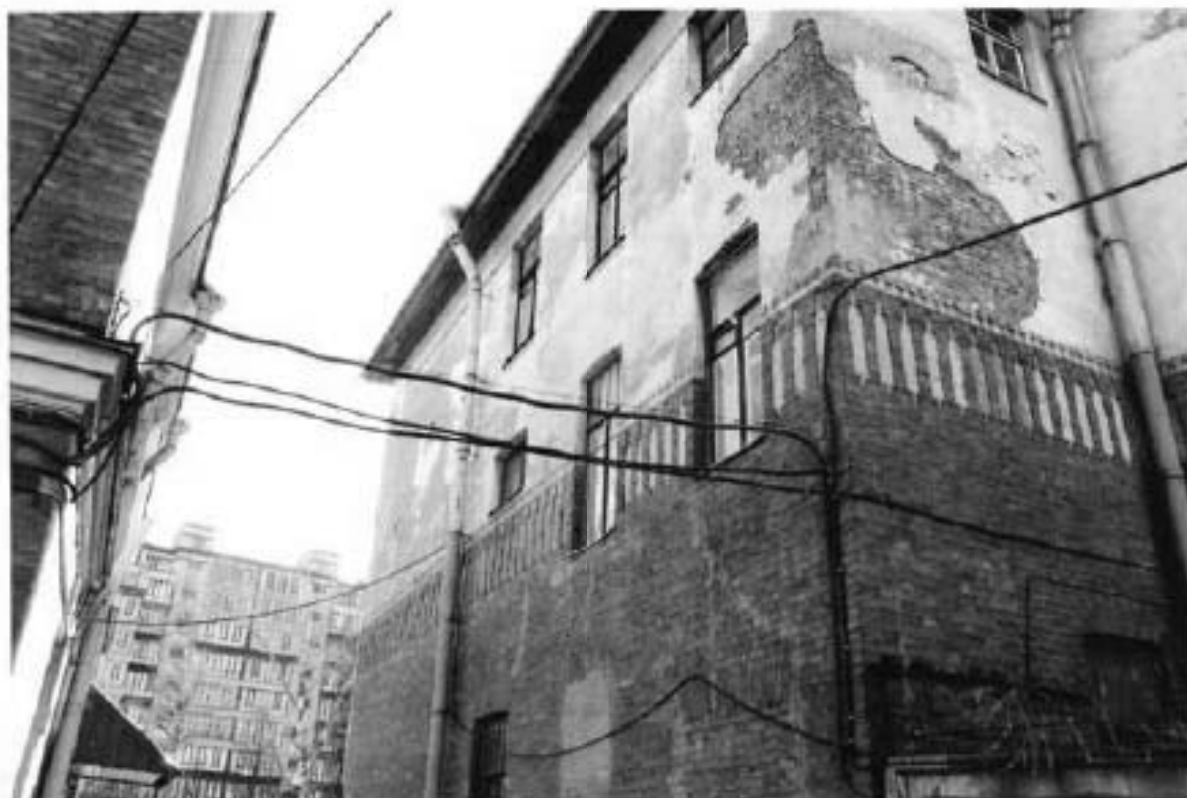
45. Вид на здание по адресу: Ждановская улица, 39, литера А
