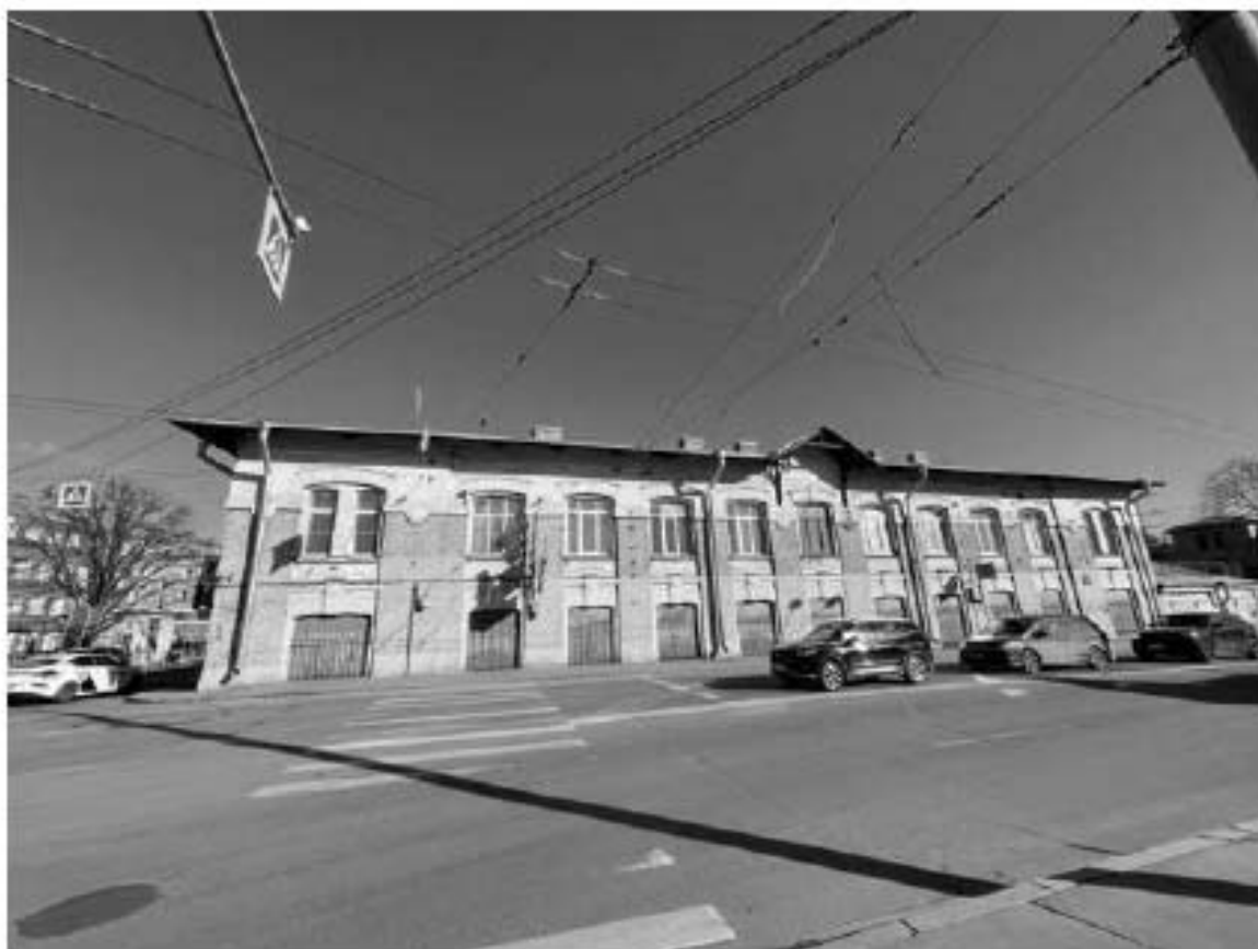
3. Вид на здание по адресу: Ждановская улица, 41, литера А
