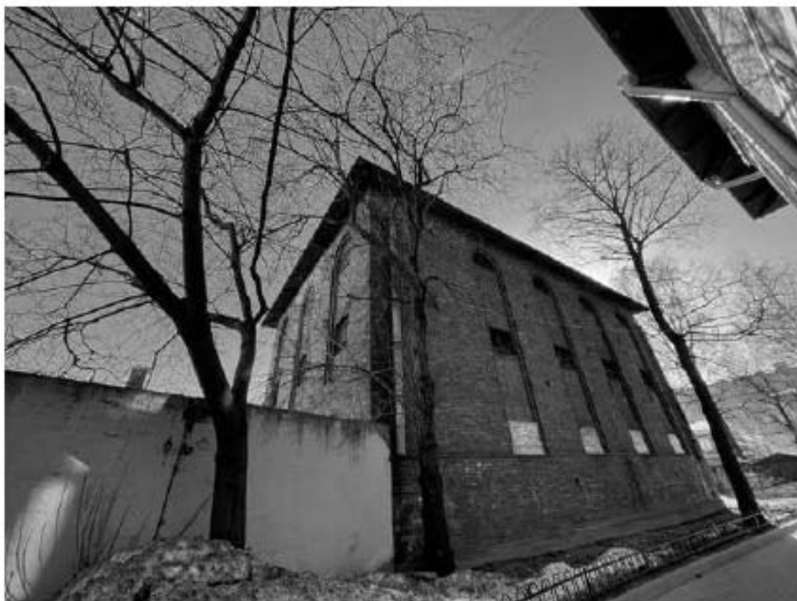
33. Вид на здание по адресу: улица Красного Курсанта, 34, №18/14
