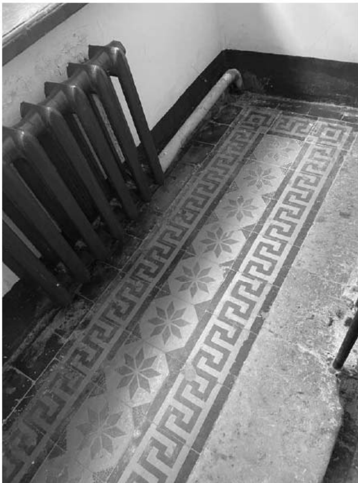
91. Фрагмент интерьера здания по адресу: улица Красного Курсанта, 34, литера А
