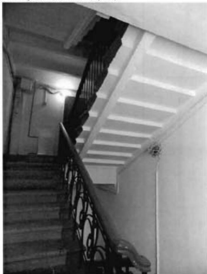
10. Лестница Л-2 (западный корпус)
