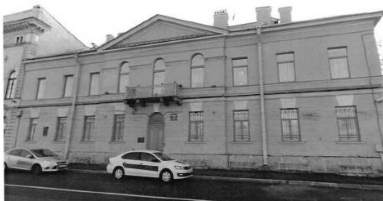
2. Фасад по Английской набережной
