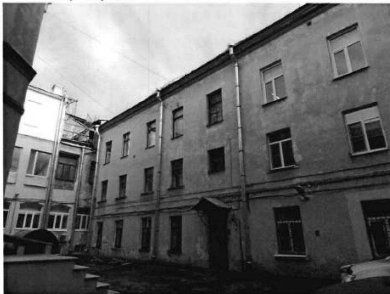
6. Восточный дворовый фасад
