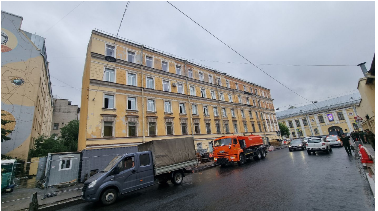
1. Вид на юго-западный фасад объекта культурного наследия регионального значения «Здание, где с 1886 г. размещалось военно-топографическое училище, в котором преподавали Цингер Н.Я. и Витковский В.В.» расположенный по адресу: г. Санкт-Петербург, Пионерская ул., д. 20, литера Б, от места производства работ. 14.06.2024
