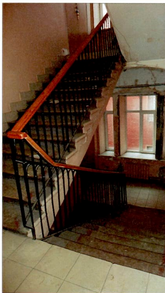
12. Лестница в северном крыле лицевого корпуса в уровне 3-го этажа.
