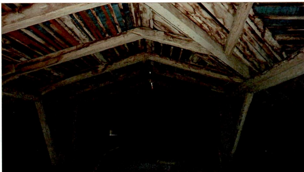
7. Чердак. Стропильная система.
