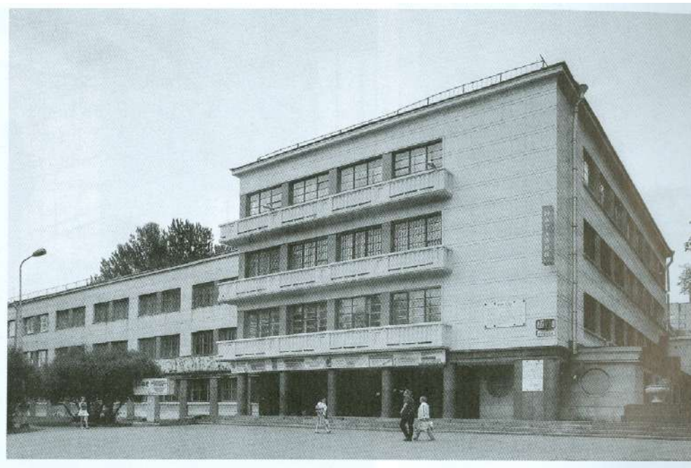
9. Архитекторы А.И. Гегелло, Д.Л. Кричевский. Дворец культуры им. И.И. Газа. Фотография. 2000-е гг. Опубликовано в: Кириков Б.М., Штиглиц М.С. Архитектура Ленинградского авангарда. Под общей редакцией Б.М. Кирикова. СПб., 2008 г. С. 129.
