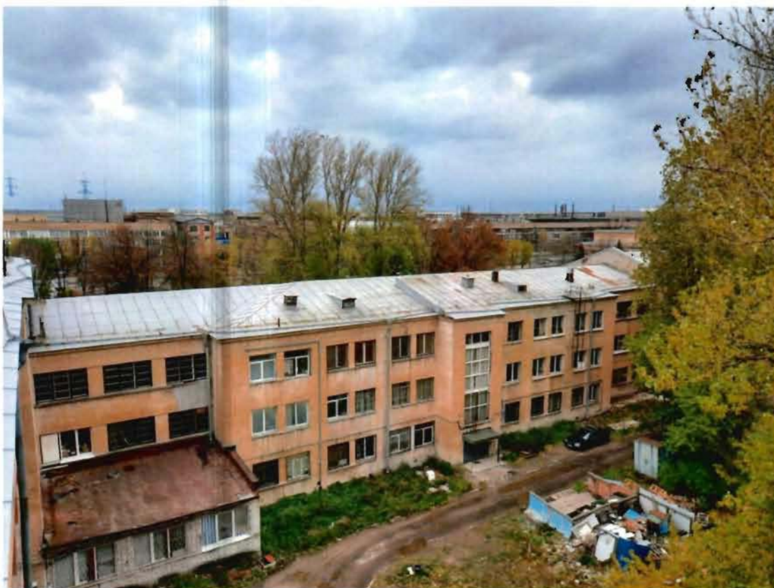
7. Вид на дворовой западный фасад объекта культурного наследия
