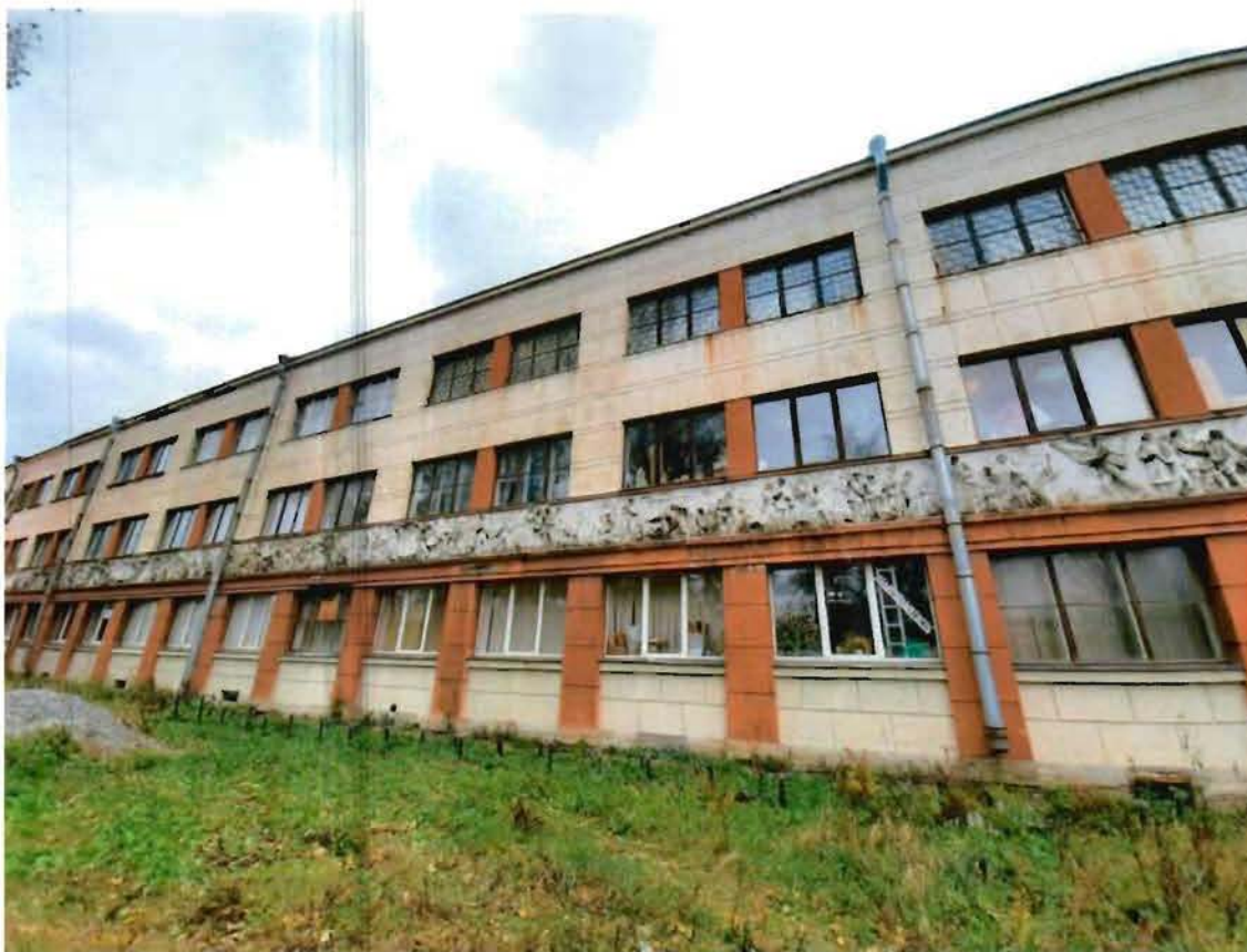
2. Вид на северную часть западного фасада объекта культурного наследия
