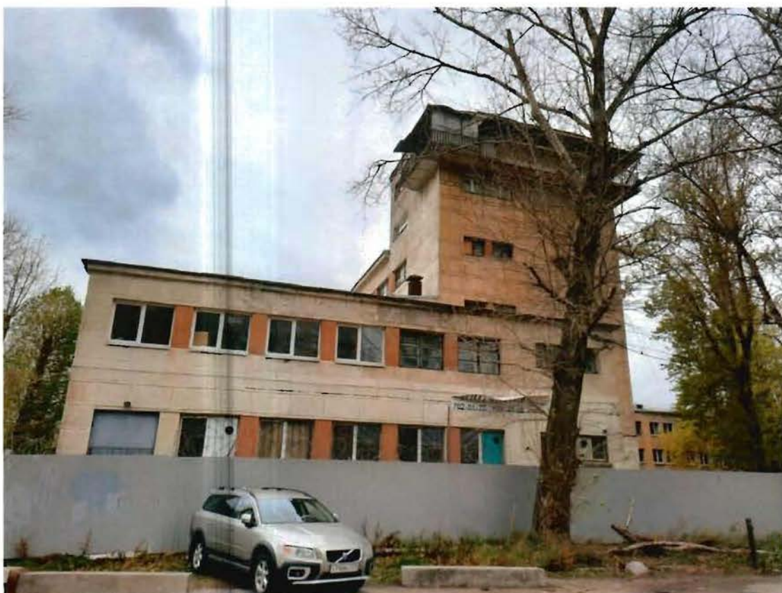
5. Вид на восточный фасад объекта культурного наследия
