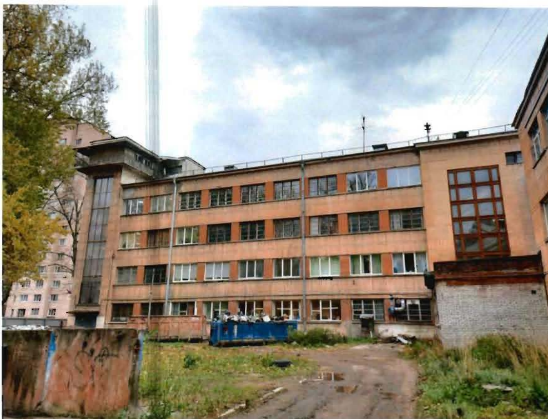
6. Вид на дворовой южный фасад объекта культурного наследия
