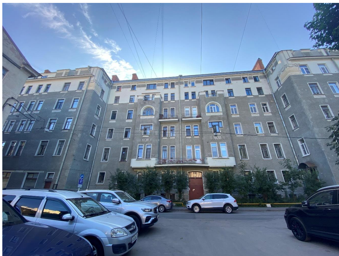
Фото 5. Лицевой фасад исследуемого здания по Большому Казачьему переулку.
