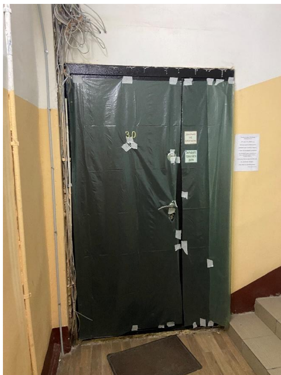
Фото 1. Вид на входную дверь.
