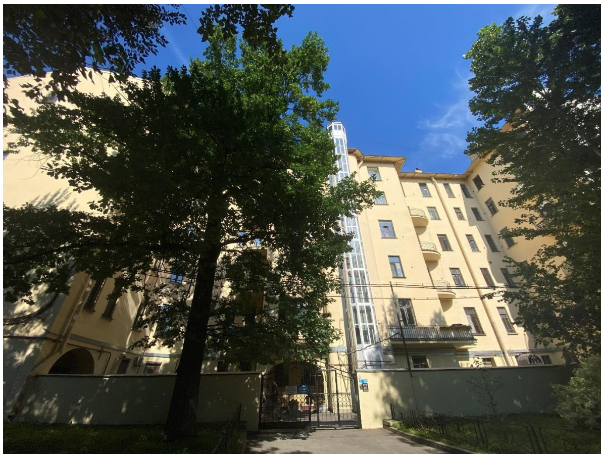
Фото 4. Дворовый фасад исследуемого здания.
