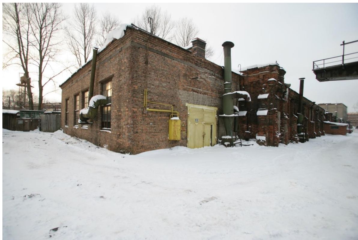
46. ВОКН «Здание инструментального цеха». Восточная пристройка н-1 и основное здание Н. Вид с северо-востока. Фотография начала 2000-х гг.
