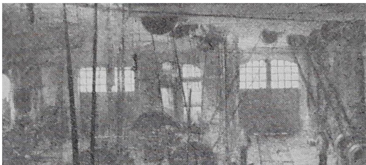
27. Колесная мастерская в западной части здания ВОКН «Здание инструментального цеха». Фрагмент снимка с проемами в западной стене. Фотография сделана между 1902 и 1913 гг. // Исторический очерк сооружения и эксплуатации С.-Петербургско-Варшавской железной дороги с ветвью к прусской границе: 1862-1912 г. Вып. 4. Подвижной состав и оборудование мастерских и заводов. СПб., 1913. Чертеж №48.
