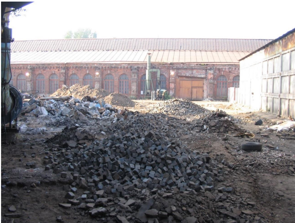
43. ВОКН «Здание инструментального цеха». Литер Н. Фрагмент северного фасада с воротным проемом в центре. Фотография начала 2000-х годов.
