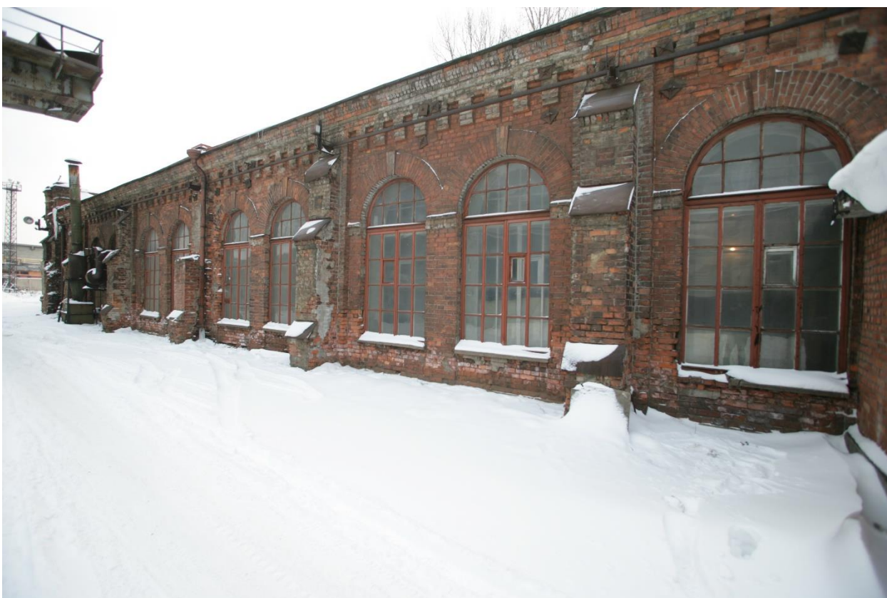
48. ВОКН «Здание инструментального цеха». Восточный фрагмент северного фасада литеры Н. Вид с северо-запада. Фотография начала 2000-х гг.
