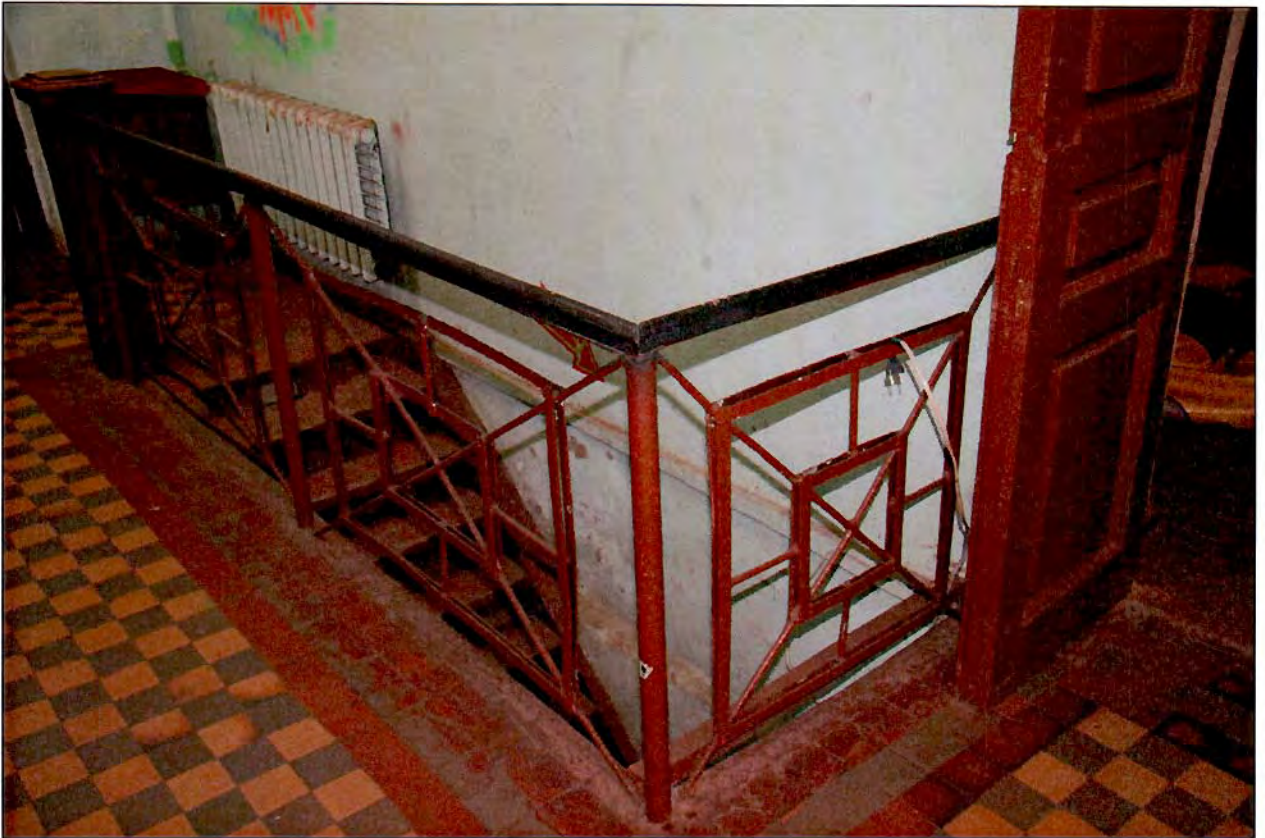
9. Интерьер. Лестница в подвал.
