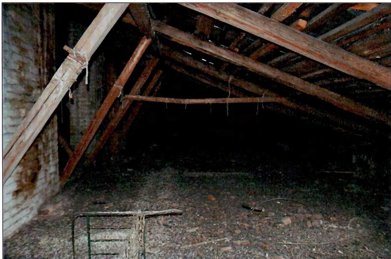
14. Интерьер. Чердак. Стропильная система.
