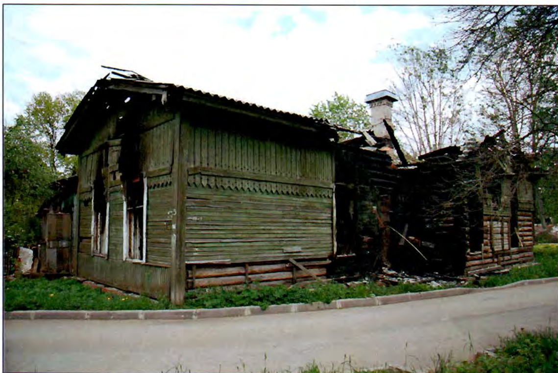
16. Общий вид. Юго-западный фасад.
