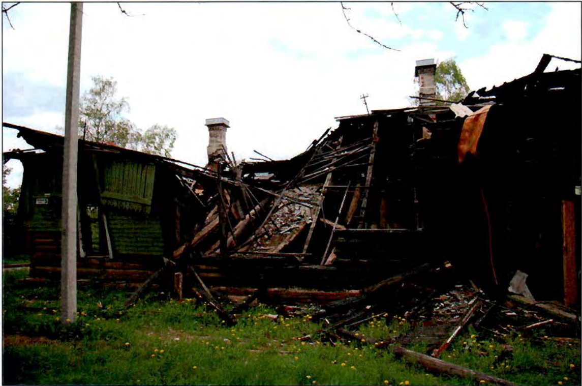
19. Фрагмент. Северо-восточный фасад.
