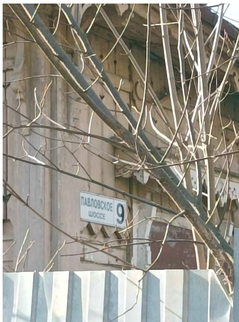
20. "Жилой дом для мальчиков с холостым надзирателем", по адресу: Санкт-Петербург, г. Павловск, Павловское шоссе, д. 9, лит. А. Фрагмент северного фасада. Дата съемки: 25.03.2024 г.
