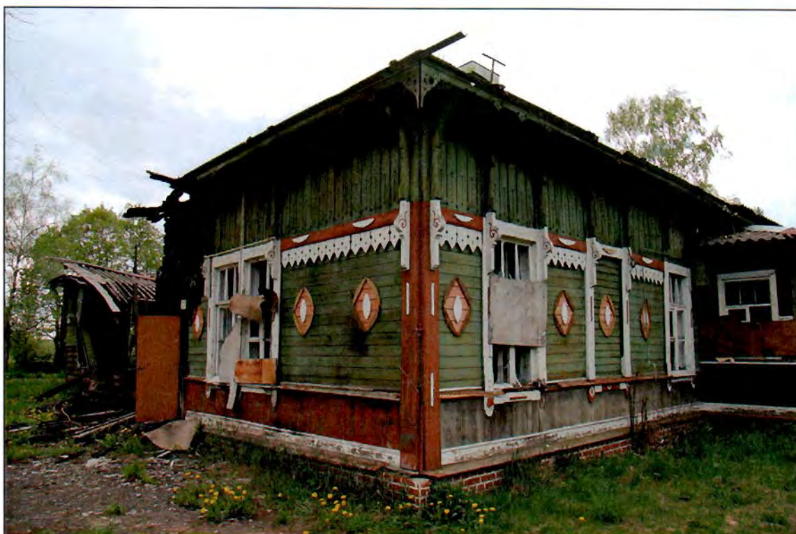
17. Общий вид. Северо-восточный фасад.
