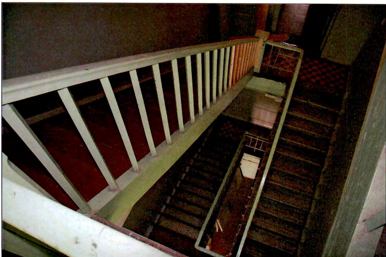
13. Интерьер. Главная лестница.
