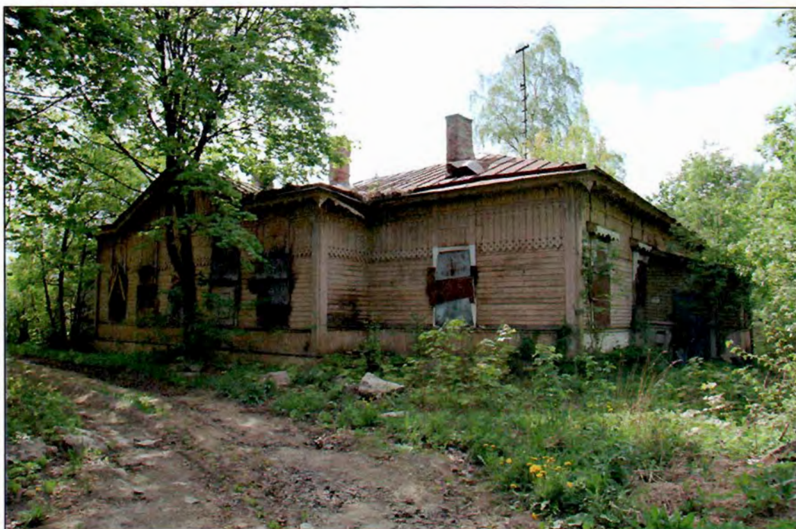
22. Общий вид. Юго-восточный фасад.
