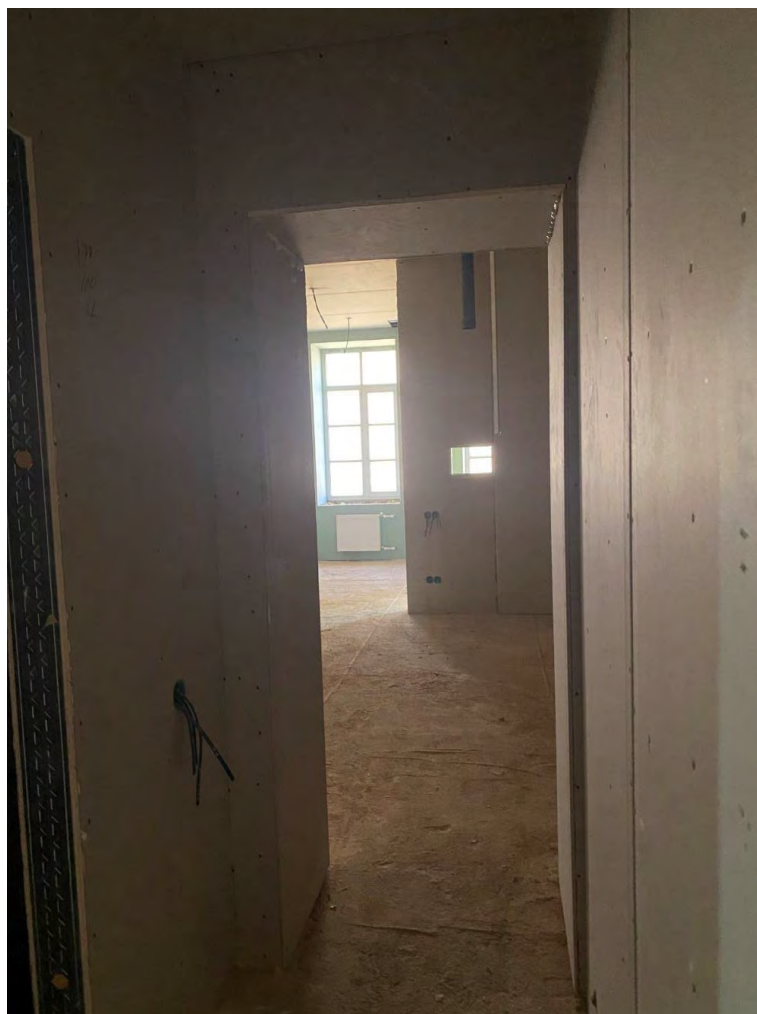
Фото №25. Помещение на третьем этаже. Сентябрь 2024г.
