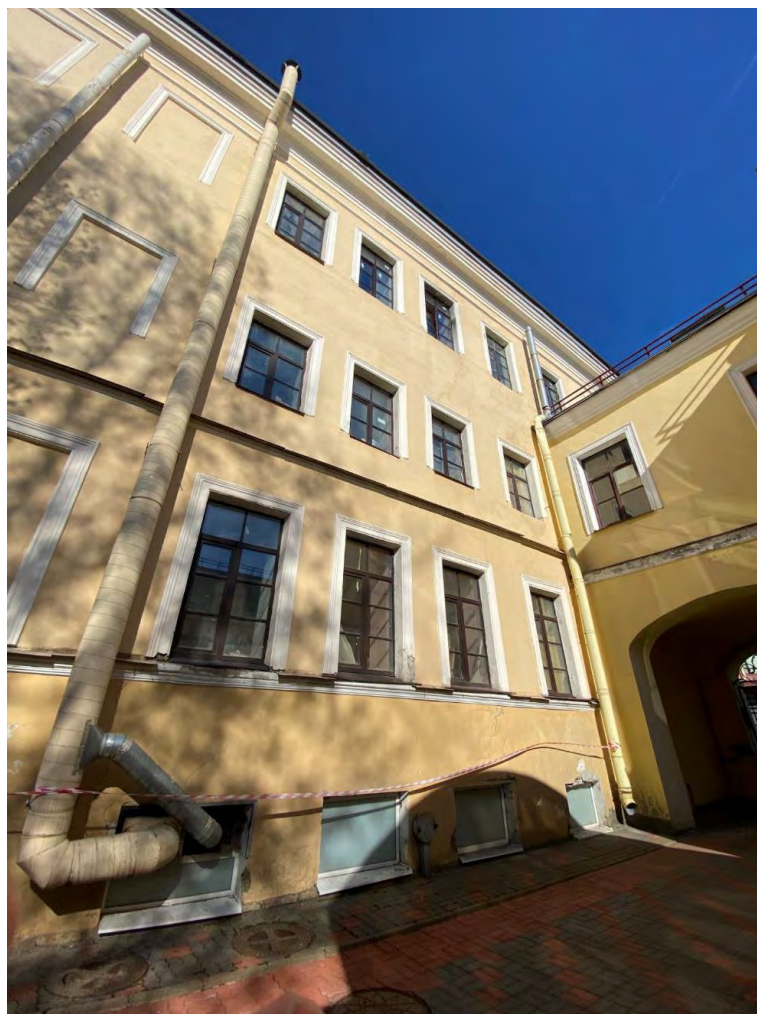
Фото №4. Фрагмент фасада по Звенигородской улице. Сентябрь 2024г.
