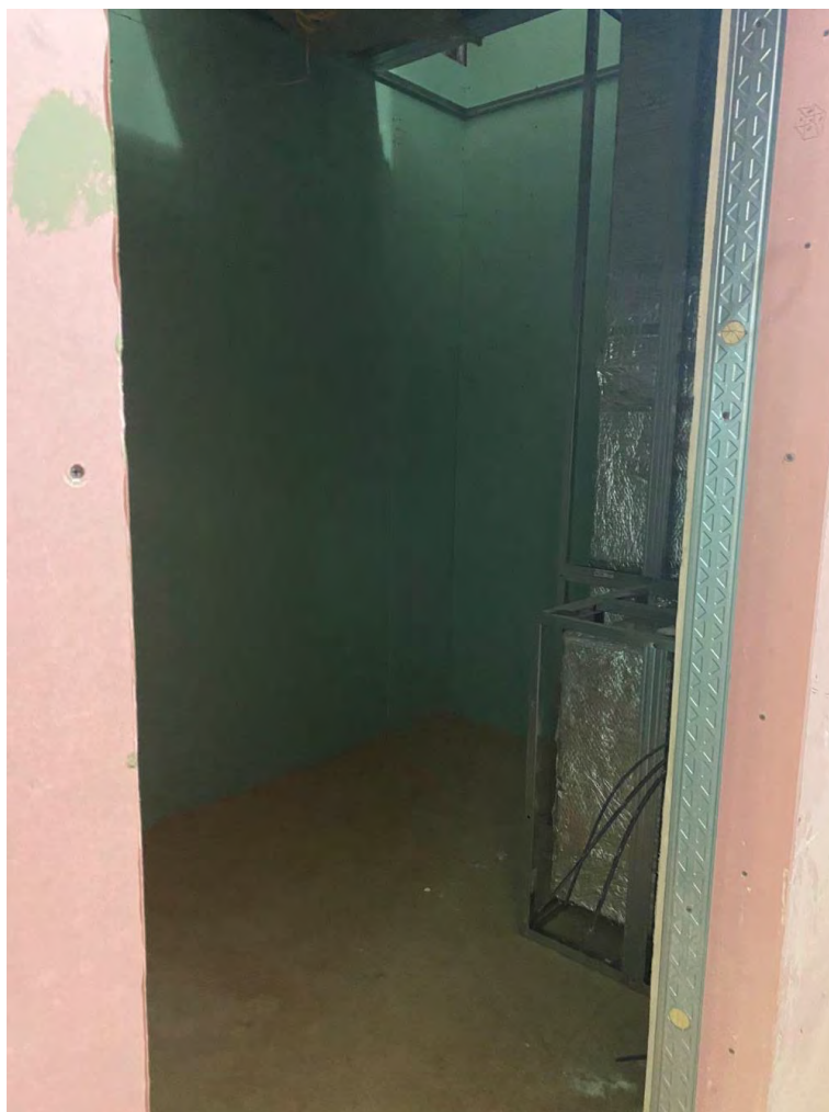
Фото №8. Помещение первого этажа. Сентябрь 2024г.
