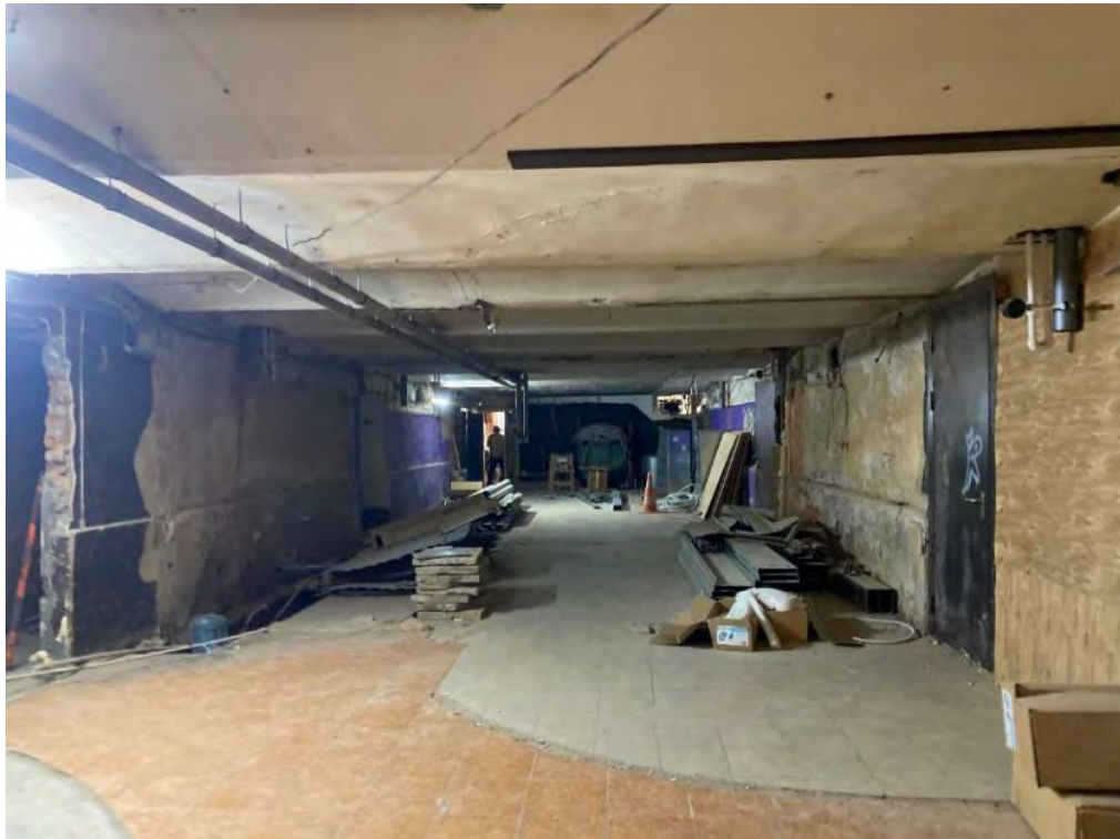
Фото №45 Коридор цокольного этажа. Сентябрь 2024г.
