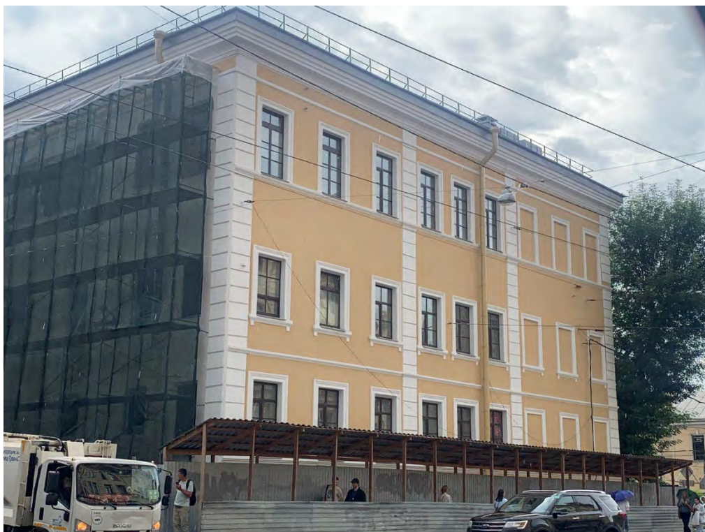
Фото №1. Фрагмент фасада по Звенигородской улице. Сентябрь 2024г.
