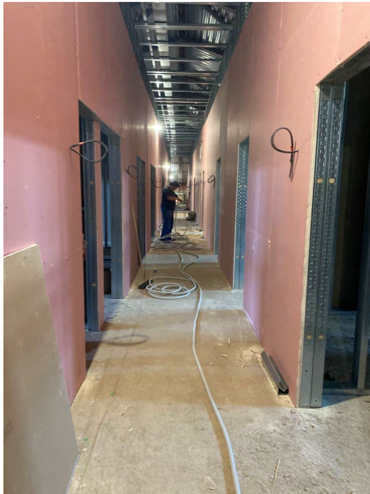
Фото №39. Коридор в мансарде. Сентябрь 2024г.
