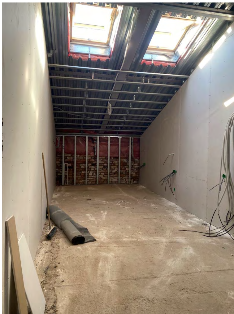
Фото №35. Помещение на мансарде. Сентябрь 2024г.
