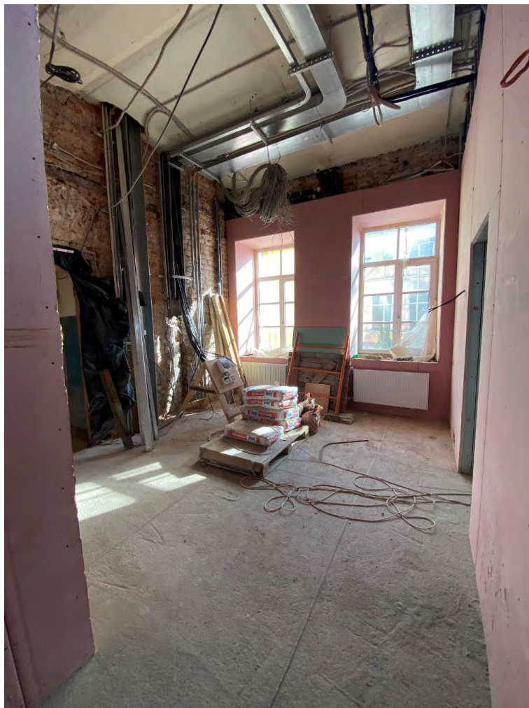
Фото №10. Помещение первого этажа. Сентябрь 2024г.
