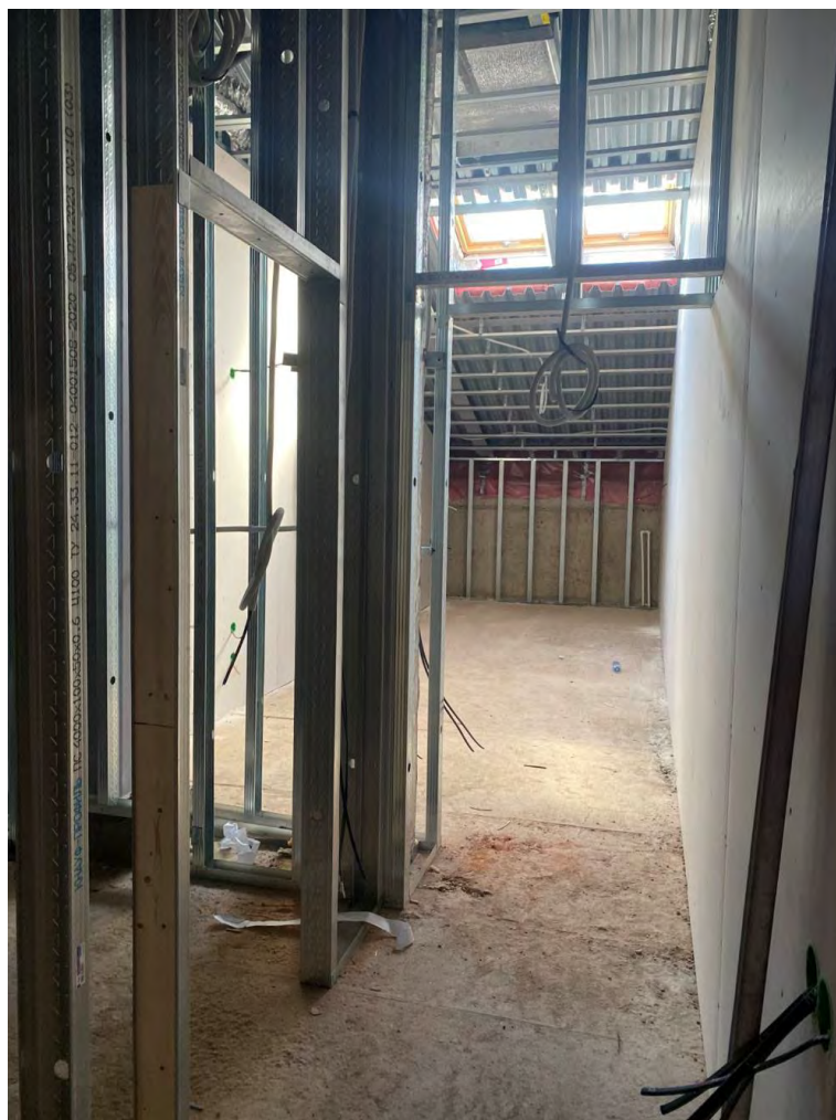
Фото №38. Помещение на мансарде. Сентябрь 2024г.
