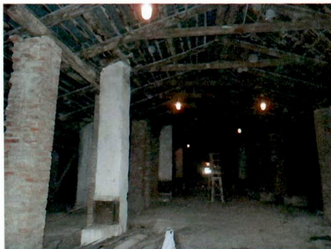
10, 11. Общий вид чердака.
