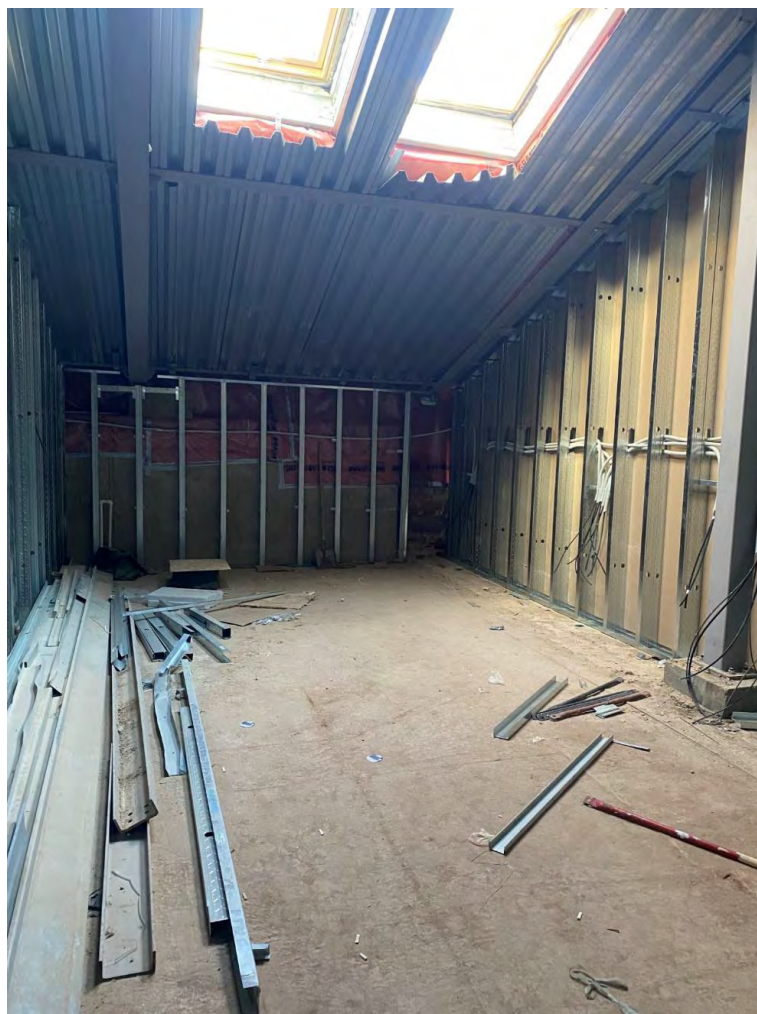
Фото №34. Помещение на мансарде. Сентябрь 2024г.
