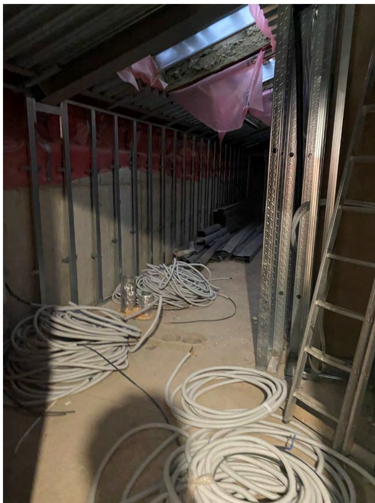
Фото №32. Помещение на мансарде. Сентябрь 2024г.
