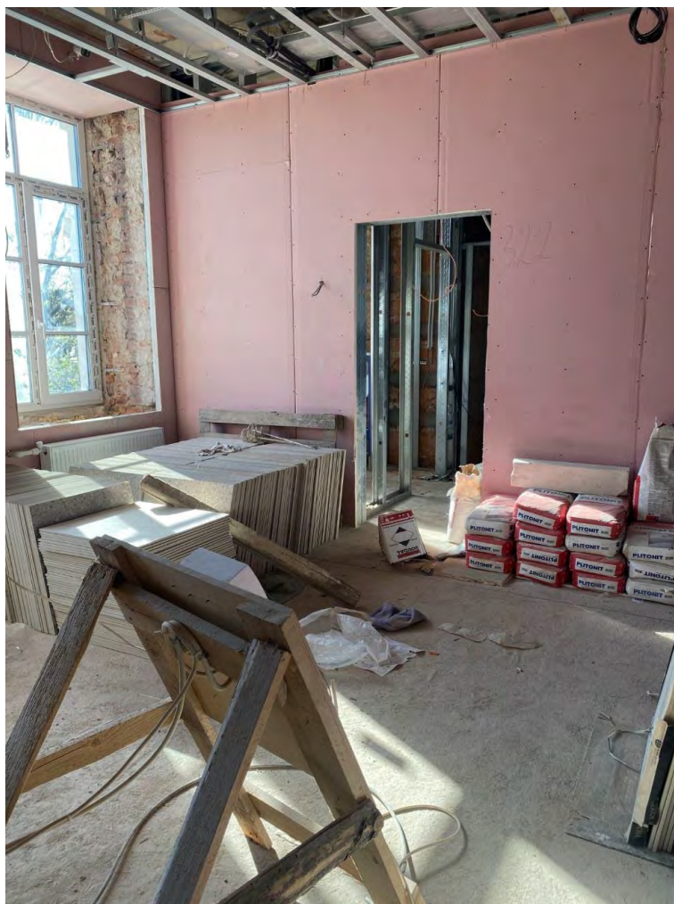
Фото №21 Помещение на третьем этаже. Сентябрь 2024г.
