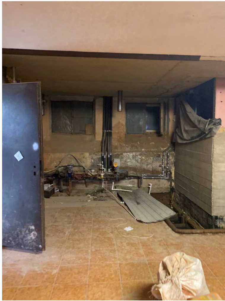
Фото №43. Коридор цокольного этажа. Сентябрь 2024г.
