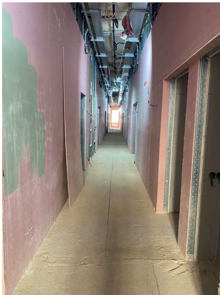
Фото №5 Коридор первого этажа. Сентябрь 2024г.
