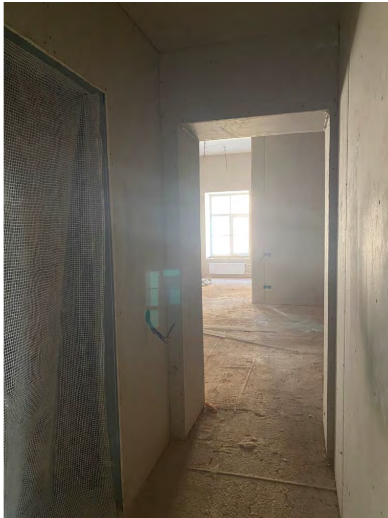
Фото №17. Помещение на втором этаже. Сентябрь 2024г.
