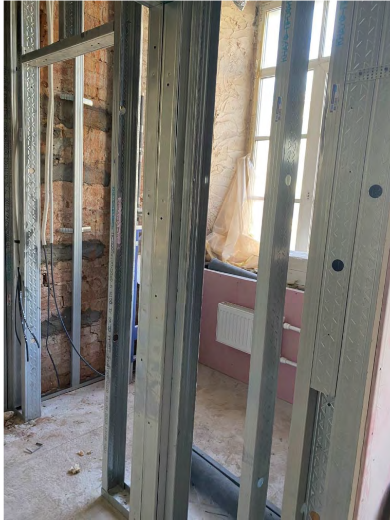
Фото №28. Помещение на третьем этаже. Сентябрь 2024г.
