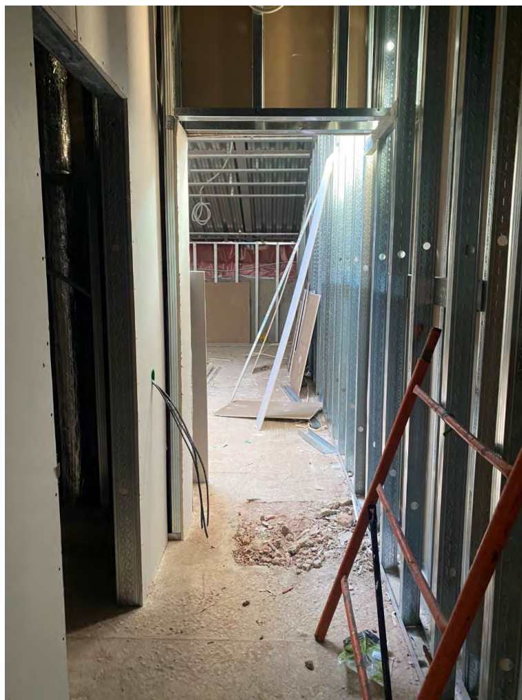
Фото №31. Помещение на мансарде. Сентябрь 2024г.
