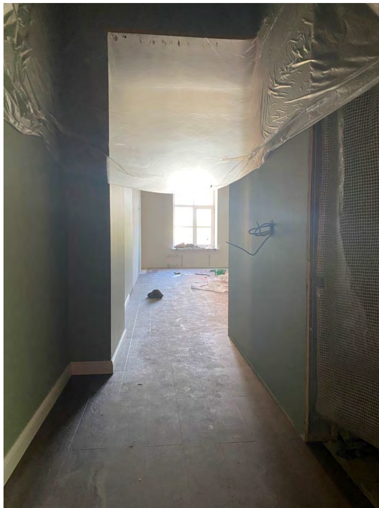
Фото №15. Помещение на втором этаже. Сентябрь 2024г.
