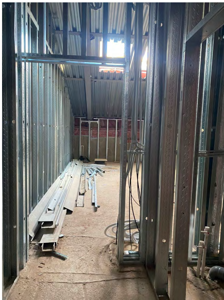
Фото №33. Помещение на мансарде. Сентябрь 2024г.
