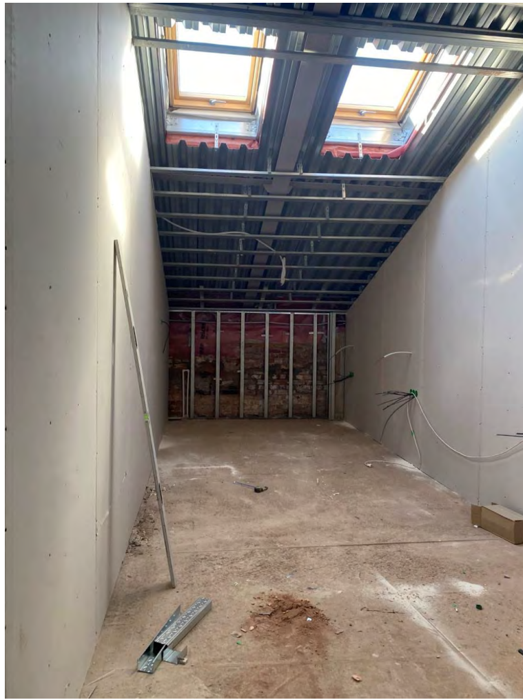
Фото №36. Помещение на мансарде. Сентябрь 2024г.
