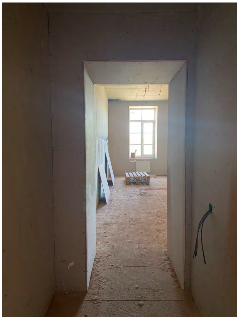
Фото №23 Помещение на третьем этаже. Сентябрь 2024г.
