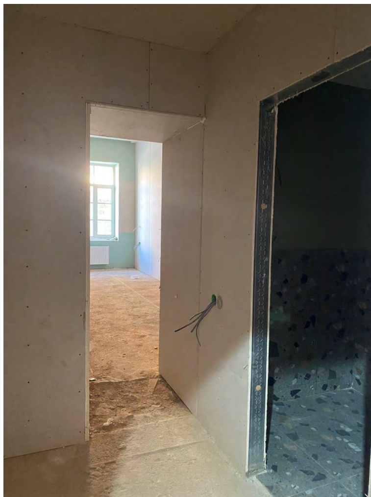
Фото №6 Помещение первого этажа. Сентябрь 2024г.
