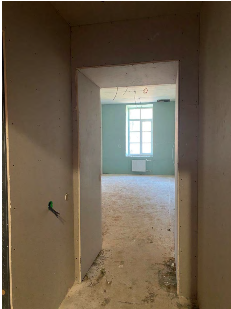
Фото №27. Помещение на третьем этаже. Сентябрь 2024г.
