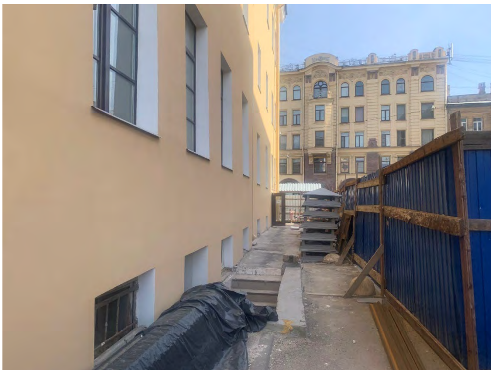
Фото №3. Фрагмент дворового фасада. Сентябрь 2024г.
