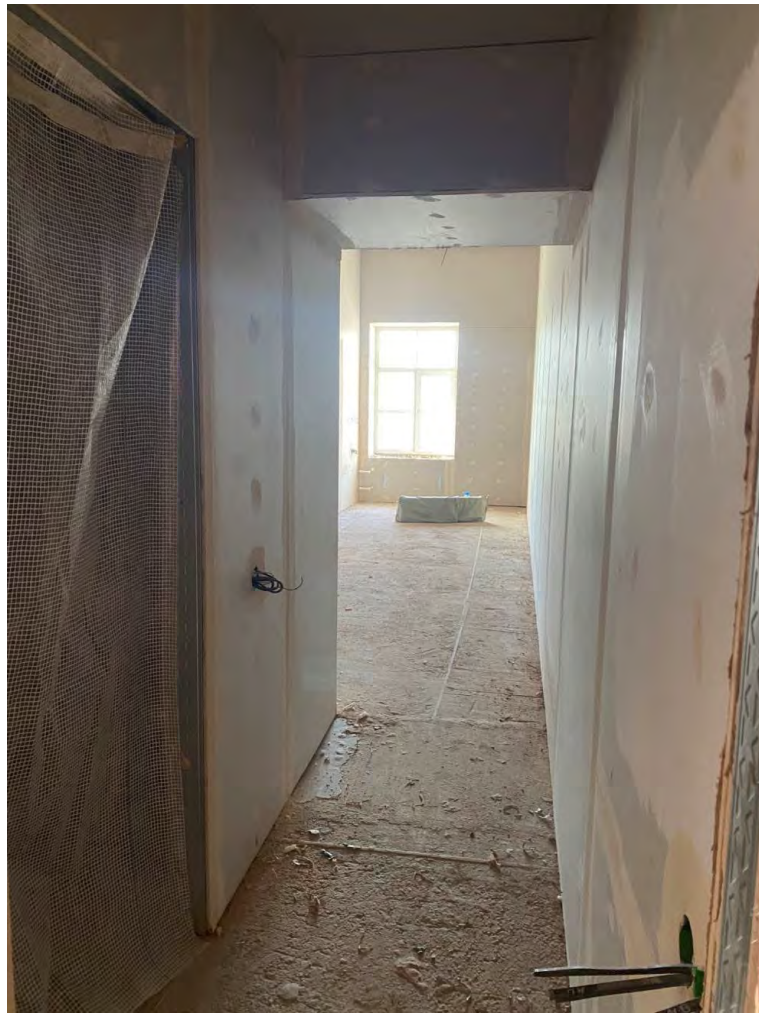
Фото №19. Помещение на втором этаже. Сентябрь 2024г.
