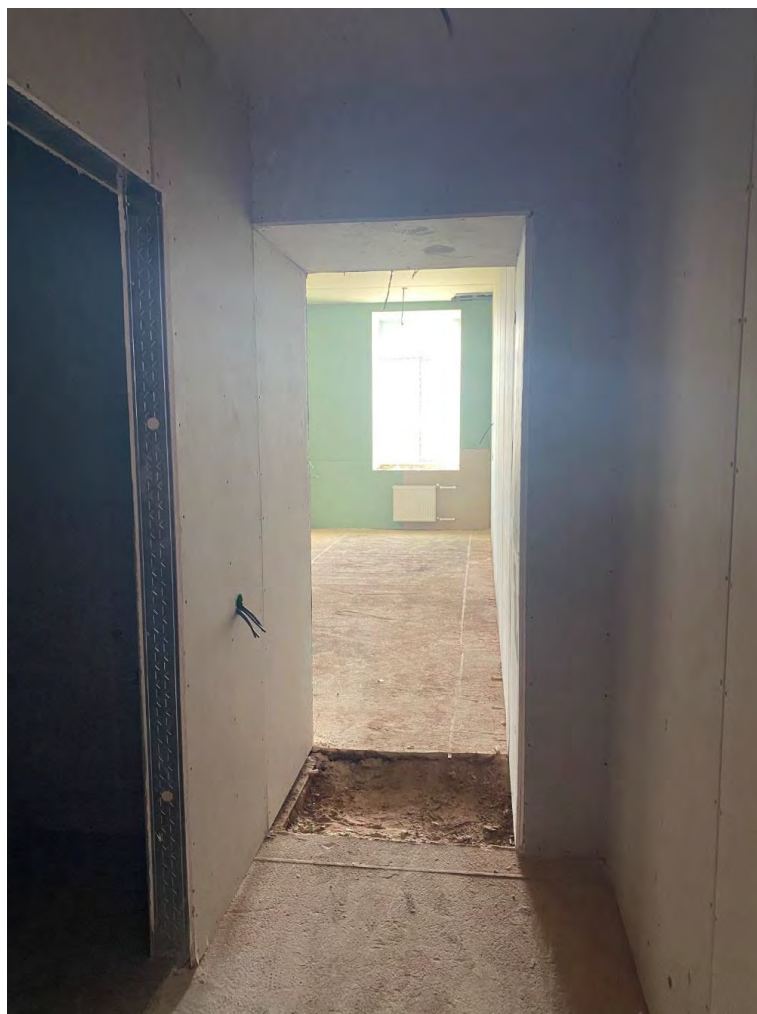
Фото №24 Помещение на третьем этаже. Сентябрь 2024г.
