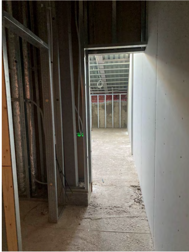
Фото №37. Помещение на мансарде. Сентябрь 2024г.
