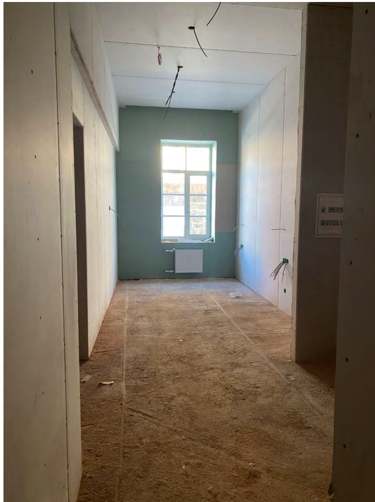
Фото №7. Помещение первого этажа. Сентябрь 2024г.
