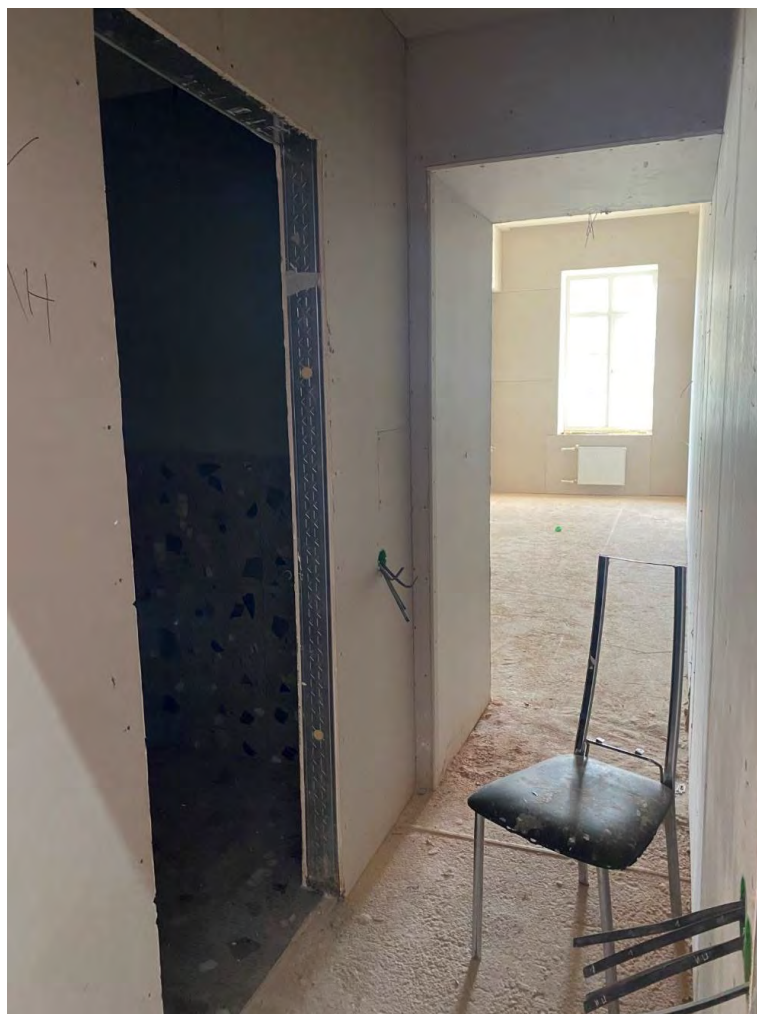
Фото №9. Помещение первого этажа. Сентябрь 2024г.
