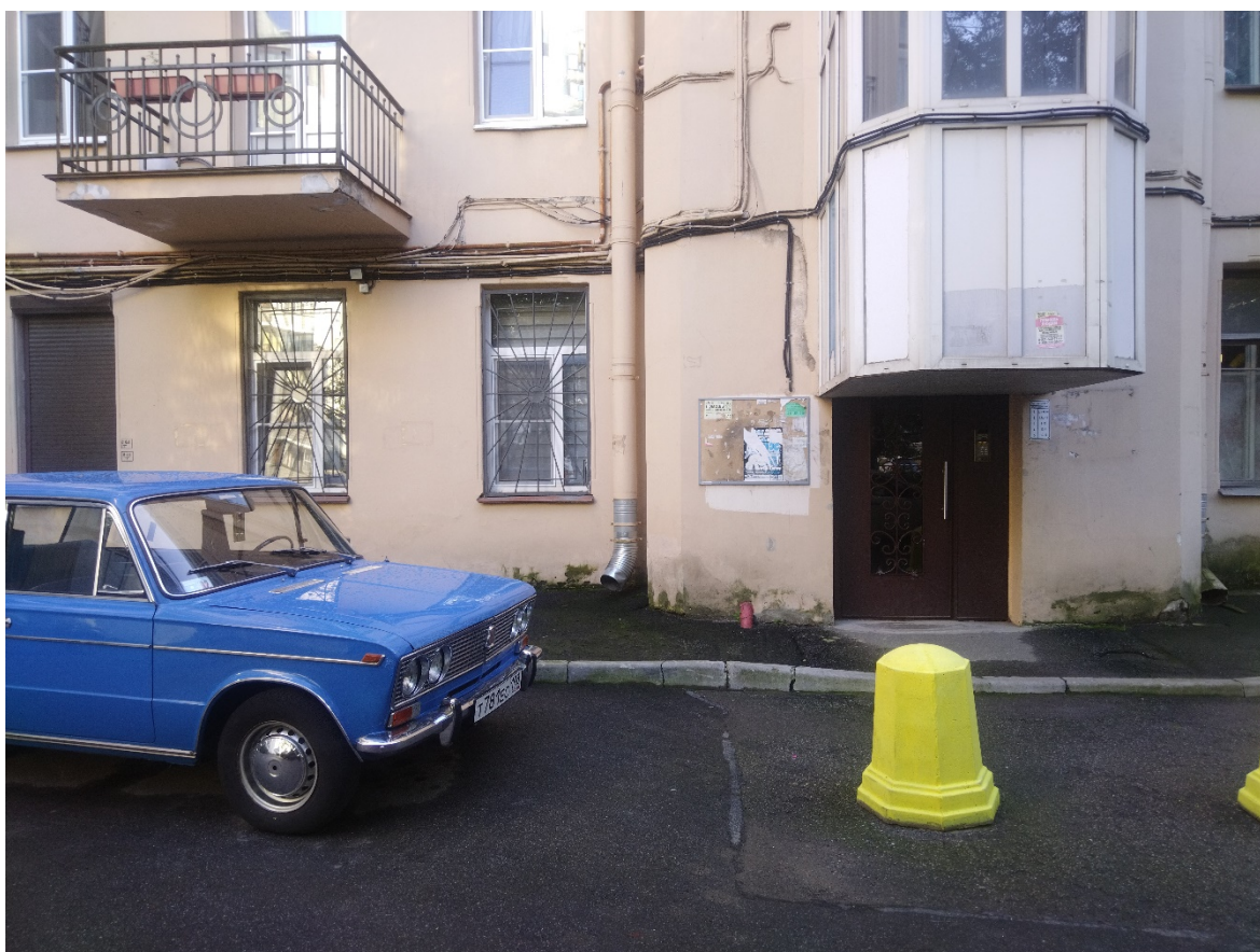
4. Объект культурного наследия регионального значения «Дом П.И. Поршневой» (г. Санкт-Петербург, наб. Черной речки, д. 49, литера А). Фрагмент дворового фасада. Дата съемки: 01.09.2024
