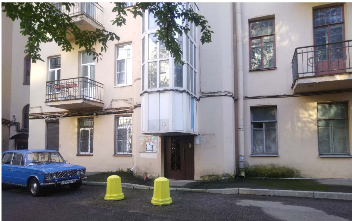
3. Объект культурного наследия регионального значения «Дом П.И. Поршневой» (г. Санкт-Петербург, наб. Черной речки, д. 49, литера А). Фрагмент дворового фасада. Дата съемки: 01.09.2024
