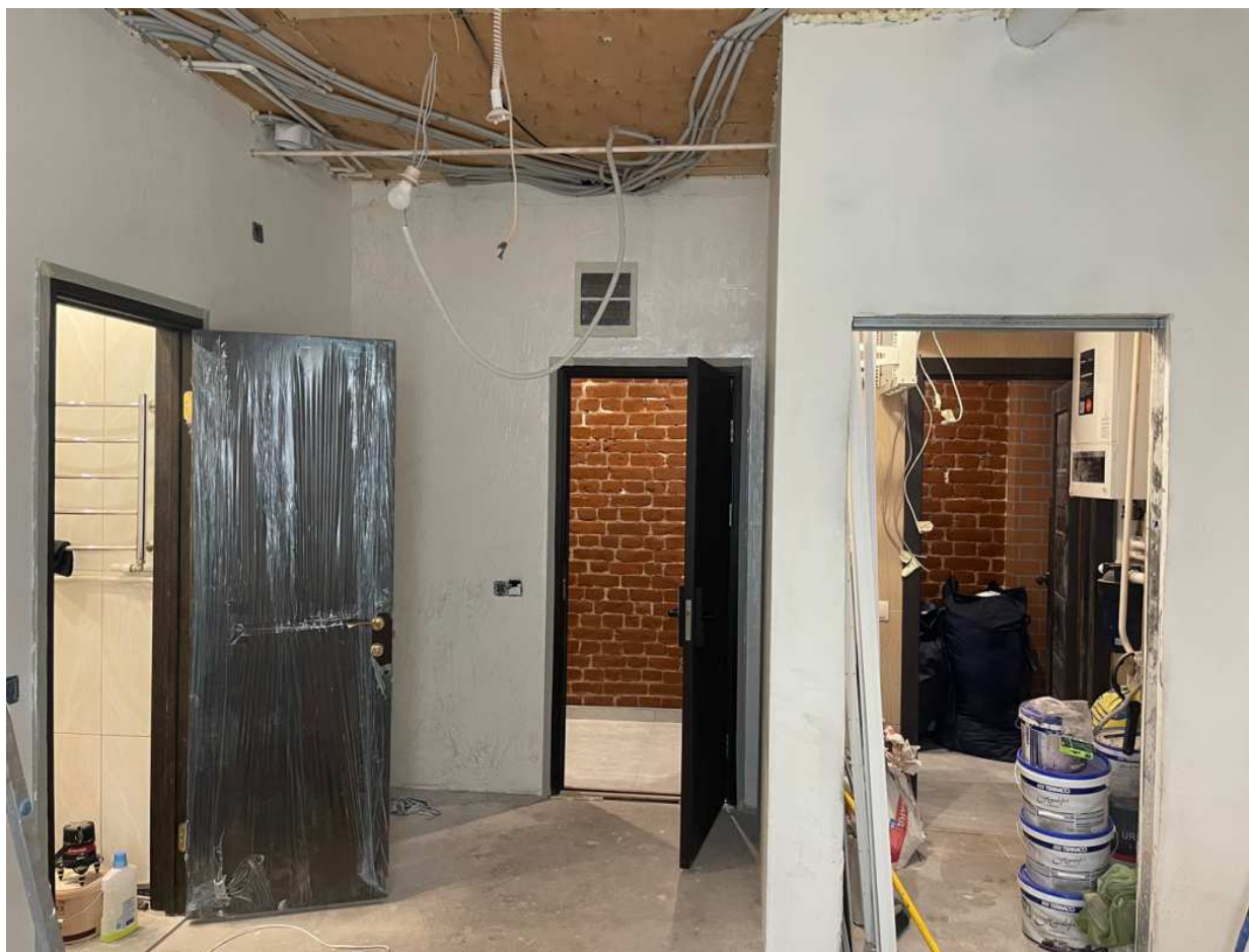
6. Фрагмент интерьера кухни (помещение 4/13.9);
