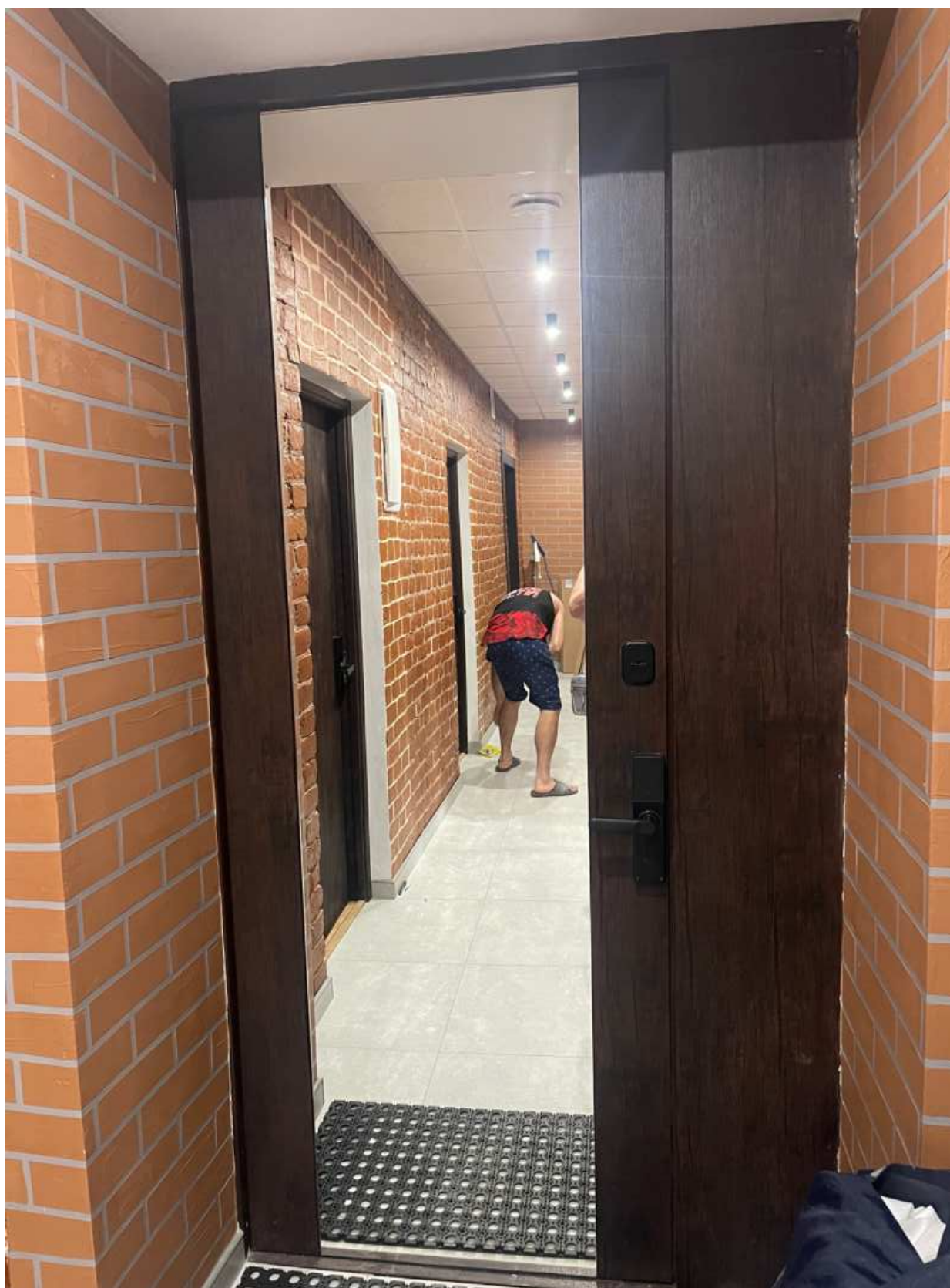
4. Вид на входную дверь в квартире;
