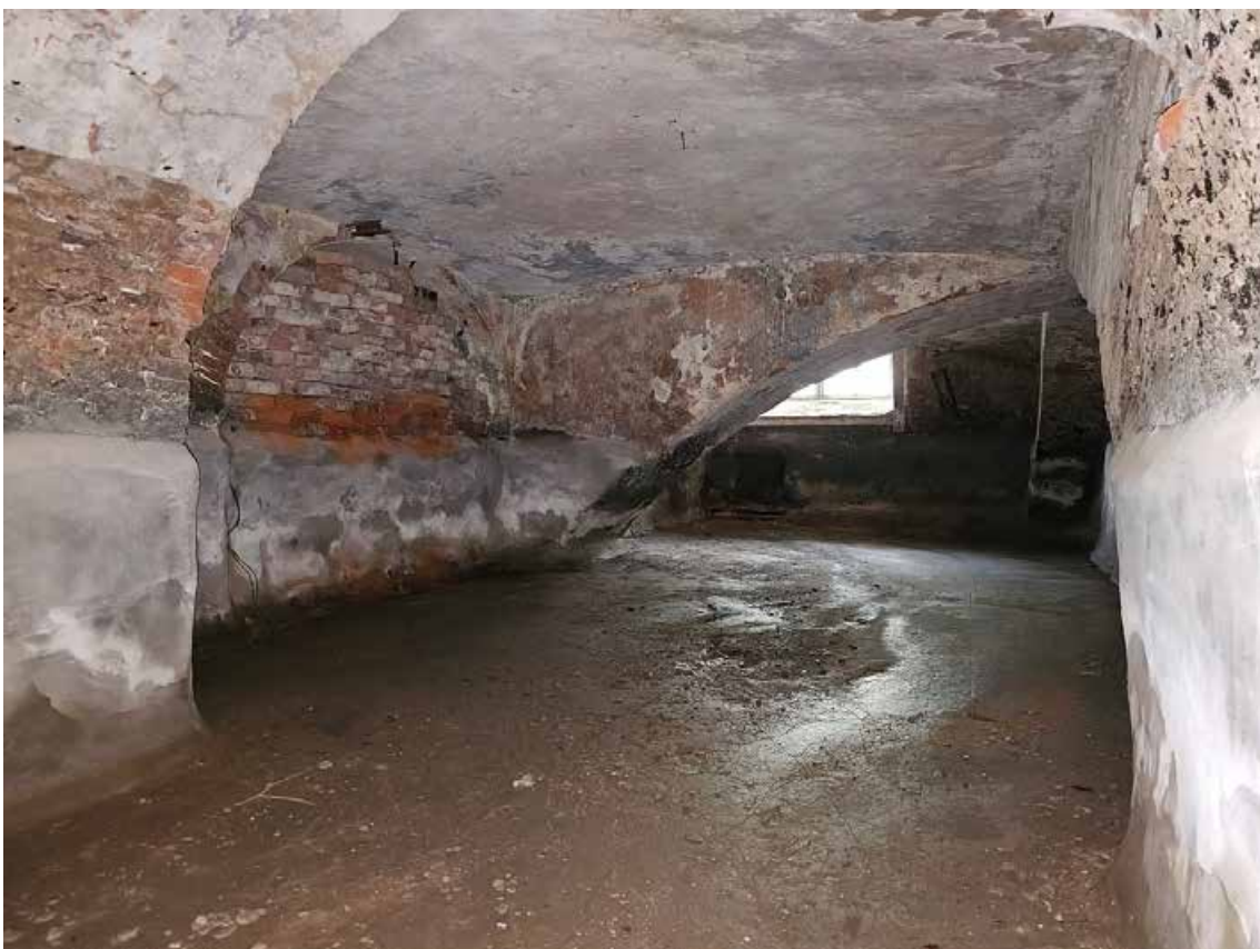
25. Объект культурного наследия регионального значения «Павловский институт с территорией, садом и оградой», по адресу: г. Санкт-Петербург, ул. Восстания, д. 8, лит. А. Общий вид пом. 4-Н (5) в уровне подвала.
