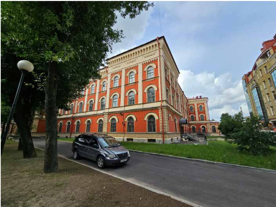
5. Объект культурного наследия регионального значения «Павловский институт с территорией, садом и оградой», по адресу: г. Санкт-Петербург, ул. Восстания, д. 8, лит. А. Общий вид северного ризалита восточного лицевого фасада.
