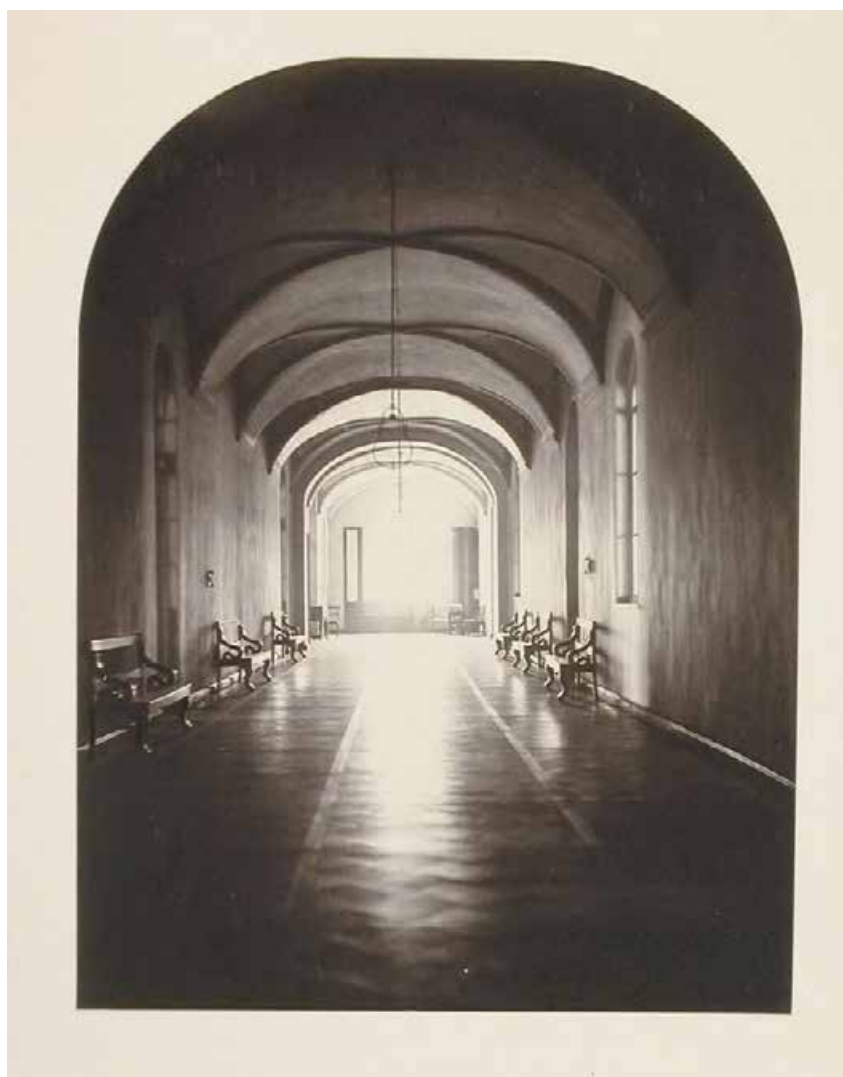
19. Вид части коридора в здании института. ЦГАКФФД СПб. Фотоальбом П 375. Позитив сн.5. 1890-е-1900-е гг.
