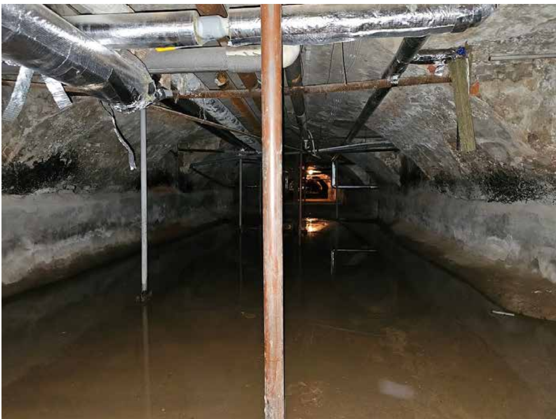
29. Объект культурного наследия регионального значения «Павловский институт с территорией, садом и оградой», по адресу: г. Санкт-Петербург, ул. Восстания, д. 8, лит. А. Общий вид пом. 4-Н (21) в уровне подвала. 1
