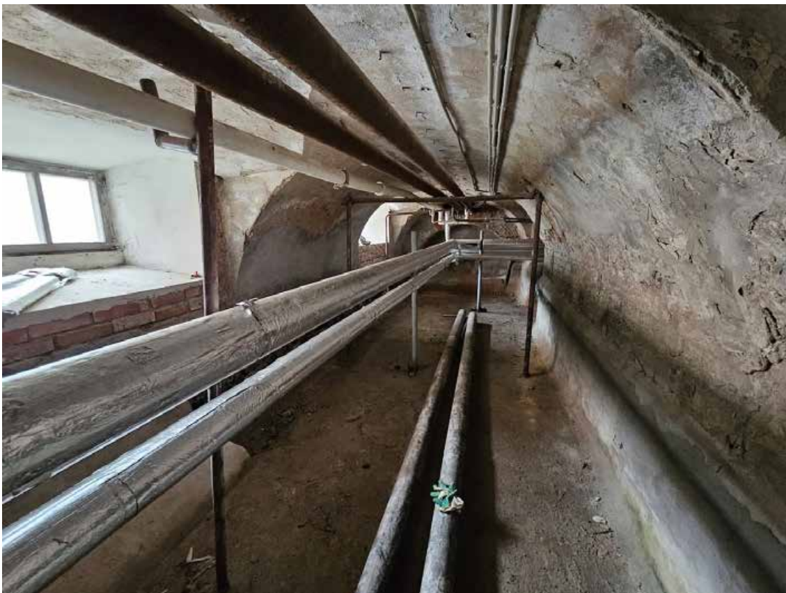
27. Объект культурного наследия регионального значения «Павловский институт с территорией, садом и оградой», по адресу: г. Санкт-Петербург, ул. Восстания, д. 8, лит. А. Общий вид пом. 4-Н (2) в уровне подвала.
