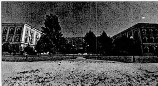
Фото 4. Западный фасад. Общий вид
