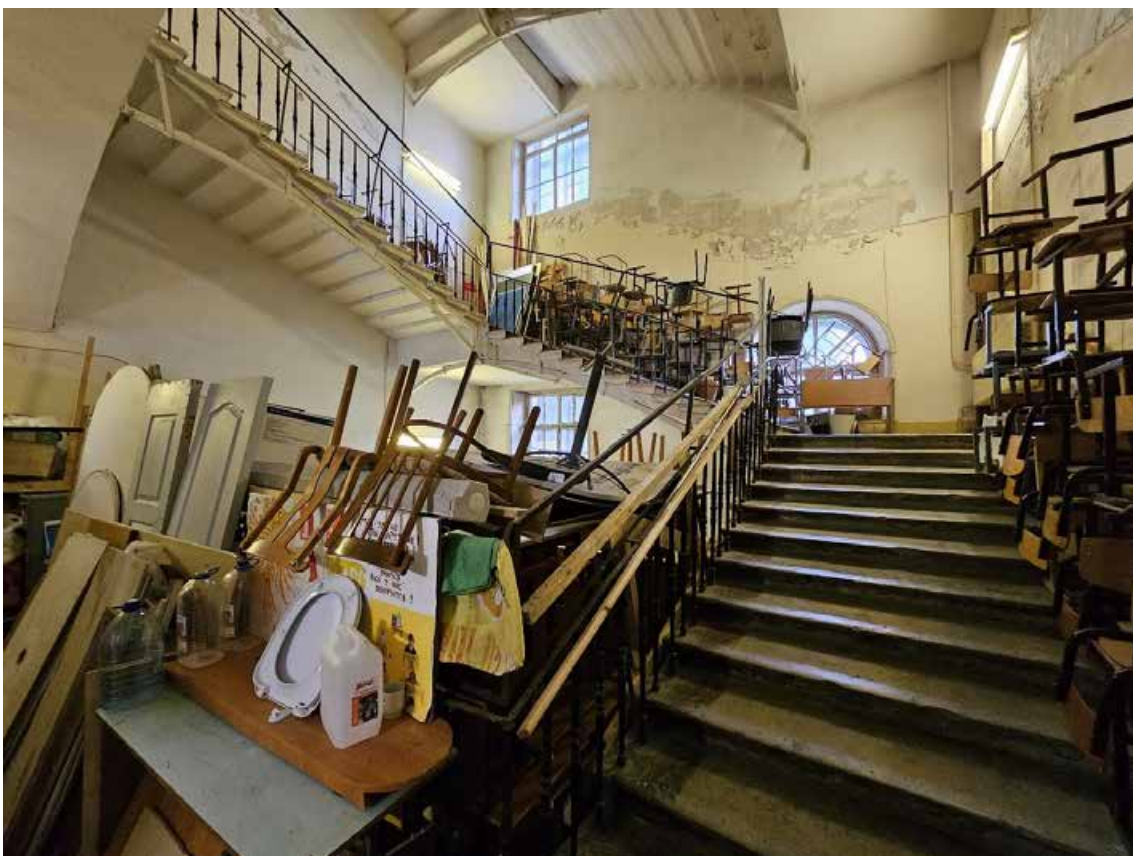
72. Объект культурного наследия регионального значения «Павловский институт с территорией, садом и оградой», по адресу: г. Санкт-Петербург, ул. Восстания, д. 8, лит. А. Общий вид четырехмаршевой лестницы в пом. 2ЛК (2) в уровне 1-го этажа.
