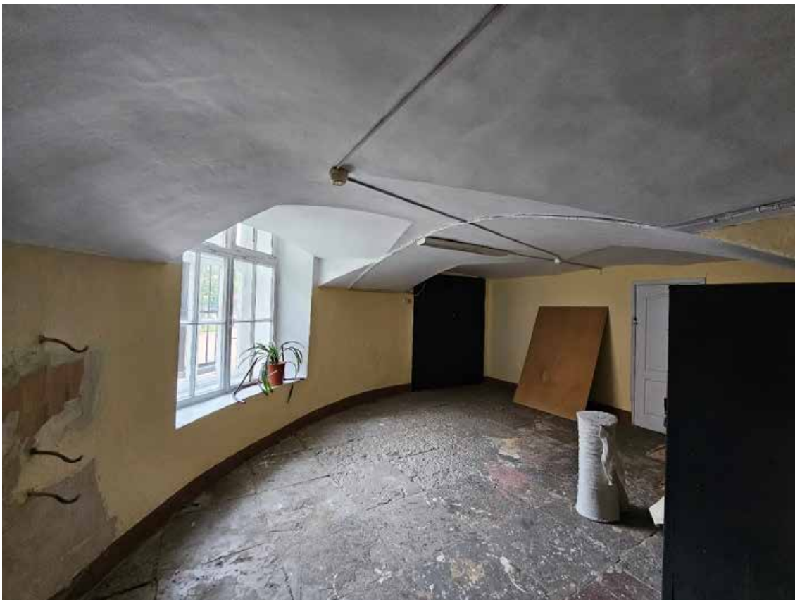
34. Объект культурного наследия регионального значения «Павловский институт с территорией, садом и оградой», по адресу: г. Санкт-Петербург, ул. Восстания, д. 8, лит. А. Общий вид пом. 5ЛК (1) в уровне 1-го этажа.
