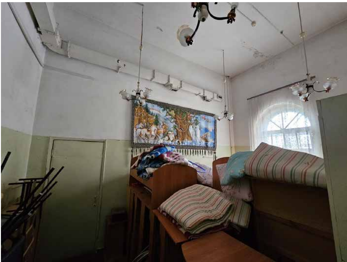
180. Объект культурного наследия регионального значения «Павловский институт с территорией, садом и оградой», по адресу: г. Санкт-Петербург, ул. Восстания, д. 8, лит. А. Общий вид пом. 14-Н (10) в уровне 3-го этажа.
