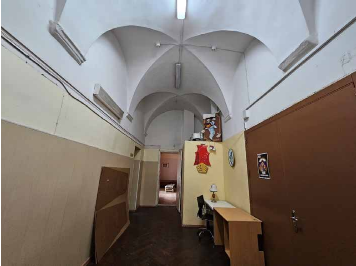
46. Объект культурного наследия регионального значения «Павловский институт с территорией, садом и оградой», по адресу: г. Санкт-Петербург, ул. Восстания, д. 8, лит. А. Фрагмент пом. 12-Н (41) в уровне 1-го этажа.
