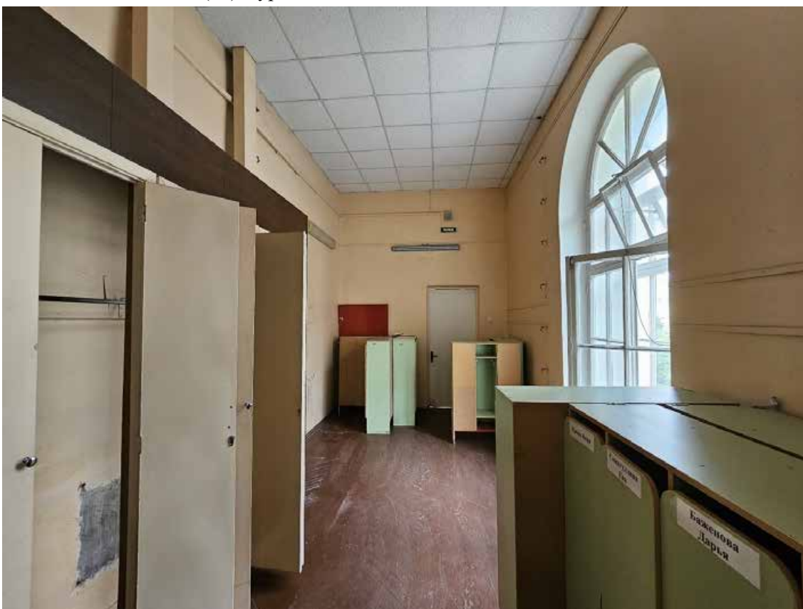
176. Объект культурного наследия регионального значения «Павловский институт с территорией, садом и оградой», по адресу: г. Санкт-Петербург, ул. Восстания, д. 8, лит. А. Общий вид пом. 14-Н (19) в уровне 3-го этажа.
