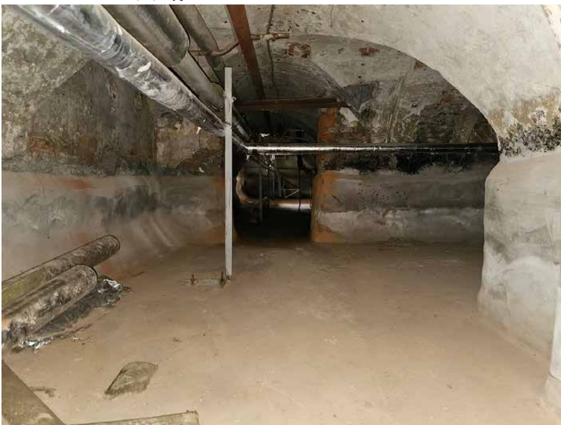
24. Объект культурного наследия регионального значения «Павловский институт с территорией, садом и оградой», по адресу: г. Санкт-Петербург, ул. Восстания, д. 8, лит. А. Фрагмент пом. 4-Н (6) в уровне подвала.
