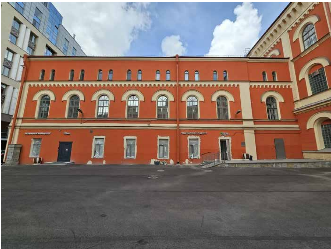
15. Объект культурного наследия регионального значения «Павловский институт с территорией, садом и оградой», по адресу: г. Санкт-Петербург, ул. Восстания, д. 8, лит. А. Общий вид восточного дворового фасада юго-западного флигеля.
