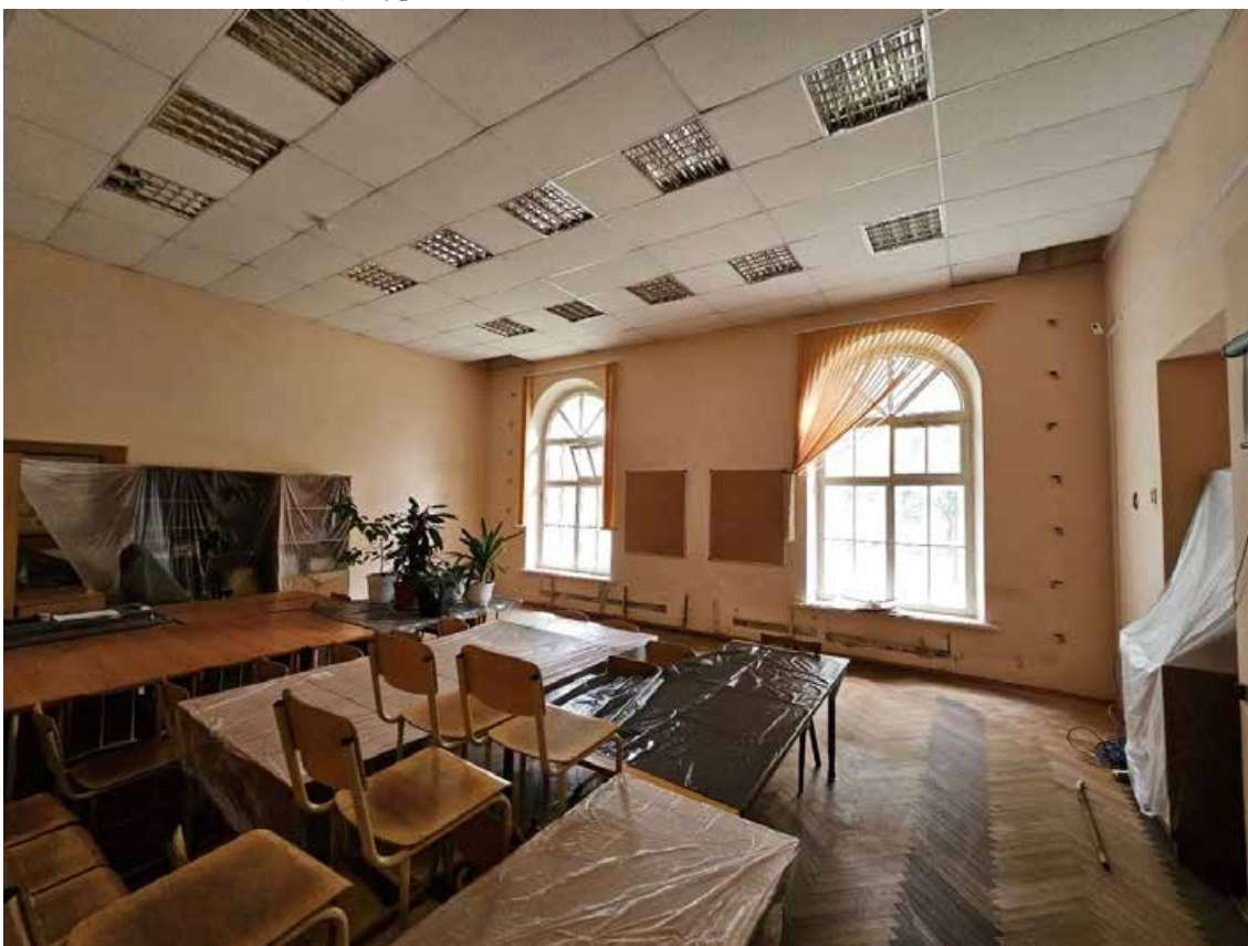
45. Объект культурного наследия регионального значения «Павловский институт с территорией, садом и оградой», по адресу: г. Санкт-Петербург, ул. Восстания, д. 8, лит. А. Общий вид пом. 5-Н (84, 87) в уровне 1-го этажа.
