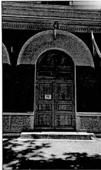
Фото 8. Фрагмент восточного фасада. Главный вход
