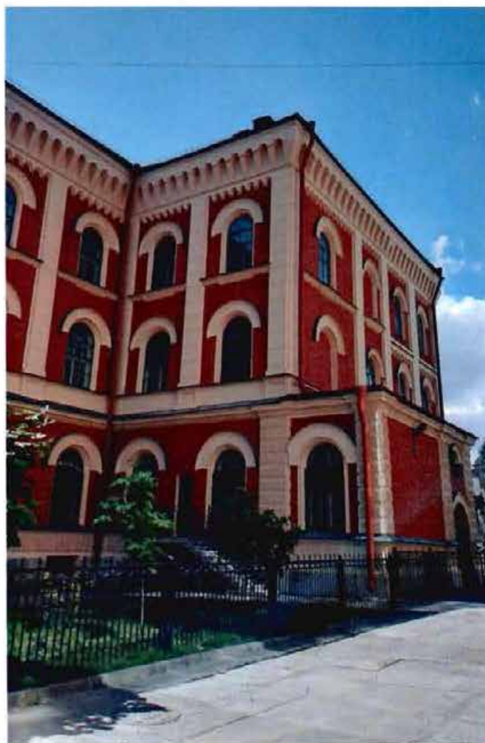
5. Здание института. Фрагмент северного фасада
