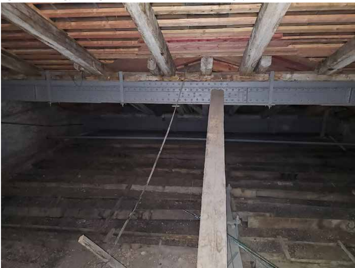
214. Объект культурного наследия регионального значения «Павловский институт с территорией, садом и оградой», по адресу: г. Санкт-Петербург, ул. Восстания, д. 8, лит. А. Фрагмент конструкции крыши над центральным ризалитом лицевого корпуса.
