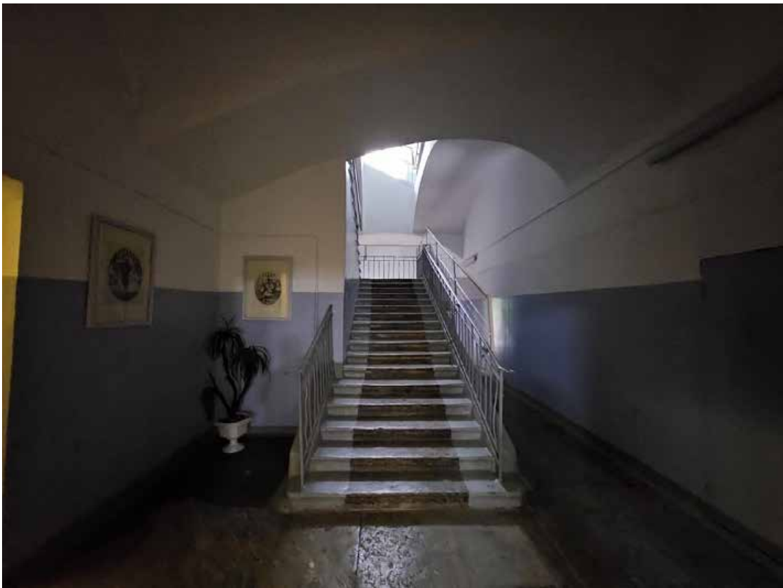
43. Объект культурного наследия регионального значения «Павловский институт с территорией, садом и оградой», по адресу: г. Санкт-Петербург, ул. Восстания, д. 8, лит. А. Общий вид трехмаршевой лестницы в пом. 6ЛК (2) в уровне 1-го этажа.
