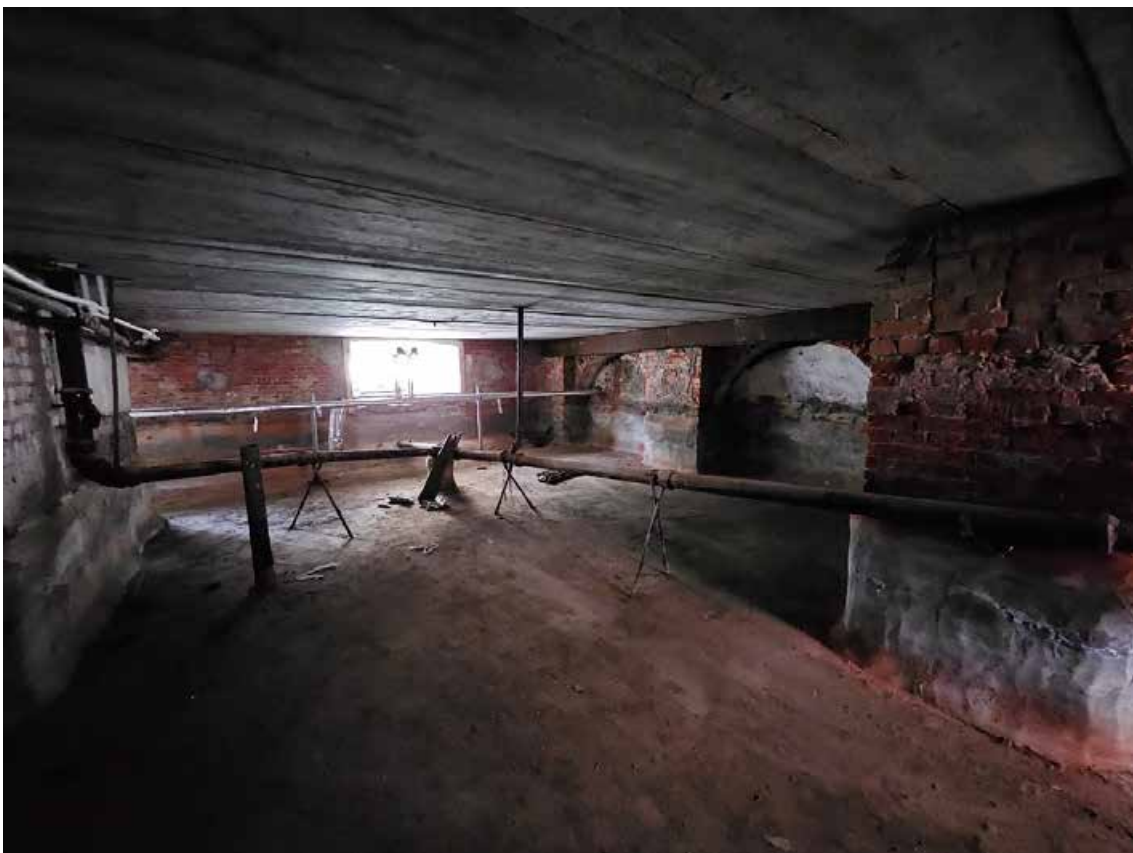
26. Объект культурного наследия регионального значения «Павловский институт с территорией, садом и оградой», по адресу: г. Санкт-Петербург, ул. Восстания, д. 8, лит. А. Общий вид пом. 4-Н (4) в уровне подвала.
