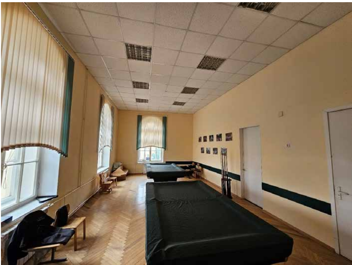
186. Объект культурного наследия регионального значения «Павловский институт с территорией, садом и оградой», по адресу: г. Санкт-Петербург, ул. Восстания, д. 8, лит. А. Общий вид пом. 14-Н (3) в уровне 3-го этажа.
