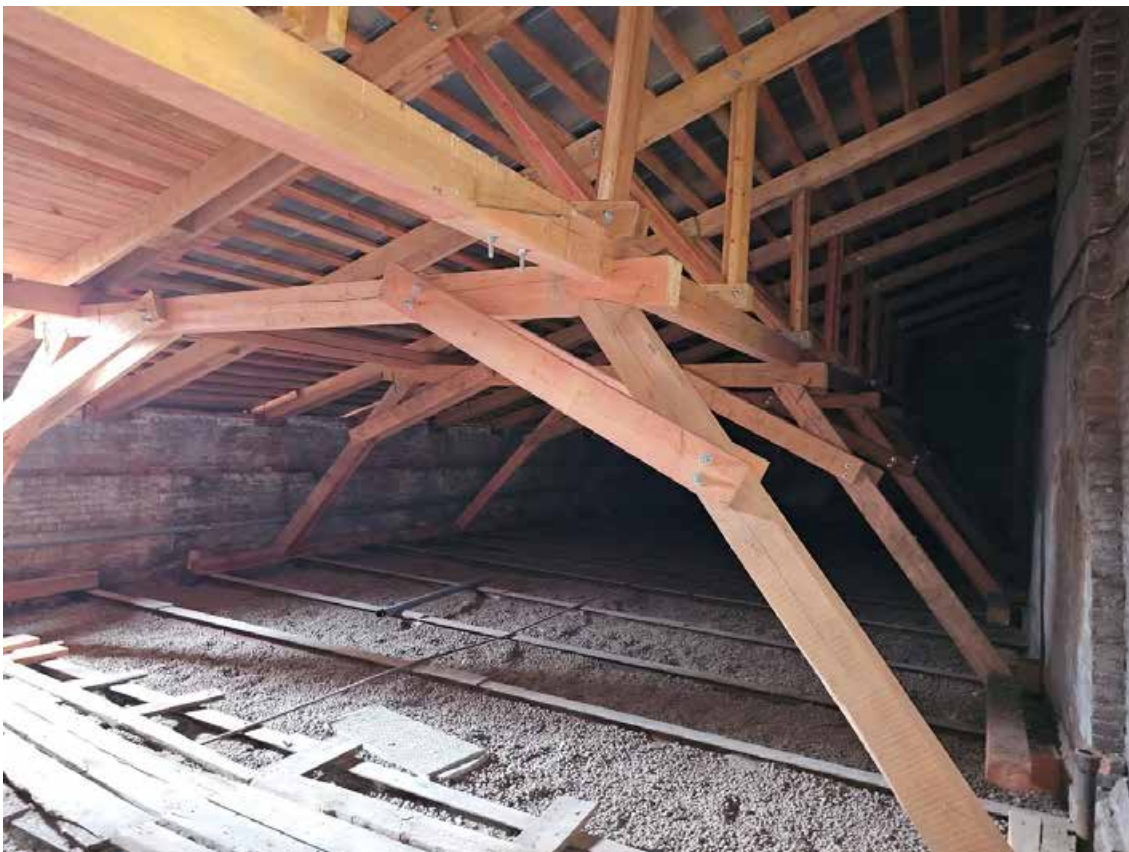
213. Объект культурного наследия регионального значения «Павловский институт с территорией, садом и оградой», по адресу: г. Санкт-Петербург, ул. Восстания, д. 8, лит. А. Фрагмент конструкции крыши в южной части лицевого корпуса.
