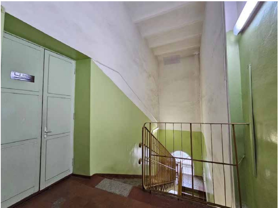
184. Объект культурного наследия регионального значения «Павловский институт с территорией, садом и оградой», по адресу: г. Санкт-Петербург, ул. Восстания, д. 8, лит. А. Общий вид двухмаршевой лестницы в пом. 8ЛК (4) в уровне 3-го этажа.
