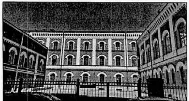
Фото 3. Вид на фрагмент южного фасада. Внутренний двор
