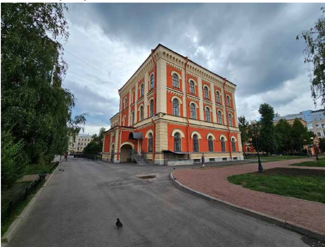
8. Объект культурного наследия регионального значения «Павловский институт с территорией, садом и оградой», по адресу: г. Санкт-Петербург, ул. Восстания, д. 8, лит. А. Общий вид западного торцевого фасада северного корпуса.
