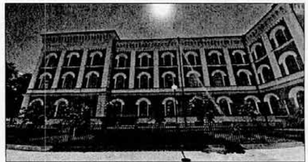
Фото 5. Вид на северный фасад
