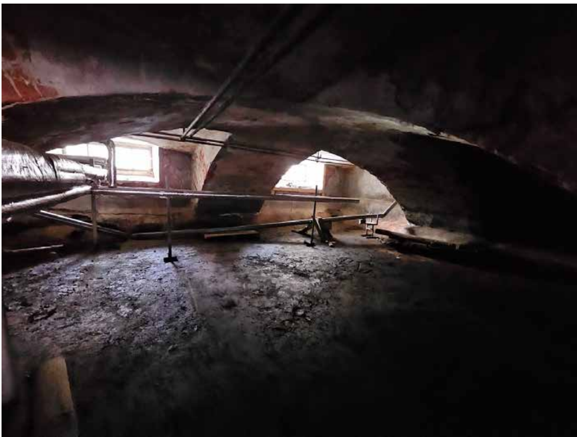
28. Объект культурного наследия регионального значения «Павловский институт с территорией, садом и оградой», по адресу: г. Санкт-Петербург, ул. Восстания, д. 8, лит. А. Общий вид пом. 4-Н (1) в уровне подвала.
