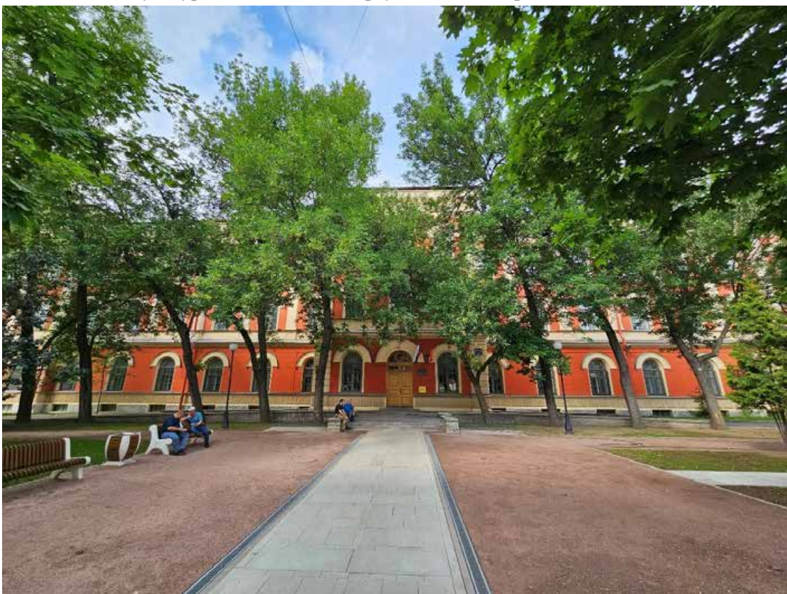
2. Объект культурного наследия регионального значения «Павловский институт с территорией, садом и оградой», по адресу: г. Санкт-Петербург, ул. Восстания, д. 8, лит. А. Общий вид центральной части восточного лицевого фасада.
