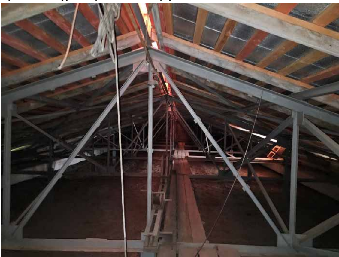
210. Объект культурного наследия регионального значения «Павловский институт с территорией, садом и оградой», по адресу: г. Санкт-Петербург, ул. Восстания, д. 8, лит. А. Фрагмент конструкции крыши юго-восточного флигеля.
