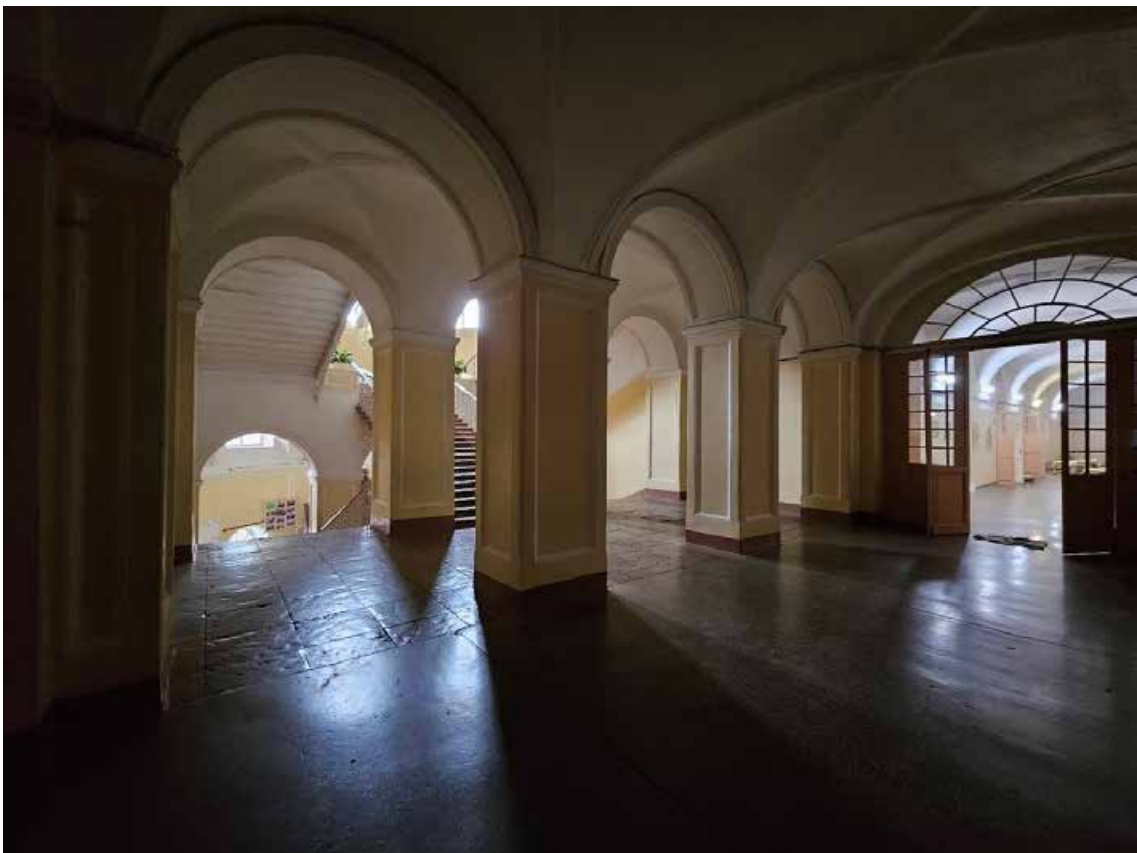
107. Объект культурного наследия регионального значения «Павловский институт с территорией, садом и оградой», по адресу: г. Санкт-Петербург, ул. Восстания, д. 8, лит. А. Общий вид пом. 7-Н (29) в уровне 2-го этажа.
