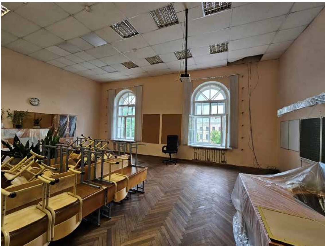
168. Объект культурного наследия регионального значения «Павловский институт с территорией, садом и оградой», по адресу: г. Санкт-Петербург, ул. Восстания, д. 8, лит. А. Общий вид пом. 11-Н (31) в уровне 3-го этажа.
