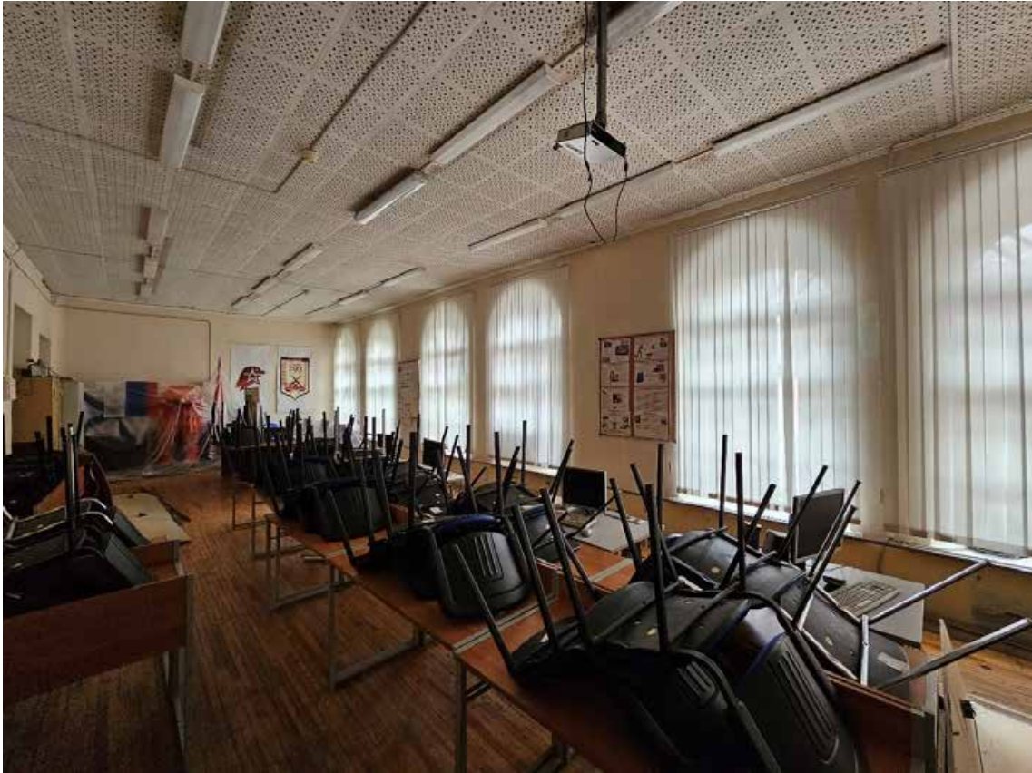
78. Объект культурного наследия регионального значения «Павловский институт с территорией, садом и оградой», по адресу: г. Санкт-Петербург, ул. Восстания, д. 8, лит. А. Общий вид пом. 5-Н (13, 14) в уровне 1-го этажа.
