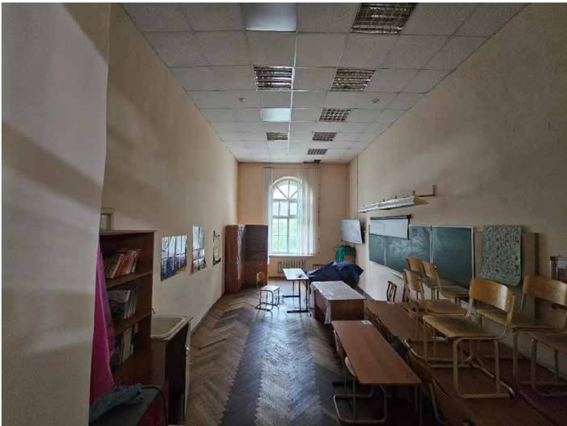
196. Объект культурного наследия регионального значения «Павловский институт с территорией, садом и оградой», по адресу: г. Санкт-Петербург, ул. Восстания, д. 8, лит. А. Общий вид пом. 11-Н (19) в уровне 3-го этажа.
