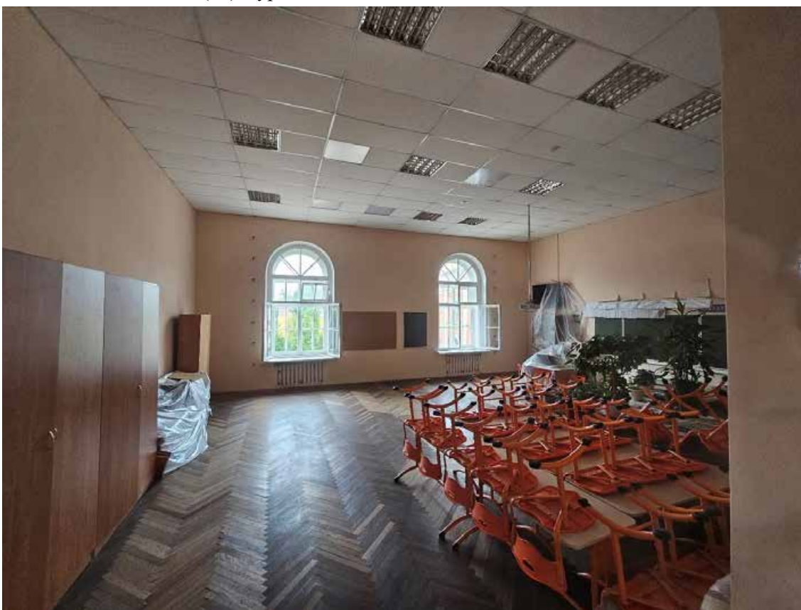
164. Объект культурного наследия регионального значения «Павловский институт с территорией, садом и оградой», по адресу: г. Санкт-Петербург, ул. Восстания, д. 8, лит. А. Общий вид пом. 11-Н (25) в уровне 3-го этажа.
