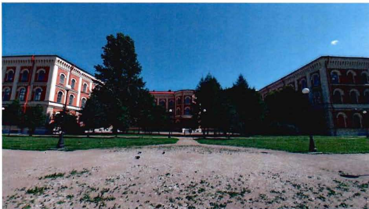
2. Здание института. Западный фасад
