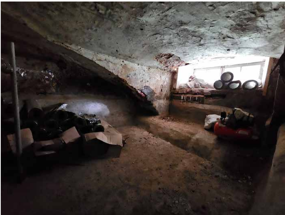
23. Объект культурного наследия регионального значения «Павловский институт с территорией, садом и оградой», по адресу: г. Санкт-Петербург, ул. Восстания, д. 8, лит. А. Общий вид пом. 4-Н (12) в уровне подвала.
