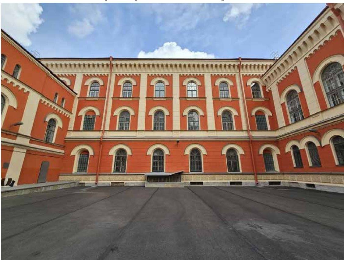
16. Объект культурного наследия регионального значения «Павловский институт с территорией, садом и оградой», по адресу: г. Санкт-Петербург, ул. Восстания, д. 8, лит. А. Общий вид южного фасада южного корпуса.
