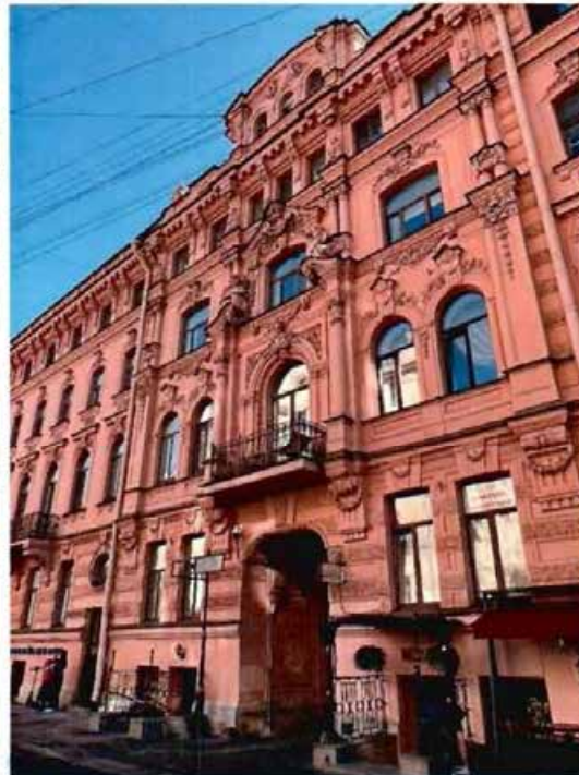
3. Фрагмент лицевого фасада. Воротный проезд.
