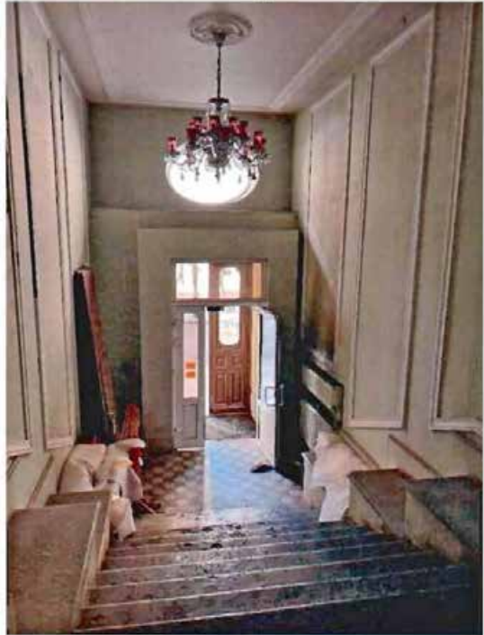
19. 1ЛК. Вестибюль. Отделка пола.
