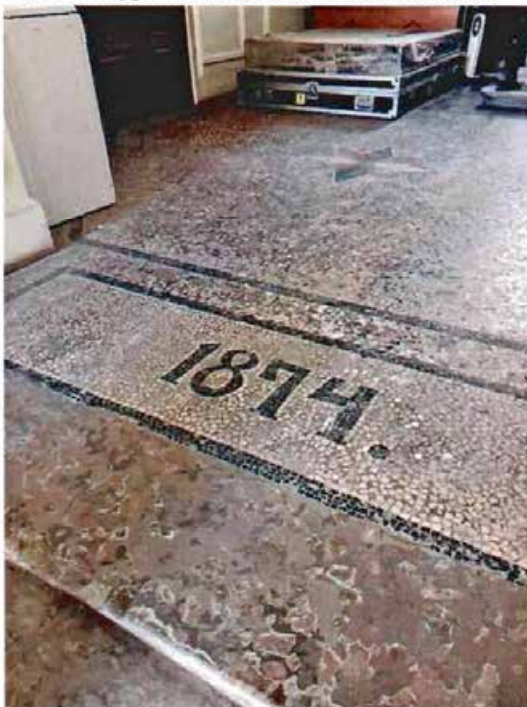
20. 1ЛК в уровне 1-го этажа. Отделка пола.
