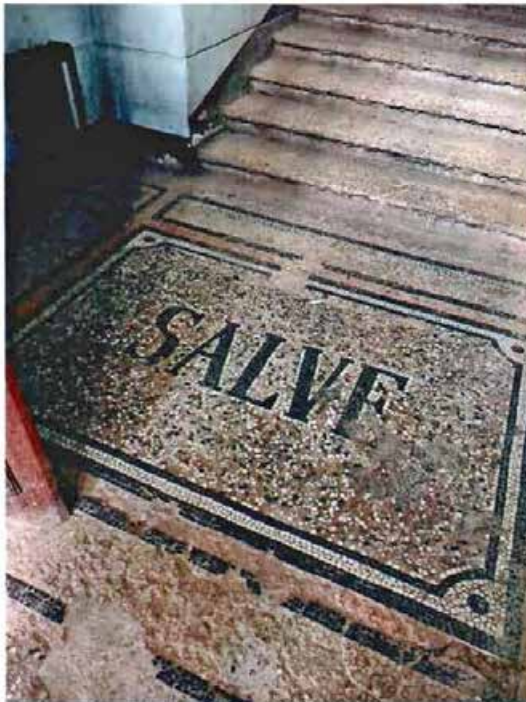
23. 2ЛК. Вестибюль. Отделка пола.
