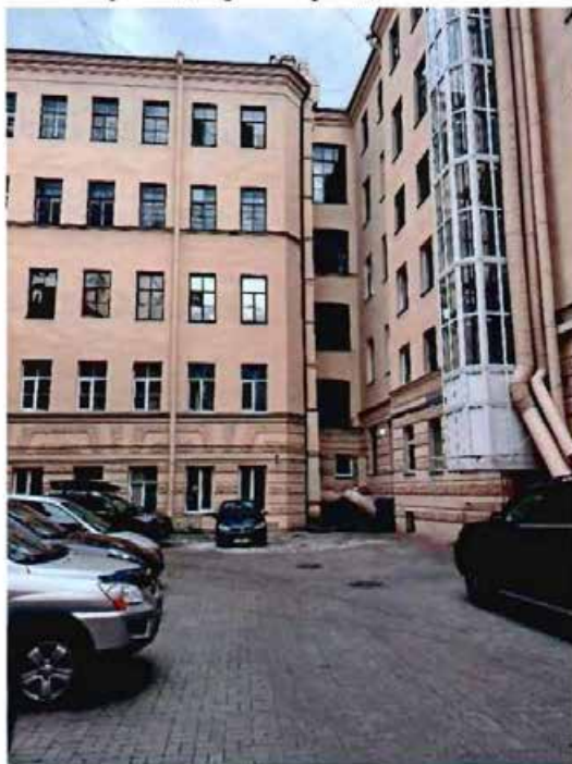
12. Северный дворовой фасад.
