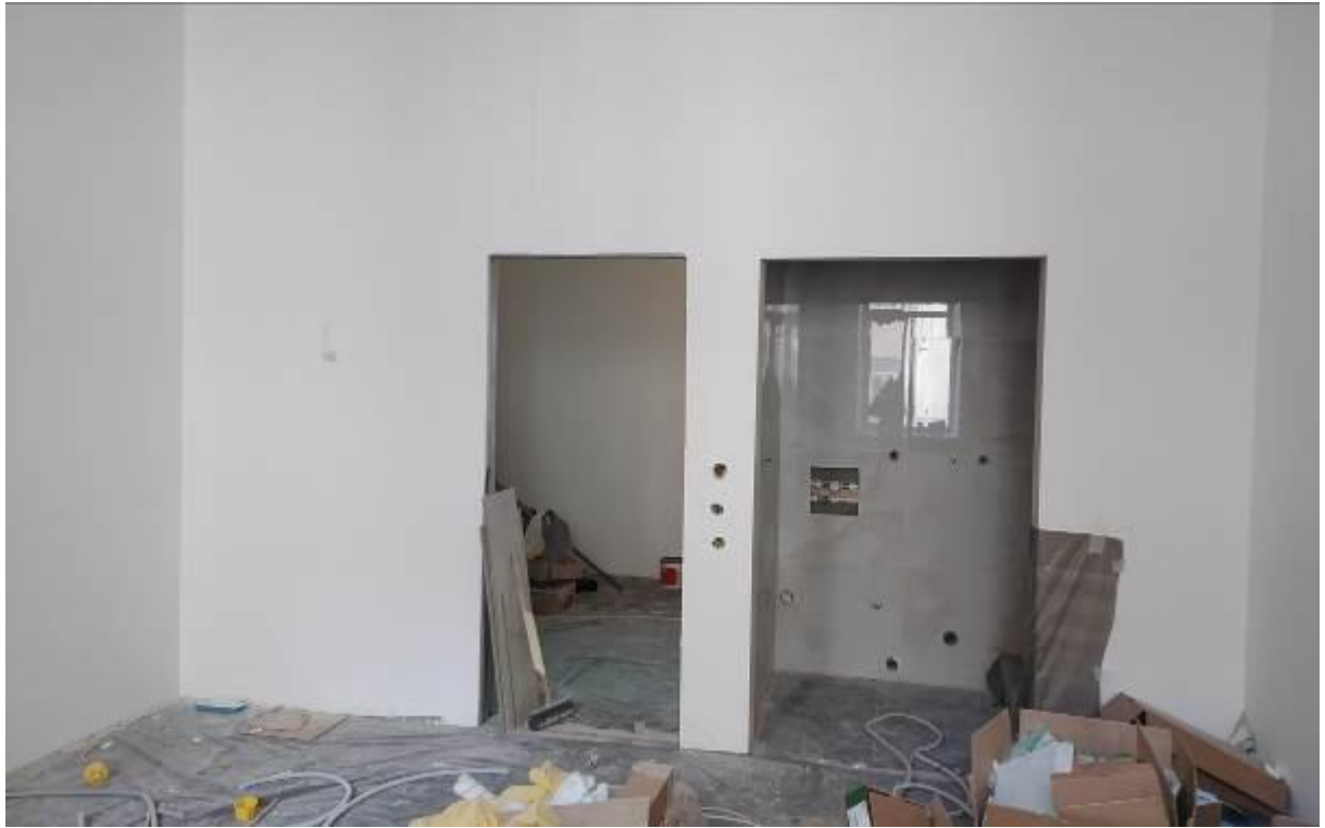
Фото 18. Квартира №3. Фрагмент. Дата съемки 22.04.2024 г.
