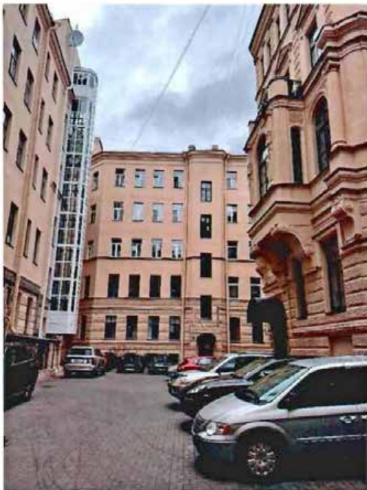
8. Южный дворовой фасад.
