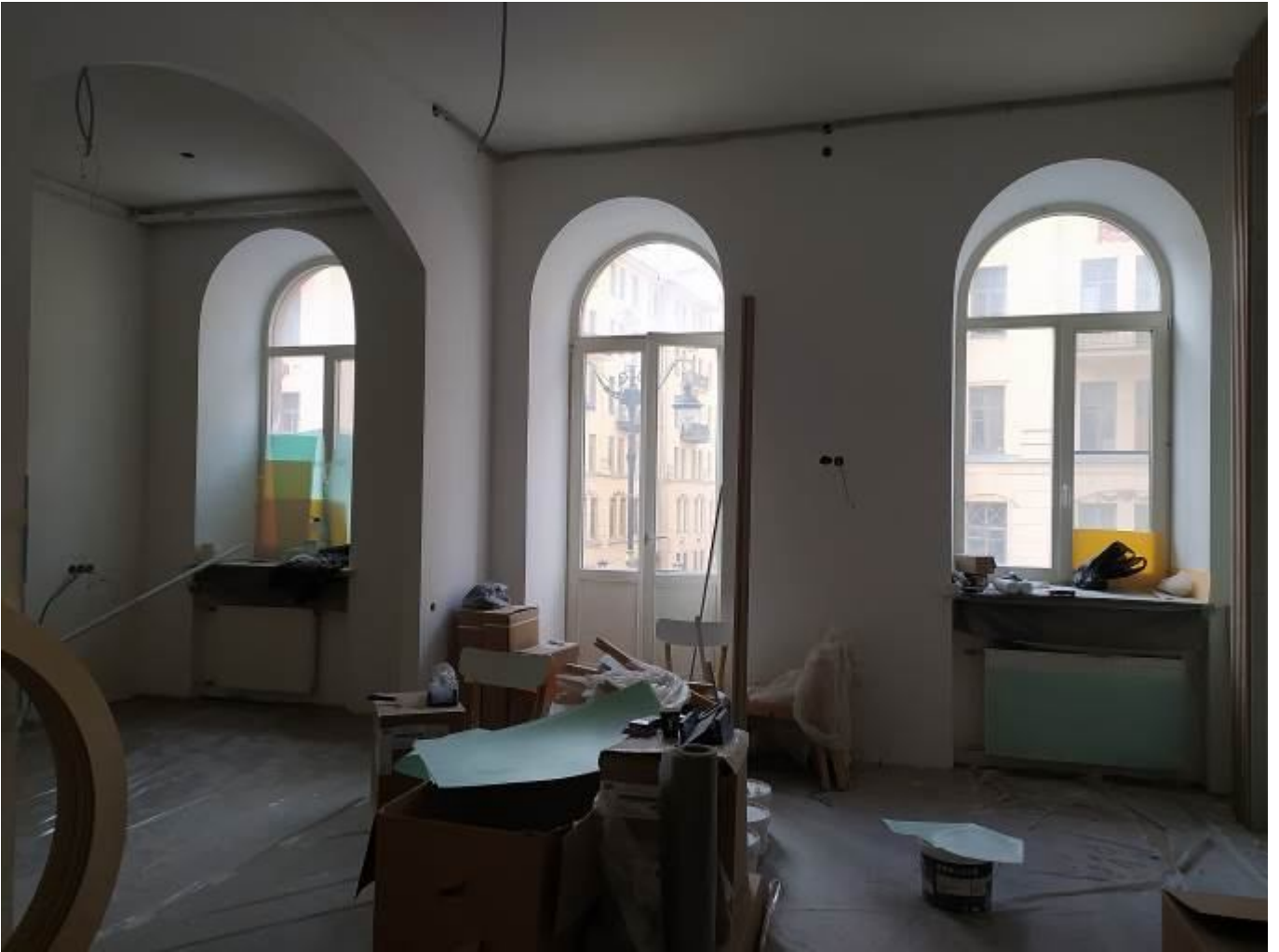
Фото 19. Квартира №3. Фрагмент. Дата съемки 22.04.2024 г.
