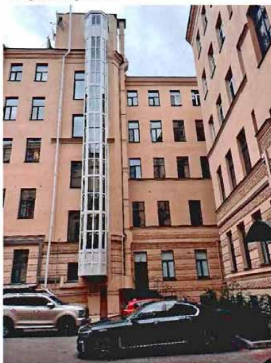
9. Северная часть восточного дворового фасада.
