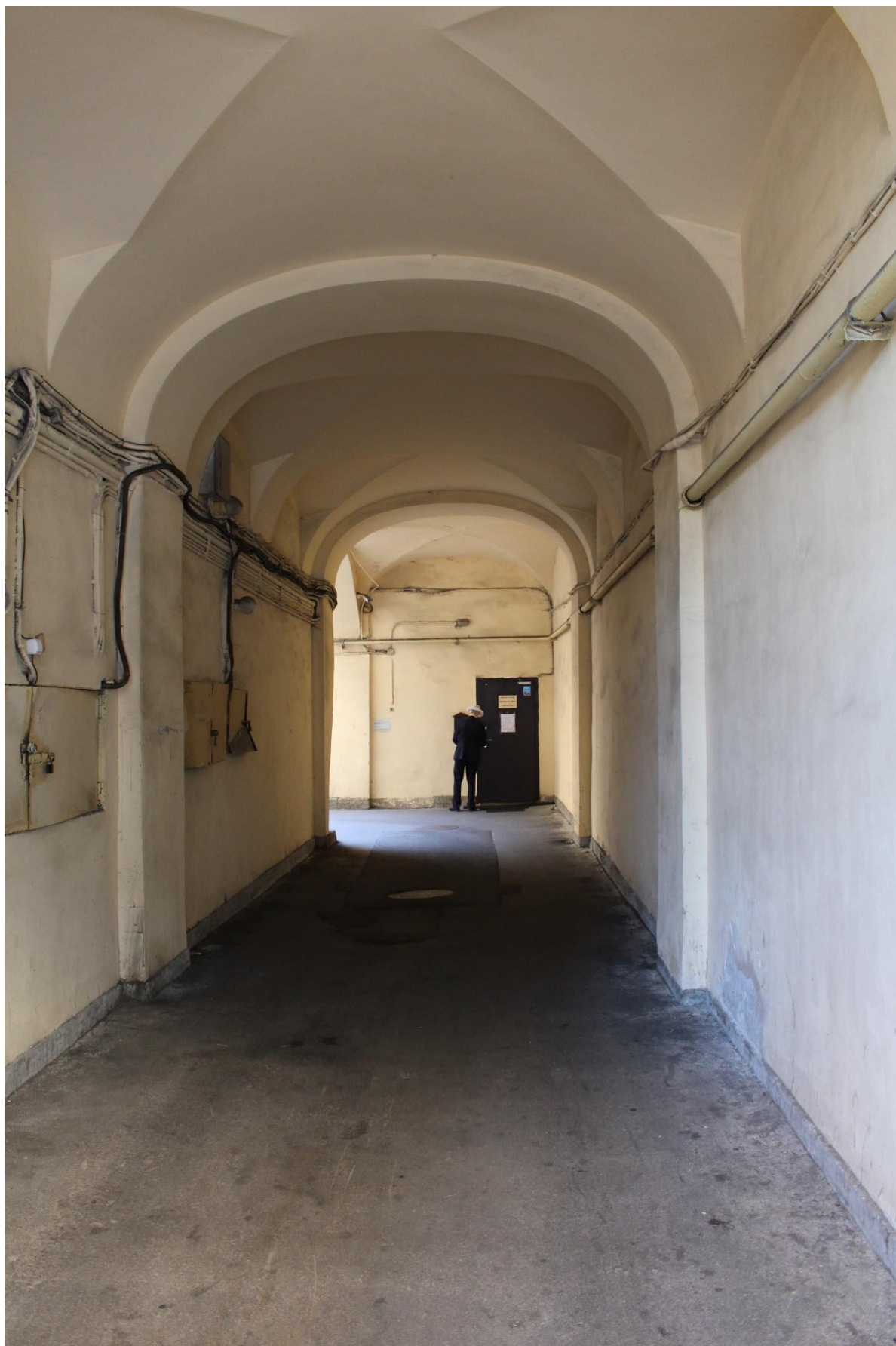
Фото 3. Вид на арку воротного проезда выявленного объекта культурного наследия регионального значения «Дом, в котором в 1892-1913 годах жил ученый-баллист Н.А. Забудский» с востока.
