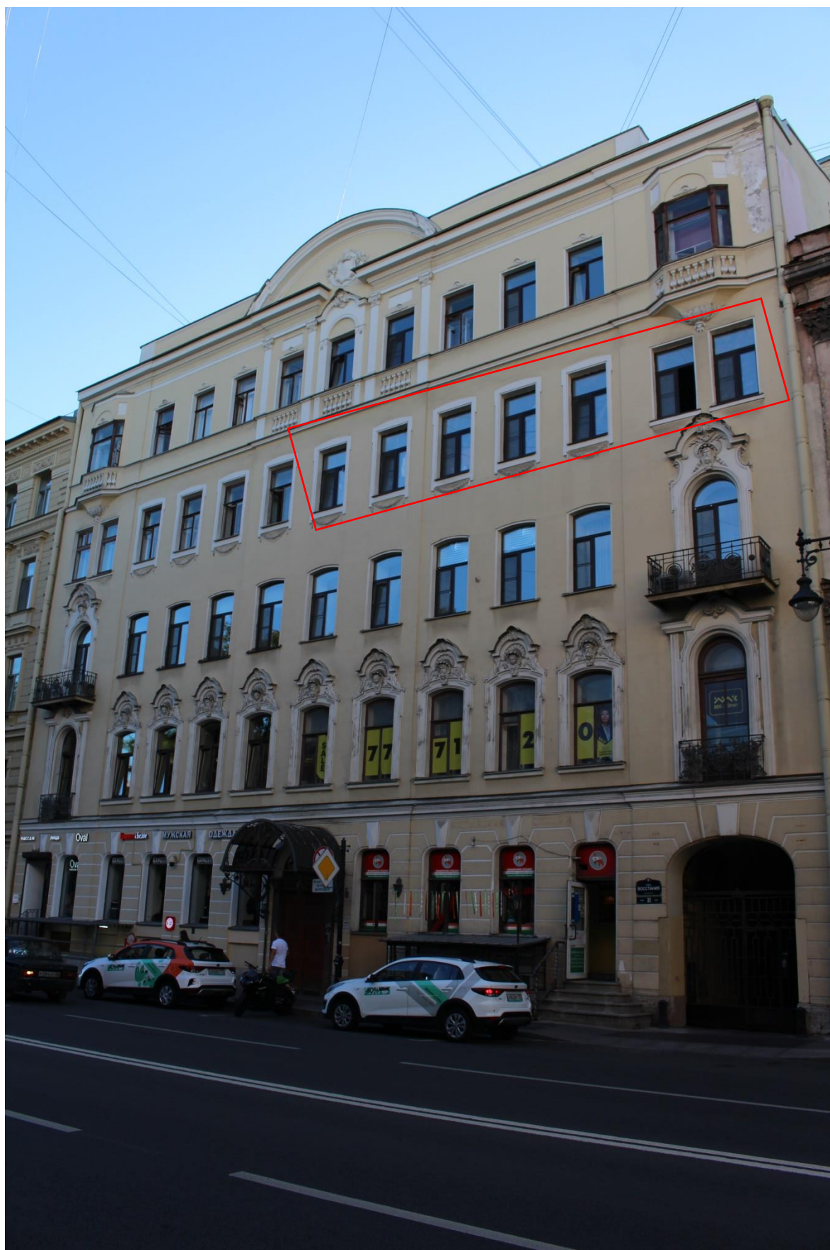
Фото 2. Вид на лицевой выявленного объекта культурного наследия регионального значения «Дом, в котором в 1892-1913 годах жил ученый-баллист Н.А. Забудский». Красным отмечены оконные проемы квартиры № 8.
