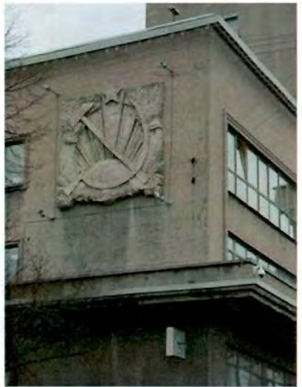
13. Угловая башня. Барельеф.
