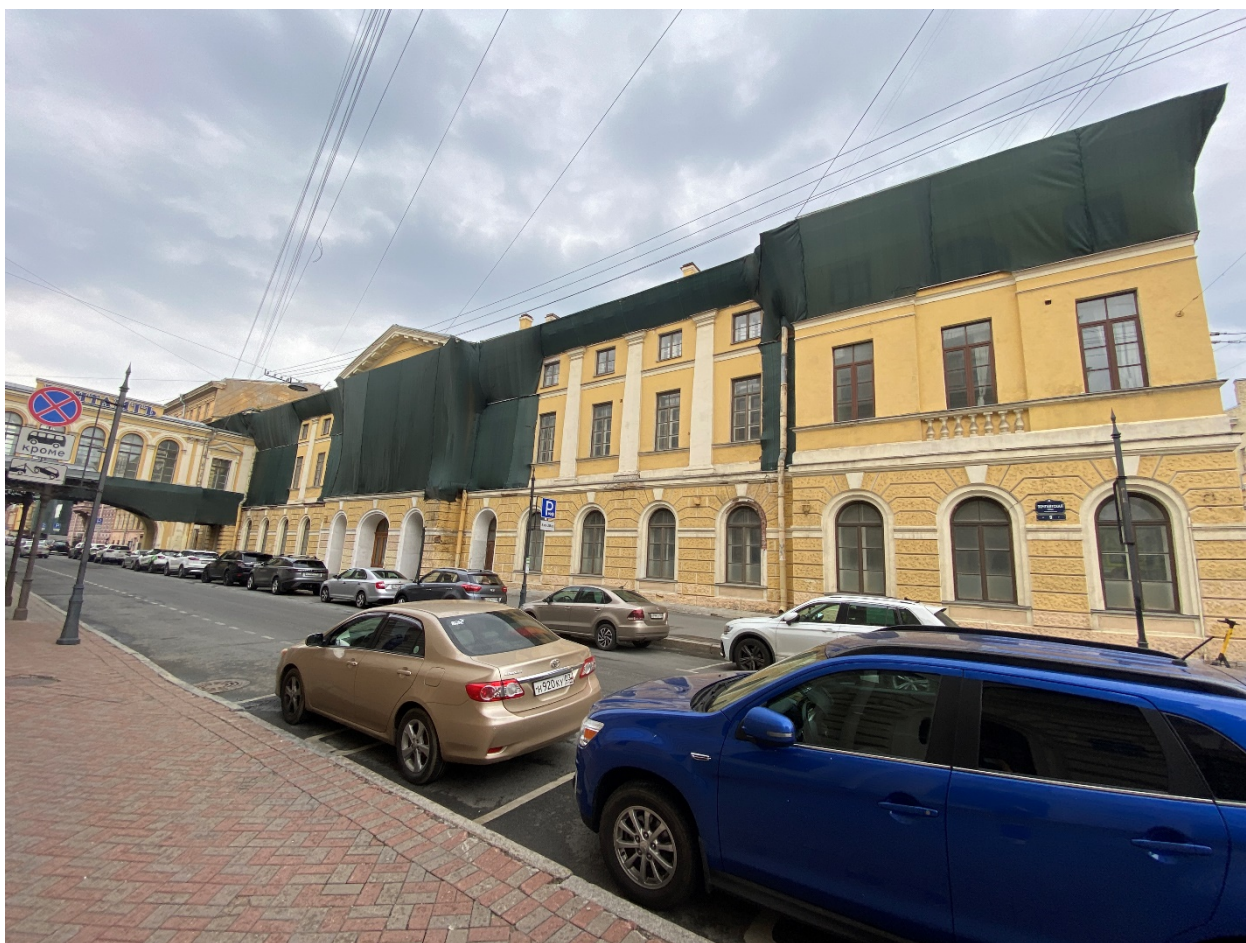
Фото №1. Угол северо-восточного и юго-восточного фасадов.
