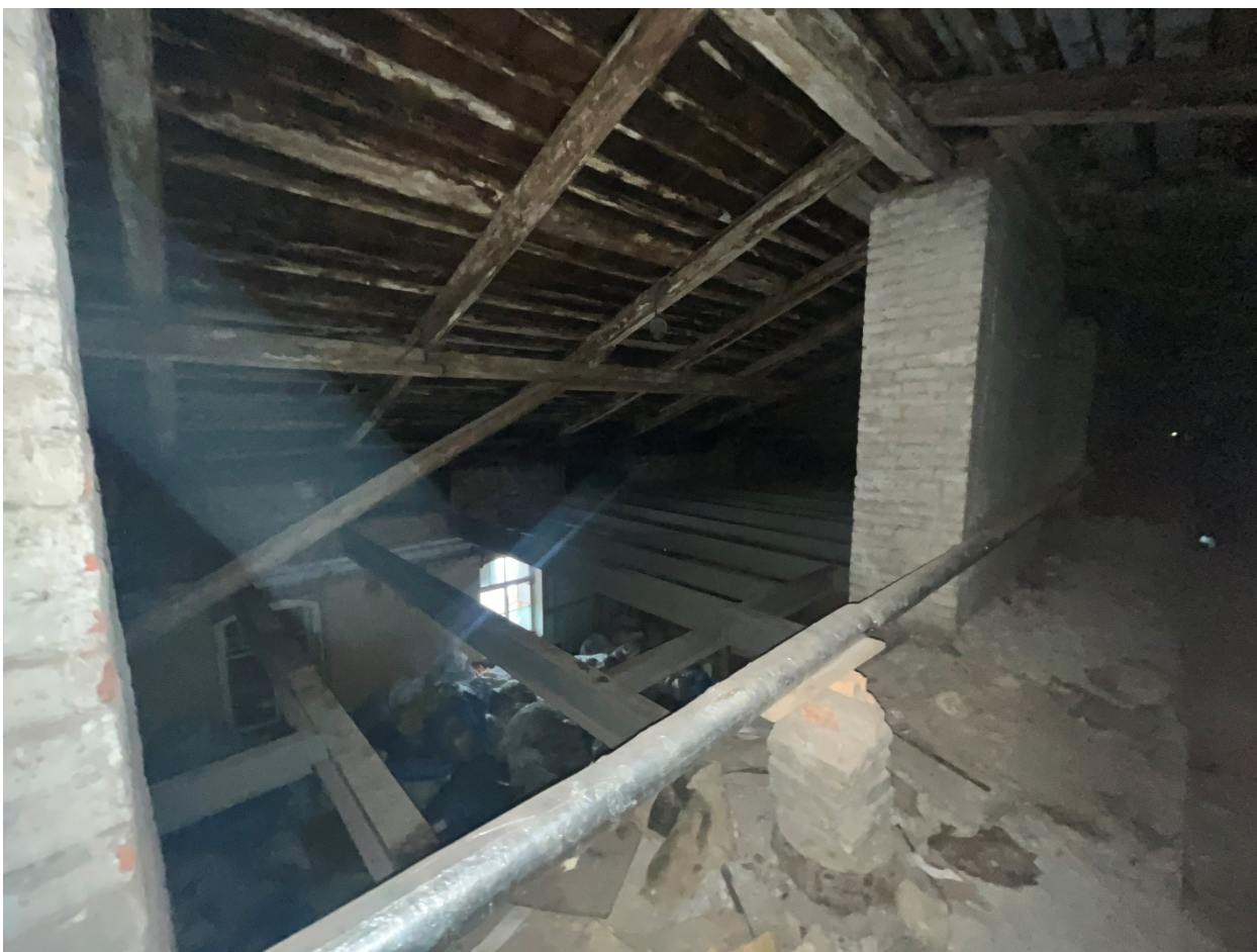
Фото №21. Чердачное пространство, фрагмент стропильной системы.
