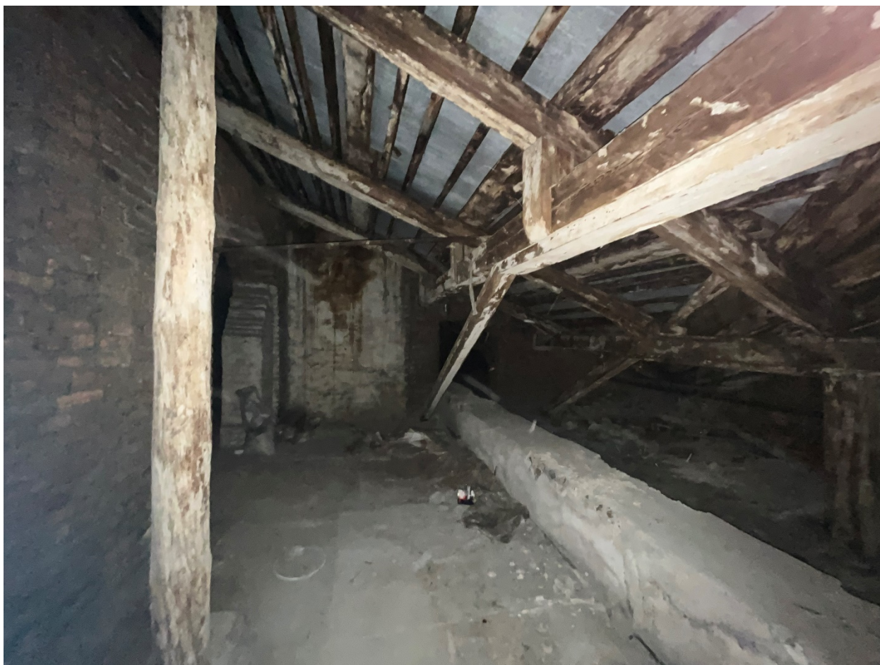
Фото №7. Чердачное пространство, фрагмент стропильной системы.
