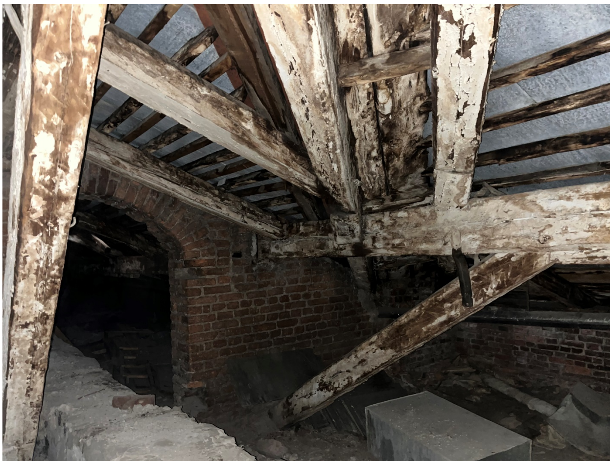
Фото №6. Чердачное пространство, фрагмент стропильной системы.
