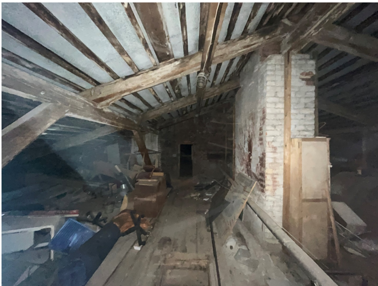
Фото №20. Чердачное пространство, фрагмент стропильной системы.
