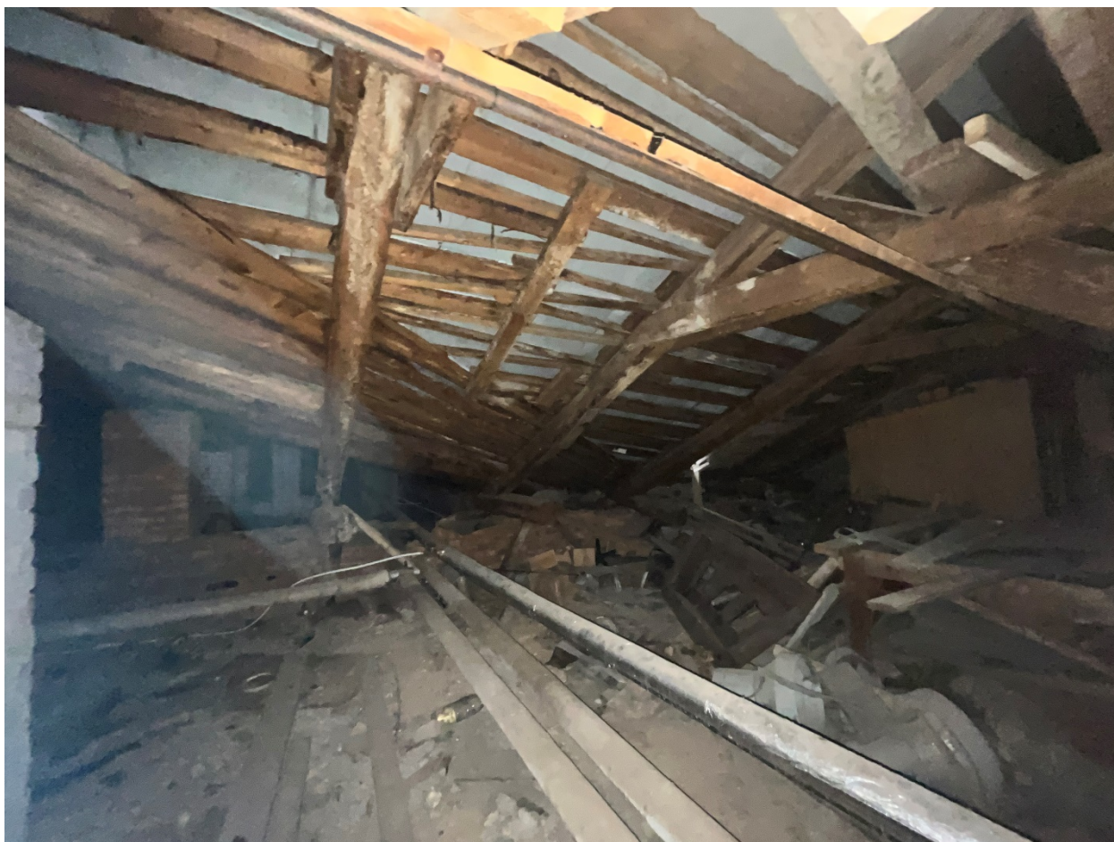
Фото №22. Чердачное пространство, фрагмент стропильной системы.
