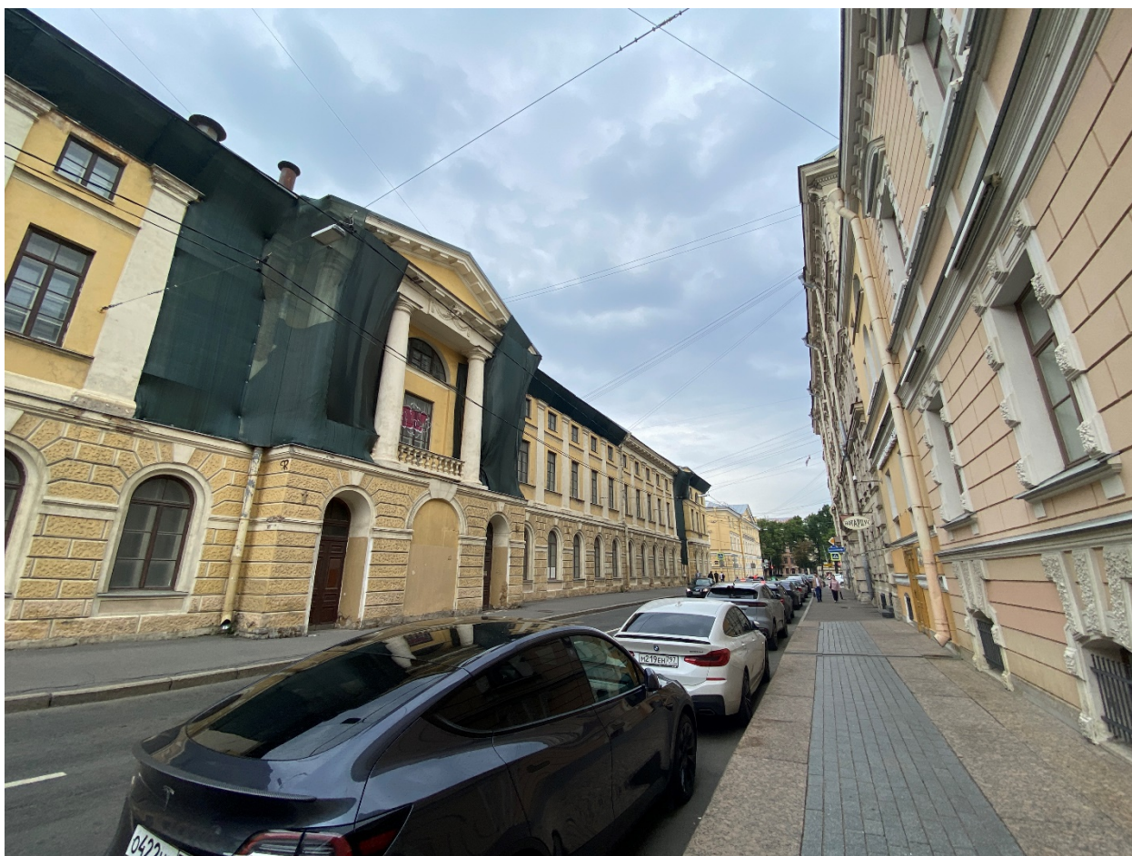
Фото №2. Фрагмент северо-восточного фасада.
