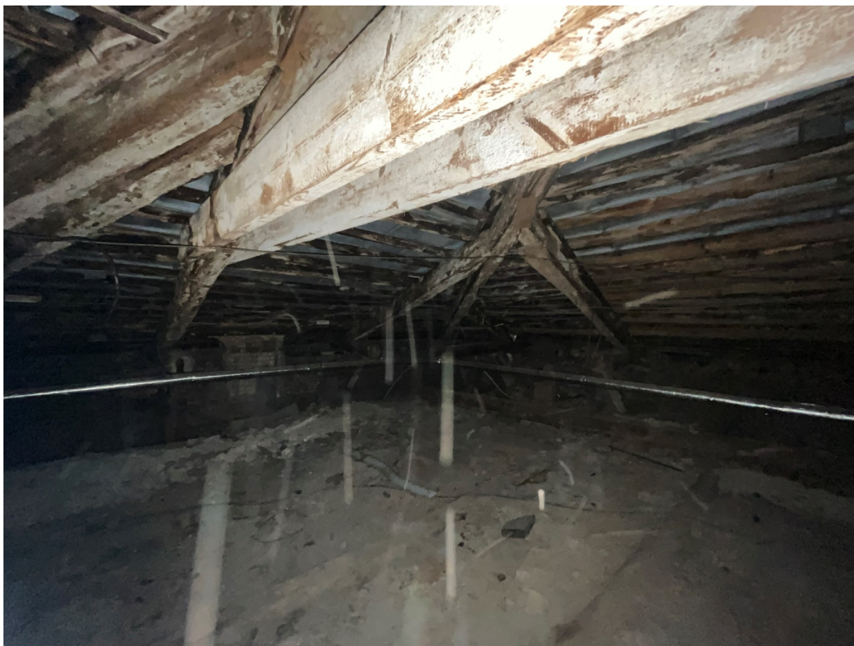
Фото №24. Чердачное пространство, фрагмент стропильной системы.
