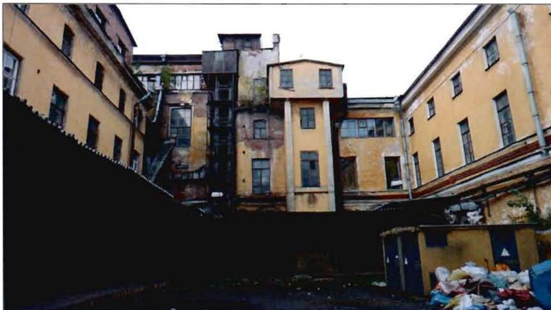
4. Дворовые фасады. Вид с востока.
