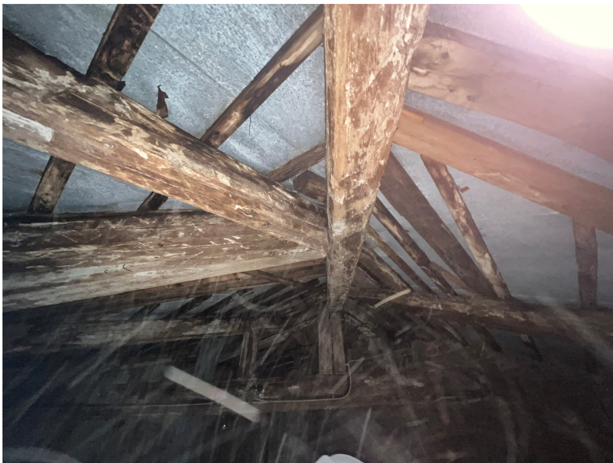
Фото №9. Чердачное пространство, фрагмент стропильной системы.
