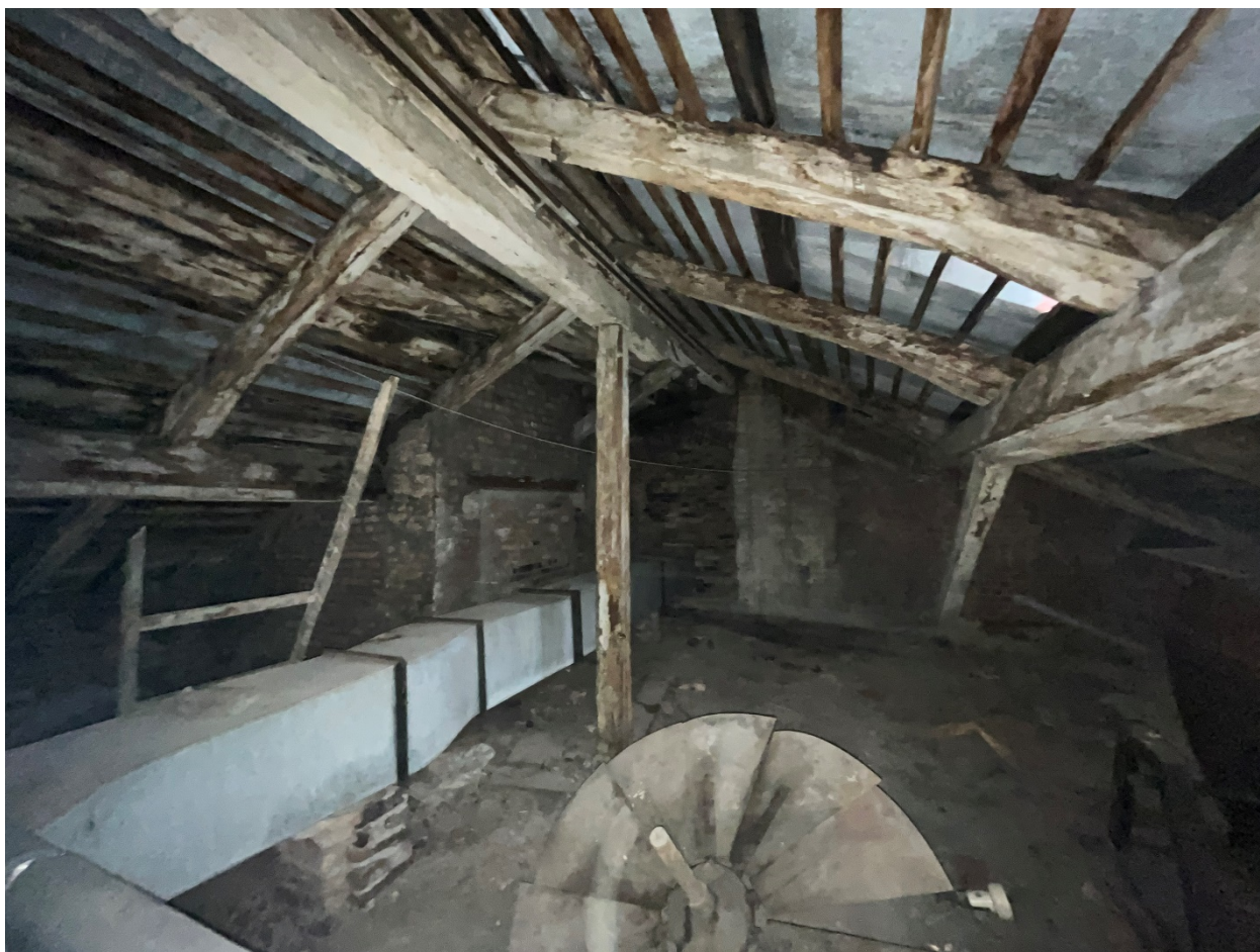
Фото №10. Чердачное пространство, фрагмент стропильной системы.
