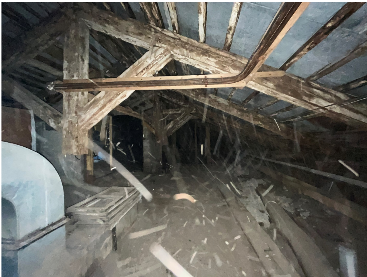
Фото №23. Чердачное пространство, фрагмент стропильной системы.
