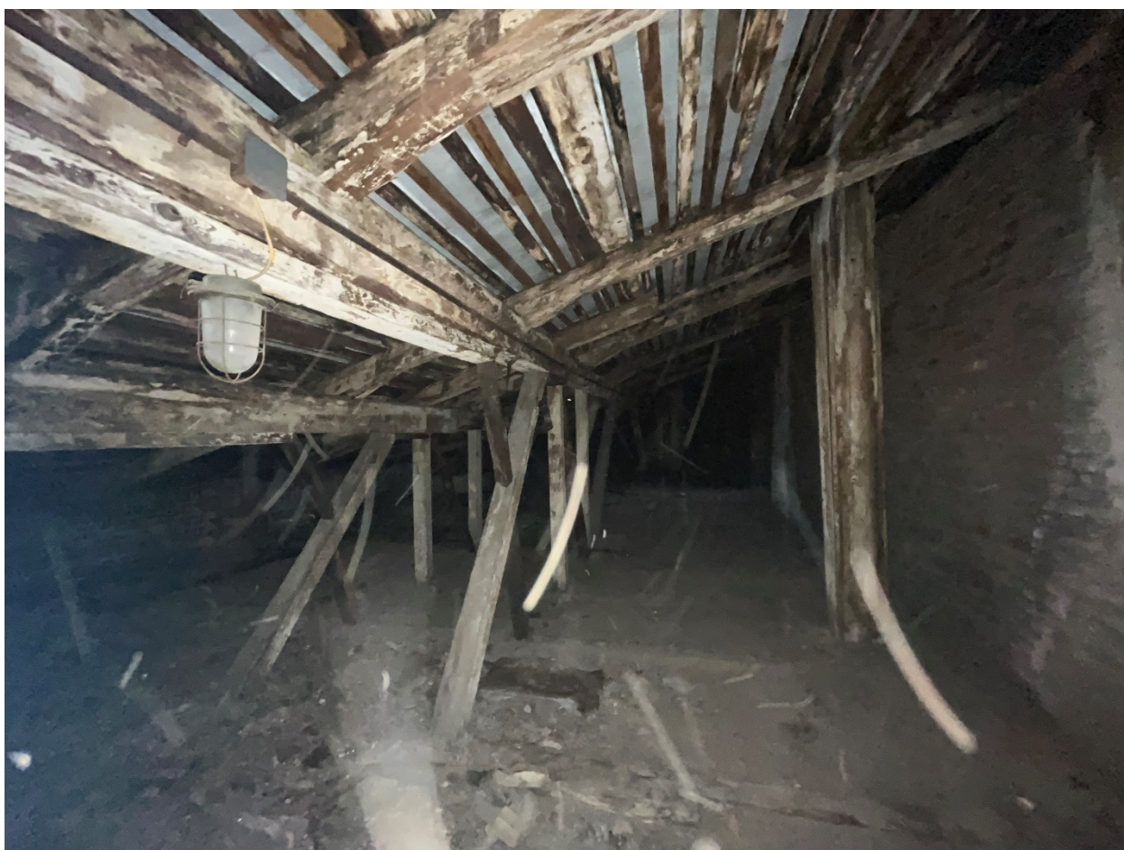
Фото №8. Чердачное пространство, фрагмент стропильной системы.
