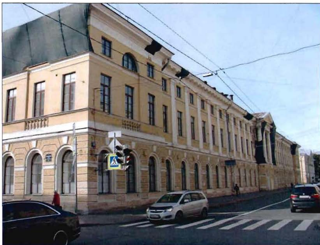
2. Восточный лицевой фасад. Вид с юго-востока.
