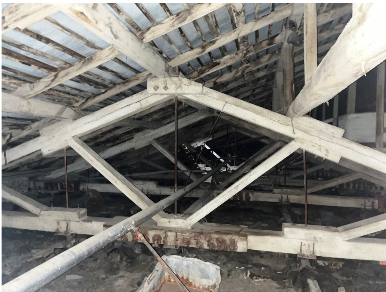
Фото №17. Чердачное пространство, фрагмент стропильной системы.
