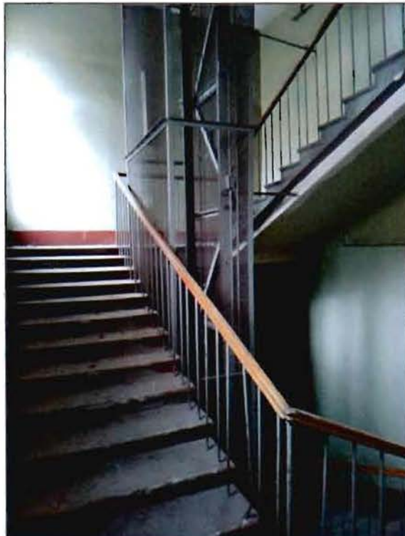
14. Лестница в западном корпусе по ул. Якубовича.
