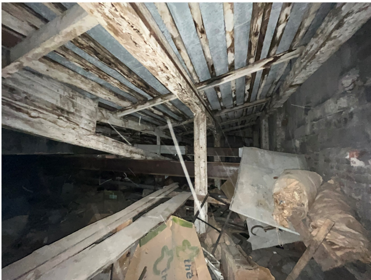
Фото №19. Чердачное пространство, фрагмент стропильной системы.
