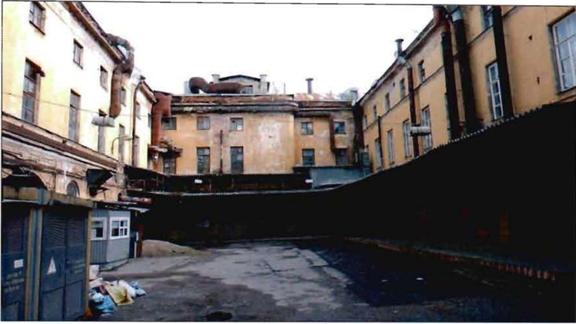
5. Дворовые фасады. Вид с запада.
