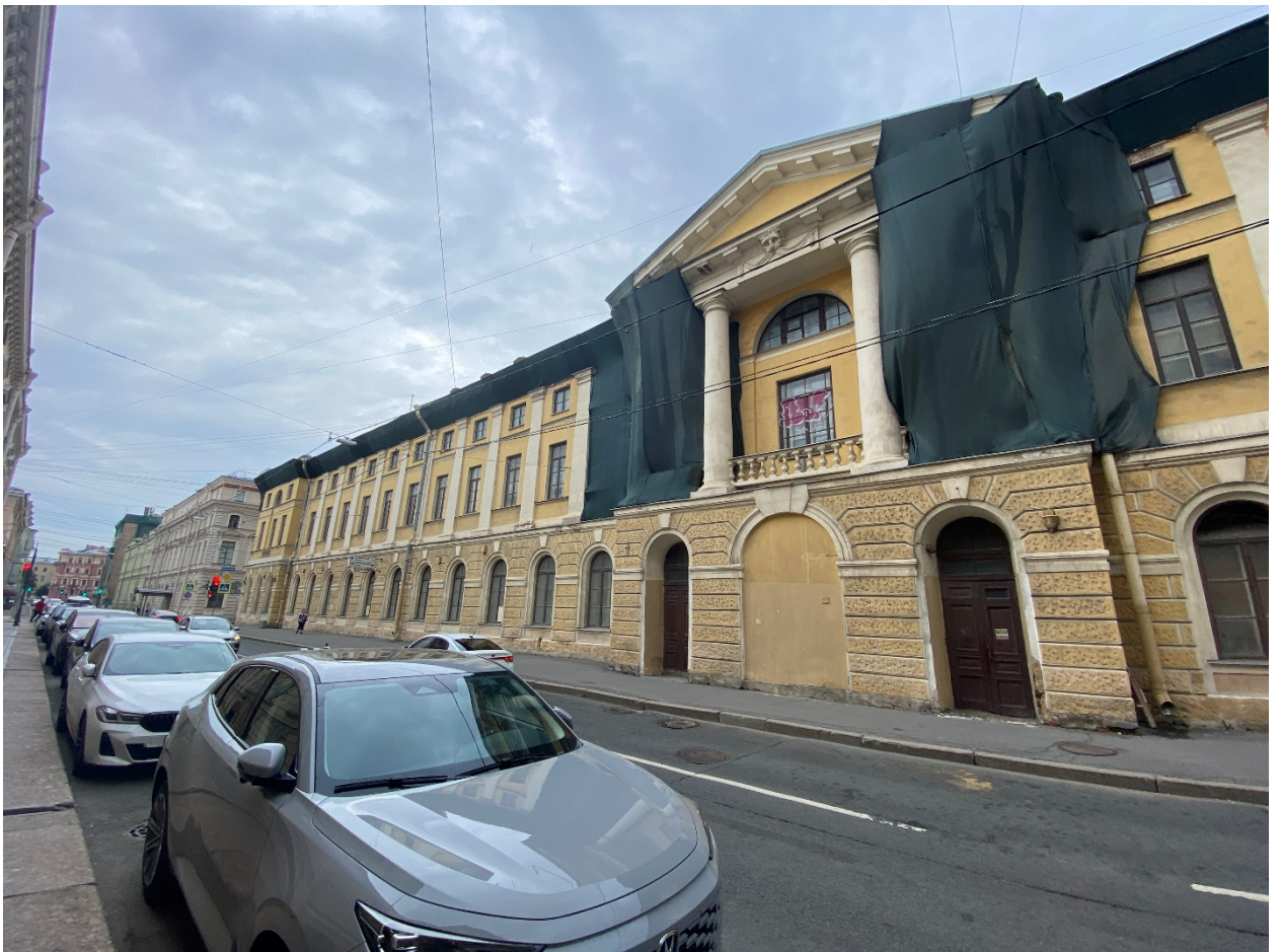
Фото №3. Фрагмент северо-восточного фасада.
