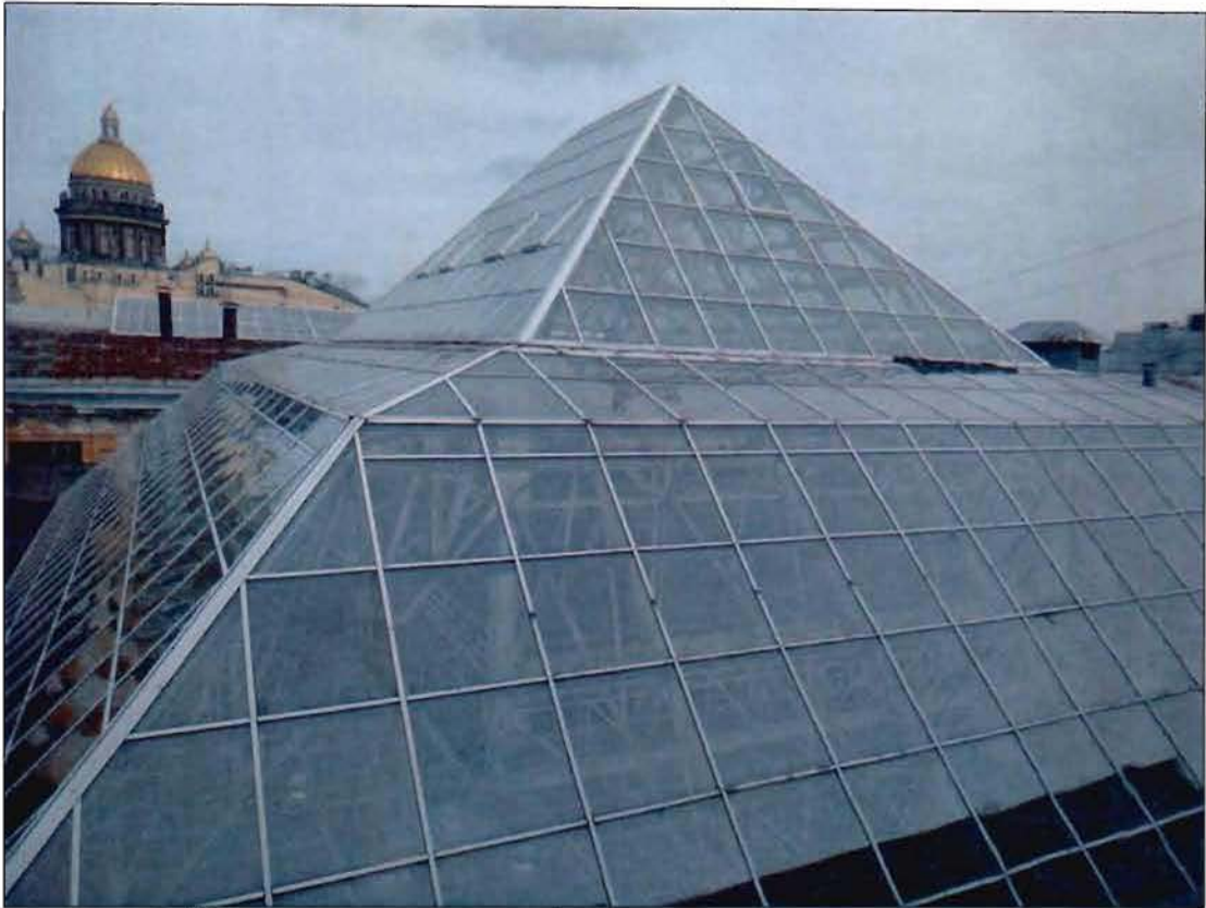
7. Конструкция светового фонаря над операционным залом.
