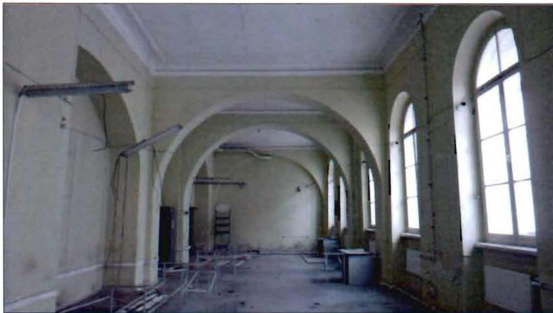
10. Перекрытие на арках. Первый этаж.
