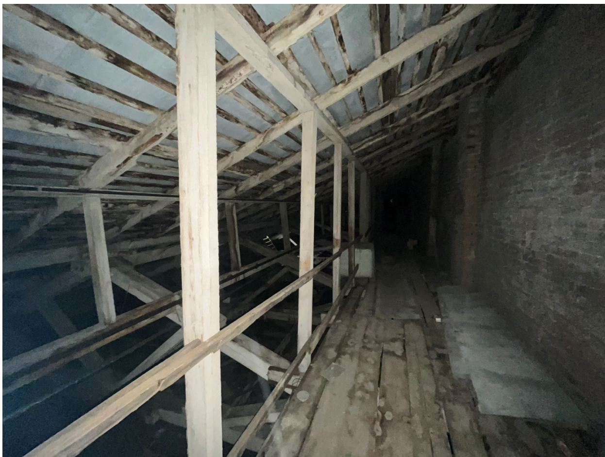
Фото №18. Чердачное пространство, фрагмент стропильной системы.
