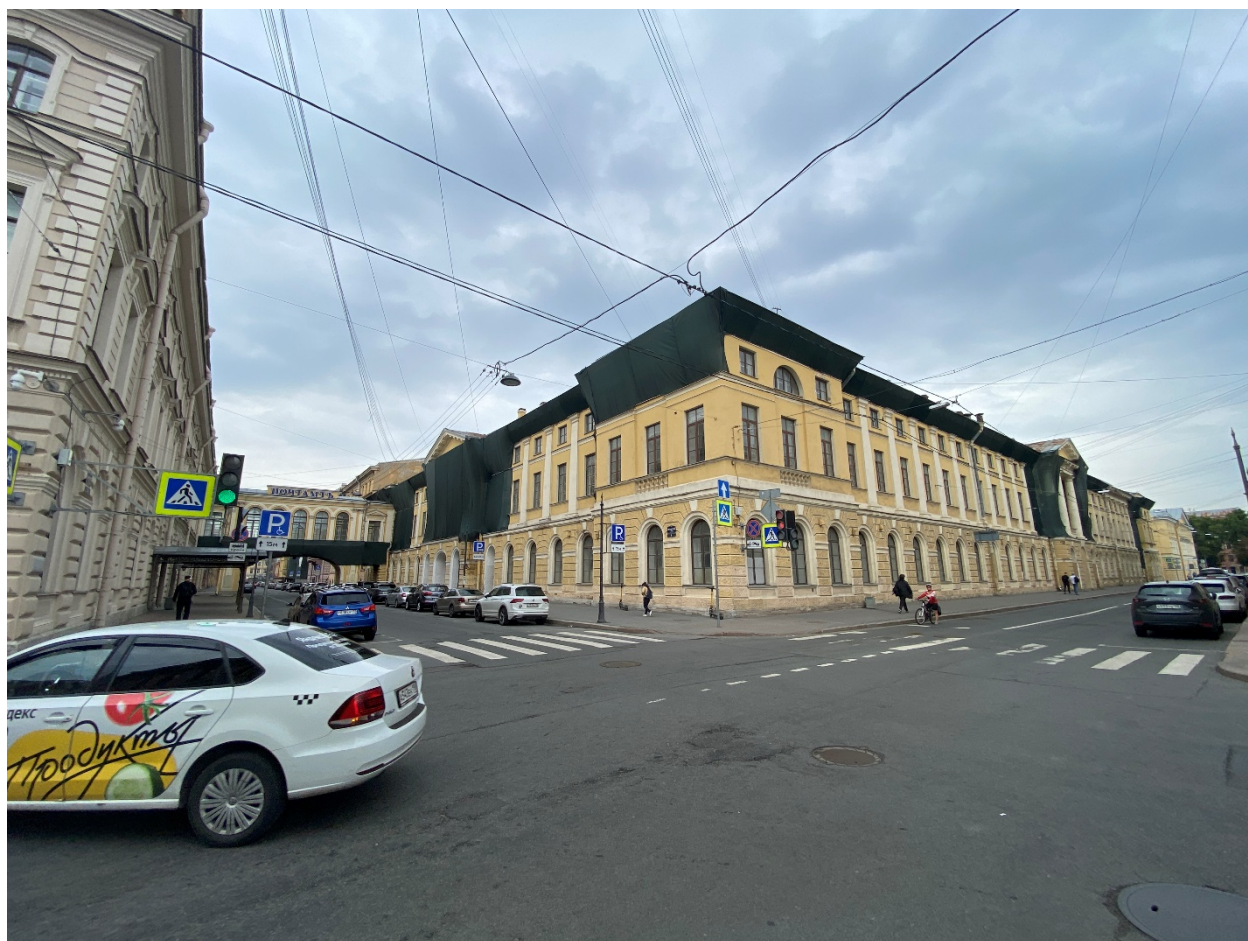
Фото №4. Фрагмент юго-восточного фасада.
