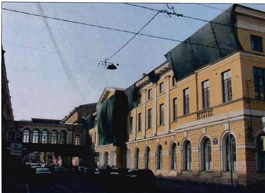
1. Южный лицевой фасад с переходной галереей. Вид с востока.
