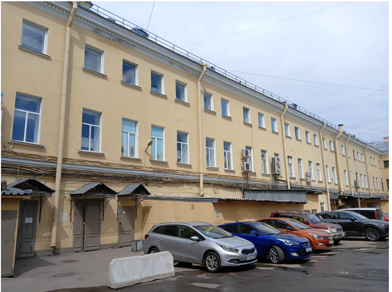
Фото 3. Объект культурного наследия регионального значения «Дом Яковлева С.Я.» по адресу: Санкт-Петербург, улица Гороховая, дом 45, литера А. Юго-западный фасад.
