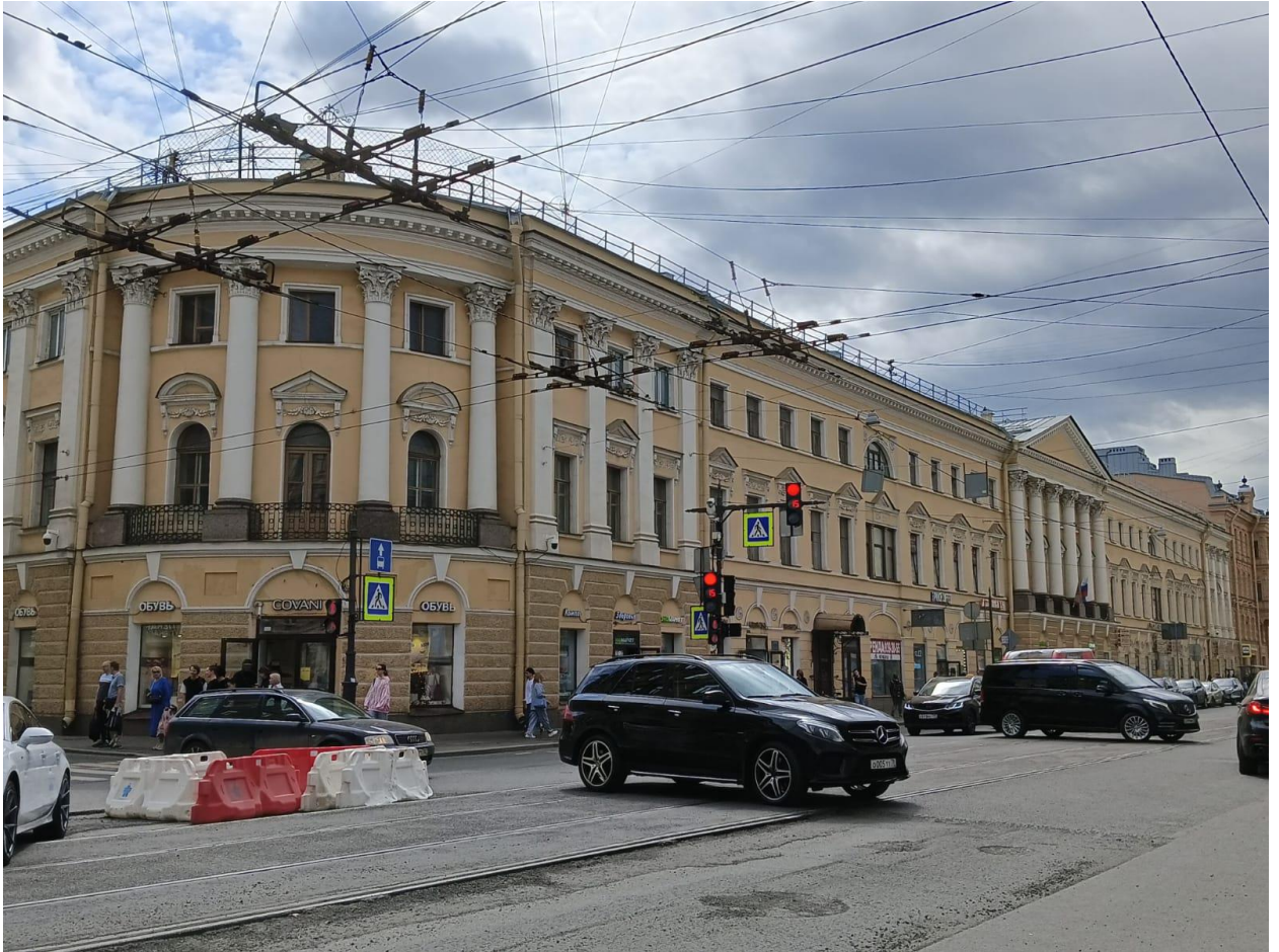
Фото 1. Объект культурного наследия регионального значения «Дом Яковлева С.Я.» по адресу: Санкт-Петербург, улица Гороховая, дом 45, литера А. Северо-западный фасад.
