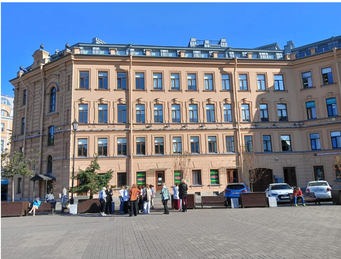
Фото 7. Объект культурного наследия регионального значения «Доходный дом Успенской церкви», Санкт-Петербург, Садовая улица, дом 40, литера Б. Южный фасад.
