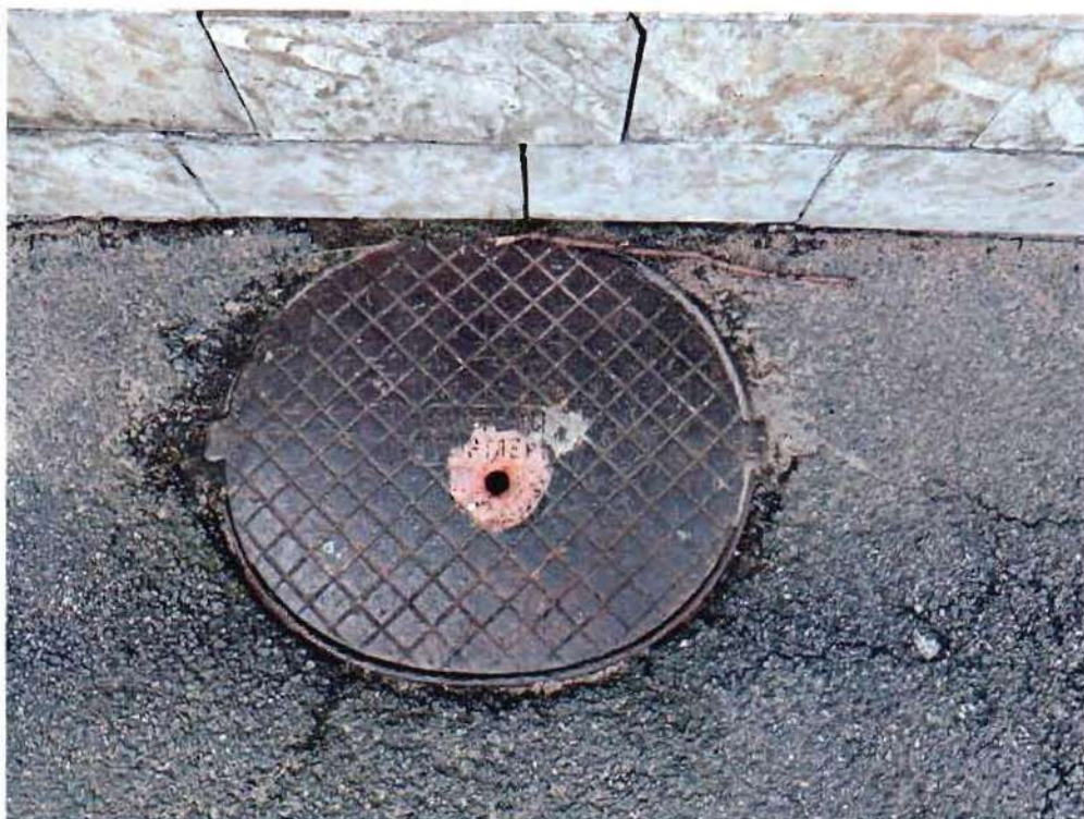
24. Крышка канализационного колодца в западной части объекта культурного наследия (фото от 25.08.2023).
