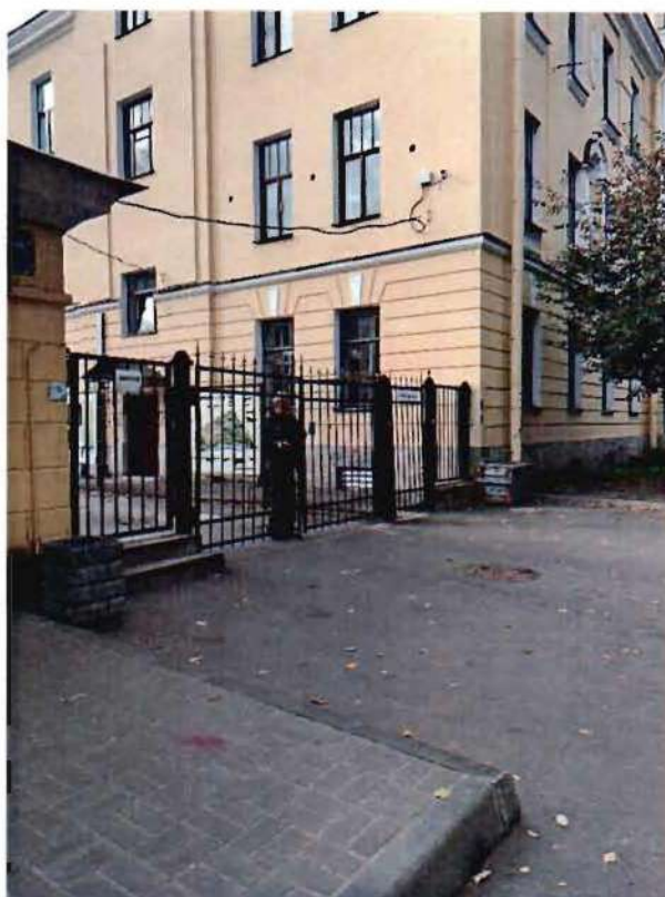
30. Фрагмент ограды объекта культурного наследия с северной стороны (фото от 13.09.2023).
