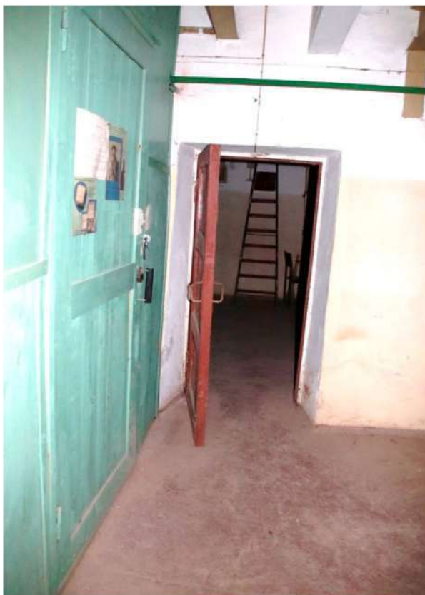
24. Объект культурного наследия федерального значения «Гербарий и библиотека» по адресу: Санкт-Петербург, улица Профессора Попова, дом 2, литера А (Санкт-Петербург, Профессора Попова ул., 2, корп.7) Помещение подвала Дата съёмки: 22.08.2024
