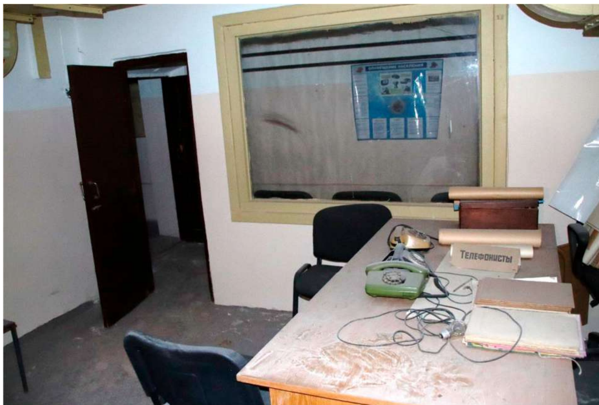
22. Объект культурного наследия федерального значения «Гербарий и библиотека» по адресу: Санкт-Петербург, улица Профессора Попова, дом 2, литера А (Санкт-Петербург, Профессора Попова ул., 2, корп.7) Помещение подвала Дата съемки: 22.08.2024
