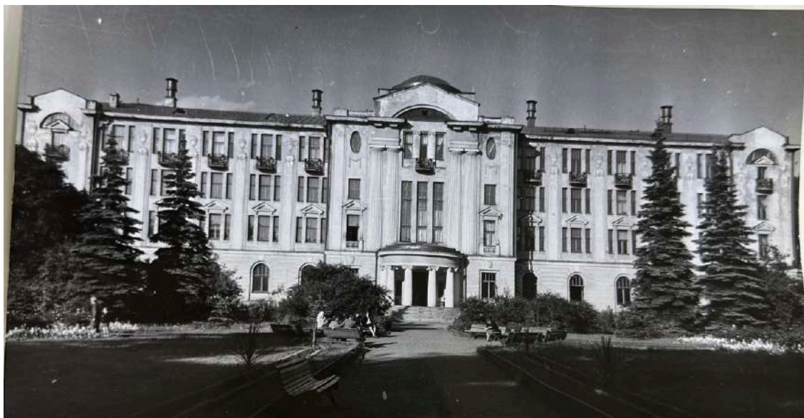
Илл. 78. Здание гербария и библиотеки. Главный фасад. Архит. И.А. Дитрих. Снимок 1935 г. // Источник: Ботанический сад: здания и сооружения. Историческая справка. Том II. Фото – иллюстрации. Академия наук СССР Ботанический институт им. В.Л. Комарова. 1985 г. П. 94-1. Отдел систематизации, популяризации и хранения документированной информации об объектах культурного наследия (Архив КГИОП).
