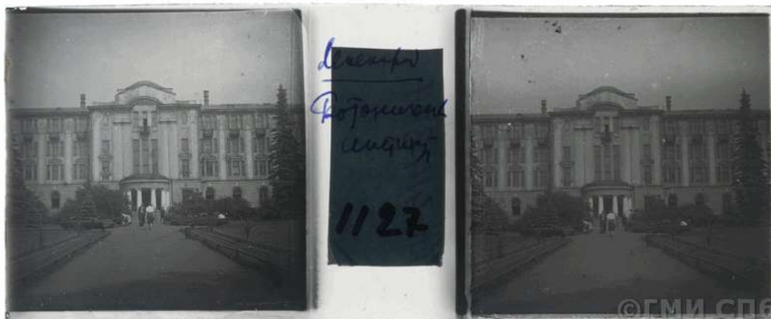
Илл. 88. Ботанический институт; главный фасад. Период создания: 1953 г. Номер в Госкаталоге: 39865923. Номер по КП (ГИК): ГМИ СПб 414377. Инвентарный номер: ГМИ СПб Инв. №- П-2104 кр // Источник: https://goskatalog.ru/portal/#/collections?id=40094019
