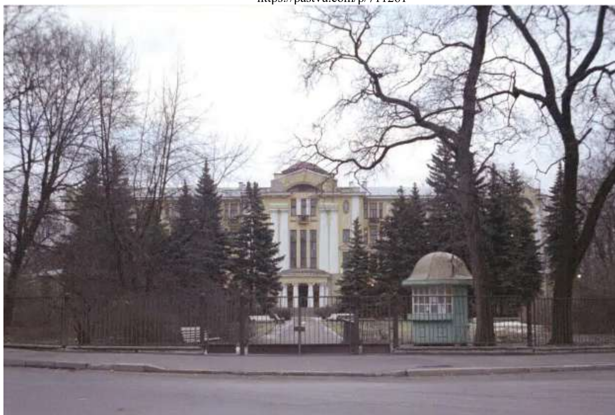
Илл. 106. Вход в Ботанический сад. 1998–2000 гг. // Источник: https://pastvu.com/p/1039424
