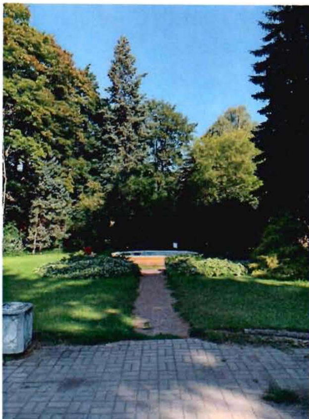
20. Фрагмент чаши фонтана с северо-западной стороны объекта культурного наследия (фото от 25.08.2023).
