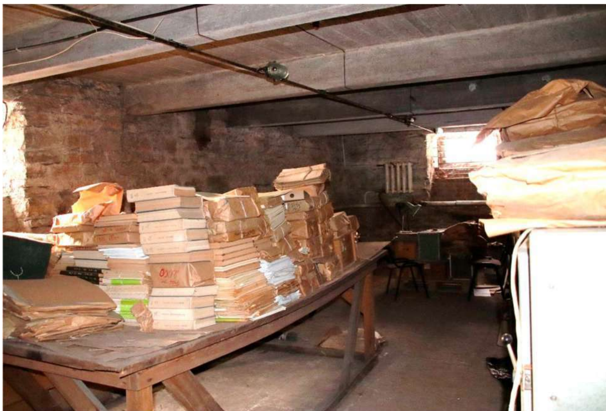
20. Объект культурного наследия федерального значения «Гербарий и библиотека» по адресу: Санкт-Петербург, улица Профессора Попова, дом 2, литера А (Санкт-Петербург, Профессора Попова ул., 2, корп.7) Помещение подвала Дата съемки: 22.08.2024
