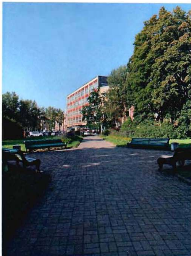
18. Фрагмент объекта культурного наследия с южной стороны (фото от 25.08.2023).
