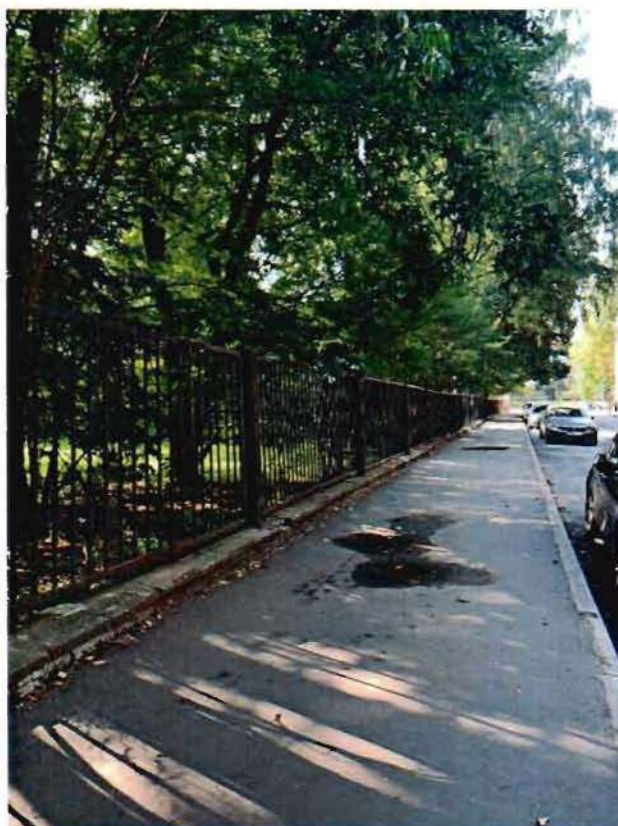
31. Фрагмент ограды объекта культурного наследия с северной стороны (фото от 13.09.2023).
