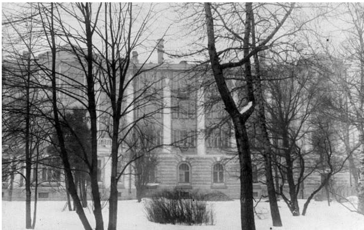
Илл. 64. Боковой фасад здания гербария. Автор съёмки: Штейнберг Яков Владимирович. Дата съёмки: 1915 г. Источник: ЦГАКФФД СПб Е 18354
