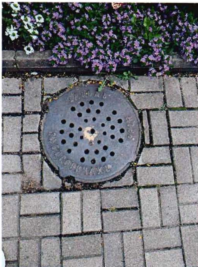
22. Крышка дождевого колодца в западной части объекта культурного наследия (фото от 25.08.2023).
