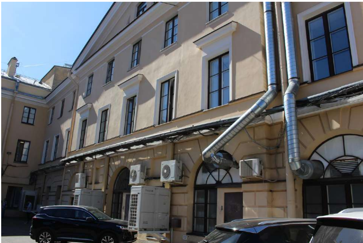
60. Вид на северо-западный дворовый фасад объекта культурного наследия федерального значения «Казармы (Трехэскадронный корпус)».
