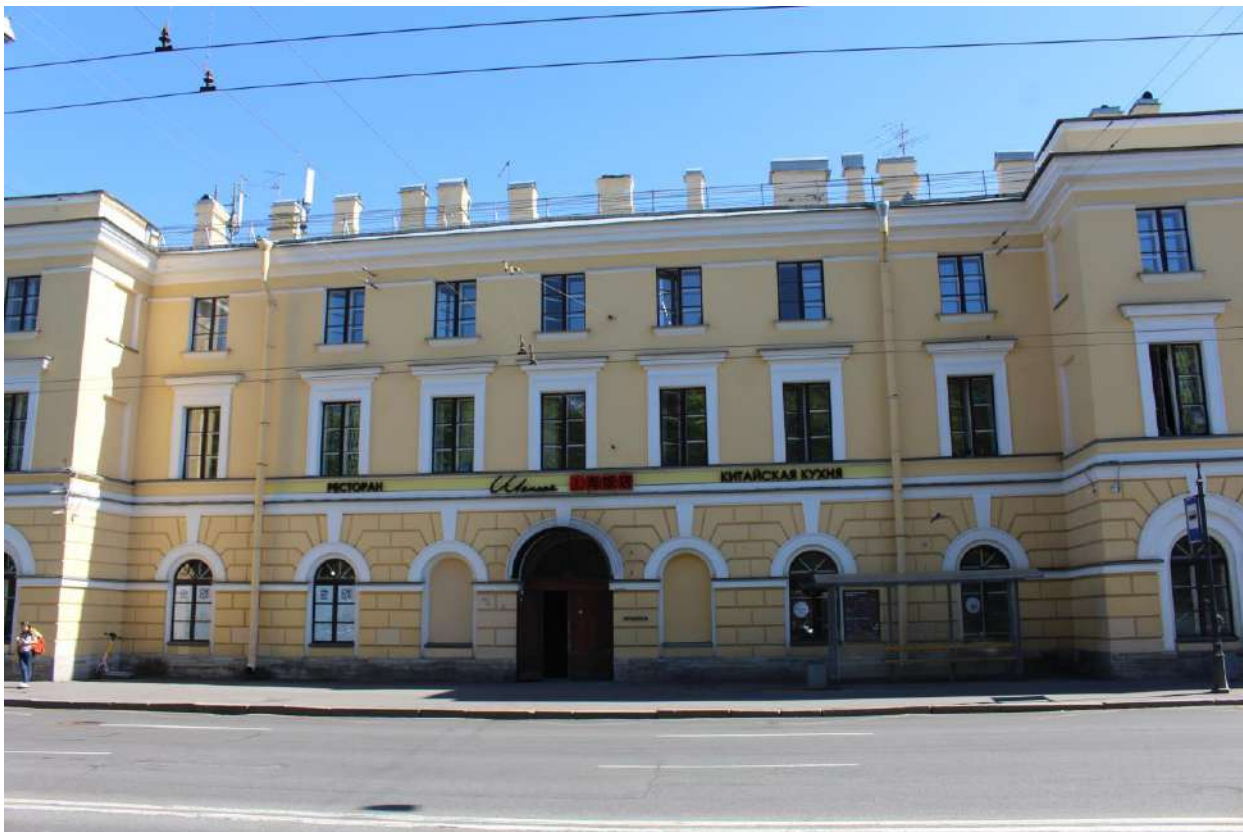
29. Вид на северо-западный фасад объекта культурного наследия федерального значения «Казармы (Трехэскадронный корпус)».
