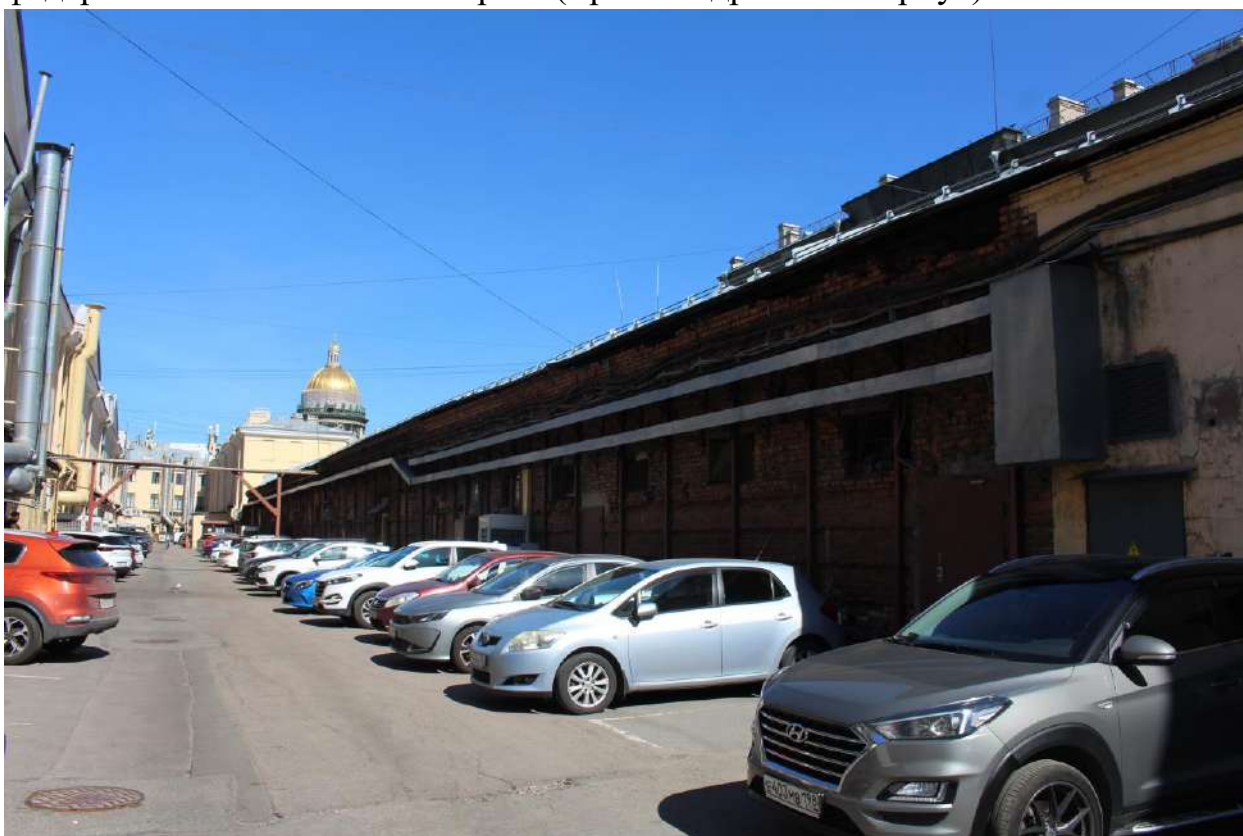
57. Вид на юго-восточный дворовый фасад объекта культурного наследия федерального значения «Казармы (Трехэскадронный корпус)».
