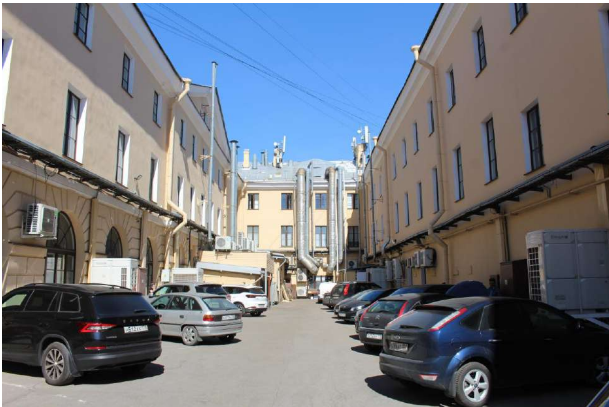
40. Вид на дворовые фасады в северо-восточной части объекта культурного наследия федерального значения «Казармы (Трехэскадронный корпус)».
