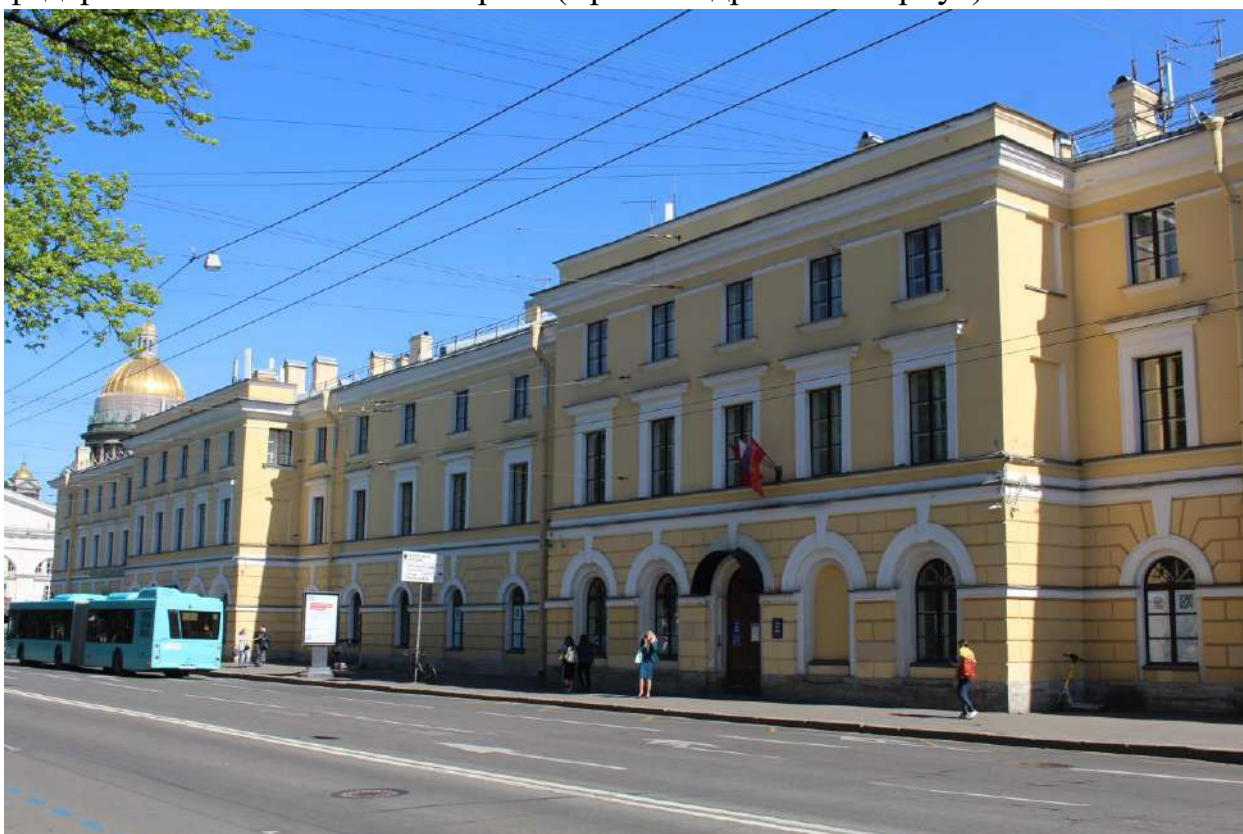
30. Вид на северо-западный фасад объекта культурного наследия федерального значения «Казармы (Трехэскадронный корпус)».
