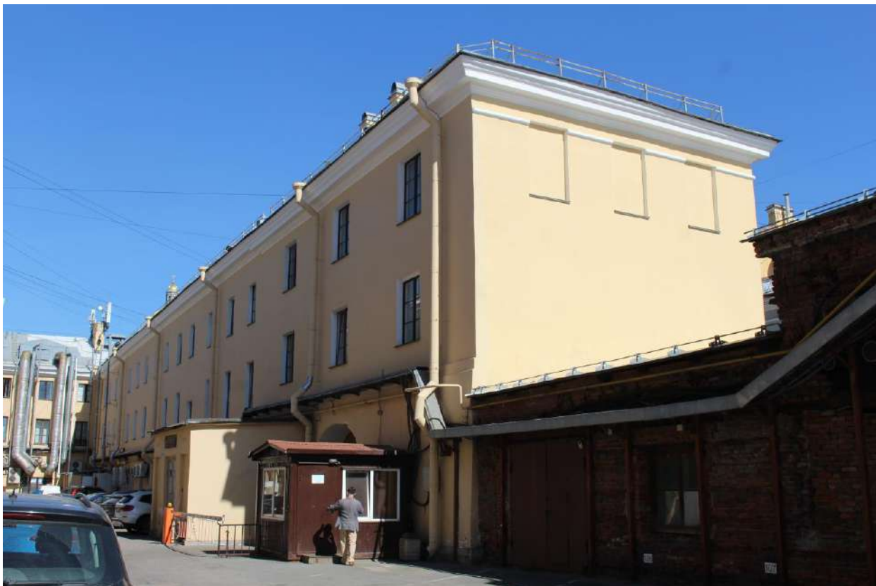
44. Вид на юго-восточный дворовый фасад объекта культурного наследия федерального значения «Казармы (Трехэскадронный корпус)».
