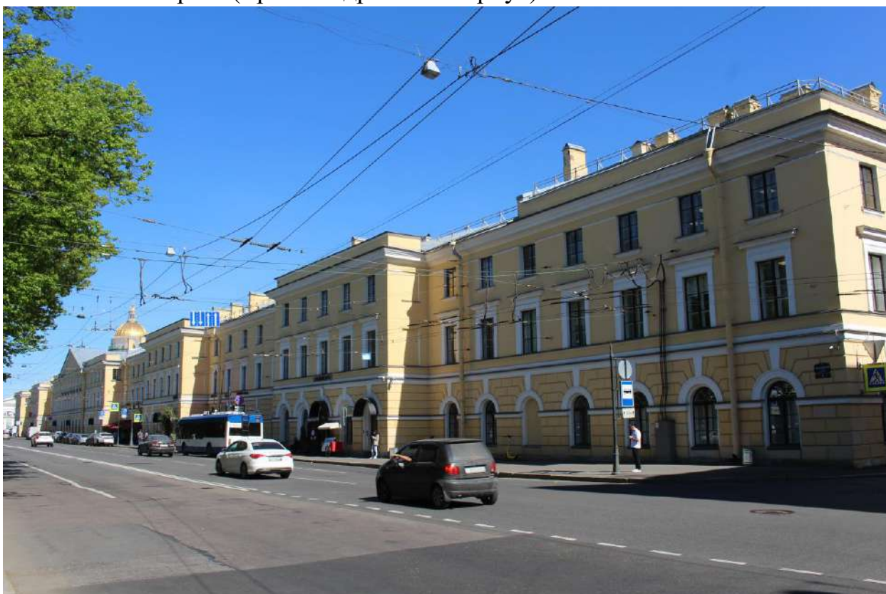
18. Вид на северо-западный фасад объекта культурного наследия федерального значения «Казармы (Трехэскадронный корпус)».
