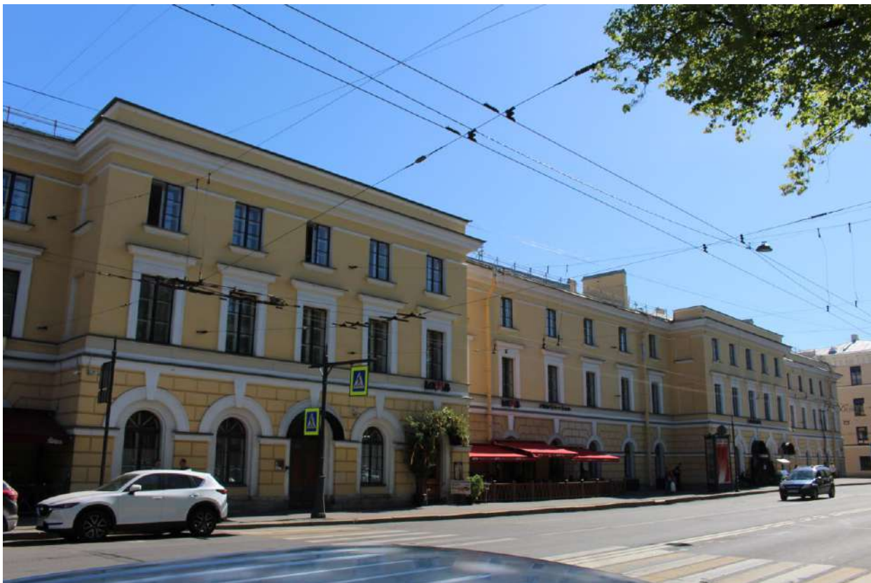
23. Вид на северо-западный фасад объекта культурного наследия федерального значения «Казармы (Трехэскадронный корпус)».
