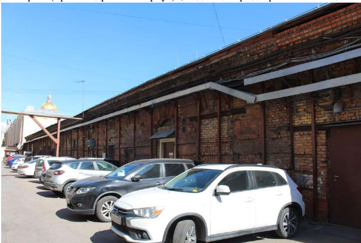
51. Вид на юго-восточный дворовый фасад объекта культурного наследия федерального значения «Казармы (Трехэскадронный корпус)».
