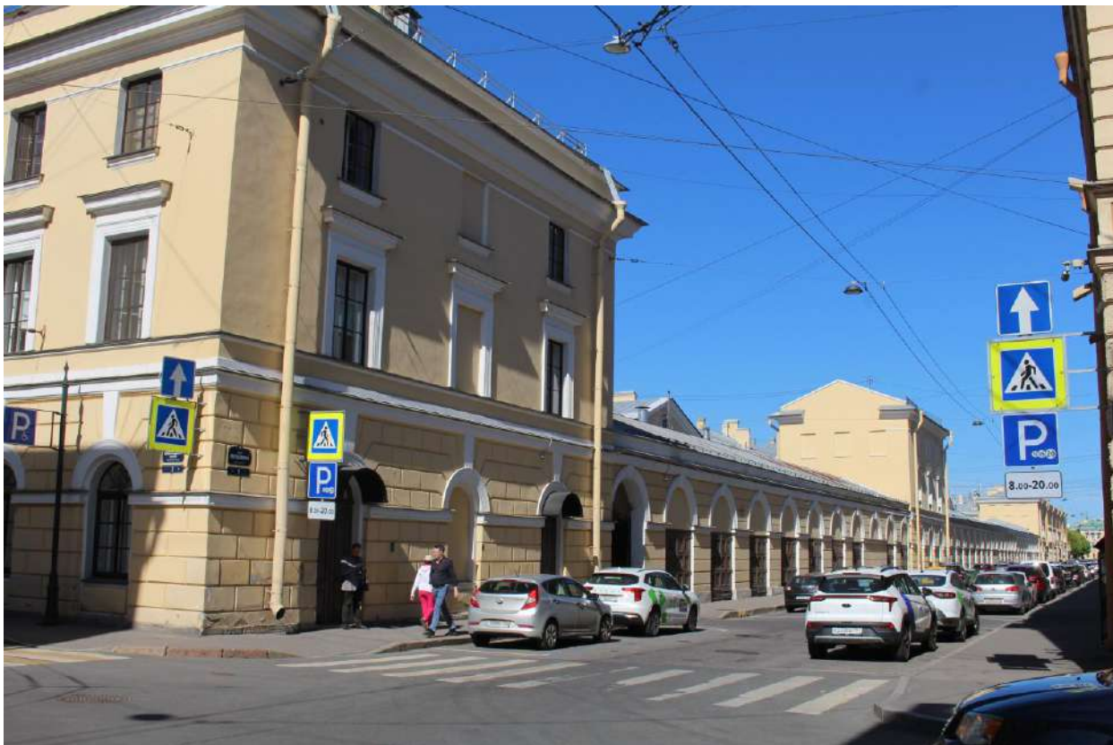
15. Вид на юго-восточный фасад объекта культурного наследия федерального значения «Казармы (Трехэскадронный корпус)».
