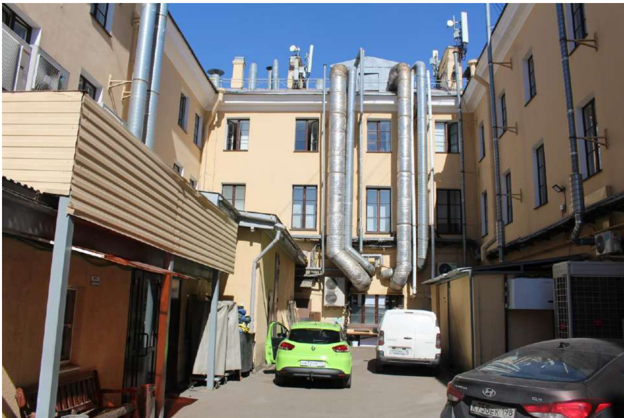
34. Вид на северо-восточный дворовый фасад объекта культурного наследия федерального значения «Казармы (Трехэскадронный корпус)».
