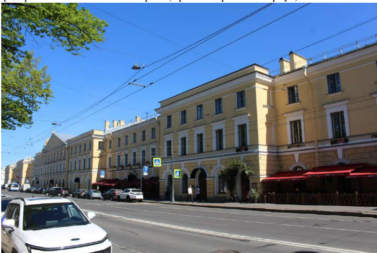
22. Вид на северо-западный фасад объекта культурного наследия федерального значения «Казармы (Трехэскадронный корпус)».
