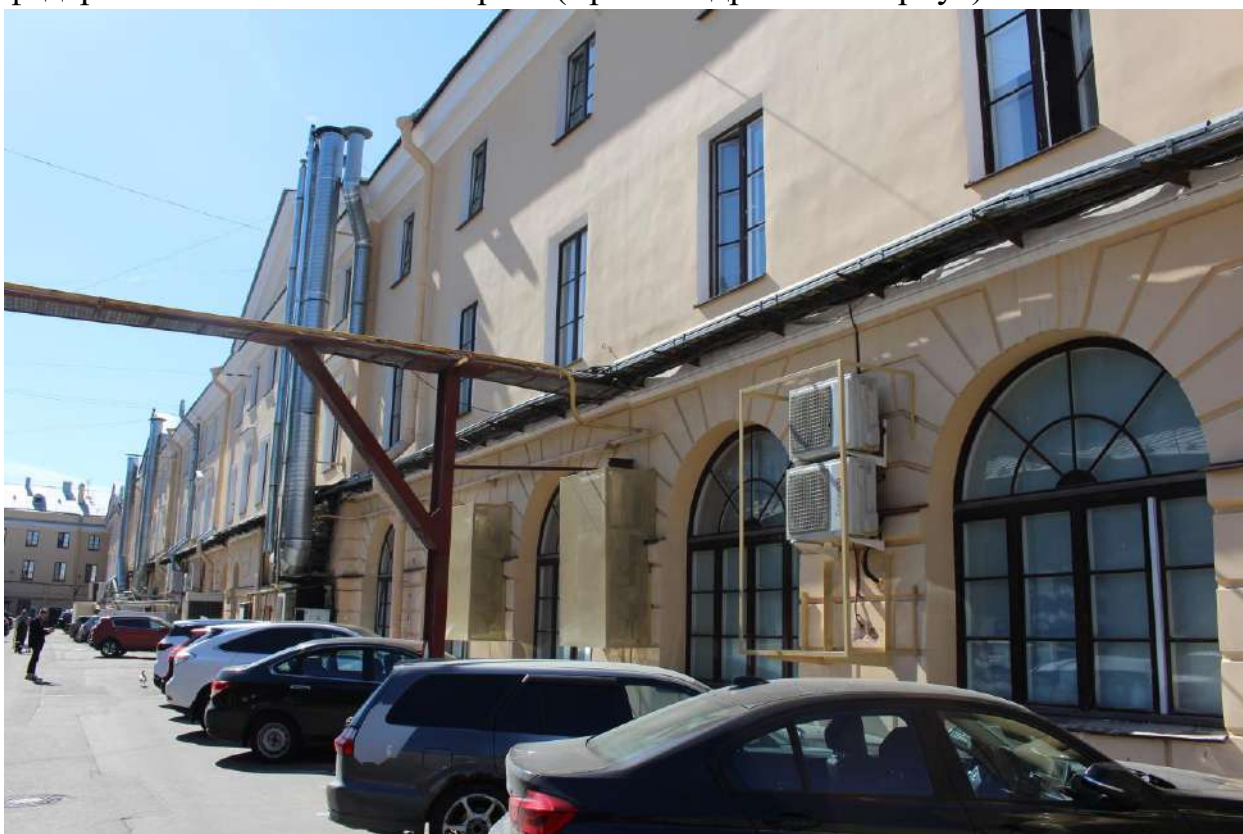
47. Вид на северо-западный дворовый фасад объекта культурного наследия федерального значения «Казармы (Трехэскадронный корпус)».
