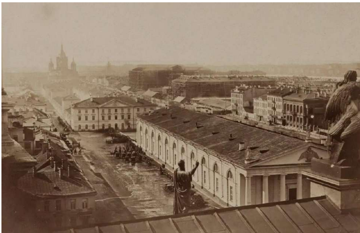
25. Вид с Исаакиевского собора в сторону Благовещенской площади. 1857-1858 гг. (источник: https://pastvu.com/p/889790 ).
