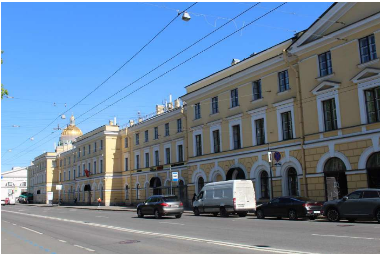
27. Вид на северо-западный фасад объекта культурного наследия федерального значения «Казармы (Трехэскадронный корпус)».
