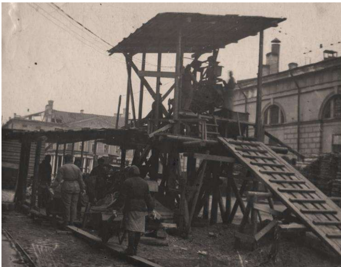
38. Работы по восстановлению города. 1944 г. (источник: госкаталог.рф № 38853820).
