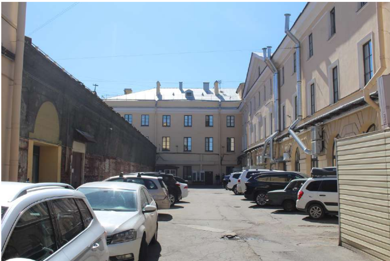
58. Дворовые фасады объекта культурного наследия федерального значения «Казармы (Трехэскадронный корпус)», вид из юго-западной части двора на юго-запад.
