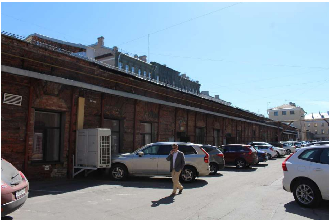
46. Вид на юго-восточный дворовый фасад объекта культурного наследия федерального значения «Казармы (Трехэскадронный корпус)».
