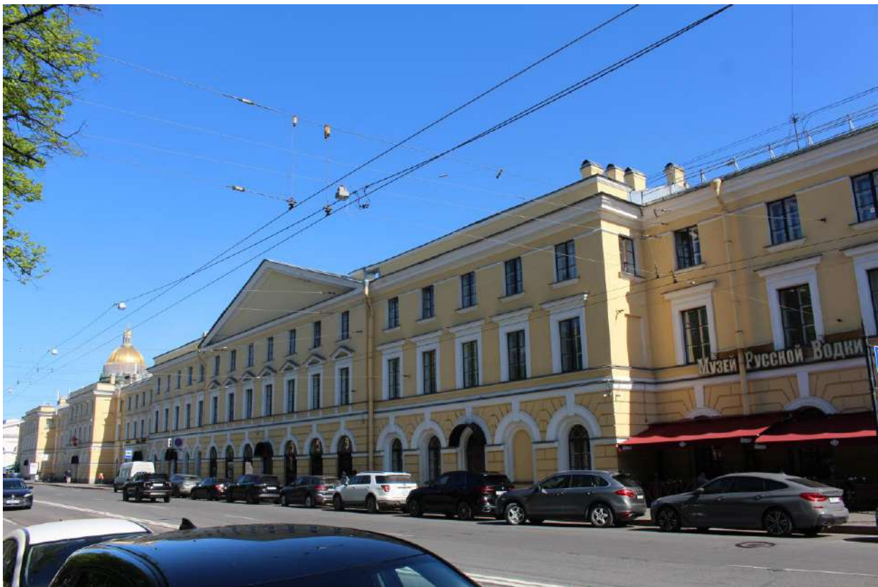
25. Вид на северо-западный фасад объекта культурного наследия федерального значения «Казармы (Трехэскадронный корпус)».
