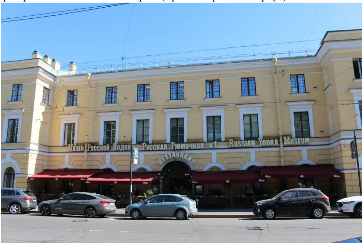
24. Вид на северо-западный фасад объекта культурного наследия федерального значения «Казармы (Трехэскадронный корпус)».
