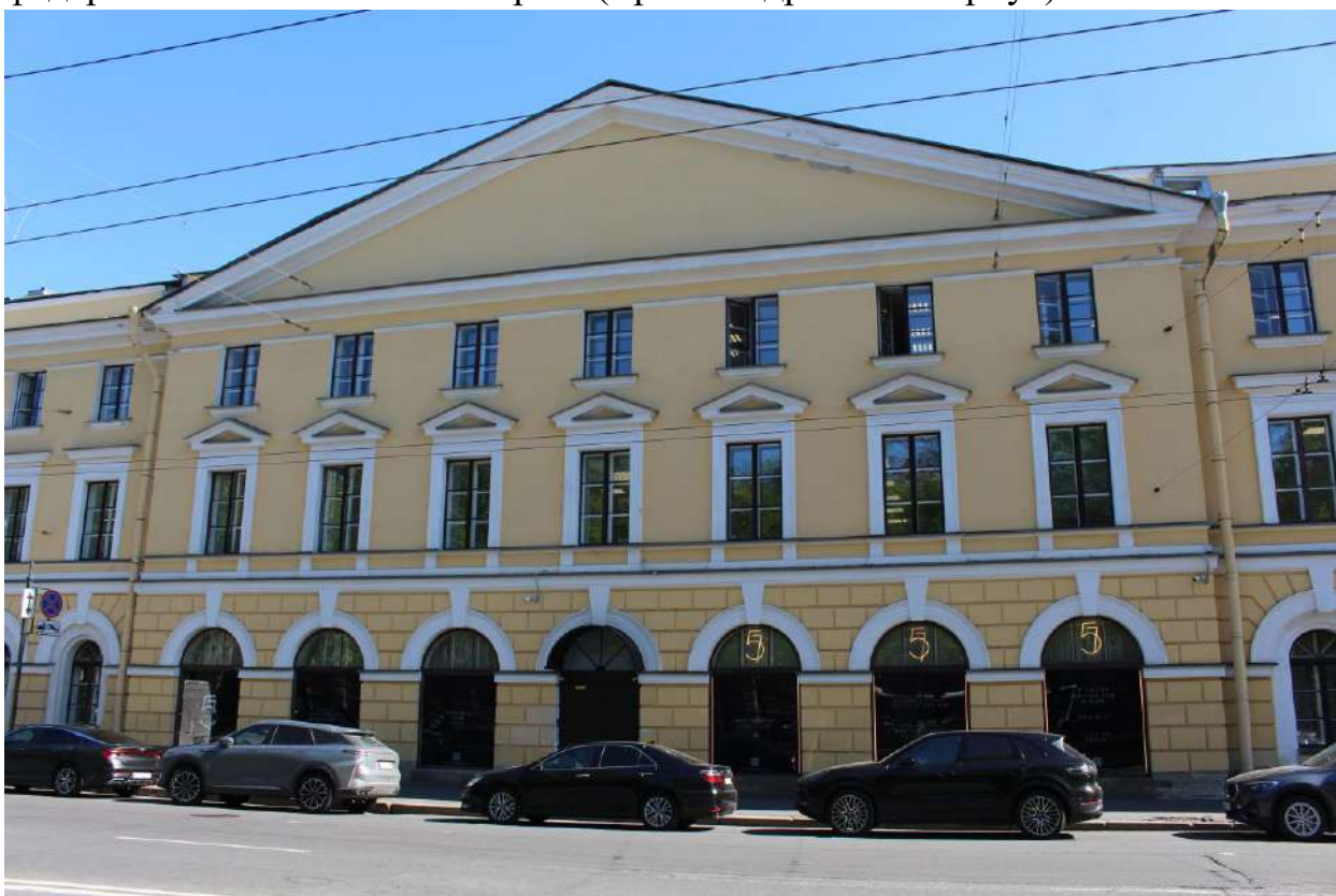
26. Вид на северо-западный фасад объекта культурного наследия федерального значения «Казармы (Трехэскадронный корпус)».
