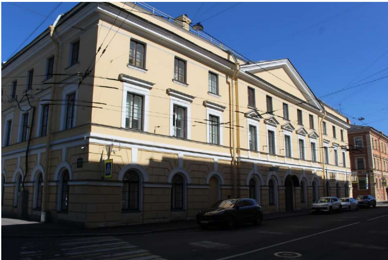
17. Вид на юго-западный фасад объекта культурного наследия федерального значения «Казармы (Трехэскадронный корпус)».
