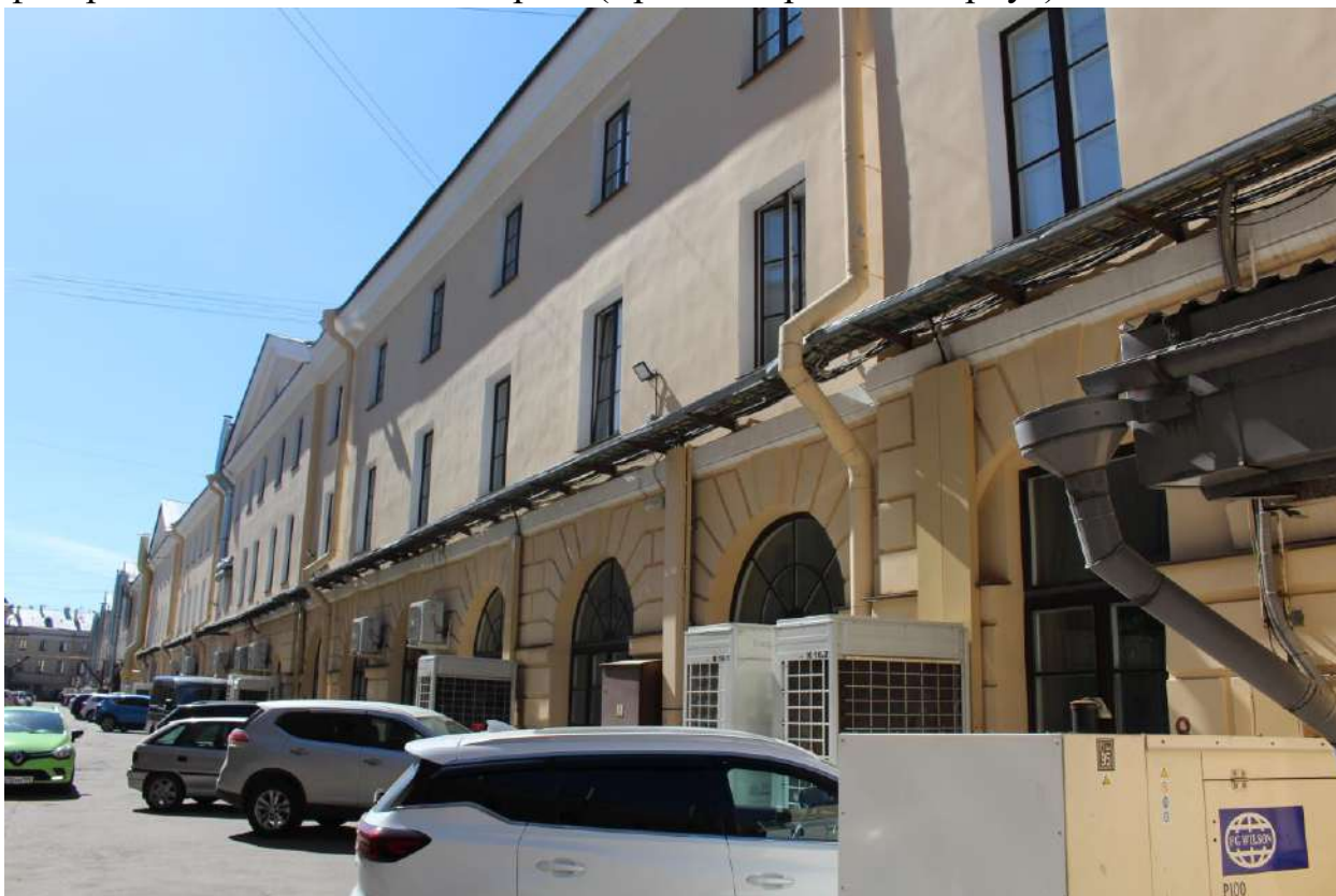
39. Вид на северо-западный дворовый фасад объекта культурного наследия федерального значения «Казармы (Трехэскадронный корпус)».
