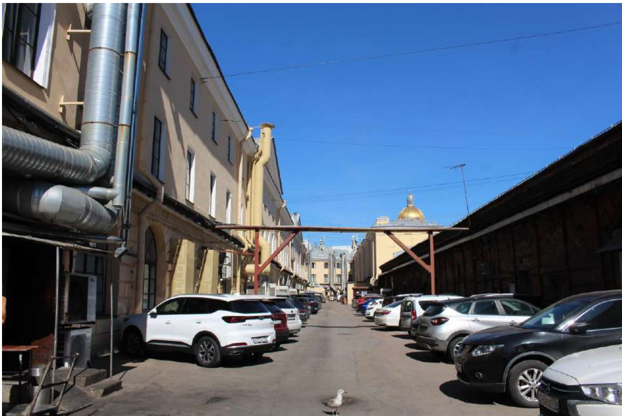
52. Дворовые фасады объекта культурного наследия федерального значения «Казармы (Трехэскадронный корпус)», вид из центра двора на северо-восток.
