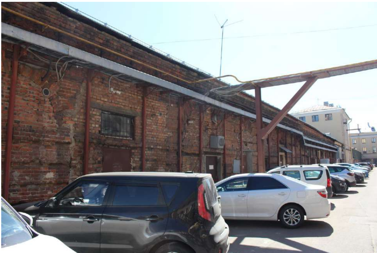
48. Вид на юго-восточный дворовый фасад объекта культурного наследия федерального значения «Казармы (Трехэскадронный корпус)».
