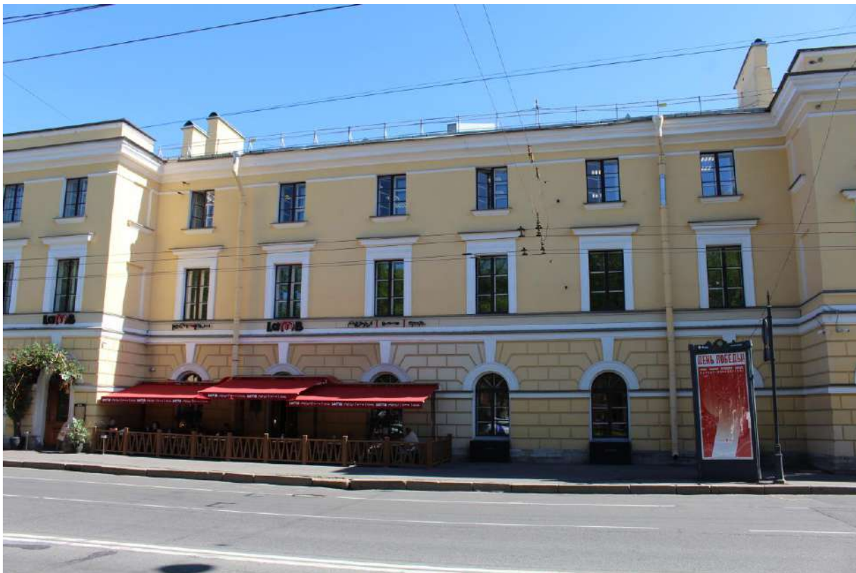
21. Вид на северо-западный фасад объекта культурного наследия федерального значения «Казармы (Трехэскадронный корпус)».
