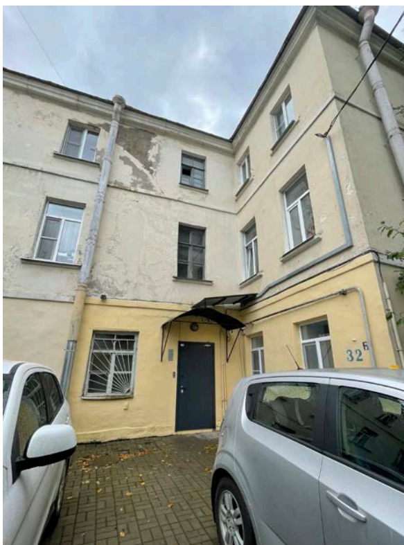
Фото 9. Фрагмент дворового фасада выявленного объекта культурного наследия «Дом Бахов»
