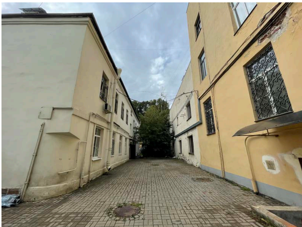
Фото 5. Фрагмент дворового фасада выявленного объекта культурного наследия «Дом Бахов»
