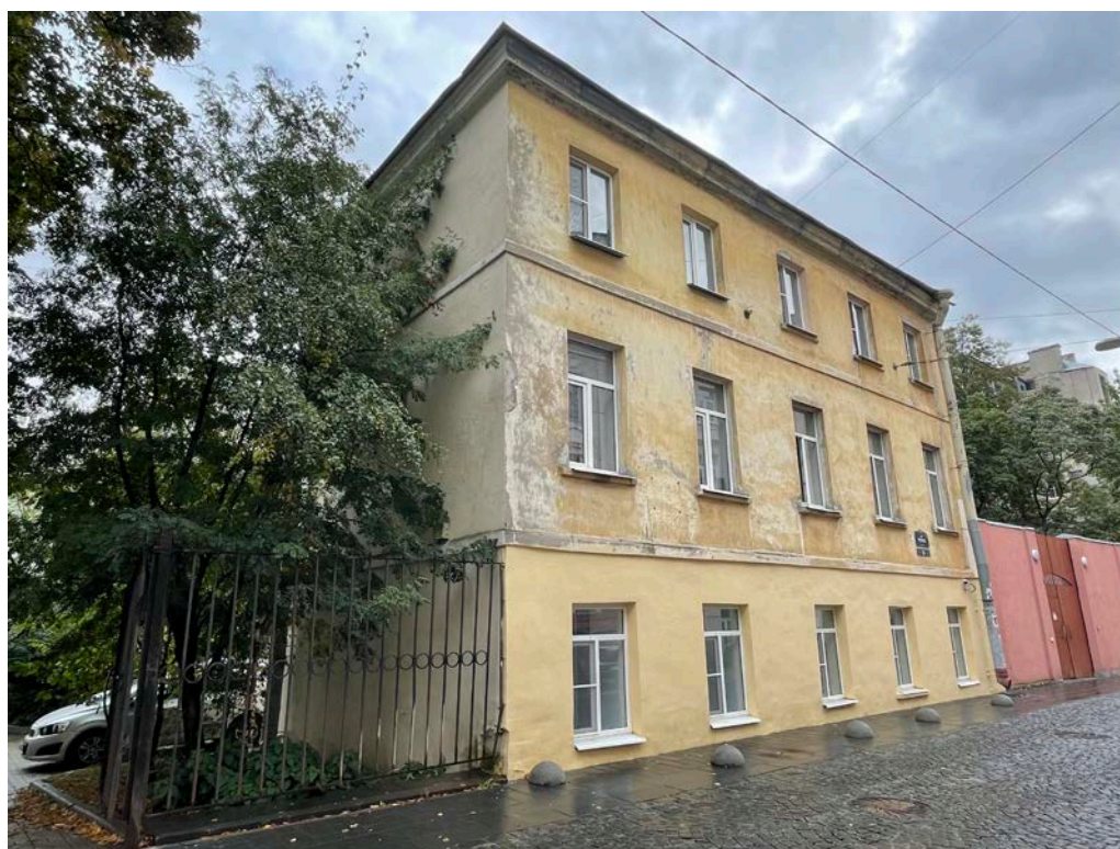
Фото 8. Фрагмент дворового фасада выявленного объекта культурного наследия «Дом Бахов»
