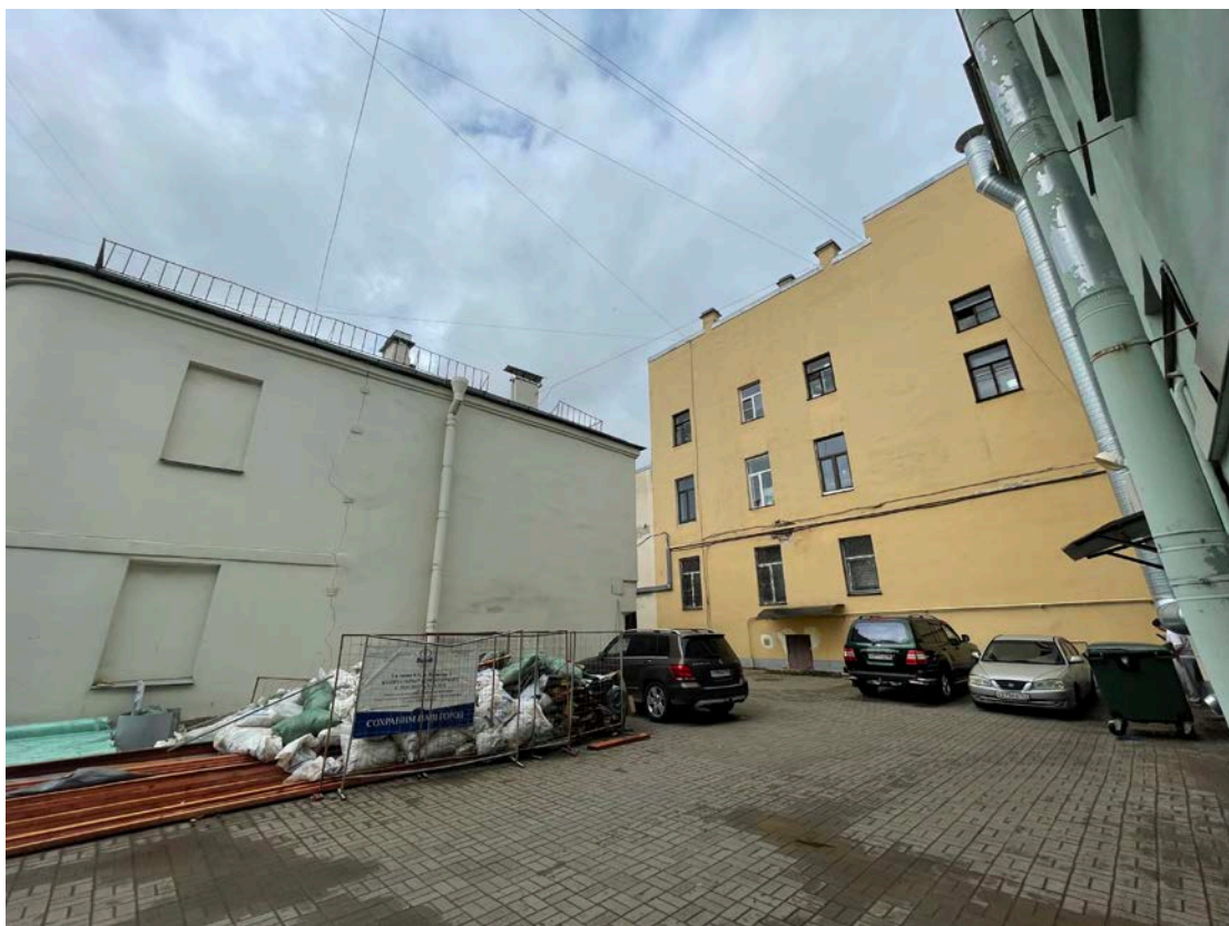
Фото 3. Фрагмент дворового фасада выявленного объекта культурного наследия «Дом Бахов»
