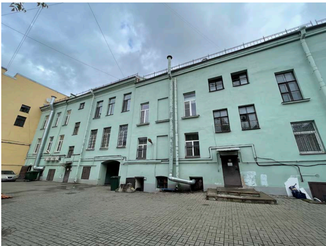
Фото 11. Фрагмент дворового фасада выявленного объекта культурного наследия «Дом Бахов»
