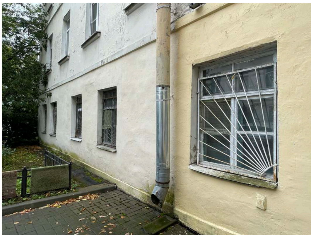
Фото 10/ Фрагмент дворового фасада выявленного объекта культурного наследия «Дом Бахов»
