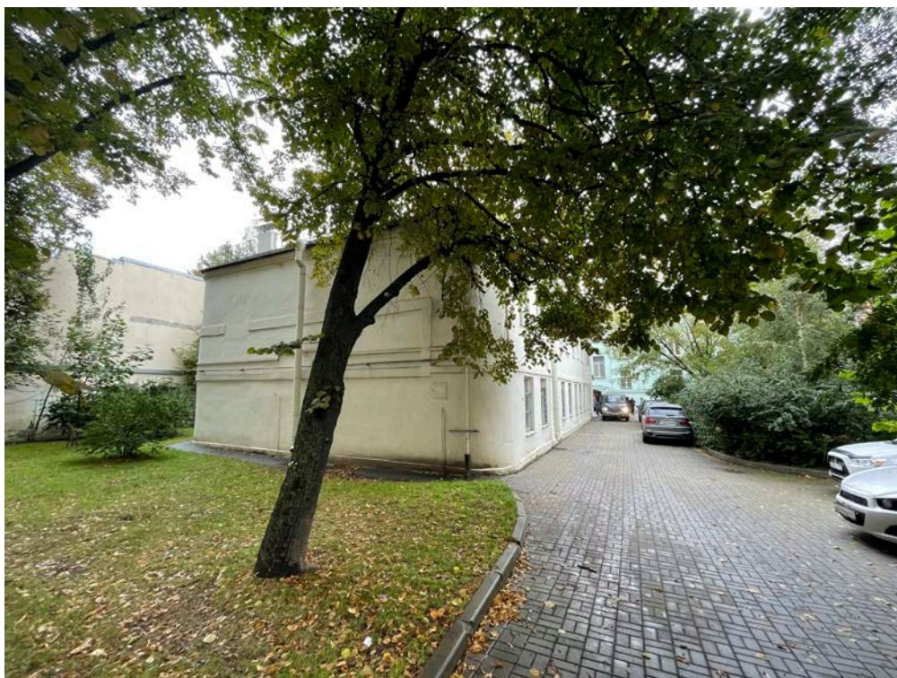
Фото 7. Фрагмент дворового фасада выявленного объекта культурного наследия «Дом Бахов»
