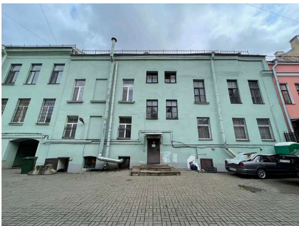
Фото 12. Фрагмент дворового фасада выявленного объекта культурного наследия «Дом Бахов»
