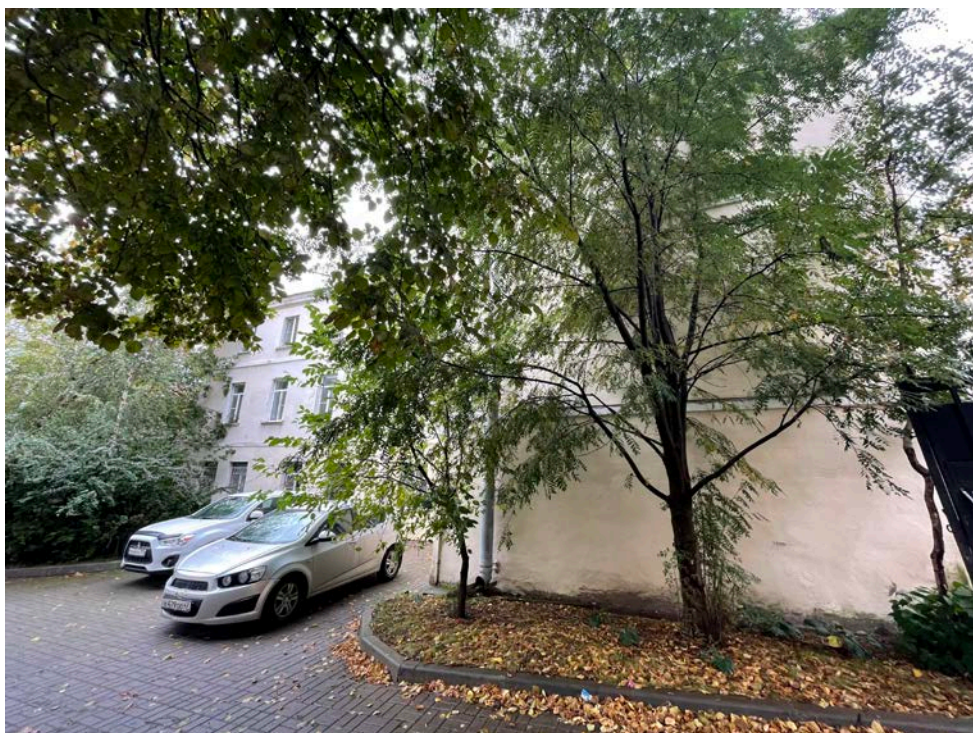
Фото 6. Фрагмент дворового фасада выявленного объекта культурного наследия «Дом Бахов»
