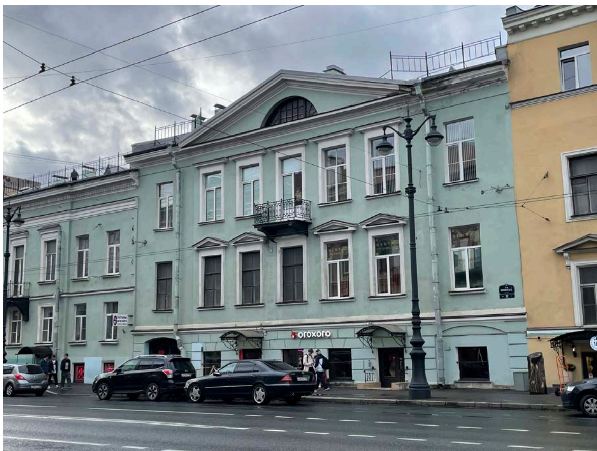
Фото 2. Лицевой фасад выявленного объекта культурного наследия «Дом Бахов»
