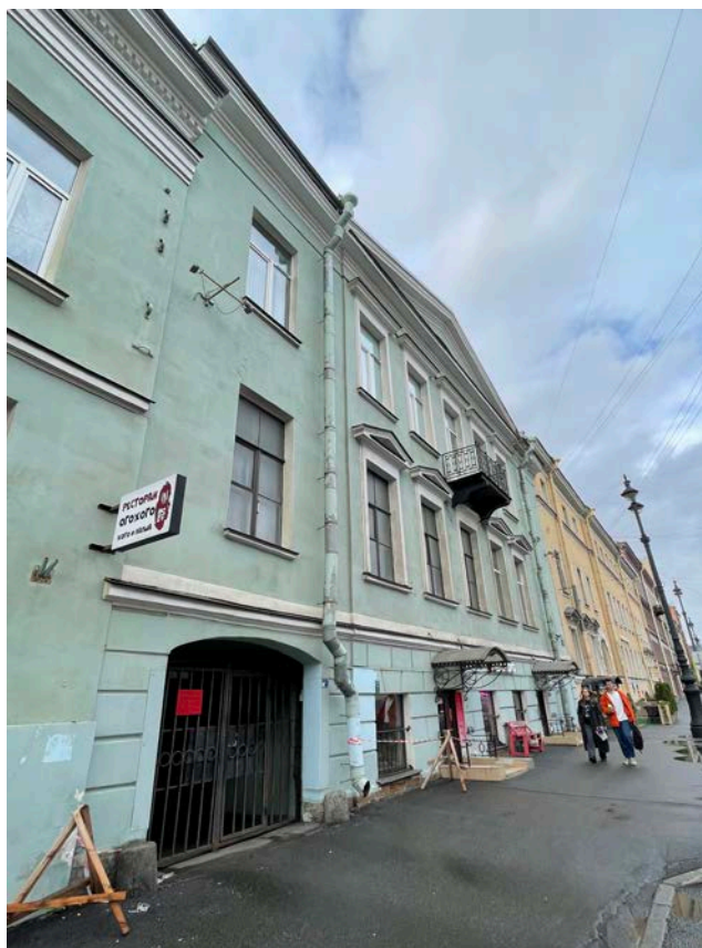
Фото 1. Лицевой фасад выявленного объекта культурного наследия «Дом Бахов»
