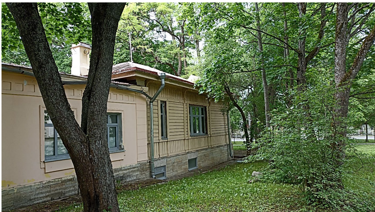
5. Вид на восточную часть южного фасада, вид с юго-запада.
