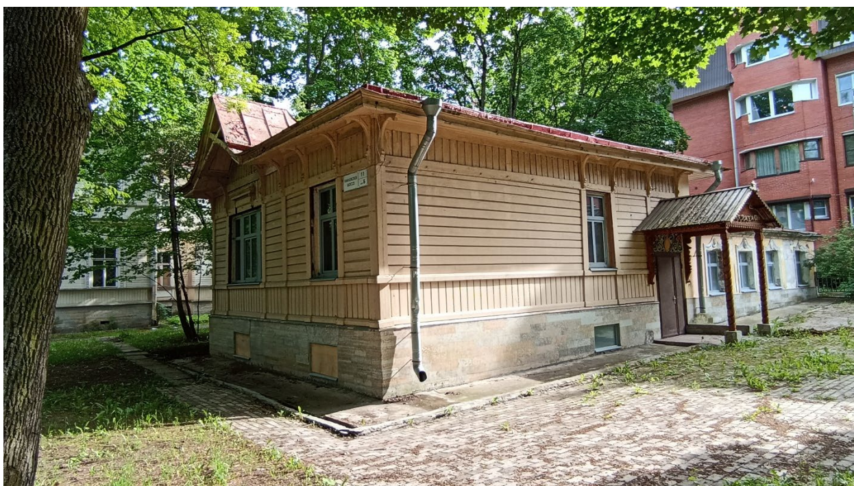
17. Вид на северный и западный фасады здания с северо-востока.
