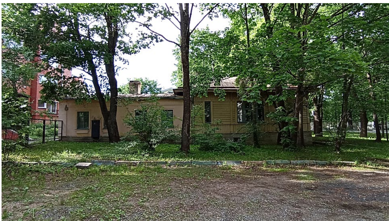
22. Вид на южный фасад здания с юга.
