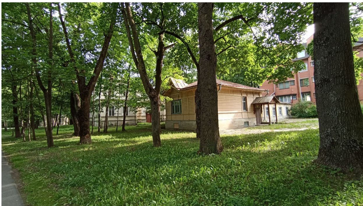
16. Общий вид на здание с северо-востока.
