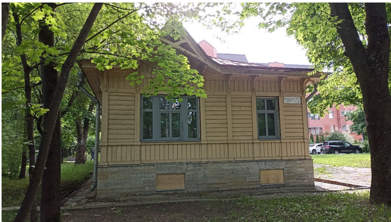
18. Вид на восточный фасад здания с востока.
