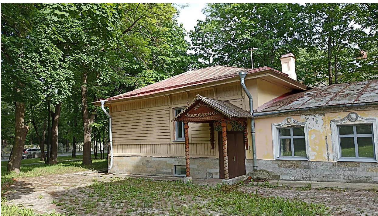
10. Вид на северный фасад деревянной части здания с юго-запада.
