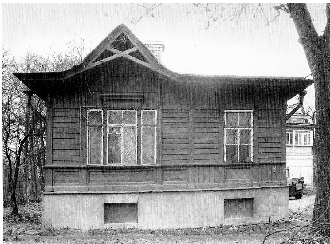
13. Восточный фасад жилого флигеля бывшей усадьбы Н.С. Чавчавадзе. Фото 1990-х гг.
