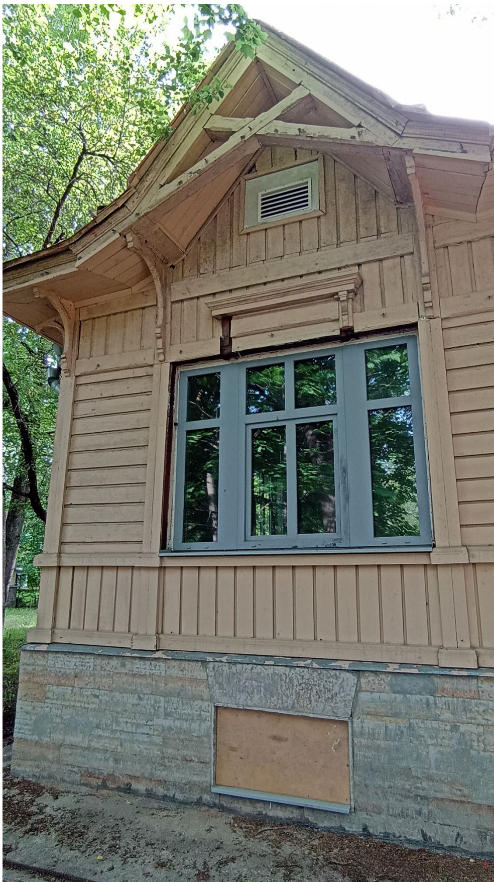
20. Южная часть восточного фасада.
