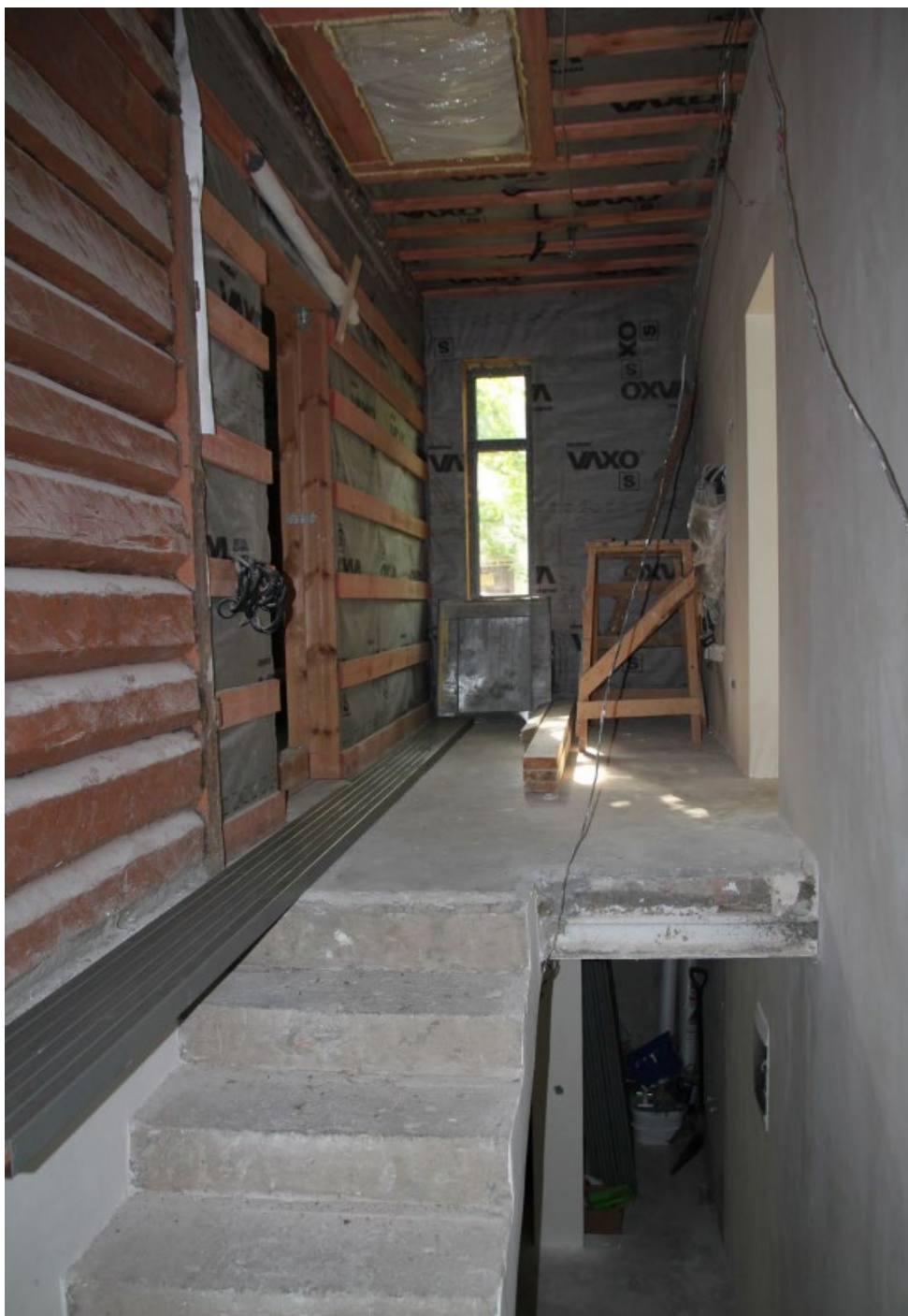
24. Помещение 109. Внутреннее помещение главного входа, современная железобетонная лестница.
