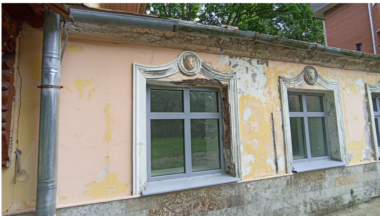
12. Восточная часть северного фасада кирпичной части здания, вид с северо-востока.
