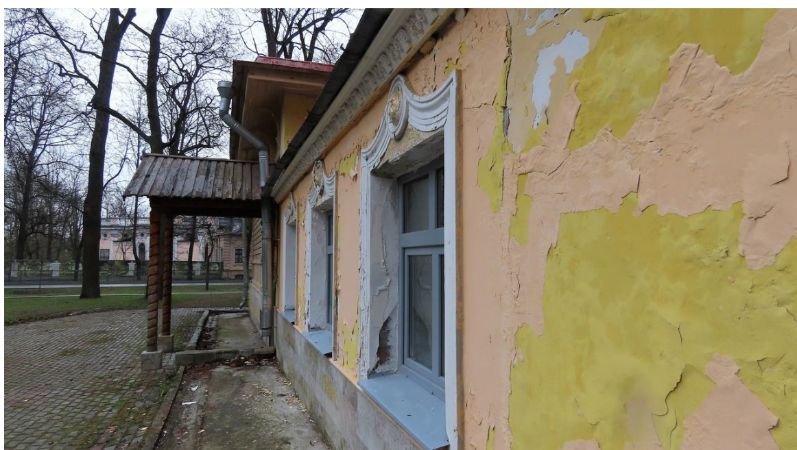
15. Флигель, северный фасад, вид с запада. Фото 2012 г. https://www.citywalls.ru/house18288.html
