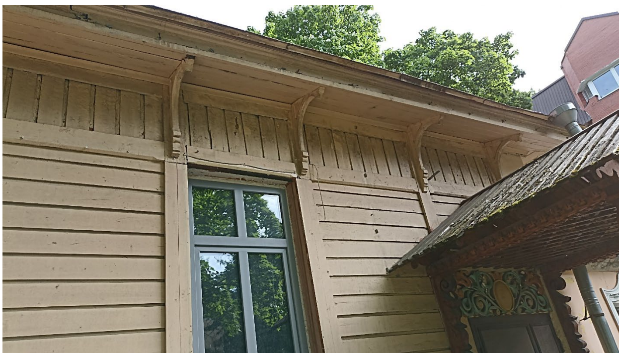
14. Фрагмент северного фасада деревянной части здания.
