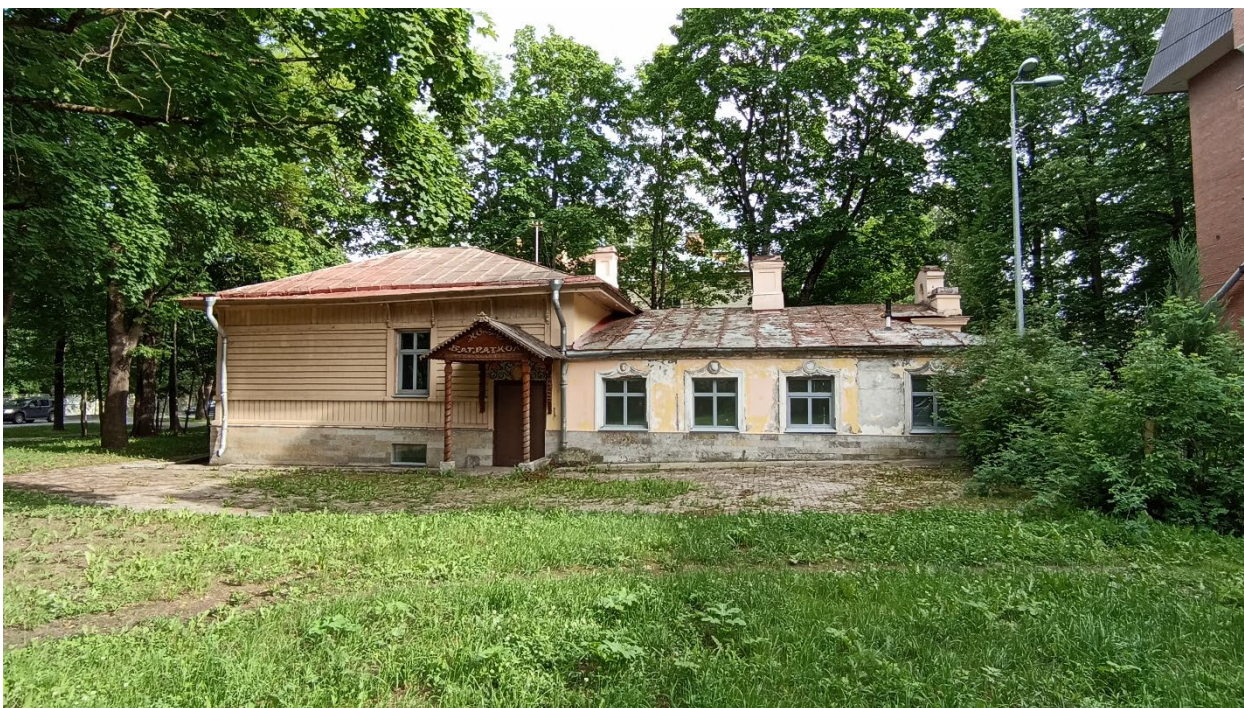
8. Общий вид на северный фасад здания с севера.
