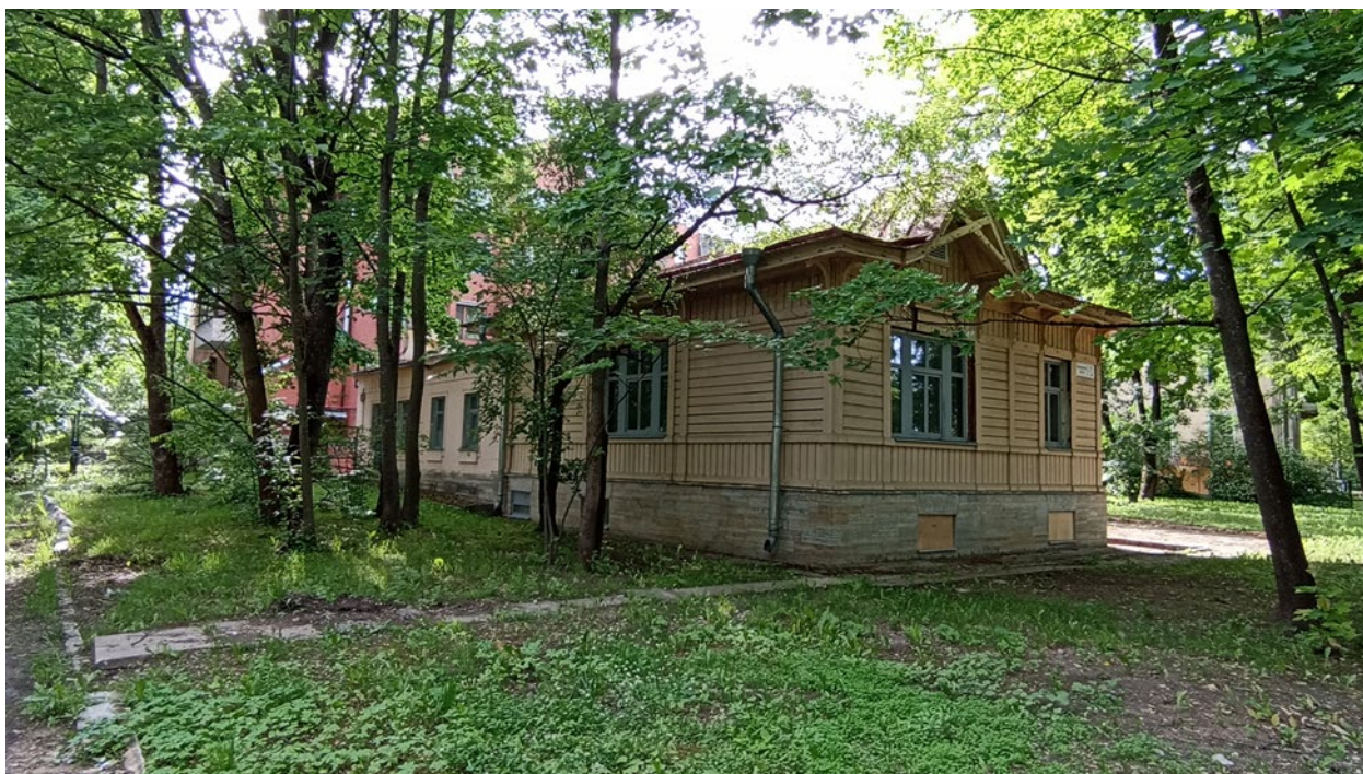
21. Вид на здание с юго-востока.
