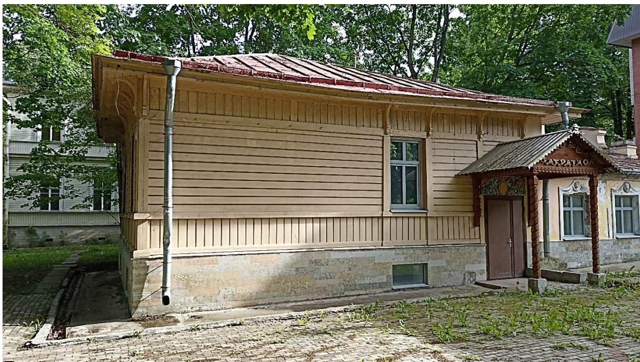
13. Вид на северный фасад деревянной части здания с северо-востока.
