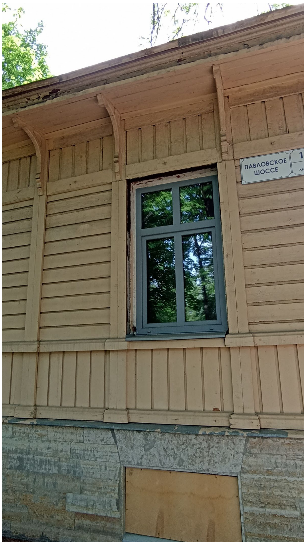
19. Северная часть восточного фасада.
