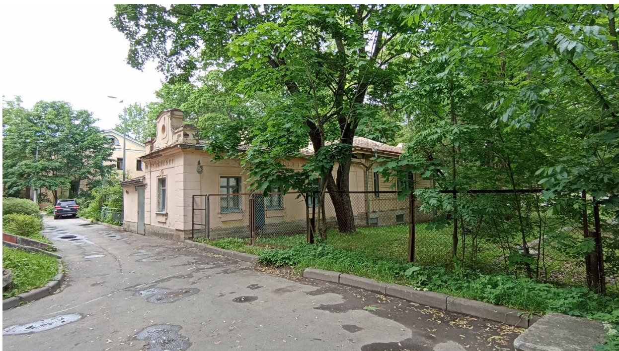
3. Вид на здание с юго-востока.
