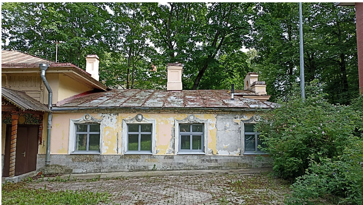
11. Вид на северный фасад кирпичной части здания с севера.
