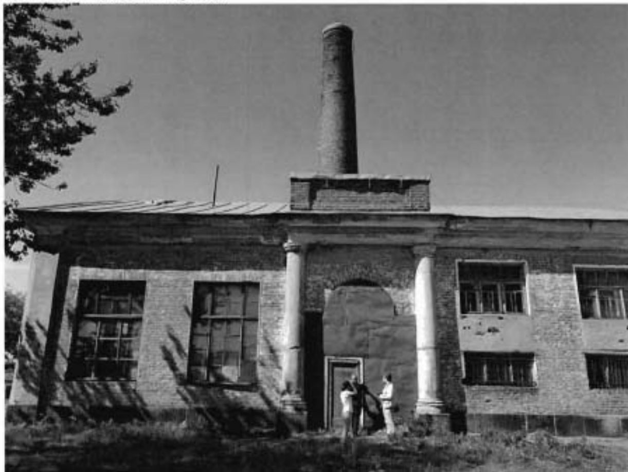
10. Котельная (восточный фасад).
