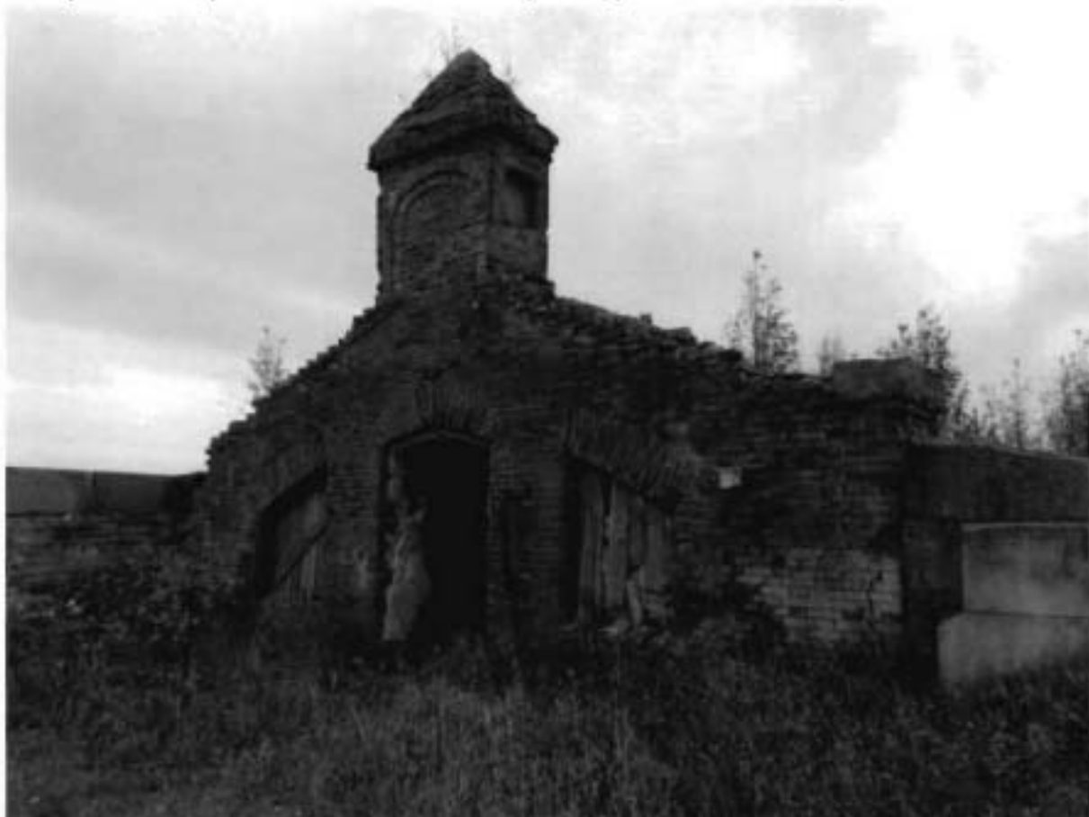
16. Кухня и пекарня. Лицевой восточный фасад (фото от 05.10.2021).
