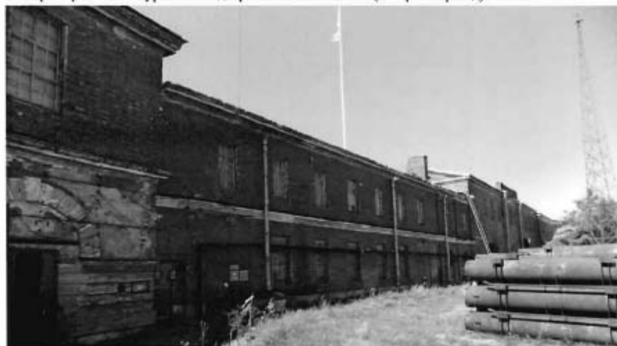
5. Правофланговая куртина с надстроенными объемами (северный фасад).
