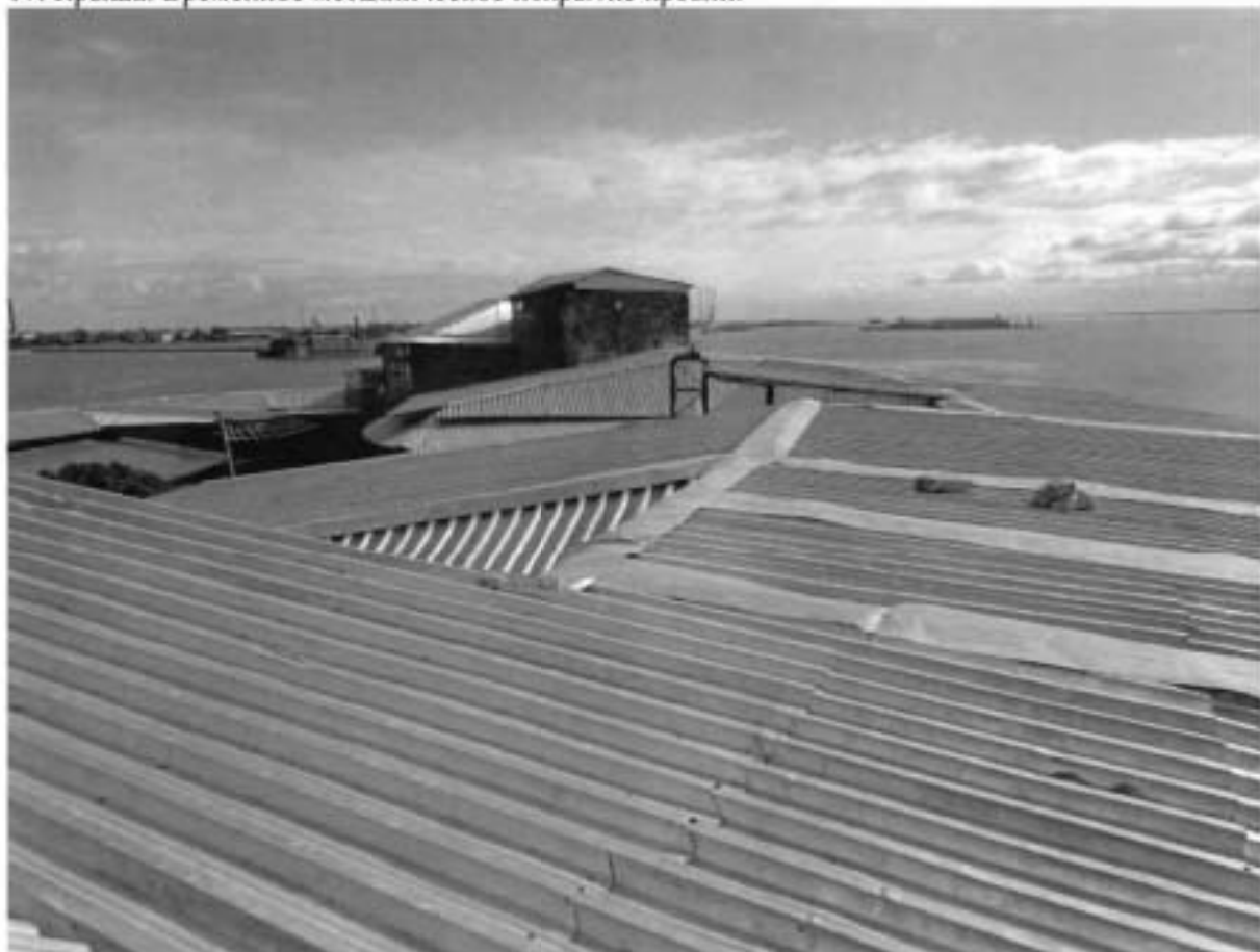
18. Крыша. Временное металлическое покрытие кровли и полубашня.
