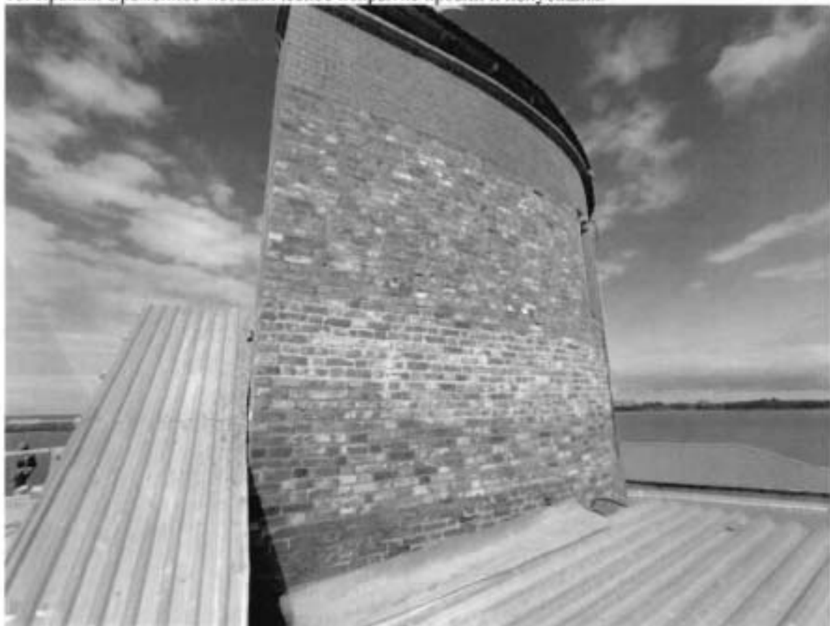
18. Крыша. Временное металлическое покрытие кровли и полубашня.
