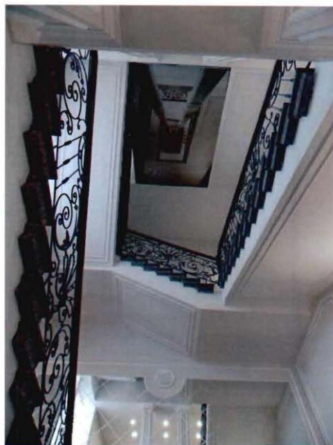
5. Лестница в северной части объекта культурного наследия.
