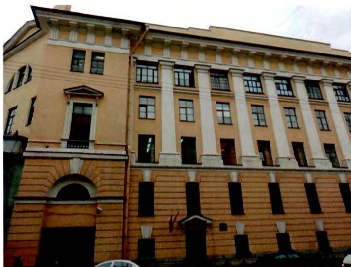
1. Фрагмент южного фасада.
