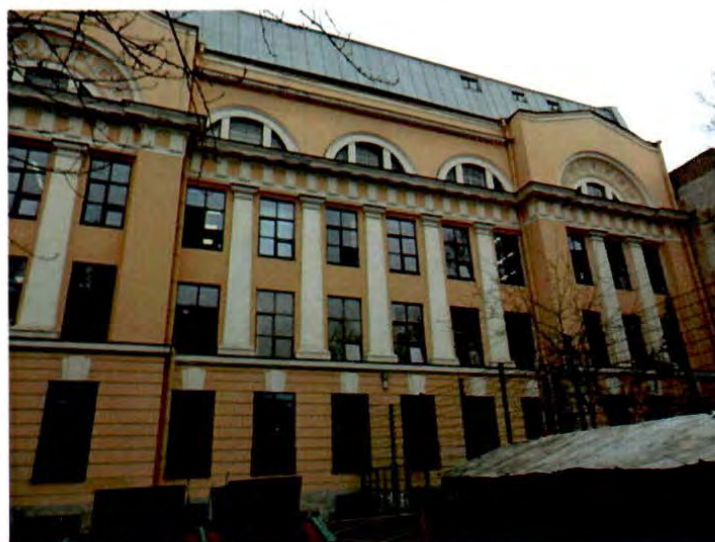
2. Фрагмент северного фасада.
