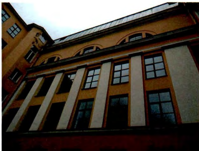
3. Фрагмент дворового фасада.
