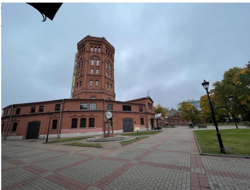
Фото 6. Вид на объект культурного наследия регионального значения «Водонапорная башня с машинным отделением и котельной», входящий в состав объекта культурного наследия регионального значения «Комплекс главной станции Санкт-Петербургских городских водопроводов»
