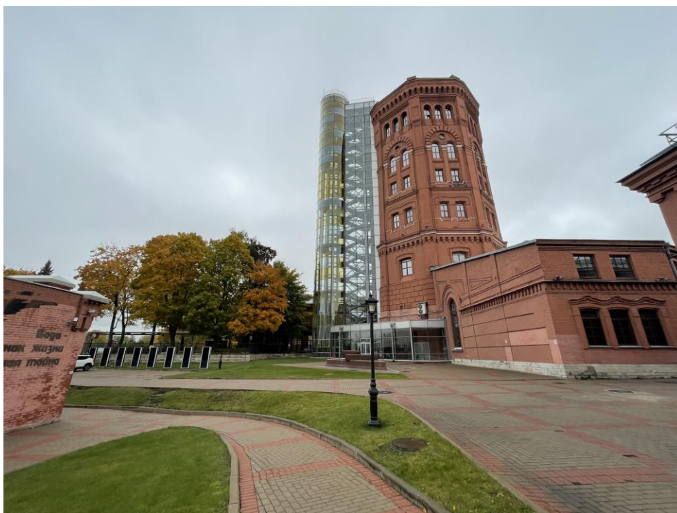
Фото 7. Вид на объект культурного наследия регионального значения «Водонапорная башня с машинным отделением и котельной», входящий в состав объекта культурного наследия регионального значения «Комплекс главной станции Санкт-Петербургских городских водопроводов»
