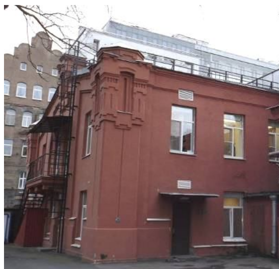
Фрагмент западного и северного фасадов северного корпуса
