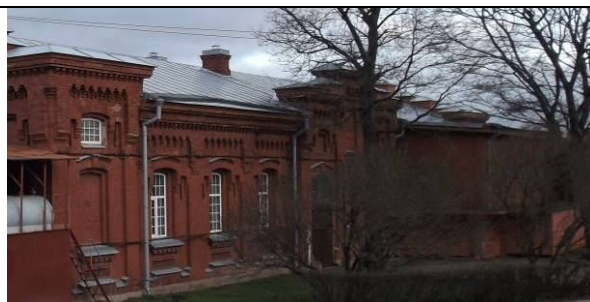
Южный фасад юго-западного корпуса
