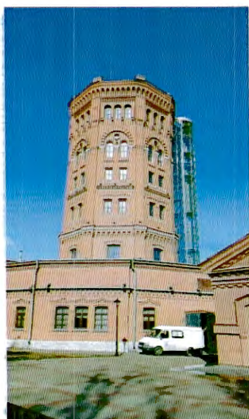
2. Общий вид с восточной стороны фасада
