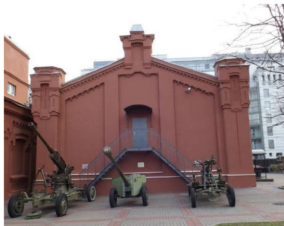
Западный фасад южного корпуса
