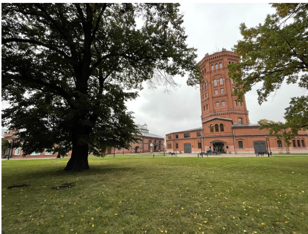
Фото 2. Вид на объект культурного наследия регионального значения «Водонапорная башня с машинным отделением и котельной», входящий в состав объекта культурного наследия регионального значения «Комплекс главной станции Санкт-Петербургских городских водопроводов»
