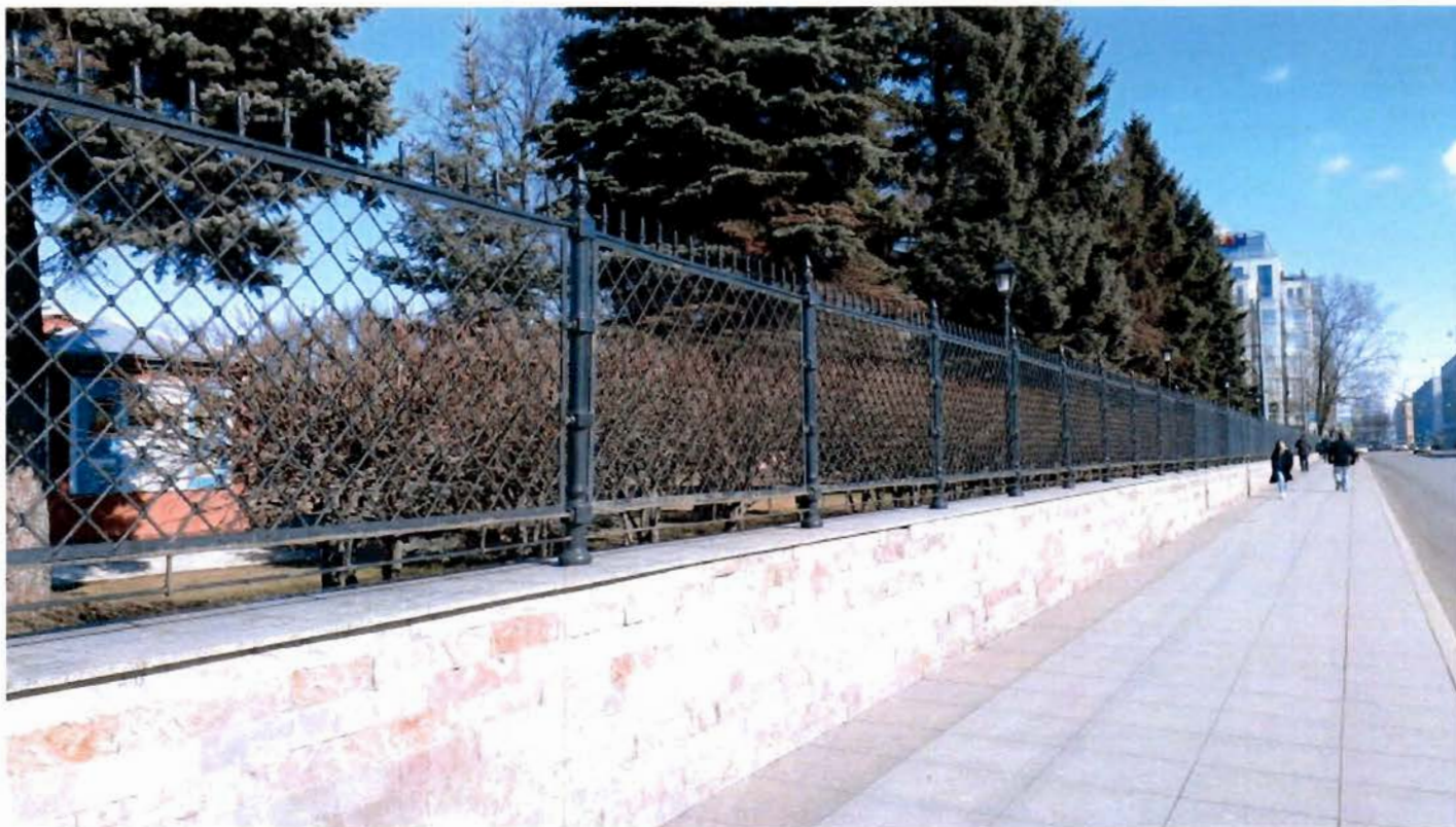
10. Кованая ограда на цоколе, облицованном известняковыми плитами
