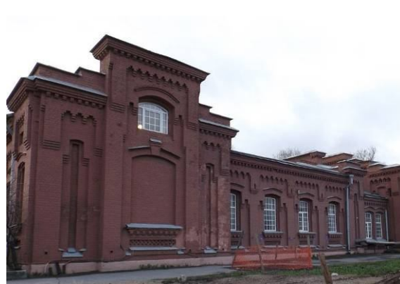
Северный фасад северо-восточного корпуса
