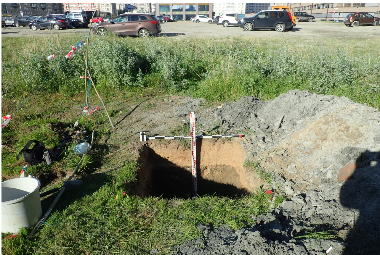
Рис. 19. Санкт-Петербург, Туристская улица, участок к/н 78:34:0004155:1. Шурф 1. Выкопанный шурф с включением окружающего пейзажа. Вид с Ю.
