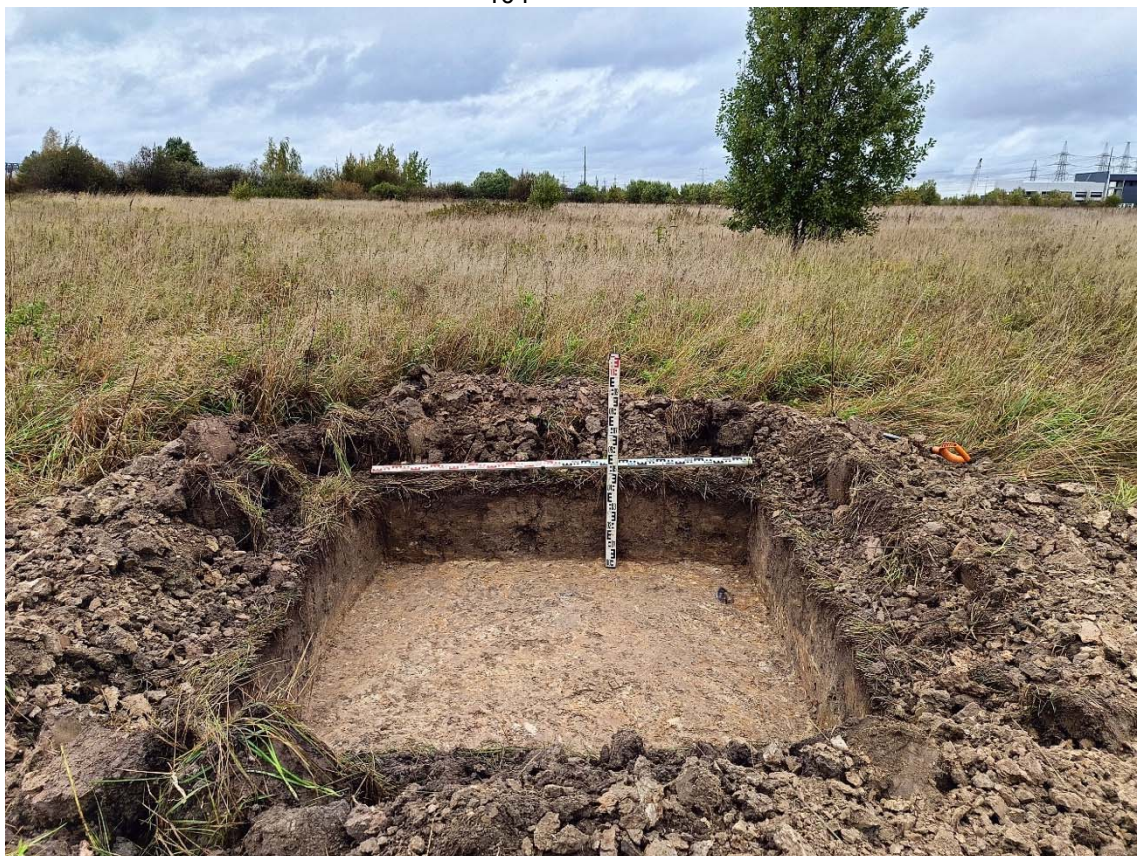
Рис. 33. СПб, Шушары-2024. КН: 78:42:0018326:366. Шурф 1, фиксация по уровню окончания работ, вид с юга.
