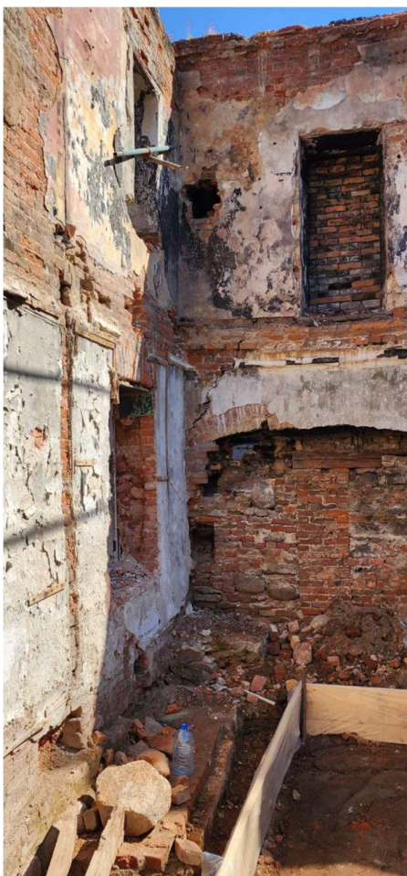
11. Объект культурного наследия регионального значения «Жилой дом» по адресу: Санкт-Петербург, г. Ломоносов, ш. Краснофлотское, д. 39, литера А 1 этаж. Фрагмент Дата съемки: 09.09.2024
