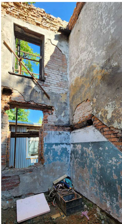
8. Объект культурного наследия регионального значения «Жилой дом» по адресу: Санкт-Петербург, г. Ломоносов, ш. Краснофлотское, д. 39, литера А 1 этаж. Фрагмент Дата съемки: 09.09.2024
