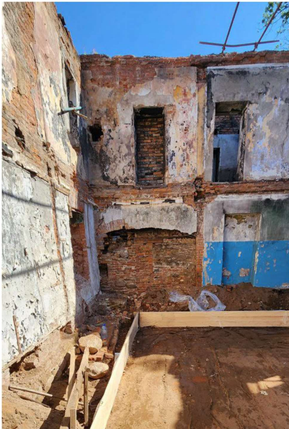
12. Объект культурного наследия регионального значения «Жилой дом» по адресу: Санкт-Петербург, г. Ломоносов, ш. Краснофлотское, д. 39, литера А 1 этаж. Фрагмент Дата съемки: 09.09.2024
