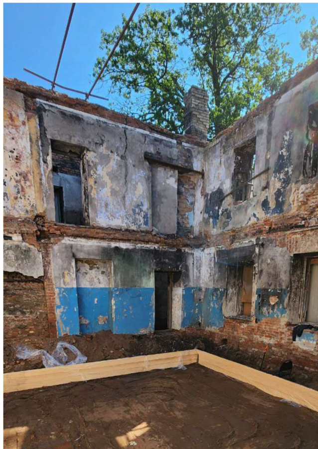
13. Объект культурного наследия регионального значения «Жилой дом» по адресу: Санкт-Петербург, г. Ломоносов, ш. Краснофлотское, д. 39, литера А 1 этаж. Фрагмент Дата съемки: 09.09.2024
