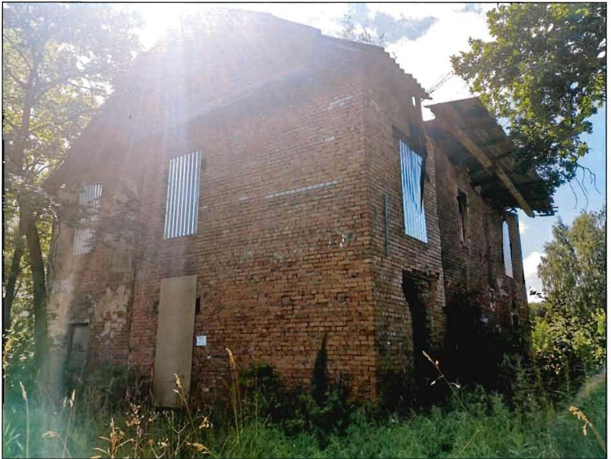
2. Общий вид на объект культурного наследия с северо-восточной стороны.
