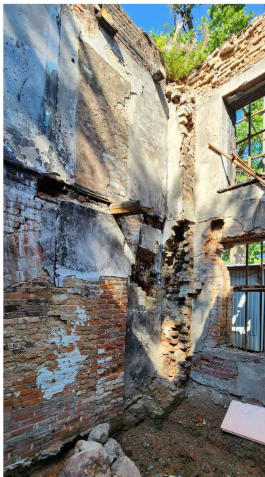
9. Объект культурного наследия регионального значения «Жилой дом» по адресу: Санкт-Петербург, г. Ломоносов, ш. Краснофлотское, д. 39, литера А 1 этаж. Фрагмент Дата съемки: 09.09.2024
