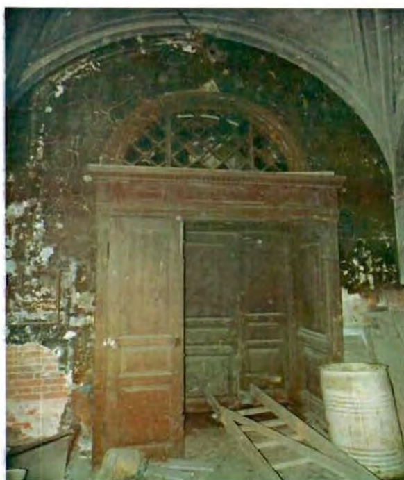
6. Тамбур главного входа.
