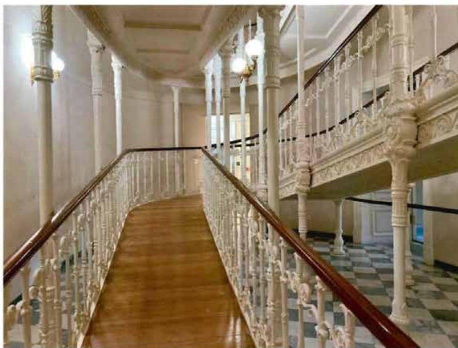
7. Помещение с пандусом объекта культурного наследия («Дворец»). Фото от 26.12.2022.
