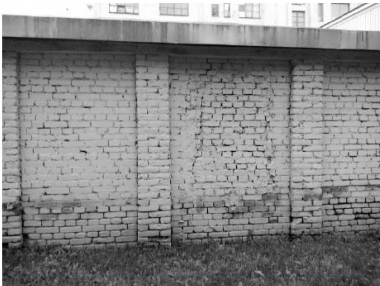
5. Северный фасад, следы закладки проёма.
