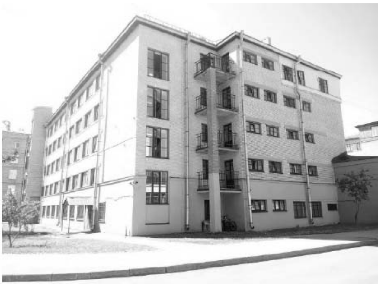
1. Общий вид с северо-востока.
