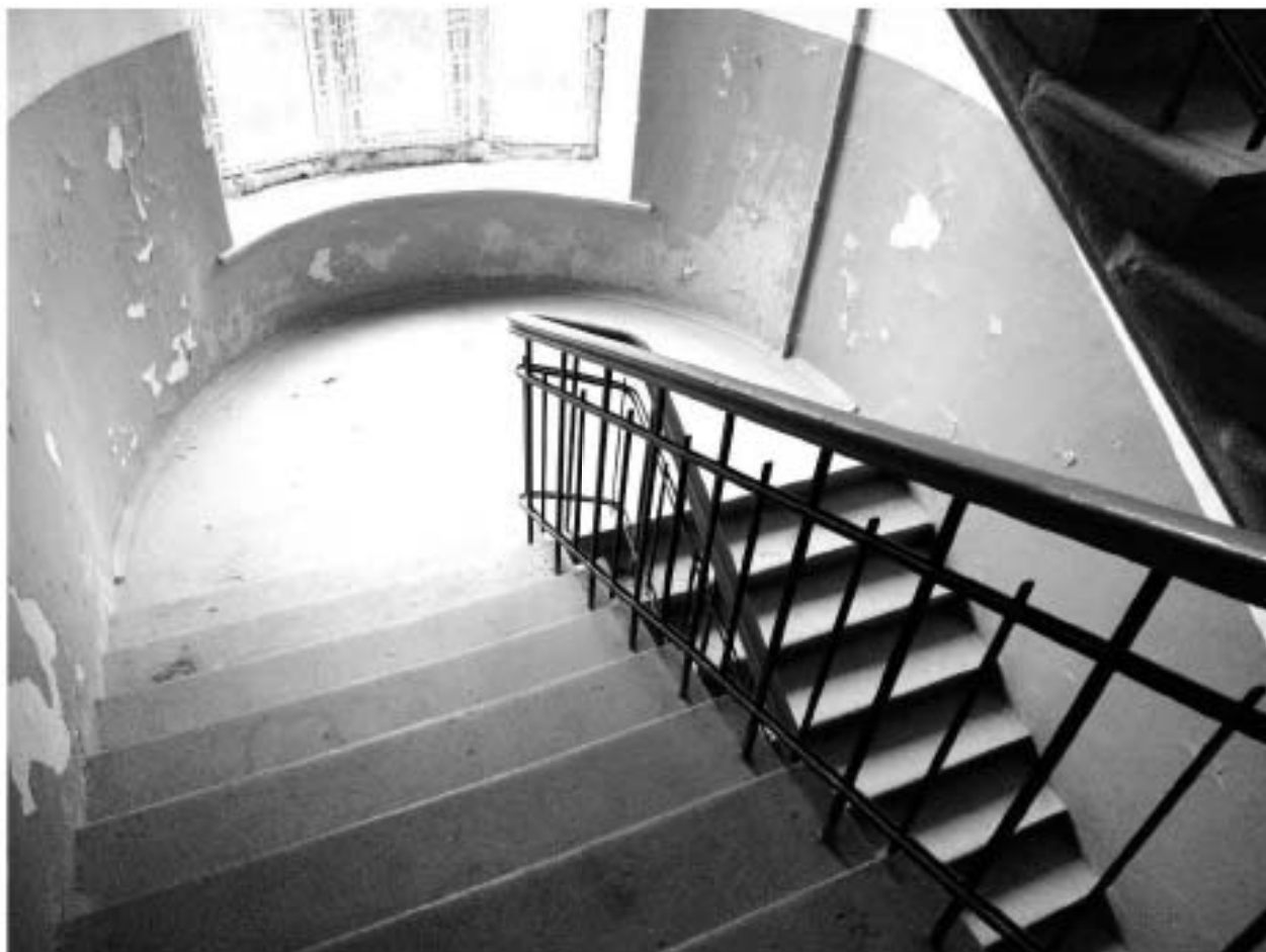
11. Южная лестница (ЛК). Общий вид с площадки 5 этажа.
