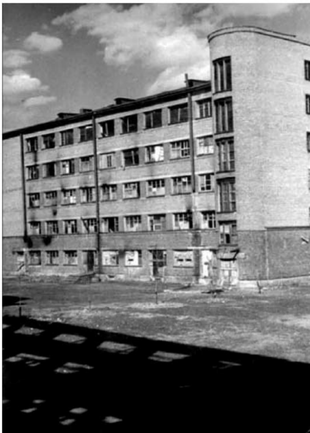
82. Корпус жилого городка Политехнического института. 1943-47 (?) Интернет-фотоархив Pastvu.com. URL: https://pastvu.com/p/140491
