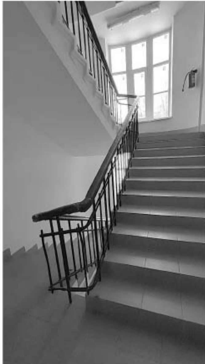
13. Лестница в северной части здания.
