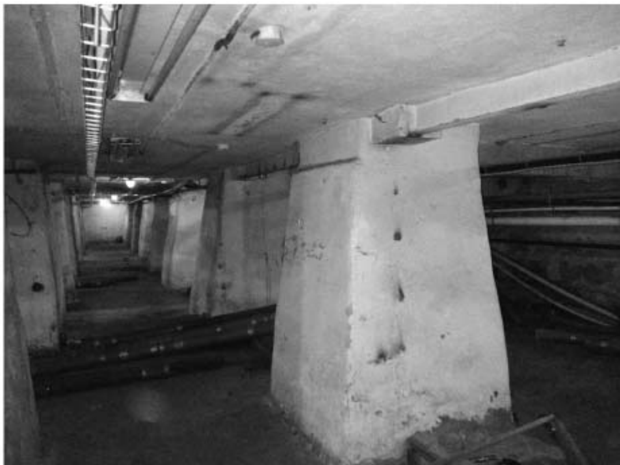
42. Южная часть корпуса. Подвал. Железобетонные опоры.
