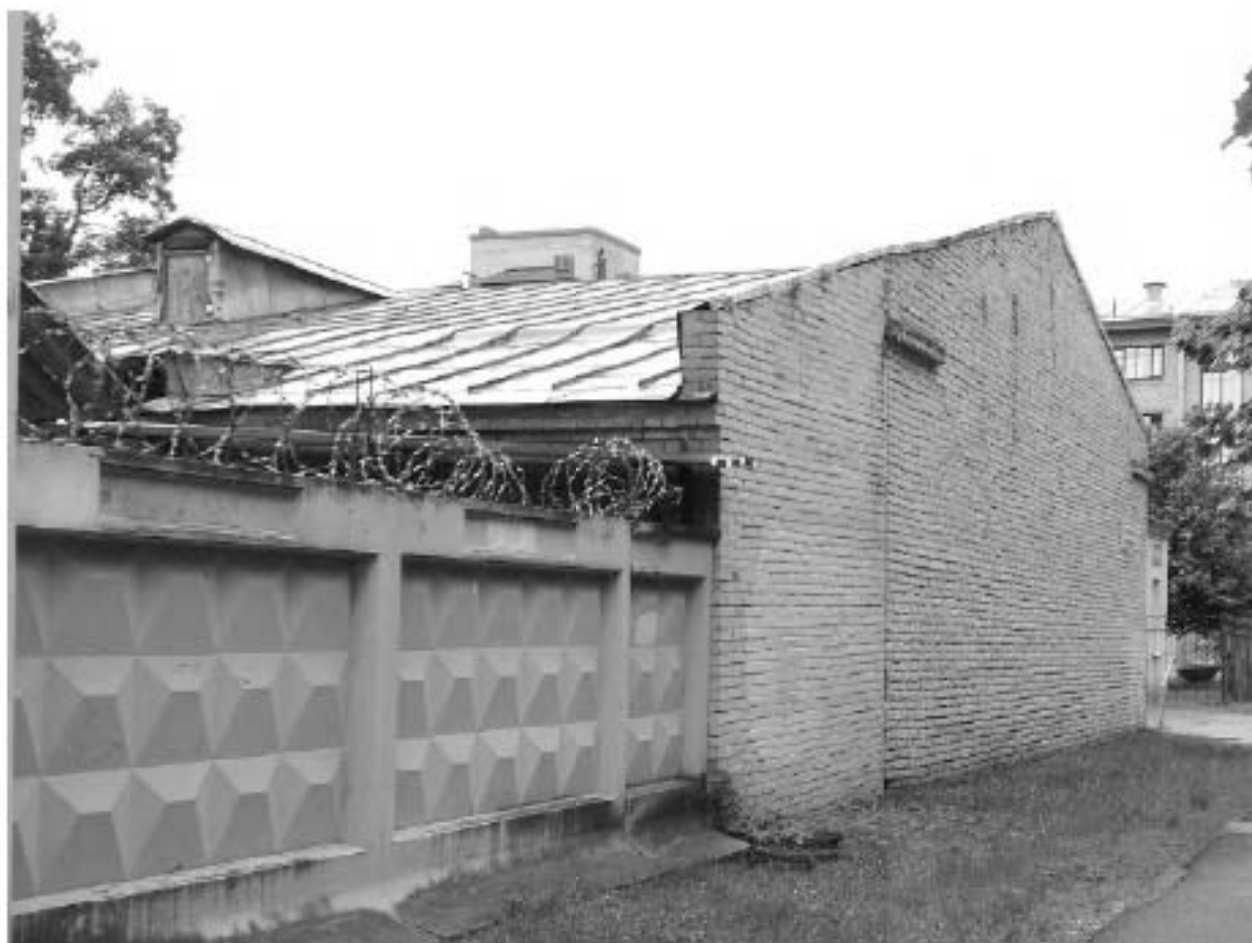
7. Северный фасад, вид с востока. Вертикальная линия – стык исторического объёма и поздней пристройки.
