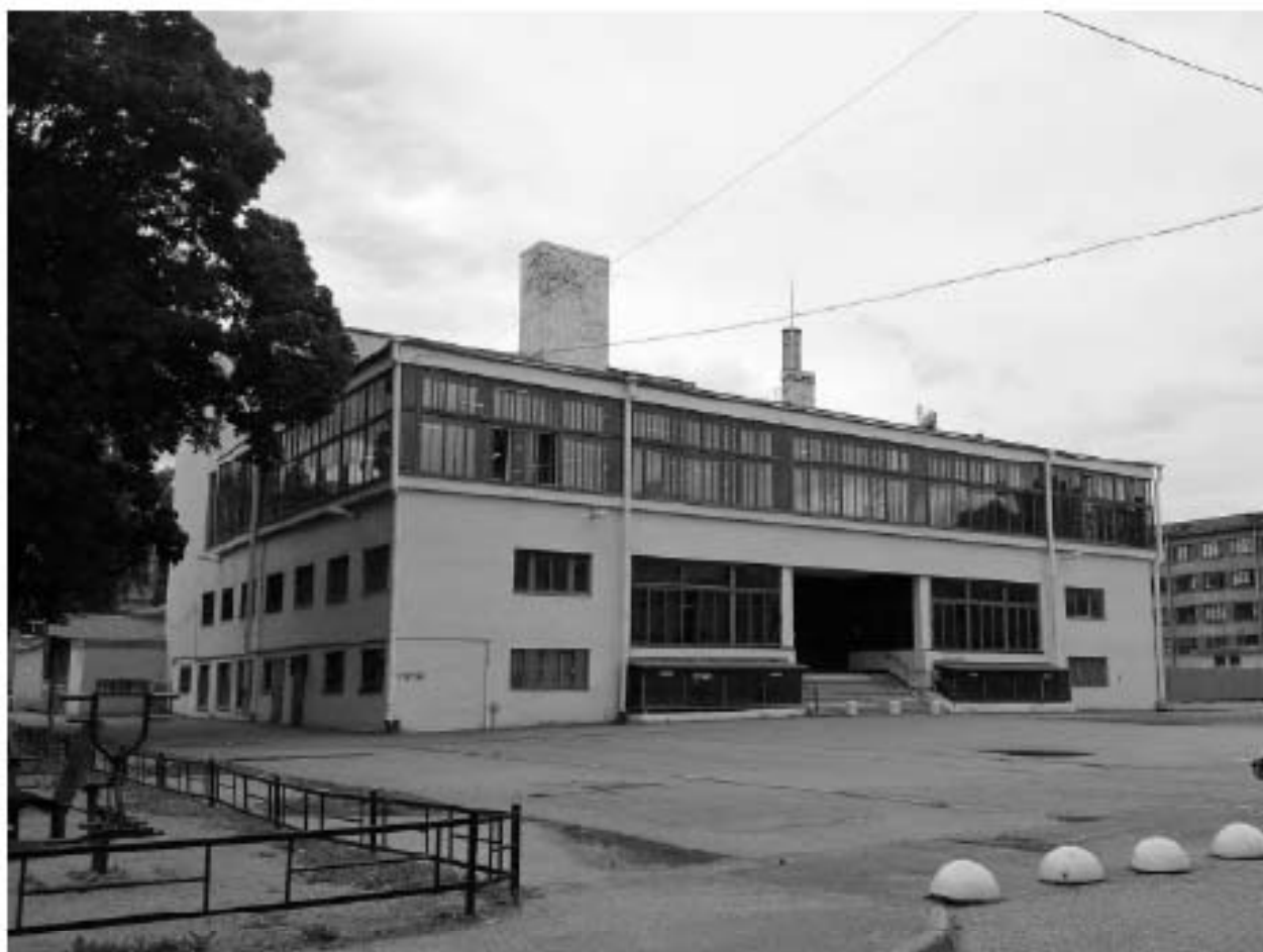
1. Общий вид здания – западный и южный фасады.
