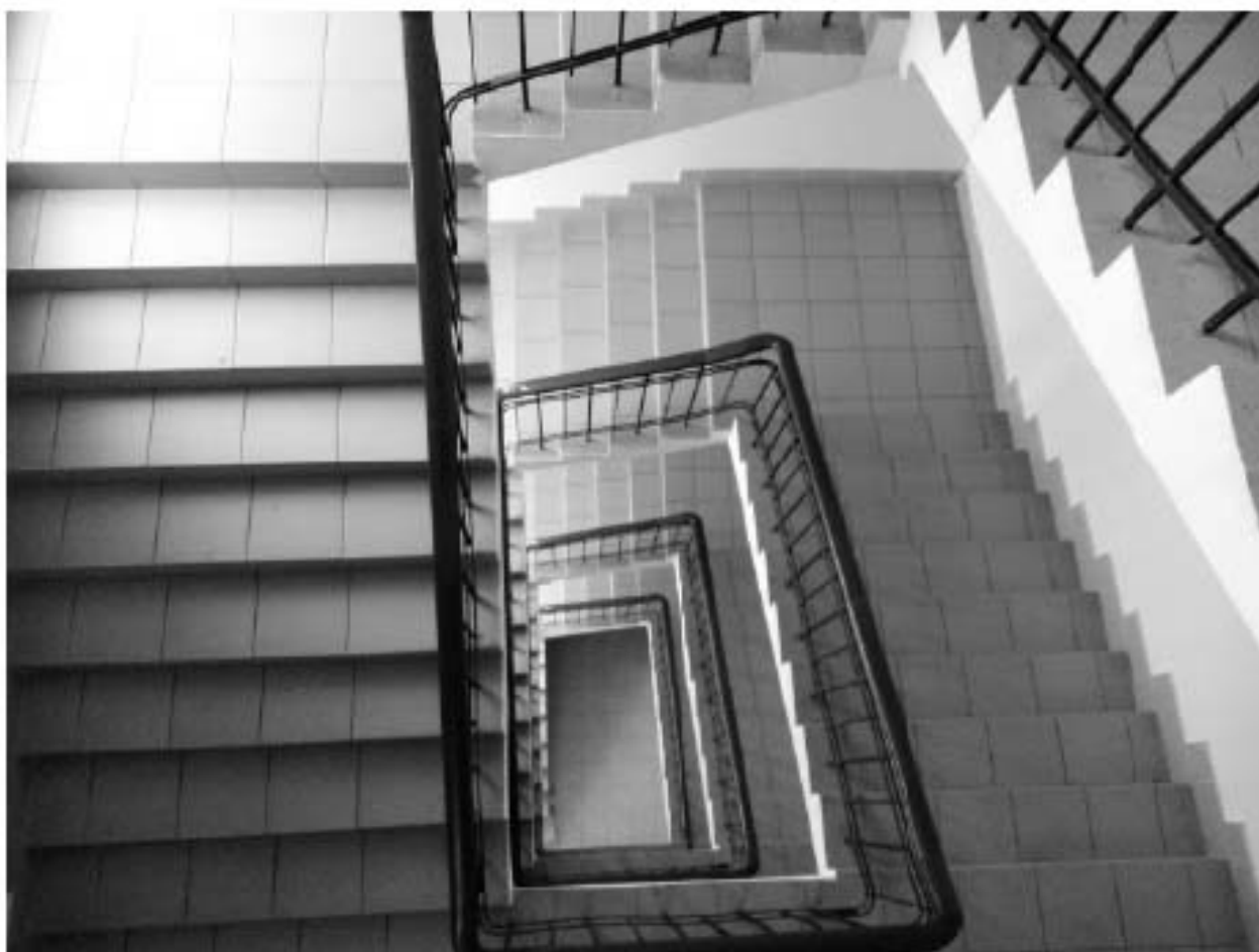
24. Южная лестница южного объема. Общий вид с площадки 4 этажа.
