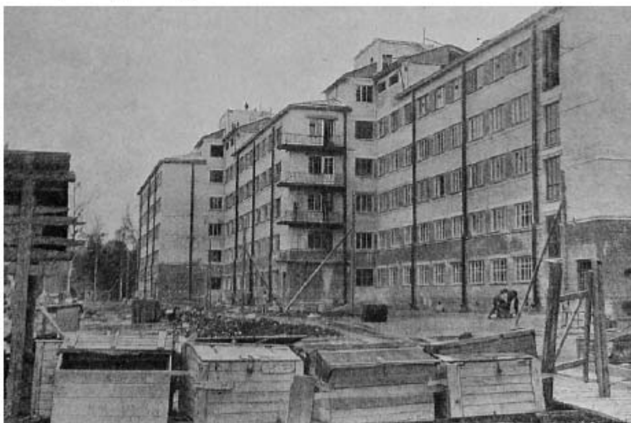
34. Постройка общежития для студентов Политехнического института. 1929-1931. Фото из альбома: "Ленинград на стройке" Л., 1931. Приводится по: интернет-фотоархив Pastvu.com. URL: https://pastvu.com/p/847143
