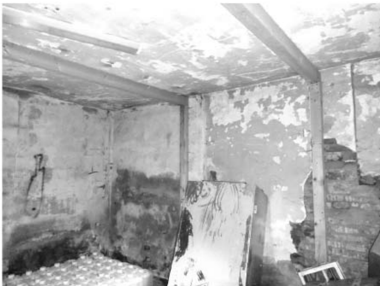
7. Помещение в восточной части постройки. Усиление перекрытий хозспособом.
