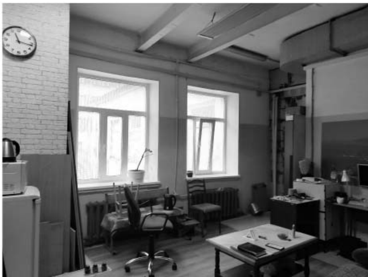
6. Помещение в восточной части здания, вид на запад. Перекрытие по металлическим балкам.
