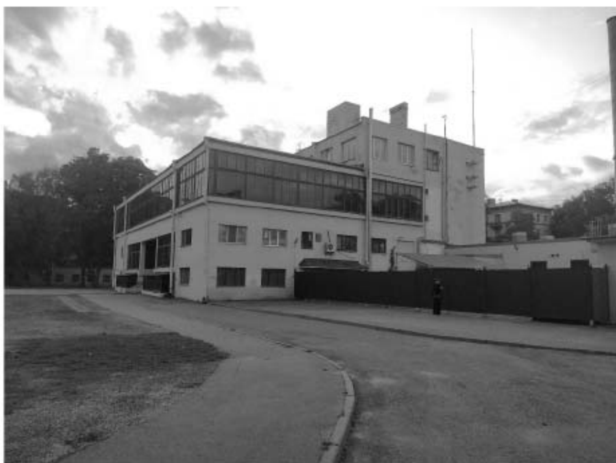
2. Общий вид здания – восточный и южный фасады.
