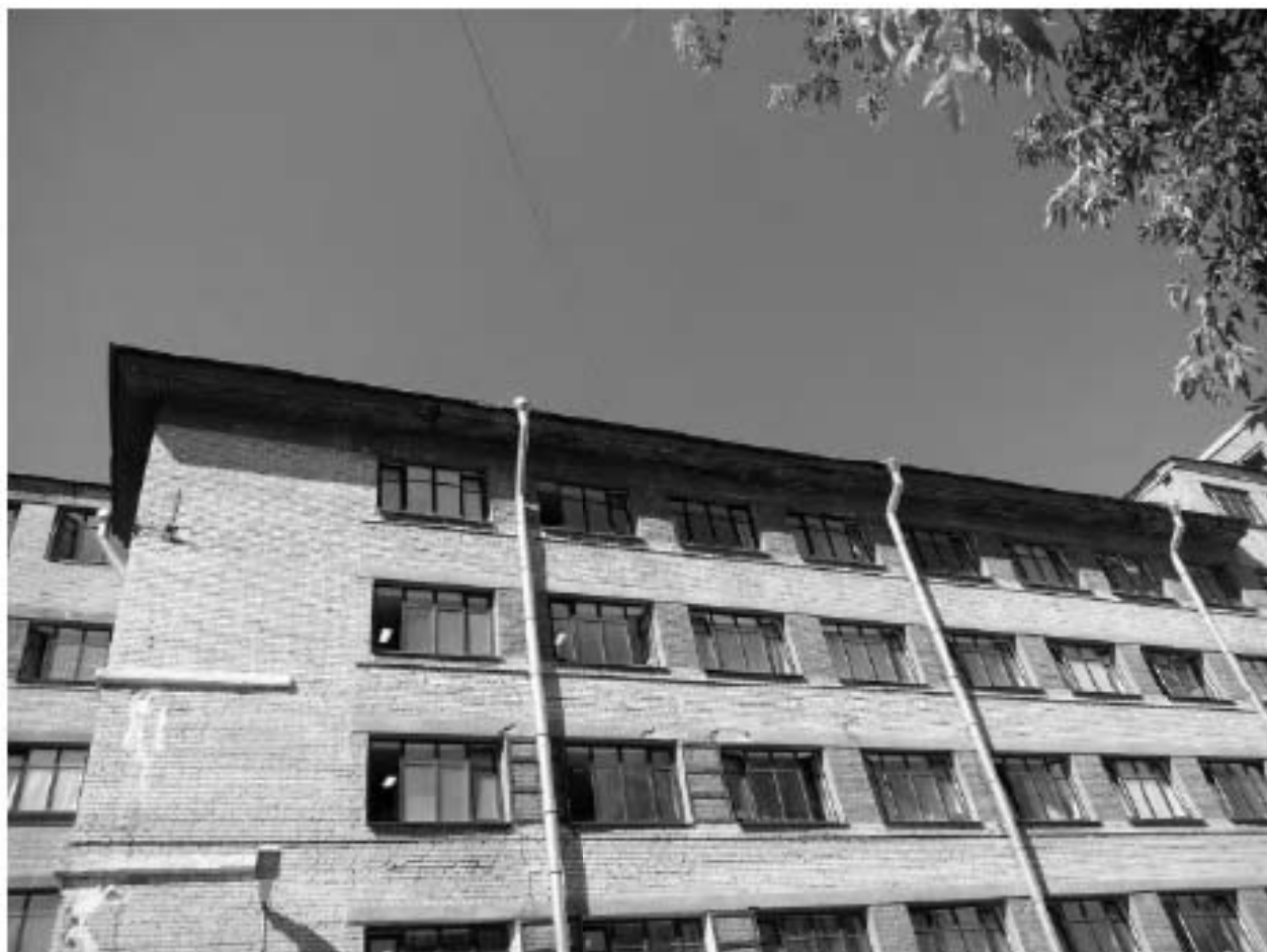
6. Фрагмент восточного фасада. Свес кровли оштукатурен по дражке, отделка имеет существенные утраты.
