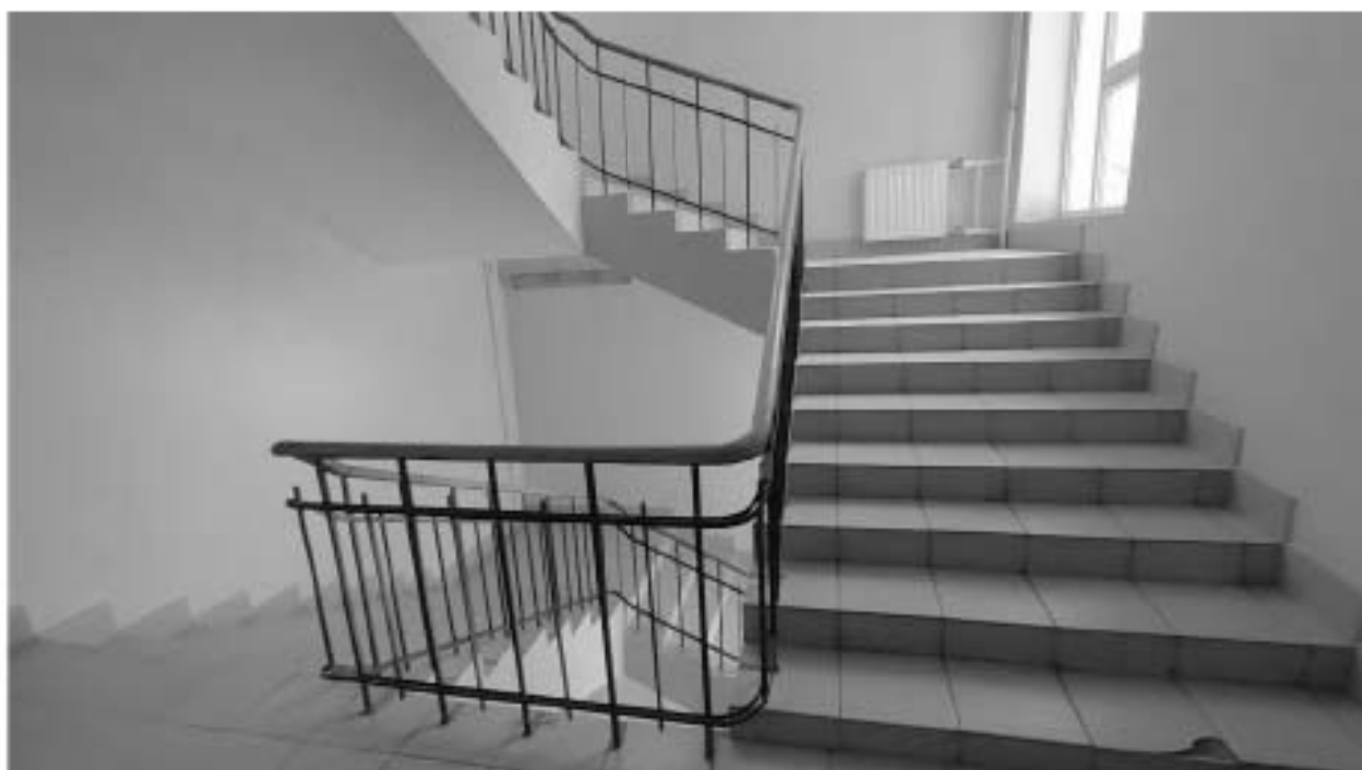
7. Общий вид центральной лестничной клетки в уровне третьего этажа.
