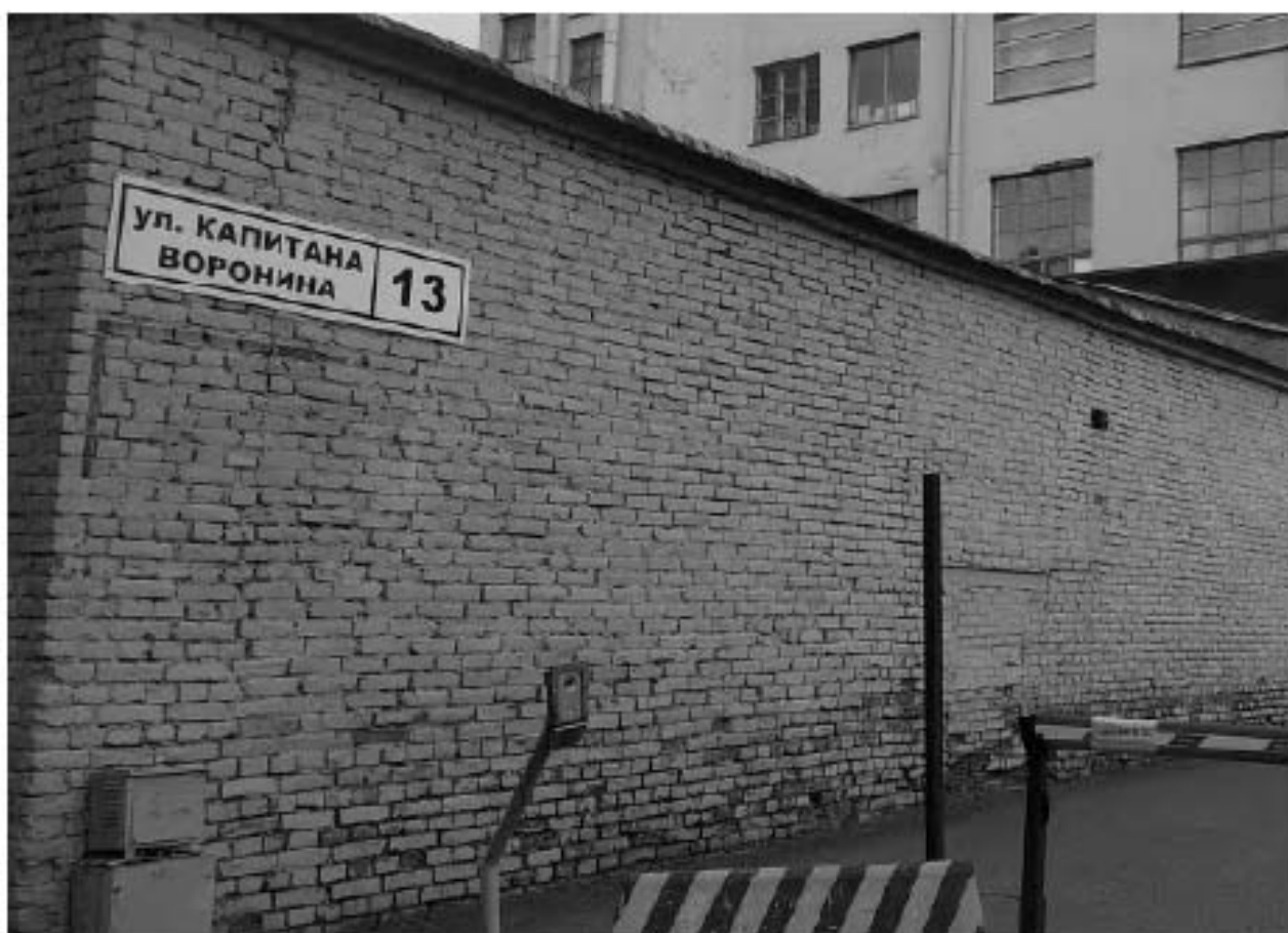
6. Фрагмент западного фасада. Трещины в кладке, перемычка заложеного в центральной части фасада.
