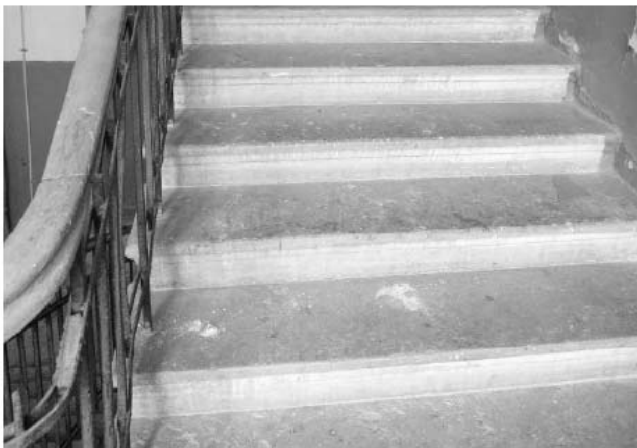
13. Южная лестница (ЛЖ). Ступени в уровне 5 этажа.
