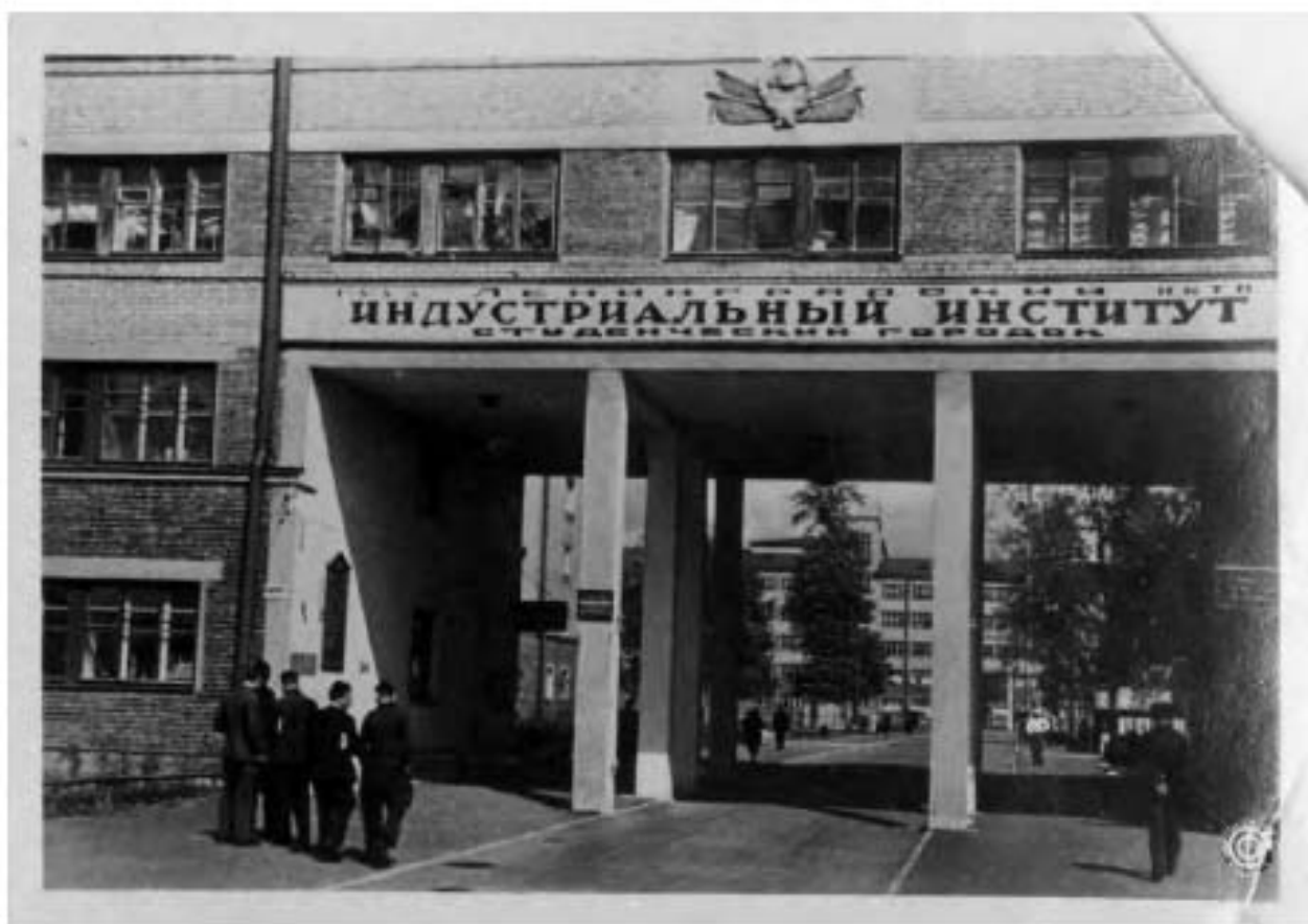
54. Вход в студенческий городок Ленинградского индустриального института. Открытка. 1938. ПОКМ-19084/80. (Вид от Лесного пр.)
