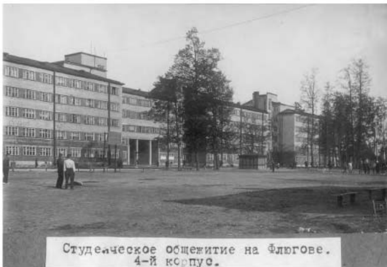
44. Студенческое общежитие на Флюгове пер. 4-й корпус. 1930-е (?). Из фондов музея Политехнического института. (Вид на корпус по Парголовской ул. с запада).
