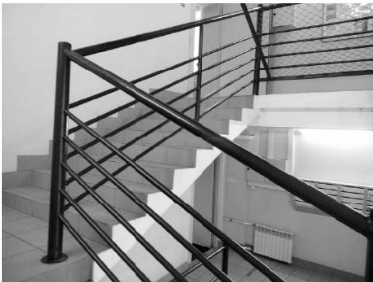
13. Лестница на стыке центрального и южного объёма. Современное ограждение.
