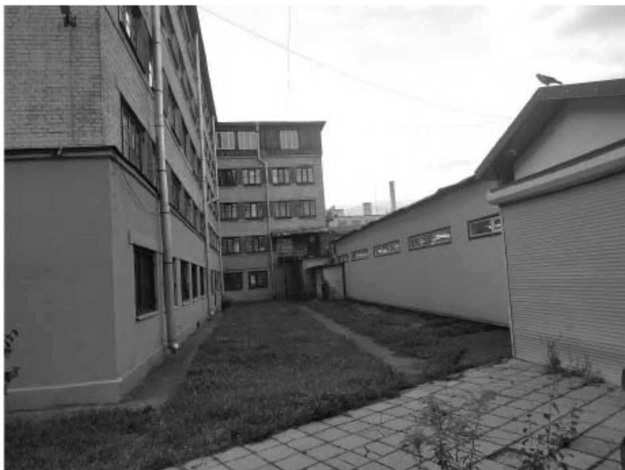
4. Вид поздней пристройки с юго-западной стороны.
