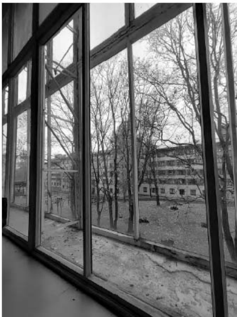
15. Оконные заполнения с исторической расстекловкой в помещении столовой.
