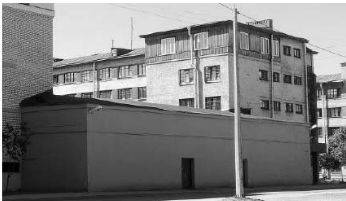
1. Общий вид здания с северо-востока (на первом плане – клуб). В уровне 5 этажа - надстройка на месте исторически существовавшей террасы.
