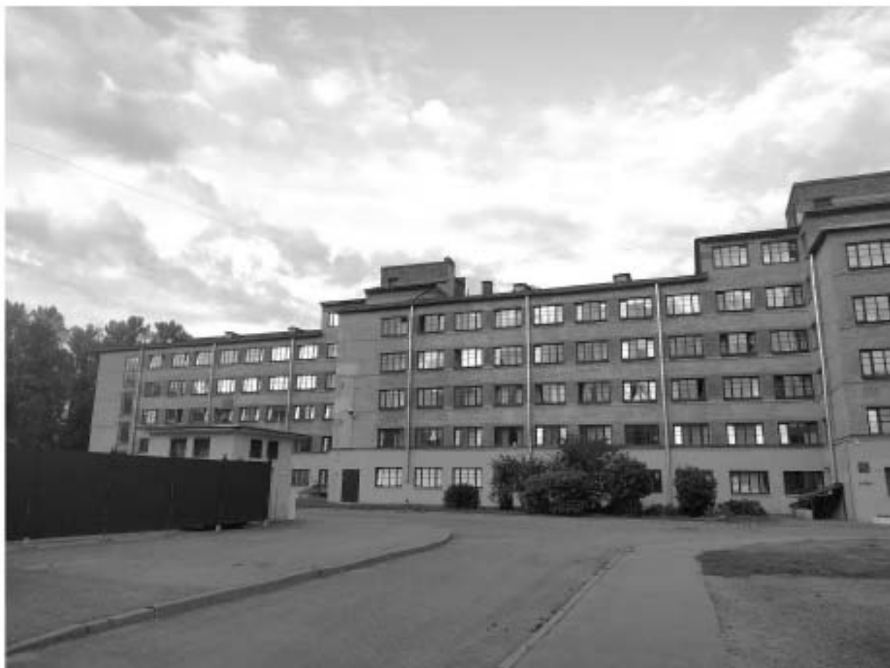
3. Северная часть здания общежития, по адресу ул. Харченко, 16.
