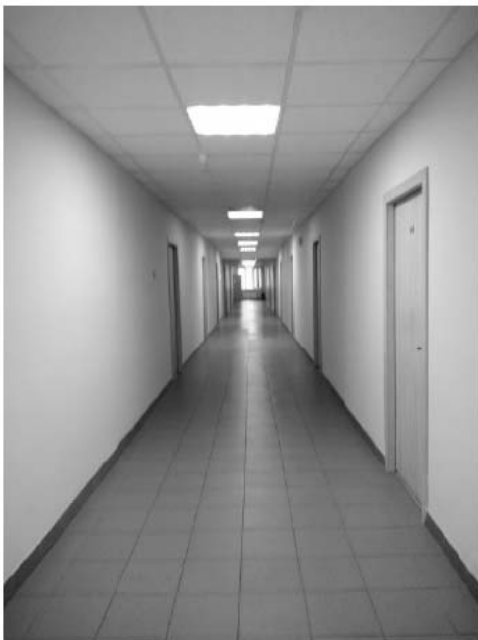
25. Коридор южного объёма в уровне 5 этажа, вид на север.
