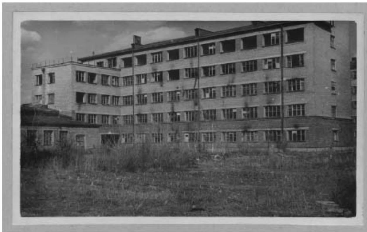
79. Корпус студенческого городка, примыкающий к клубу (Парголовская ул., 11, к.2). Без даты (1940-е?). Из фондов музея Политехнического института.
