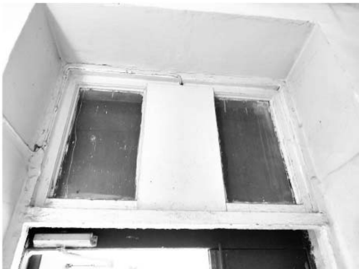
7. Стекла́нная фра́муга фикси́рует исто́рические габа́риты проёма.
