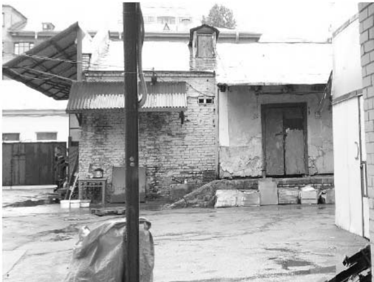
3. Восточный фасад, фрагмент. Каркасная пристройка, оштукатуренная по драпке.
