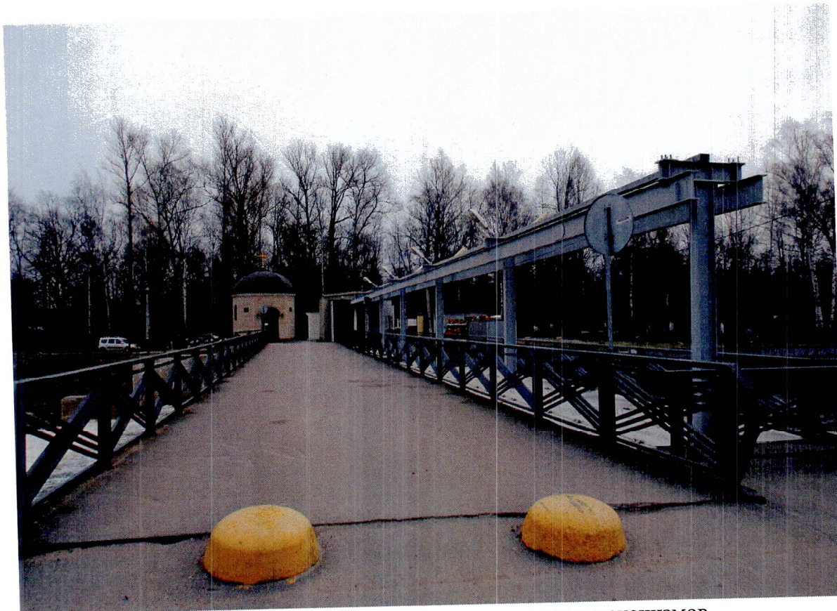
5. Дорожное покрытие. Эстакада для подъемных механизмов
