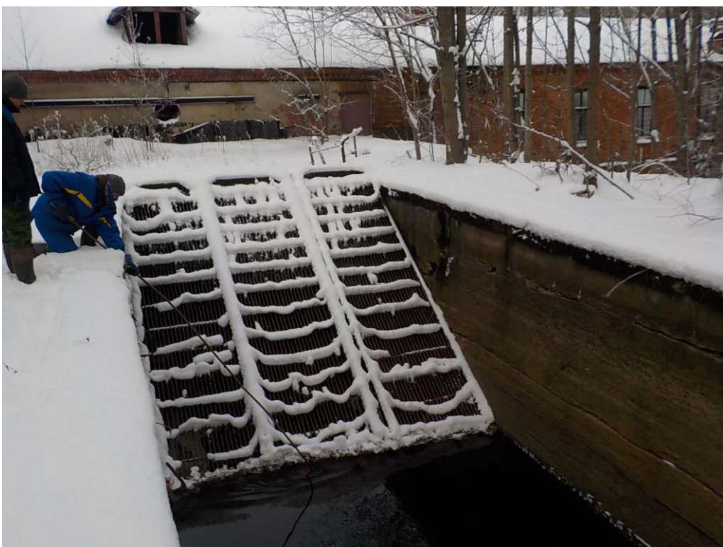
8. «Соляной канал», в составе объекта культурного наследия регионального значения «Ансамбль Сестрорецкого оружейного завода», г. Санкт-Петербург, г. Сестрорецк, ул. Воскова, д. 2, лит. А, сооружение 3. Фрагмент канала. Фото 01.02.2024г.
