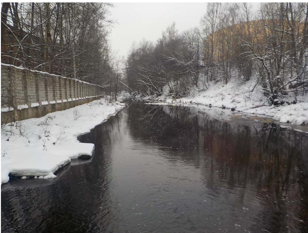
1. «Соляной канал», в составе объекта культурного наследия регионального значения «Ансамбль Сестрорецкого оружейного завода», г. Санкт-Петербург, г. Сестрорецк, ул. Воскова, д. 2, лит. А, сооружение 3. Общий вид канала. Фото 01.02.2024г.
