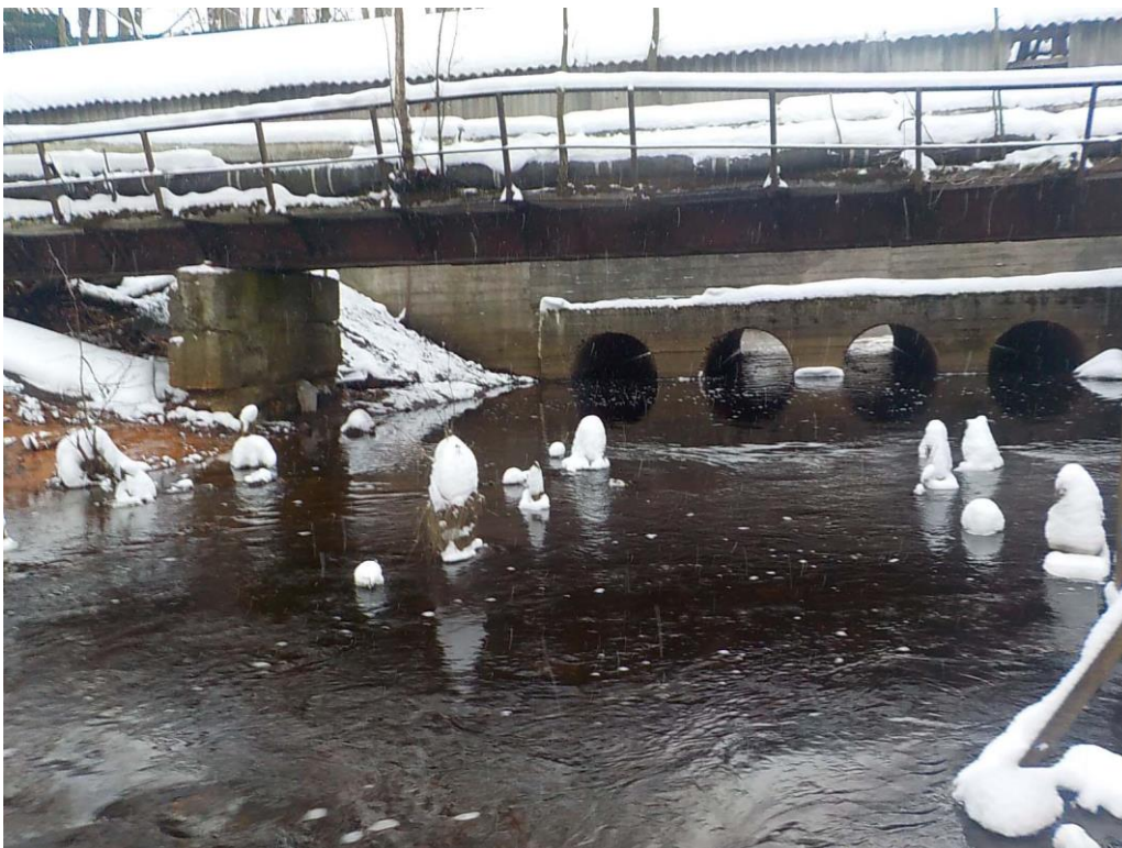
6. «Соляной канал», в составе объекта культурного наследия регионального значения «Ансамбль Сестрорецкого оружейного завода», г. Санкт-Петербург, г. Сестрорецк, ул. Воскова, д. 2, лит. А, сооружение 3. Фрагмент канала. Фото 01.02.2024г.
