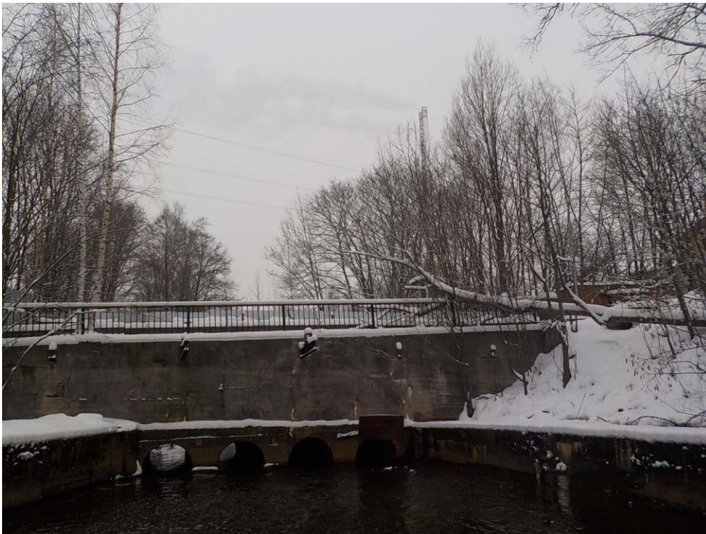
3. «Соляной канал», в составе объекта культурного наследия регионального значения «Ансамбль Сестрорецкого оружейного завода», г. Санкт-Петербург, г. Сестрорецк, ул. Воскова, д. 2, лит. А, сооружение 3. Фрагмент канала. Фото 01.02.2024г.
