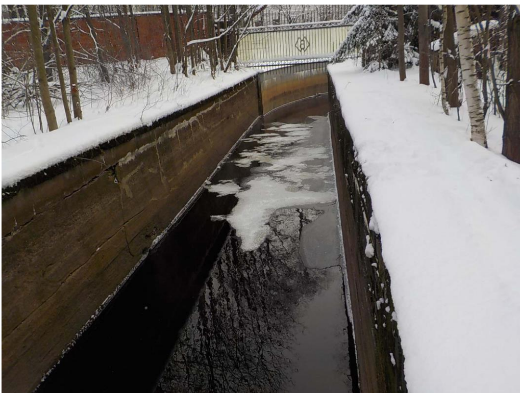
10. «Соляной канал», в составе объекта культурного наследия регионального значения «Ансамбль Сестрорецкого оружейного завода», г. Санкт-Петербург, г. Сестрорецк, ул. Воскова, д. 2, лит. А, сооружение 3. Фрагмент канала. Фото 01.02.2024г.
