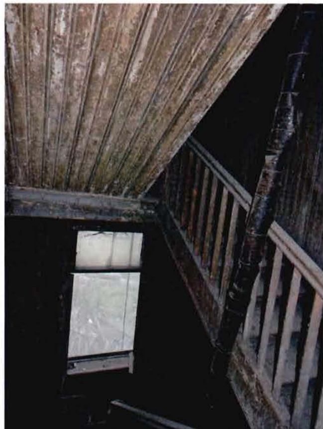
4. Лестница в северо-восточной части объекта культурного наследия.
