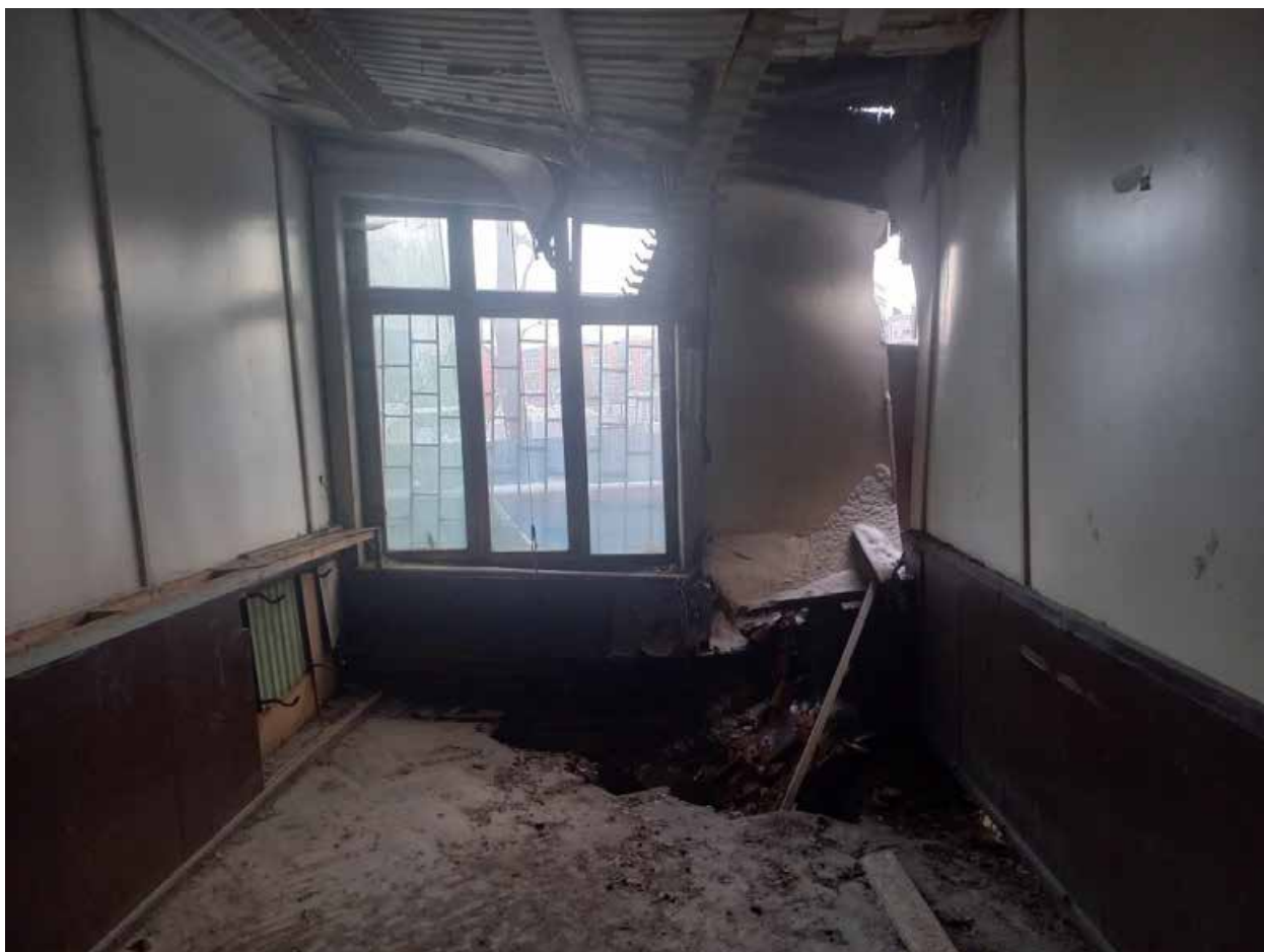
Фото 18. Внутренние помещения. 1 этаж.
