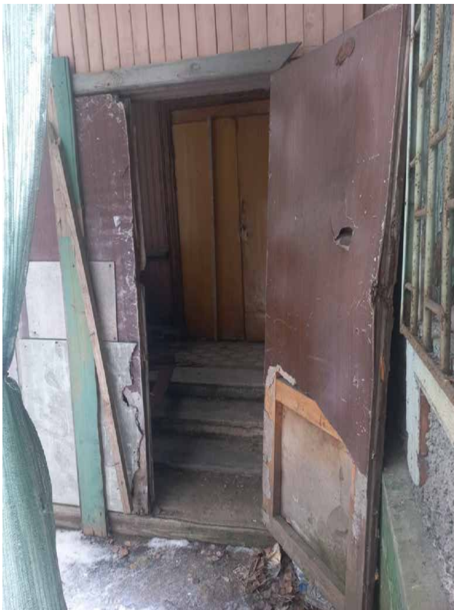
Фото 5. Главный вход в здание.
