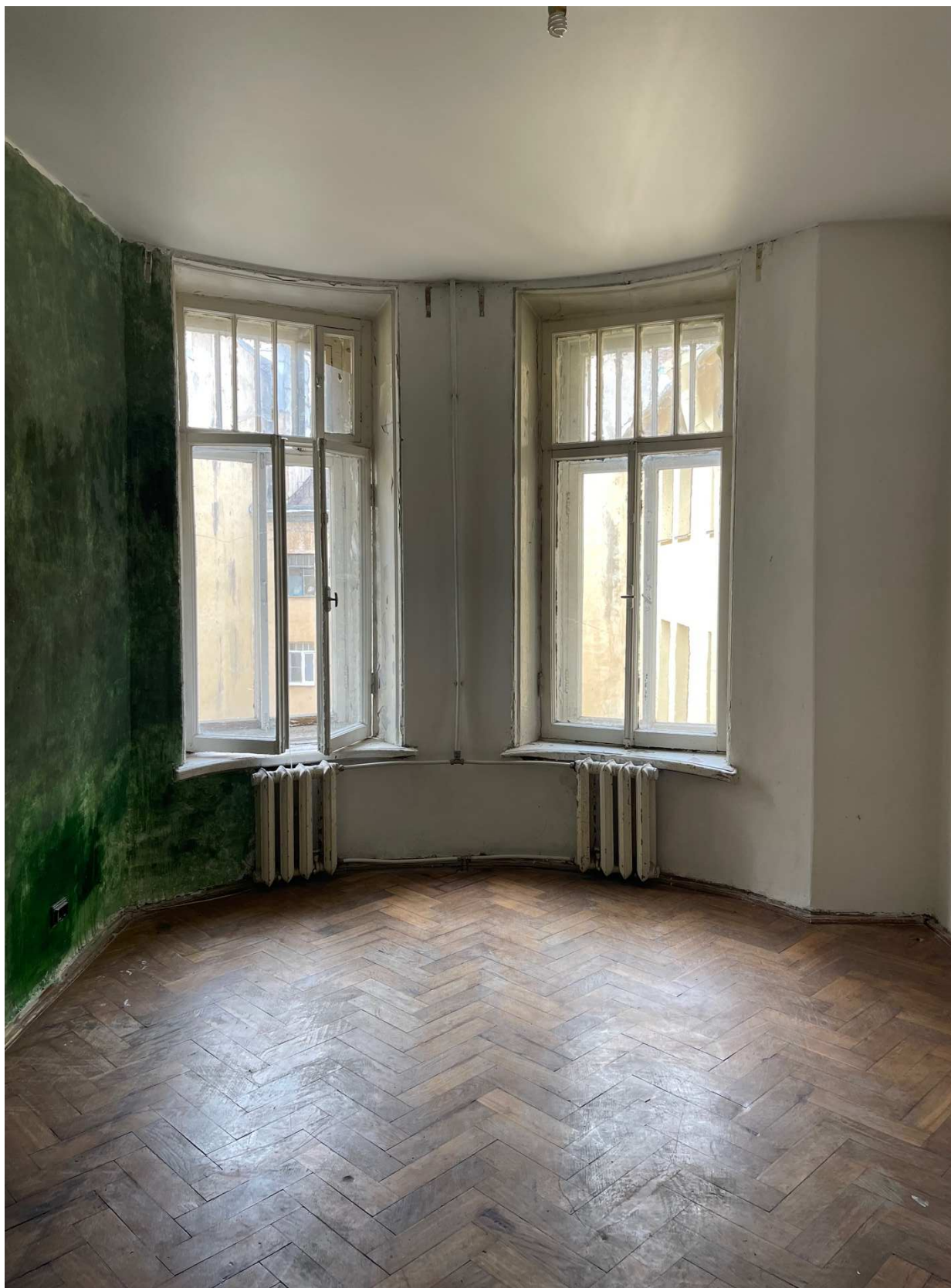
11.Фрагмент интерьера комнаты (помещение 11/19.3);
