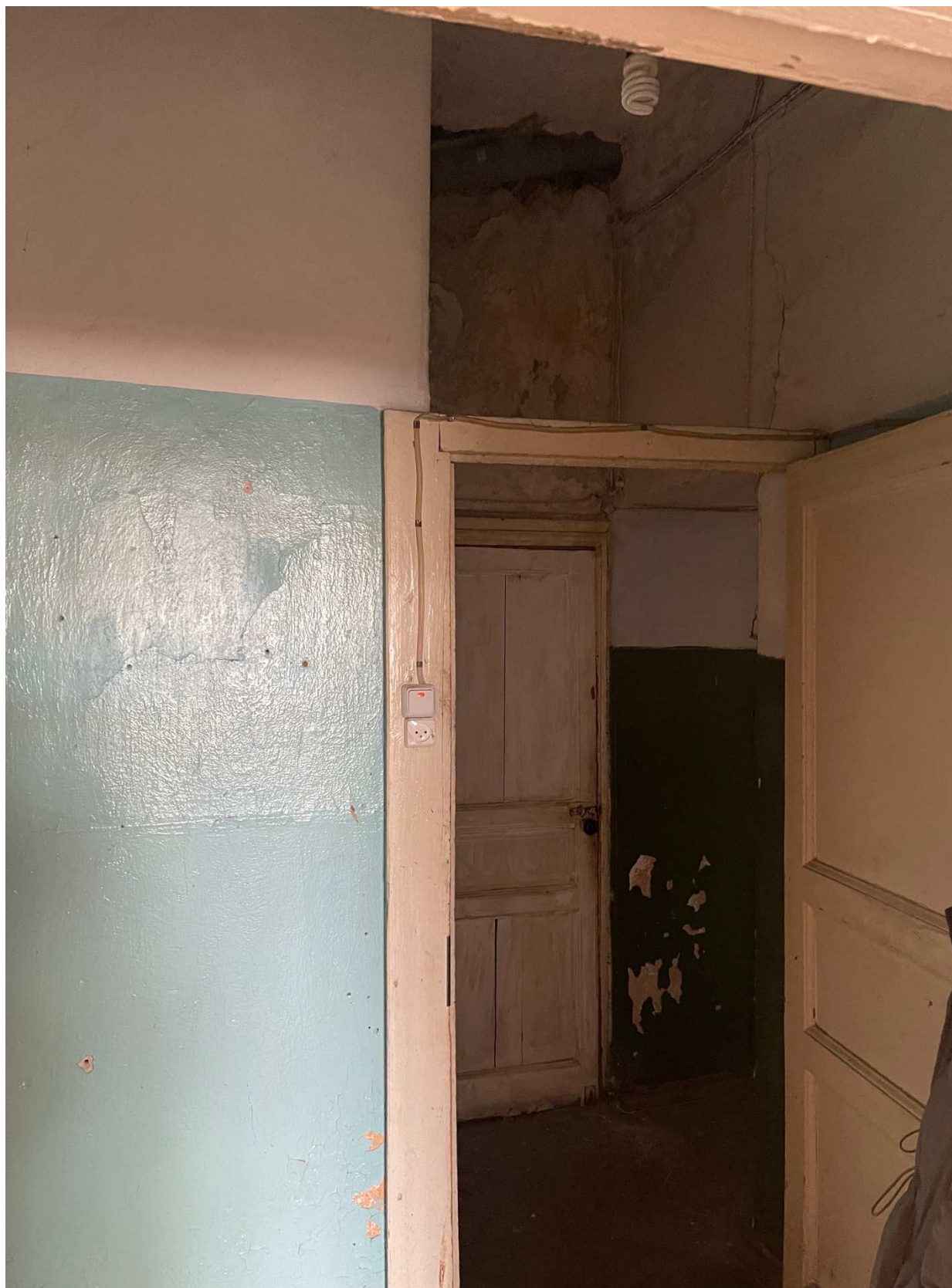
15.Фрагмент интерьера ванной (помещение 10/4.5);
