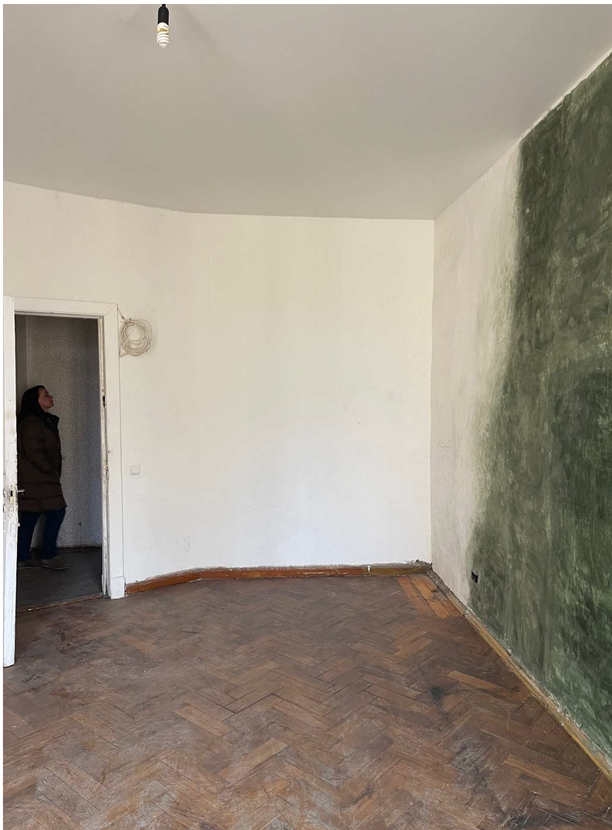
12.Фрагмент интерьера комнаты (помещение 11/19.3);
