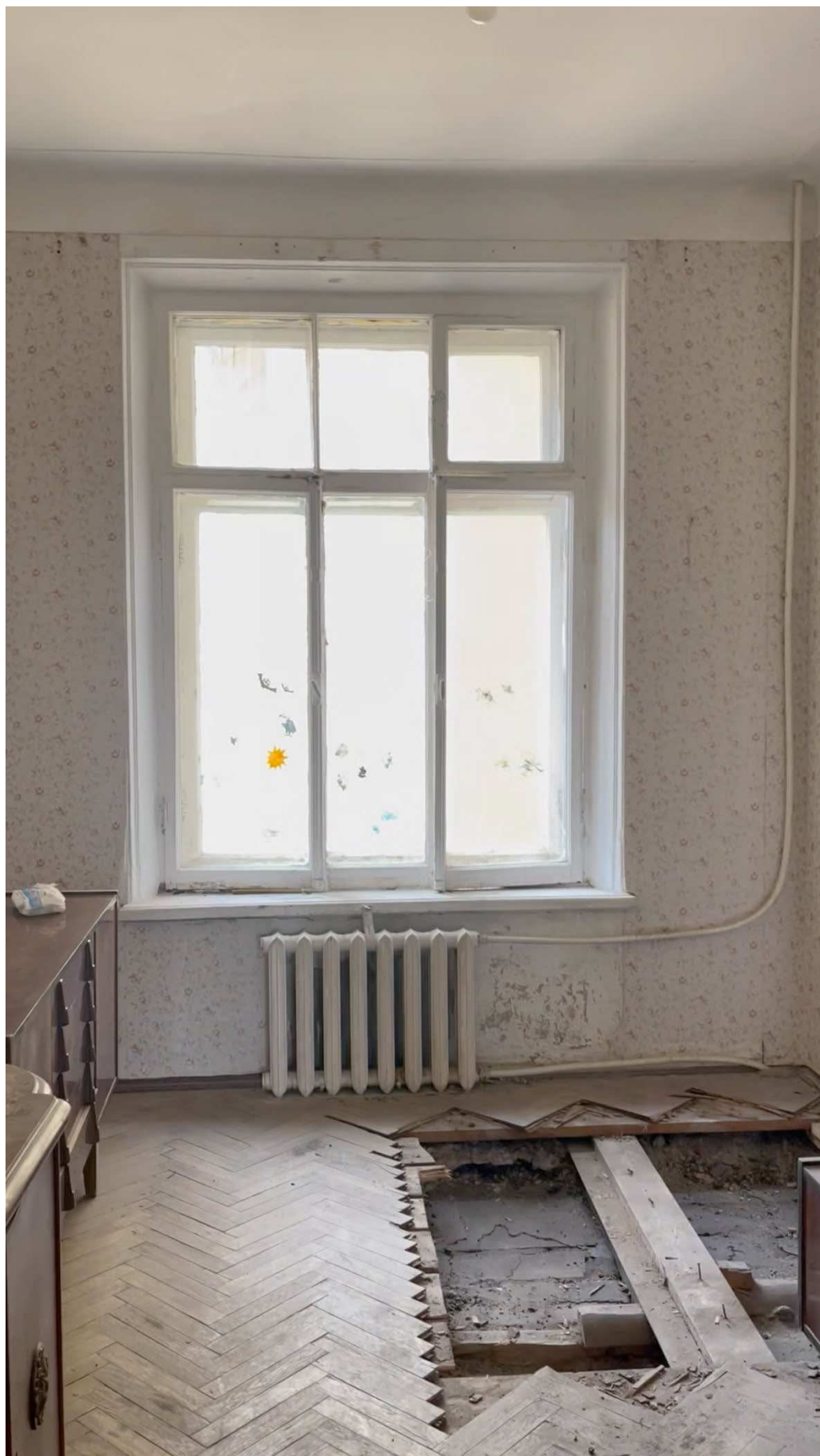
7. Фрагмент интерьера комнаты (помещение 12/14.3);
