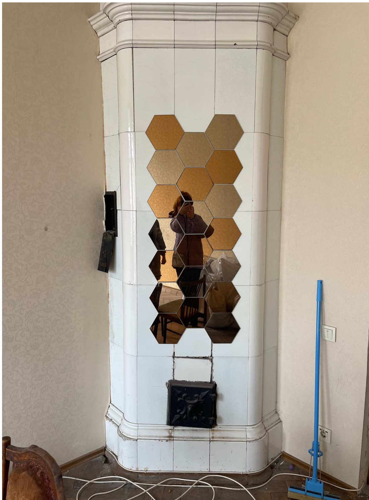
5. Вид на печь в помещении 2/20.5;
