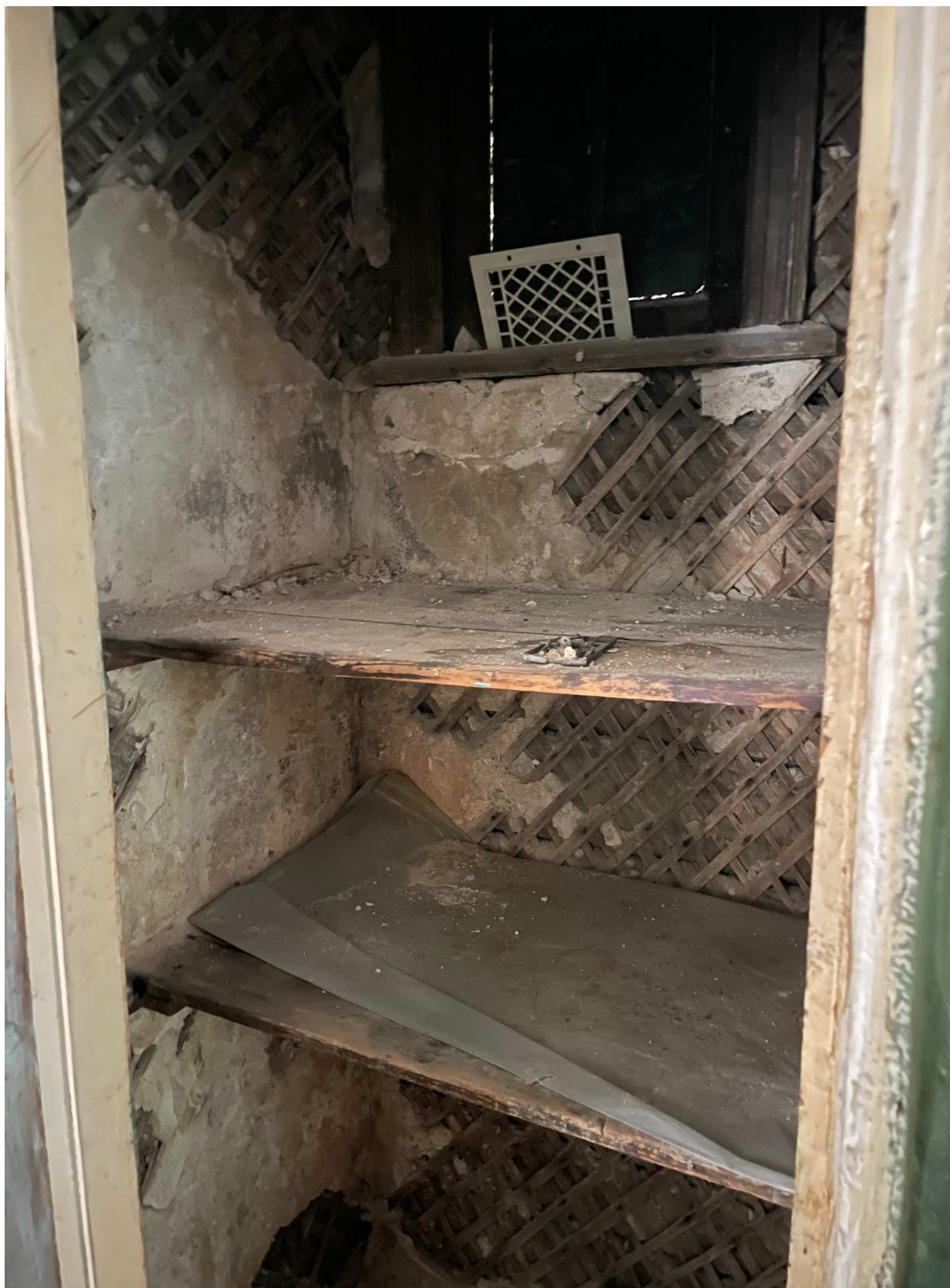
20. Вид на встроенный шкаф;
