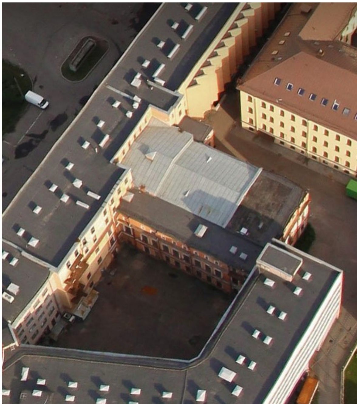
63. Объект по адресу: Санкт-Петербург, Рижский пр., д. 3, литера Л. Вид на крышу здания. 2011 г. // Яндекс карты – транспорт, навигация, поиск мест [Электронный ресурс] – URL: https://yandex.ru/maps/2/saint-petersburg . Дата обращения: 09.02.2023 г.
