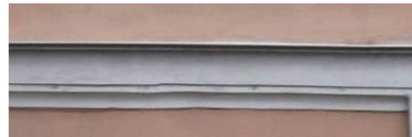
венчающий профилированный раскрепованный карниз;
