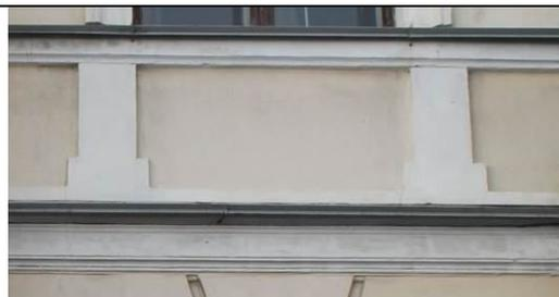
венчающий профилированный карниз с профилированной тягой;
