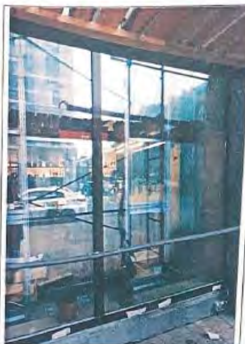
9. Фрагмент. Западный фасад здания по адресу: ул. Некрасова, дом 60, литера А. Окно Помещения.
