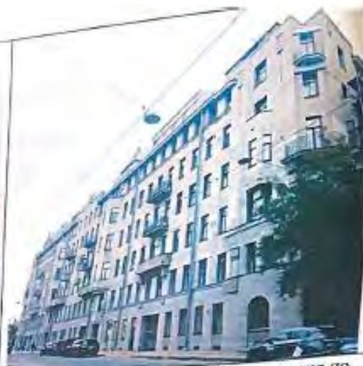
2. Общий вид. Восточный фасад здания по адресу: ул. Некрасова, дом 60, литера А.
