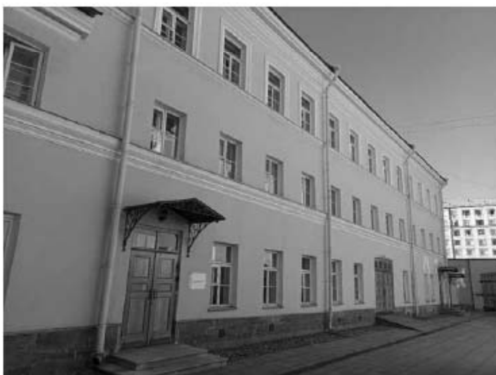
14. Объект культурного наследия федерального значения «Усадьба Державина Г.Р.», по адресу: Санкт-Петербург, наб. реки Фонтанки, д. 118. Флигель (Реставрационный корпус). Фрагмент фасада. Дата съемки: 10.10.2022г.
