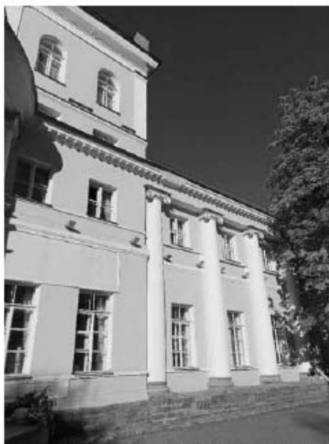
12. Объект культурного наследия федерального значения «Усадьба Державина Г.Р.», по адресу: Санкт-Петербург, наб. реки Фонтанки, д. 118. Главный дом (Центральный корпус). Фрагмент фасада. Дата съемки: 10.10.2022г.
