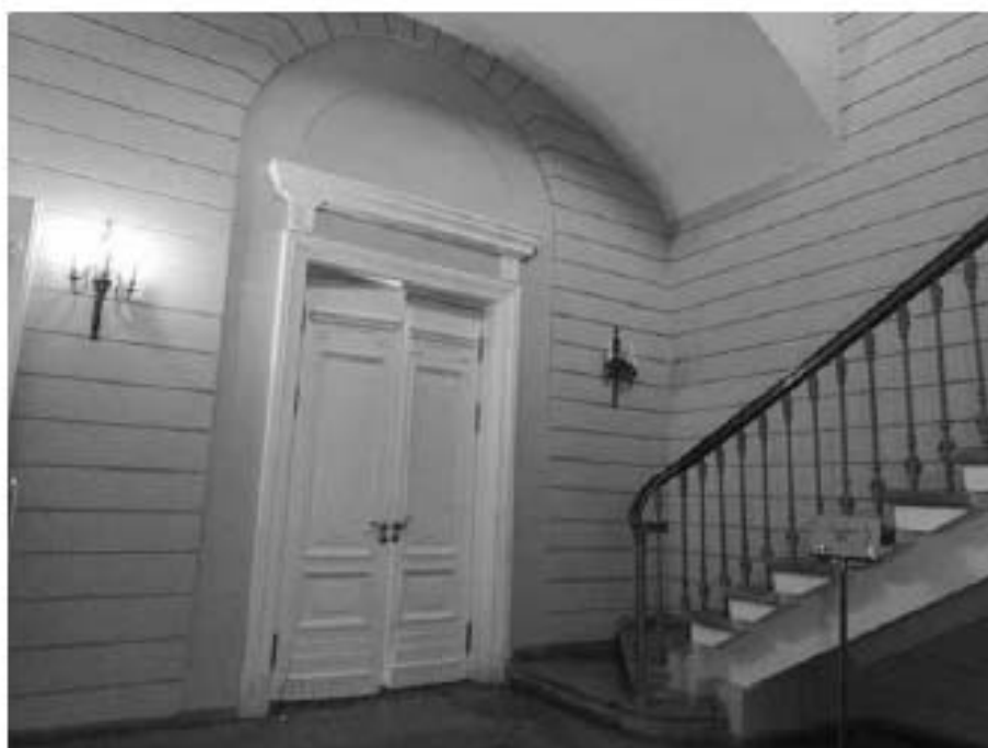
17. Объект культурного наследия федерального значения «Усадьба Державина Г.Р.», по адресу: Санкт-Петербург, наб. реки Фонтанки, д. 118. Главный дом (Центральный корпус). Лестница. Дата съемки: 10.10.2022г.
