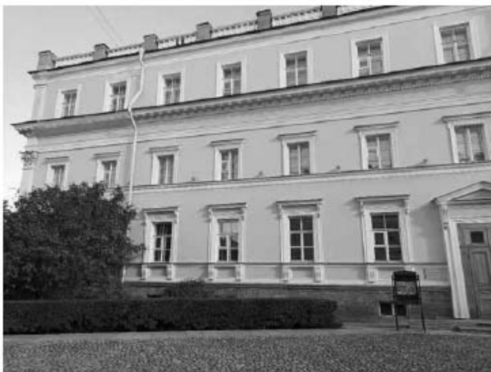
3. Объект культурного наследия федерального значения «Усадьба Державина Г.Р.», по адресу: Санкт-Петербург, наб. реки Фонтанки, д. 118. Главный дом (Восточный корпус). Фрагмент фасада. Дата съемки: 10.10.2022г.
