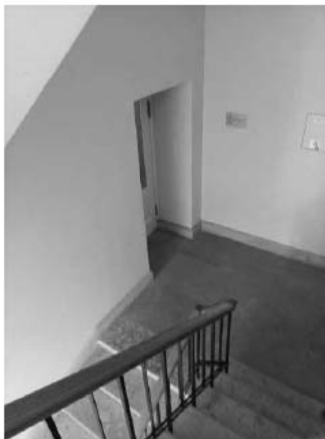
56. Объект культурного наследия федерального значения «Усадьба Державина Г.Р.», по адресу: Санкт-Петербург, наб. реки Фонтанки, д. 118. Флигель (Гостевой корпус). Лестница. Дата съемки: 10.10.2022г.
