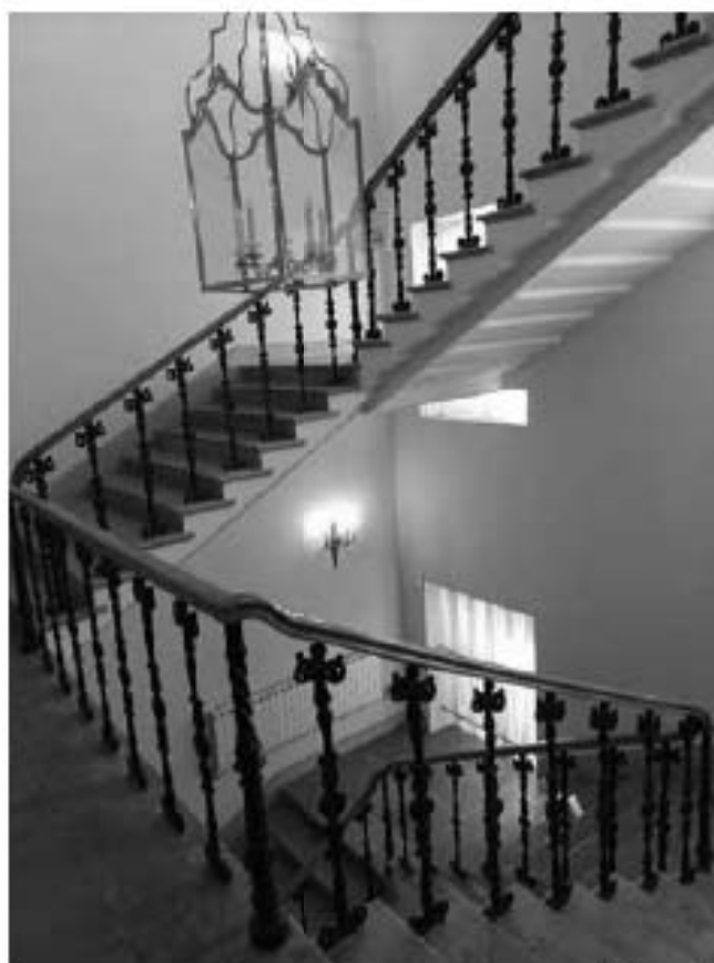
47. Объект культурного наследия федерального значения «Усадьба Державина Г.Р.», по адресу: Санкт-Петербург, наб. реки Фонтанки, д. 118. Главный дом (Восточный корпус). Лестница. Дата съемки: 10.10.2022г.
