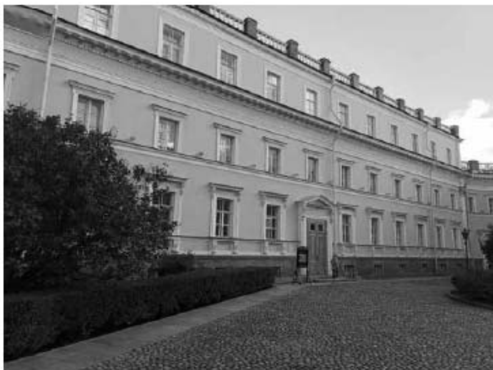
2. Объект культурного наследия федерального значения «Усадьба Державина Г.Р.», по адресу: Санкт-Петербург, наб. реки Фонтанки, д. 118. Главный дом (Восточный корпус). Фрагмент фасада. Дата съемки: 10.10.2022г.
