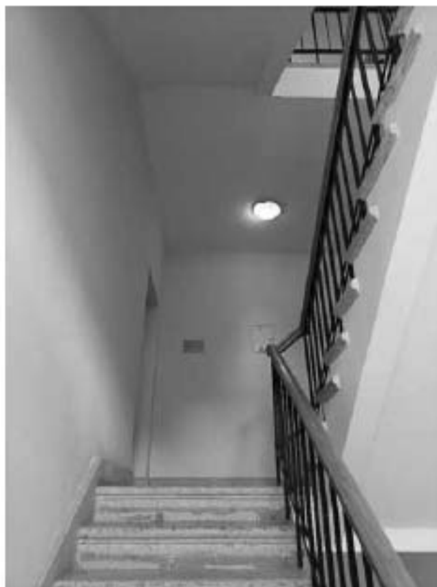
57. Объект культурного наследия федерального значения «Усадьба Державина Г.Р.», по адресу: Санкт-Петербург, наб. реки Фонтанки, д. 118. Флигель (Гостевой корпус). Лестница. Дата съемки: 10.10.2022г.
