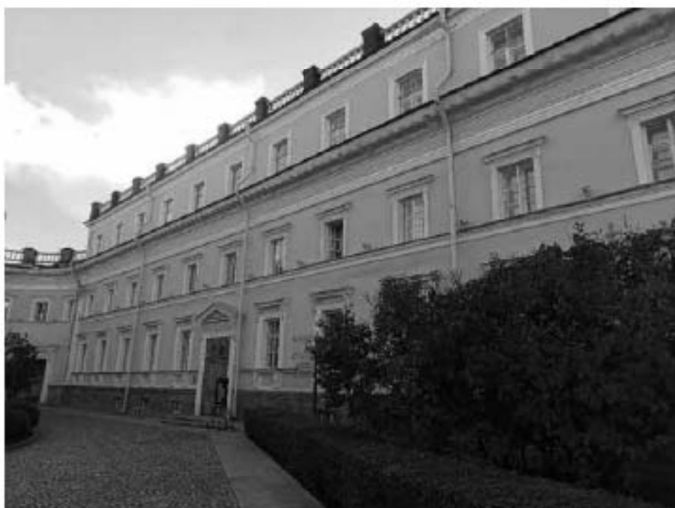
4. Объект культурного наследия федерального значения «Усадьба Державина Г.Р.», по адресу: Санкт-Петербург, наб. реки Фонтанки, д. 118. Главный дом (Западный корпус). Фрагмент фасада. Дата съемки: 10.10.2022г.
