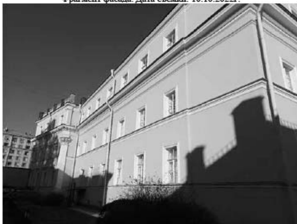
6. Объект культурного наследия федерального значения «Усадьба Державина Г.Р.», по адресу: Санкт-Петербург, наб. реки Фонтанки, д. 118. Главный дом (Западный корпус). Фрагмент фасада. Дата съемки: 10.10.2022г.
