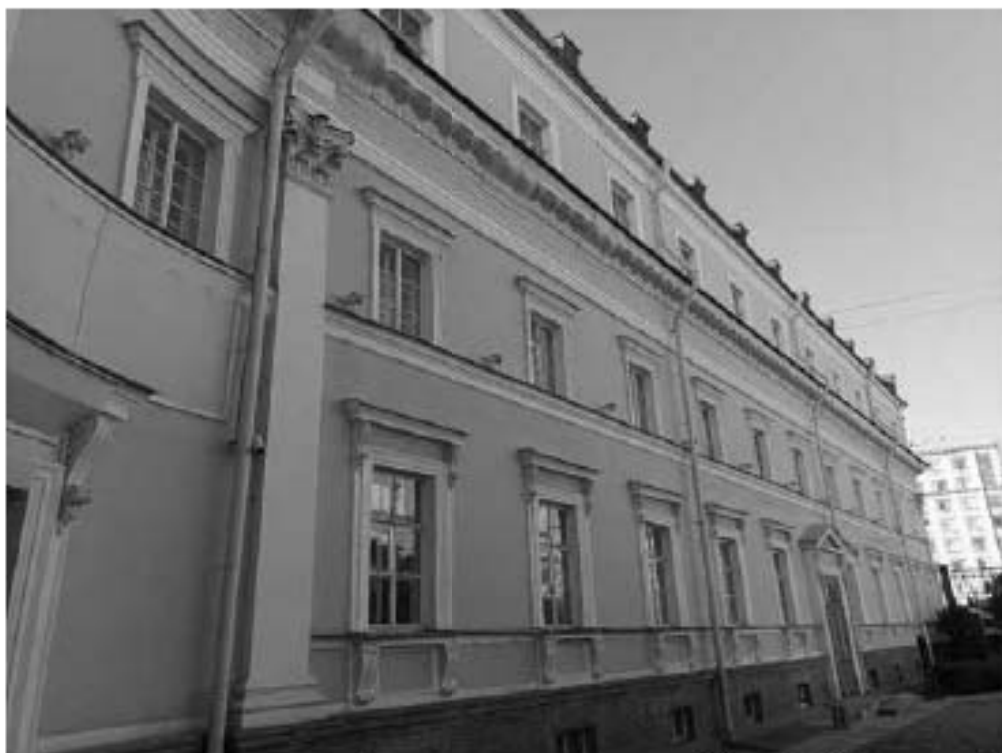
5. Объект культурного наследия федерального значения «Усадьба Державина Г.Р.», по адресу: Санкт-Петербург, наб. реки Фонтанки, д. 118. Главный дом (Западный корпус). Фрагмент фасада. Дата съемки: 10.10.2022г.
