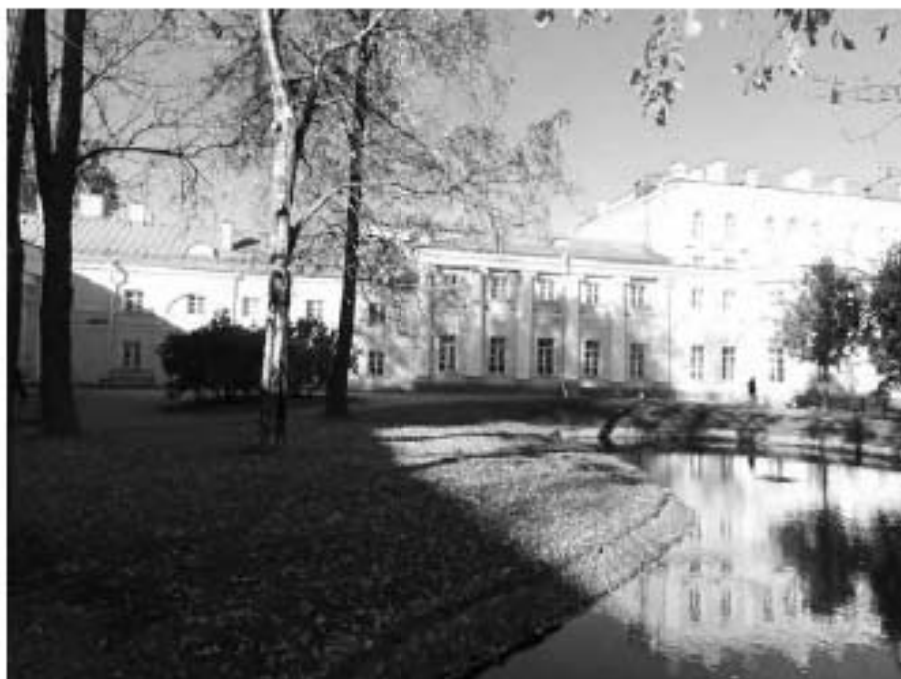
11. Объект культурного наследия федерального значения «Усадьба Державина Г.Р.», по адресу: Санкт-Петербург, наб. реки Фонтанки, д. 118. Главный дом (Центральный корпус). Фрагмент фасада. Дата съемки: 10.10.2022г.
