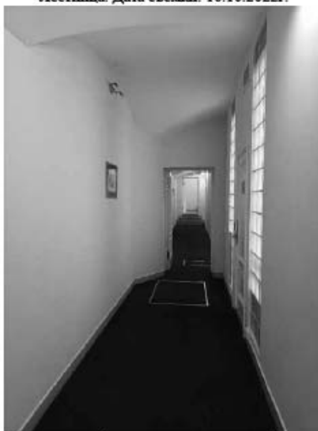
58. Объект культурного наследия федерального значения «Усадьба Державина Г.Р.», по адресу: Санкт-Петербург, наб. реки Фонтанки, д. 118. Флигель (Гостевой корпус). Коридор 1 этажа. Дата съемки: 10.10.2022г.
