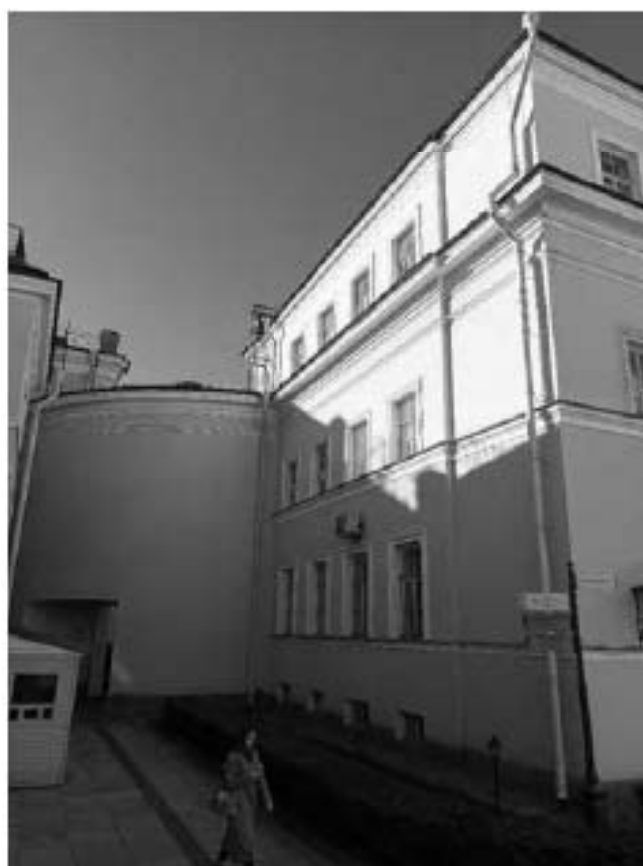
8. Объект культурного наследия федерального значения «Усадьба Державина Г.Р.», по адресу: Санкт-Петербург, наб. реки Фонтанки, д. 118. Главный дом (Восточный корпус). Фрагмент фасада. Дата съемки: 10.10.2022г.
