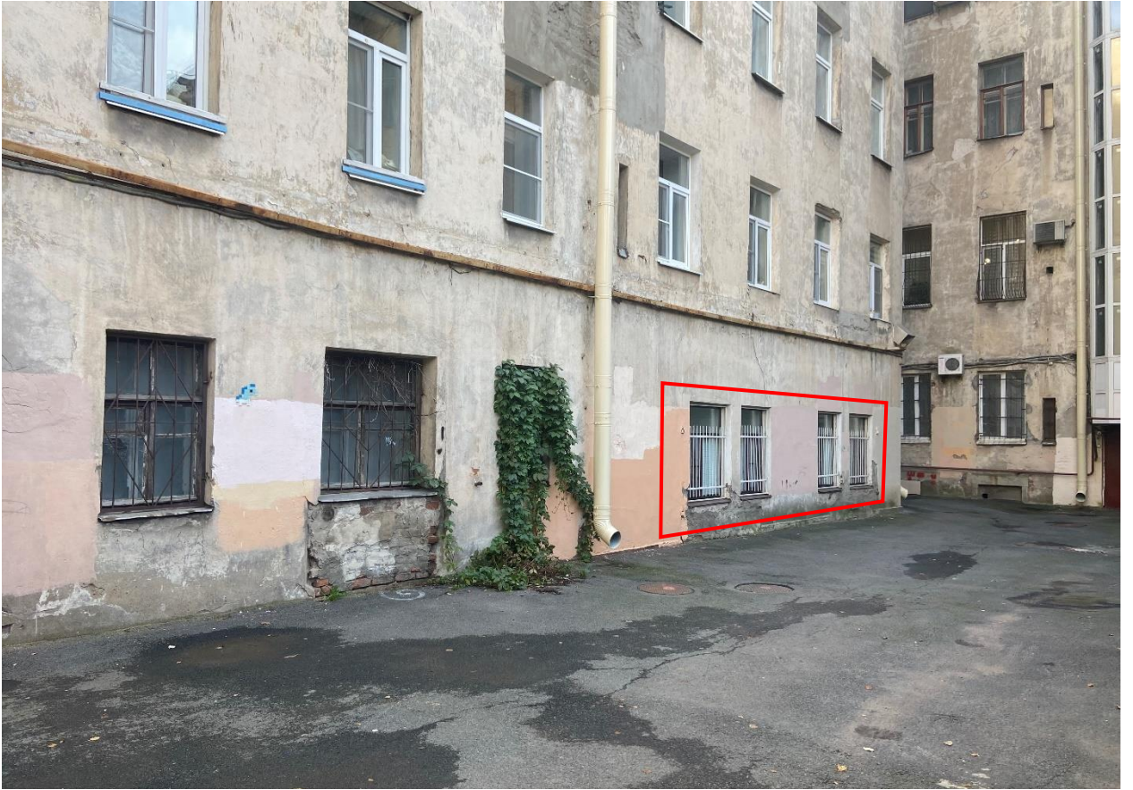
Фото 7. Вид на дворовый фасад.
