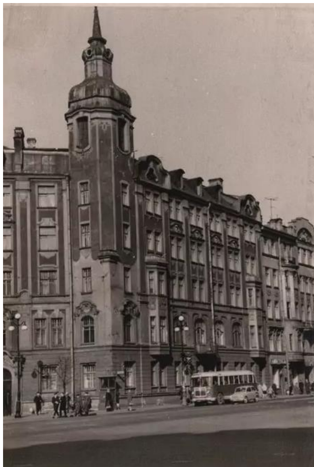
Илл. 40. Доходный дом М.М. Горбова. Кировский пр., д. 20; Санкт-Петербург, Петроградский район, Петроградский остров, 1963 г. // Электронный ресурс: http://goskatalog.ru/
