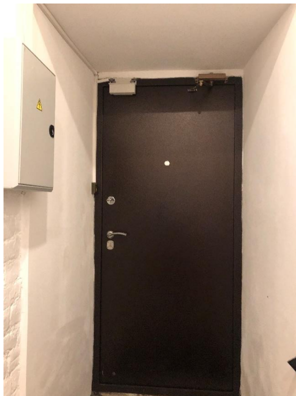
Фото 2. Вид на входную дверь изнутри.
