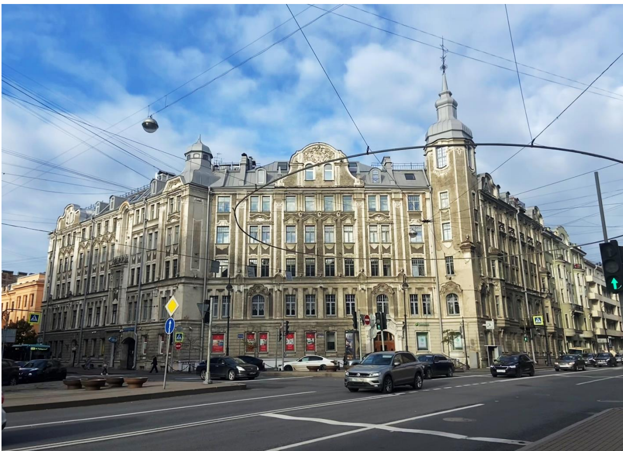
Фото 1. Вида на дом № 10 на пересечении улицы Мира и Каменноостровского проспекта.
