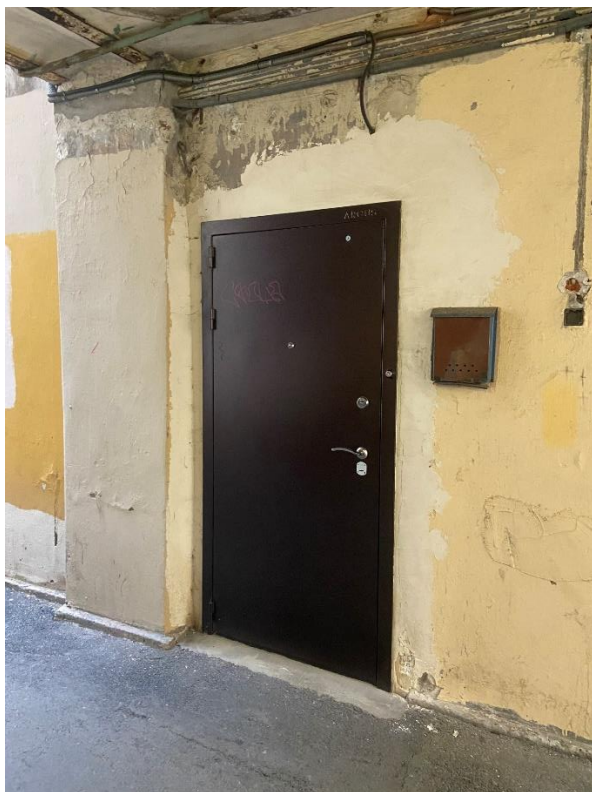
Фото 1. Вид на входную дверь в исследуемую квартиру.
