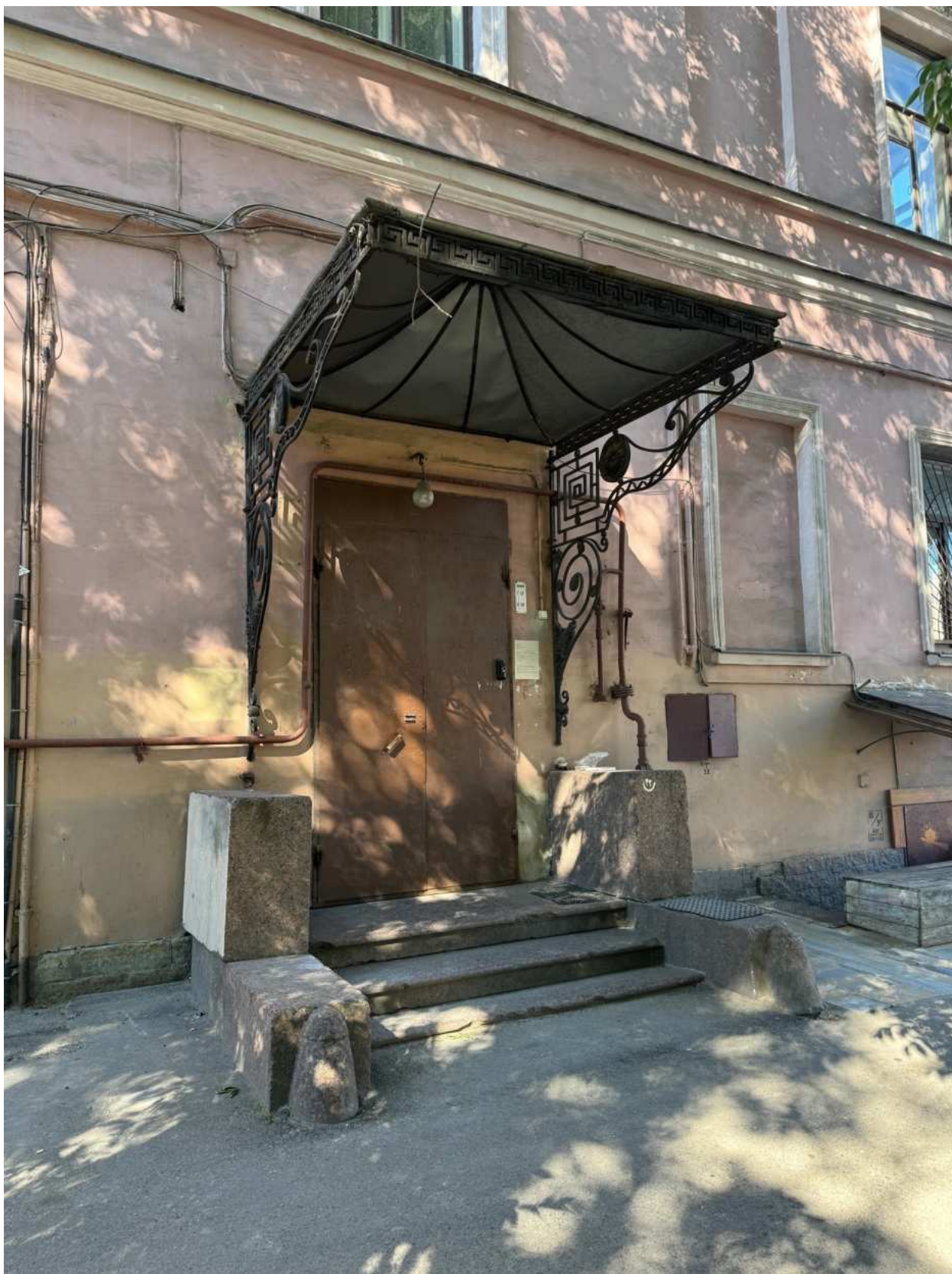
Фото 5. Вход в парадную с восточного фасада объекта культурного наследия.
