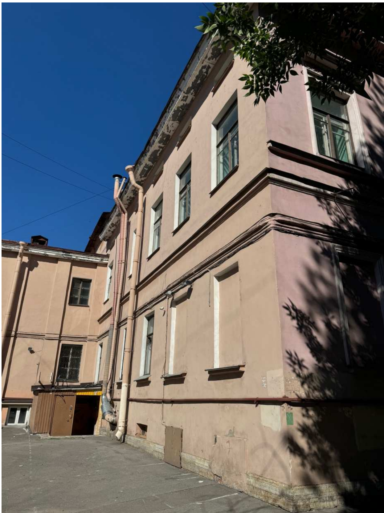
Фото 6. Вид на южный дворовой фасад объекта культурного наследия.
