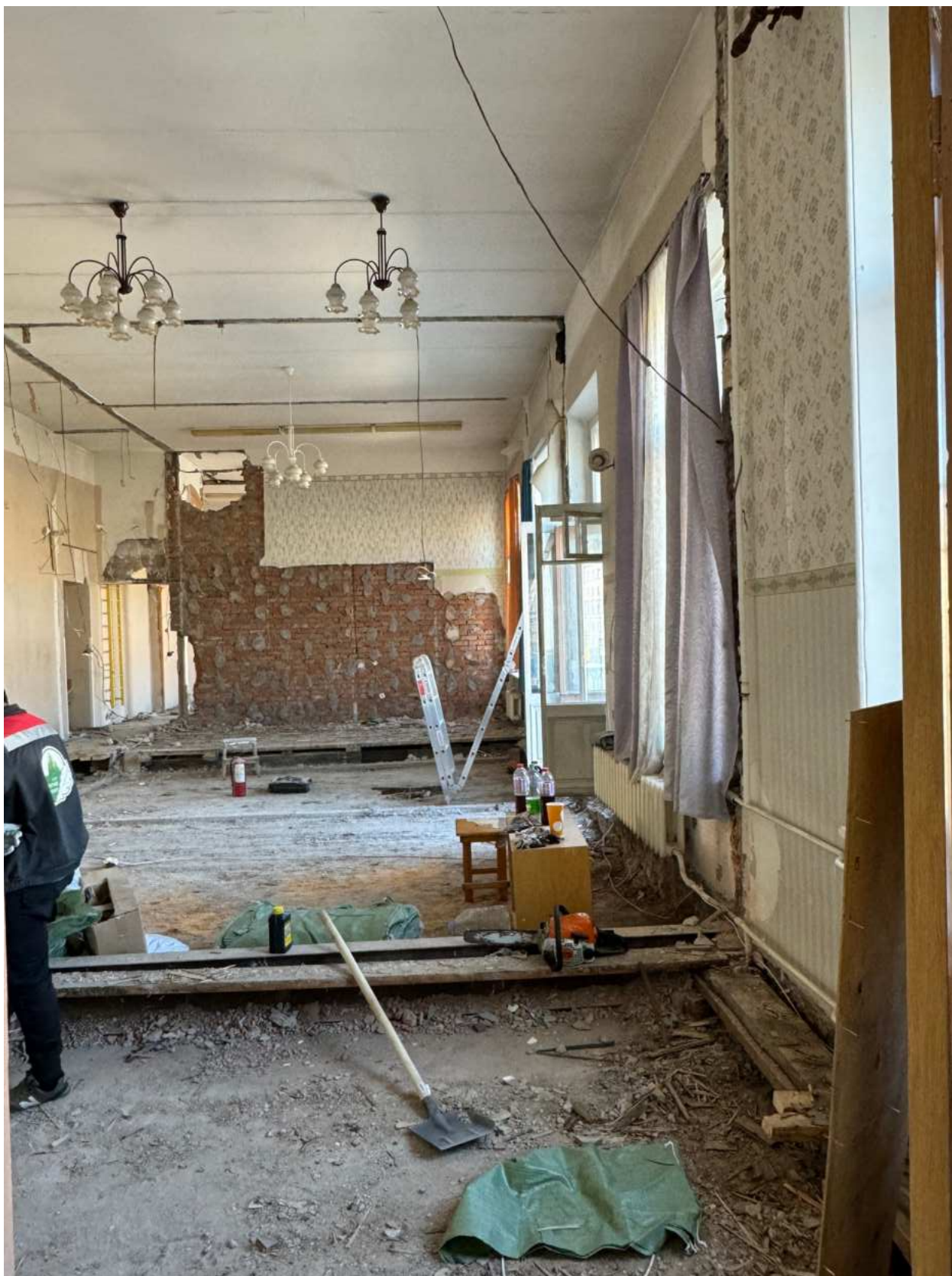
Фото 29. Вид на помещение квартир № 3-4 объекта культурного наследия.
