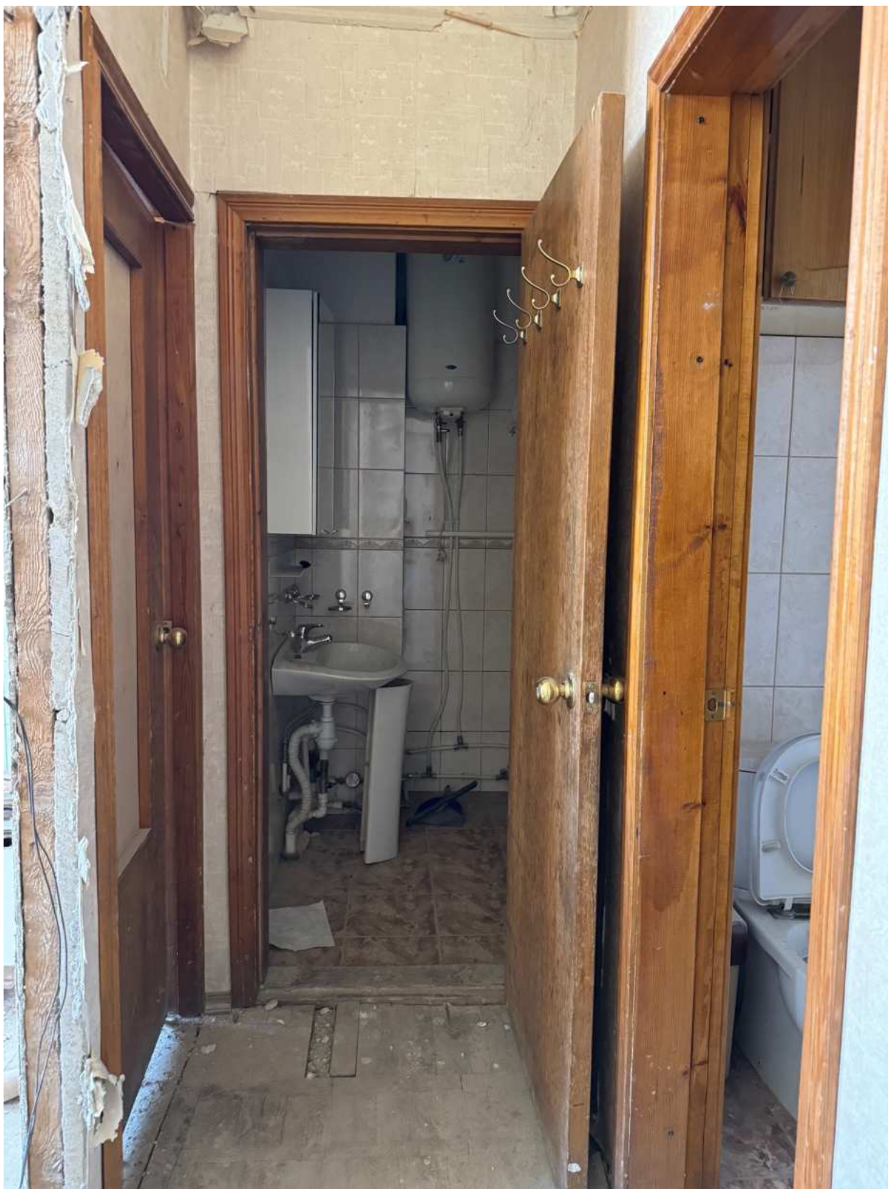
Фото 24. Вид на помещение квартир № 3-4 объекта культурного наследия.
