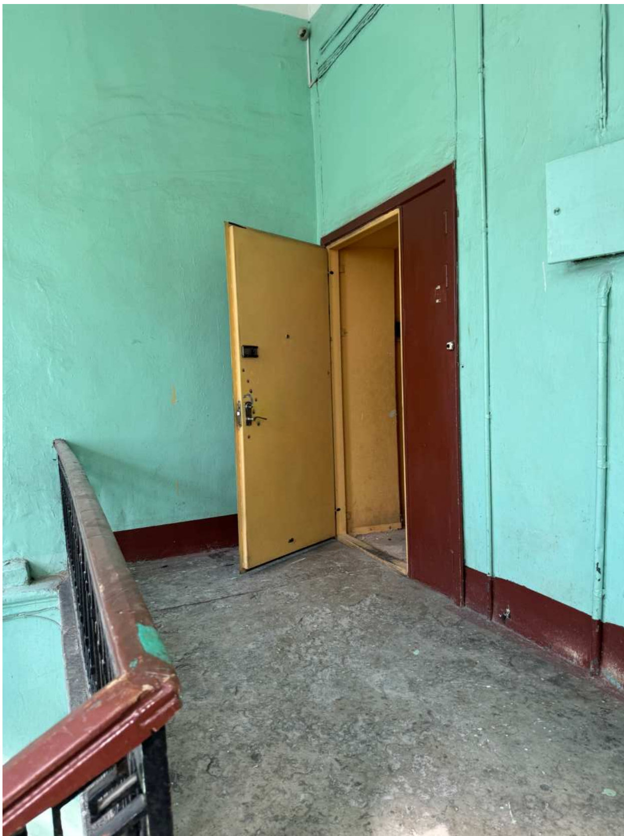
Фото 15. Вид на дверное заполнение, ведущее в квартиры № 3-4 объекта культурного наследия.
