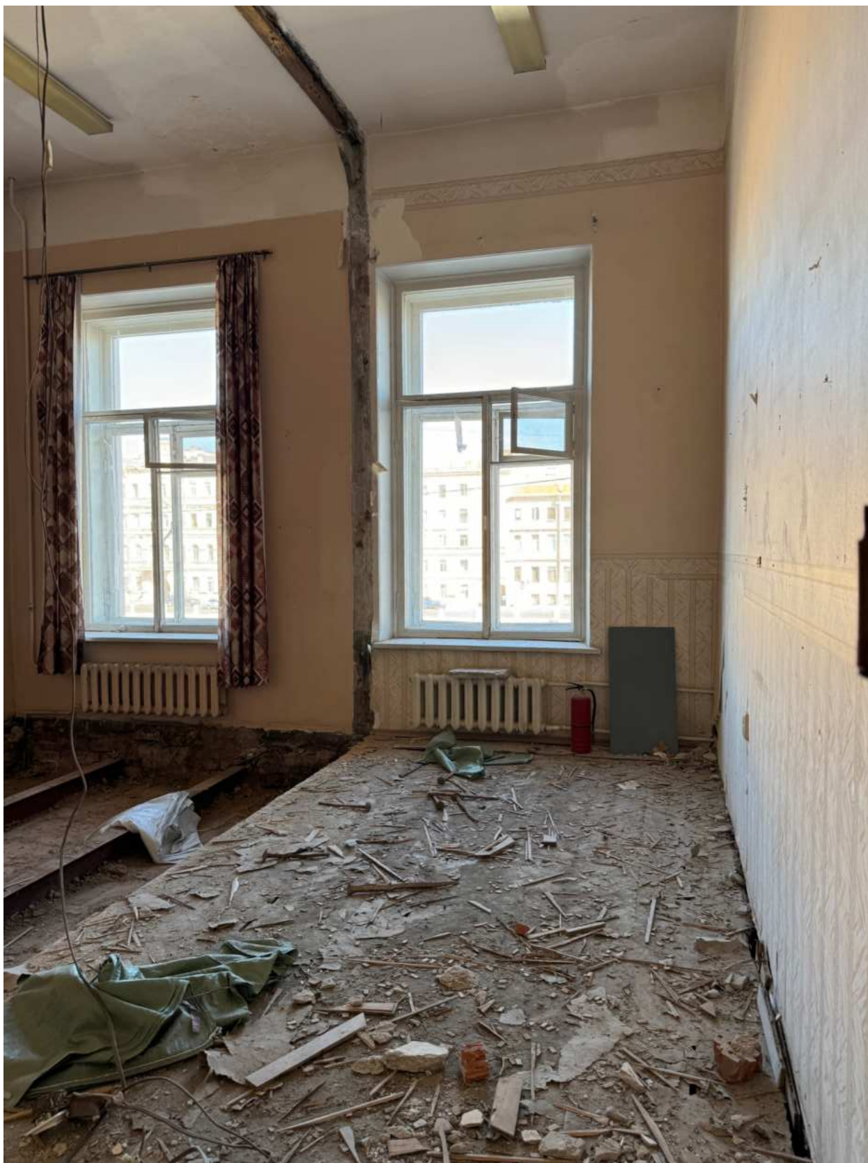
Фото 41. Вид на помещение квартир № 3-4 объекта культурного наследия.
