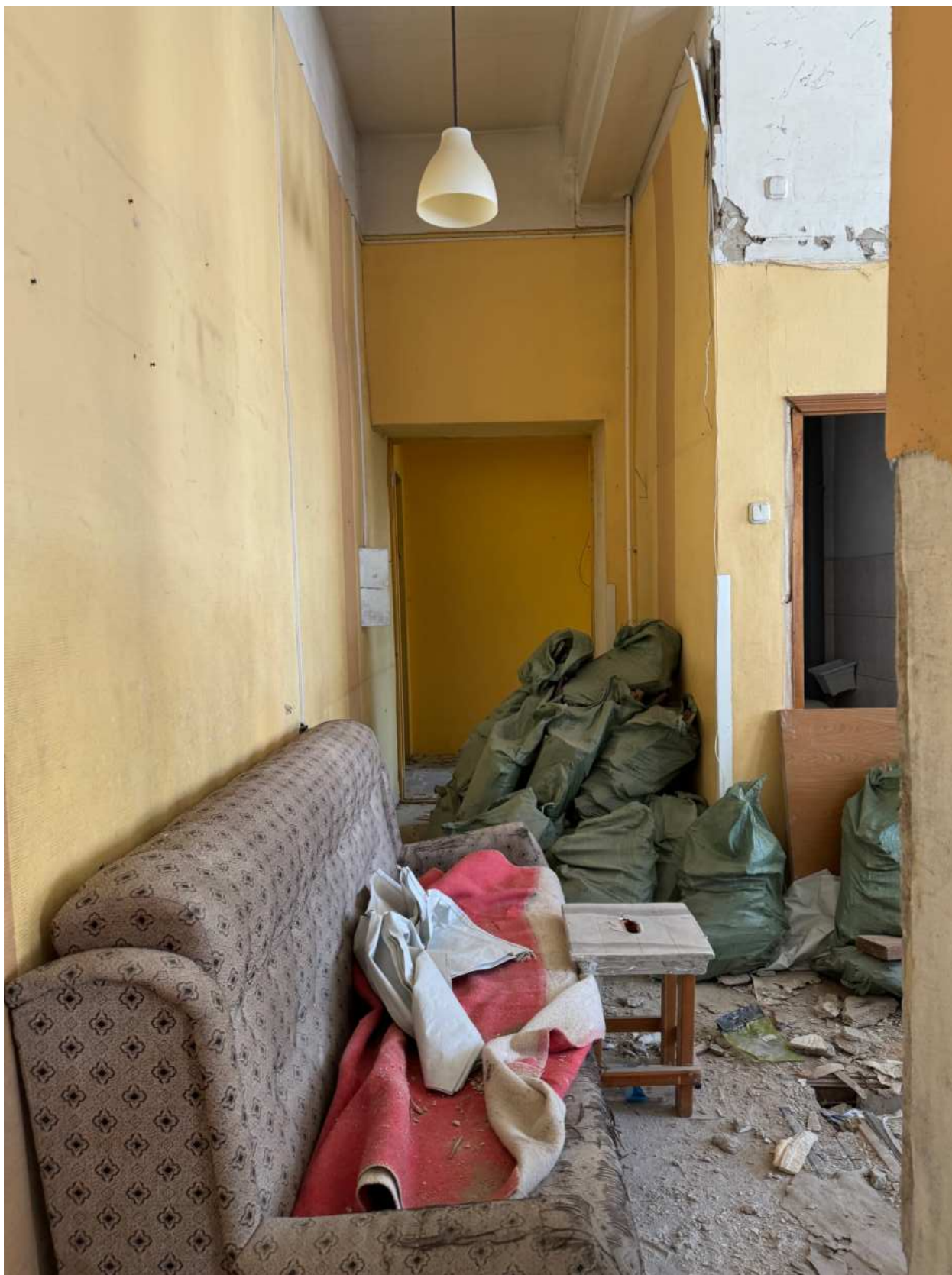
Фото 50. Вид на помещение квартир № 3-4 объекта культурного наследия.
