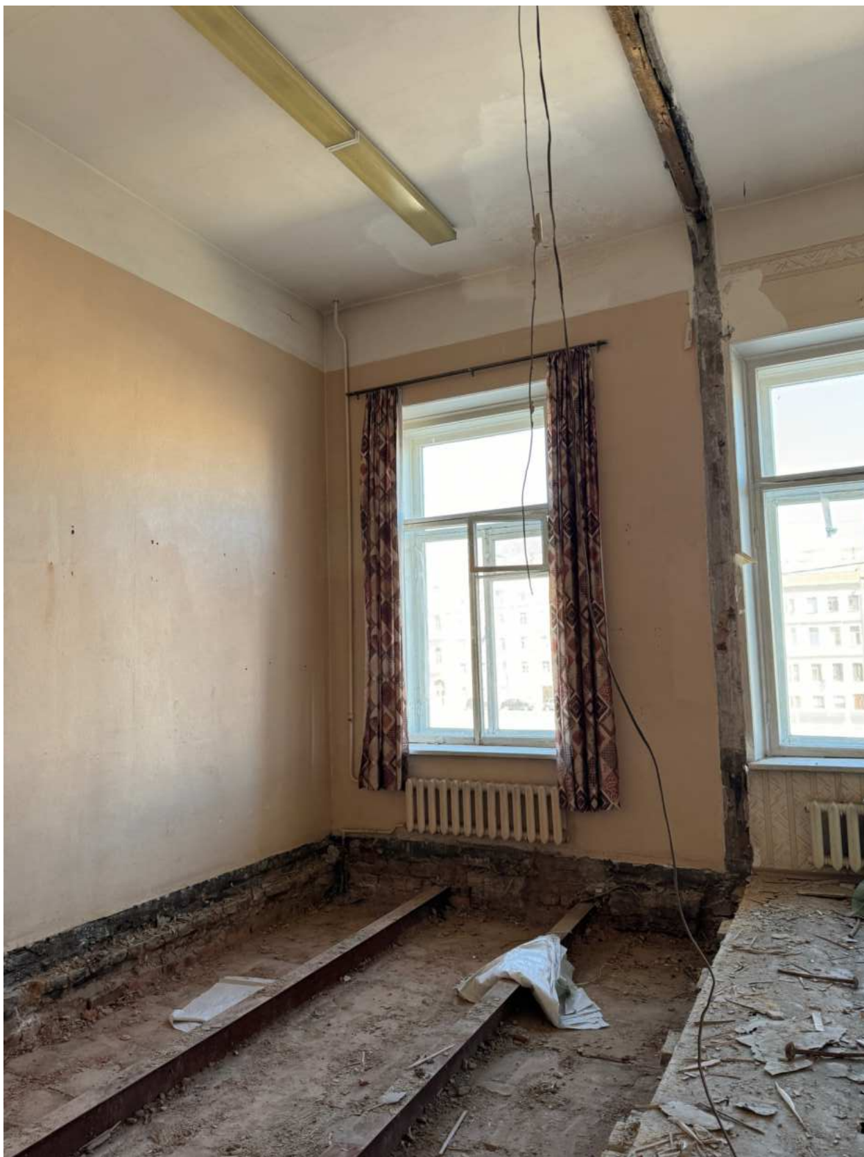
Фото 42. Вид на помещение квартир № 3-4 объекта культурного наследия.
