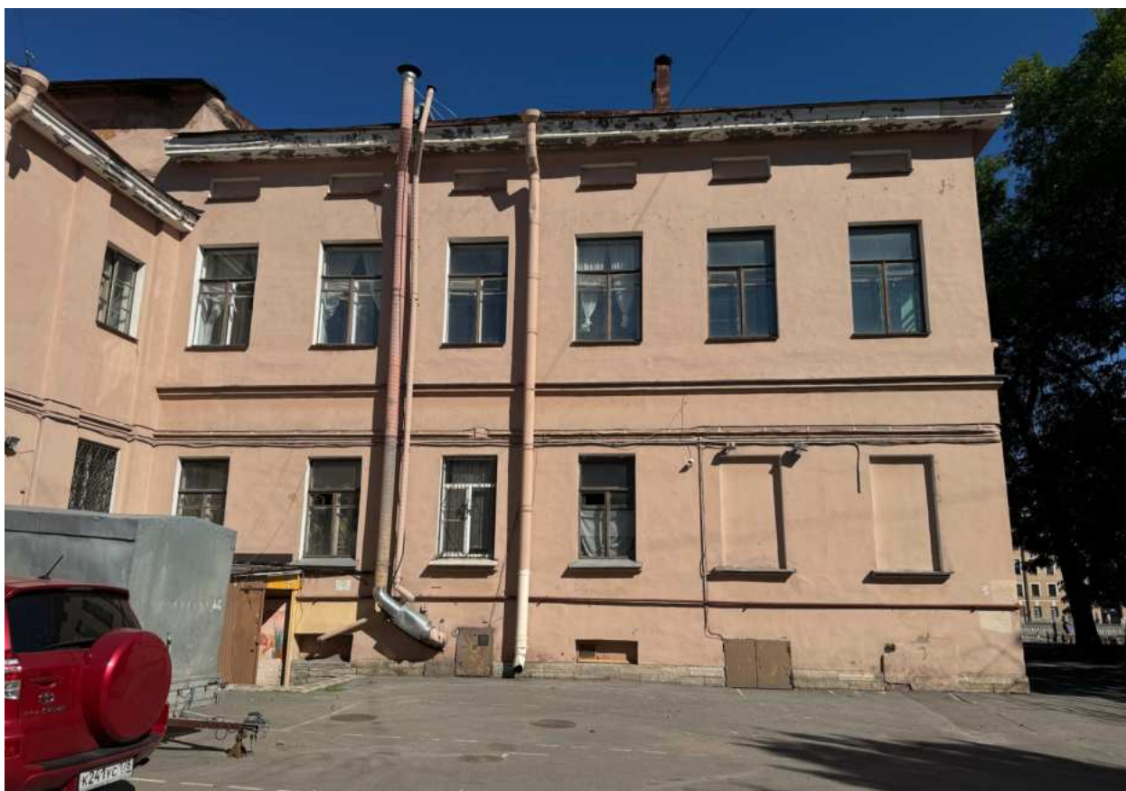
Фото 8. Вид на южный фасад объекта культурного наследия.
