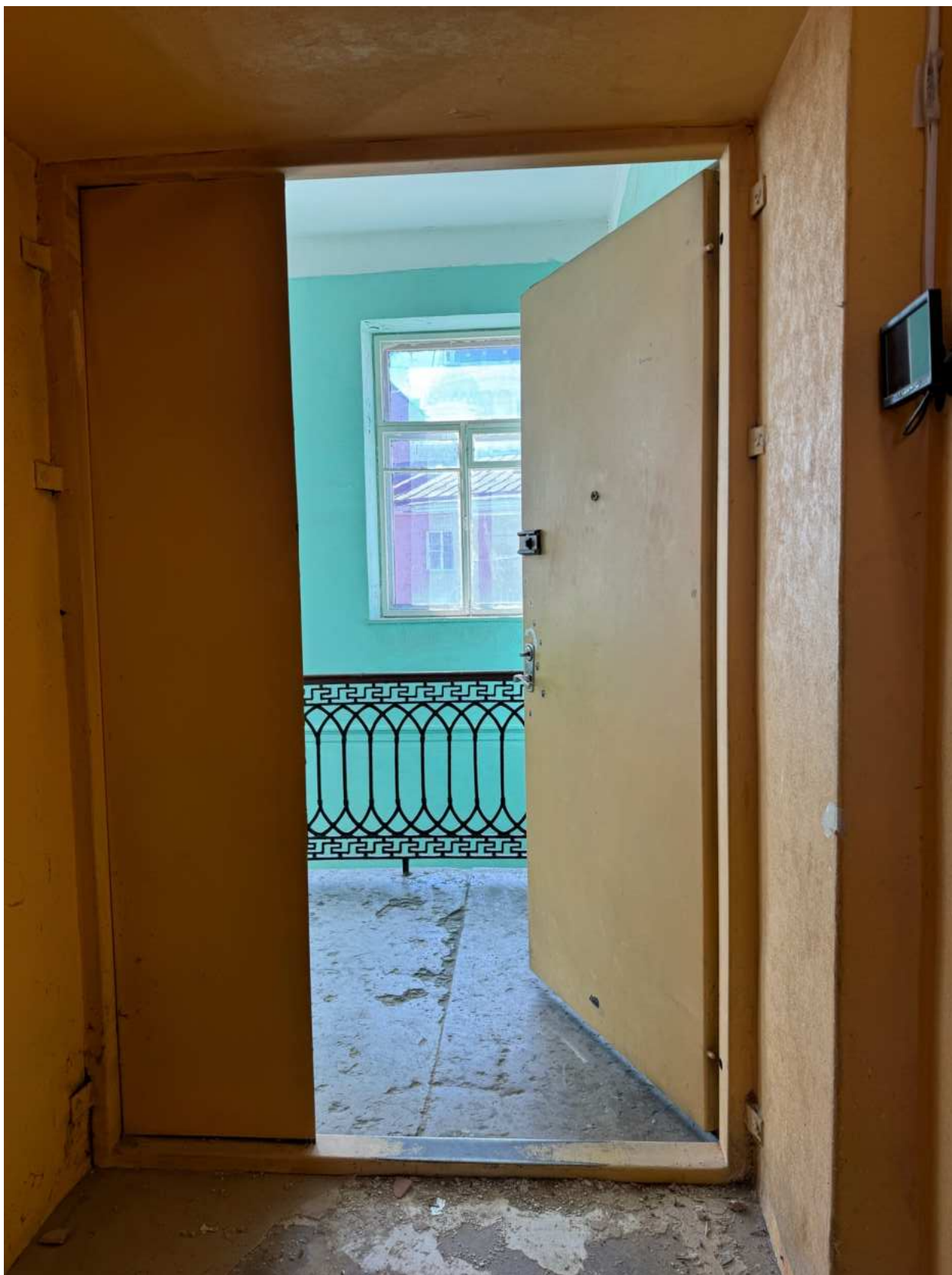
Фото 18. Вид на входное дверное заполнение квартир № 3-4 объекта культурного наследия.
