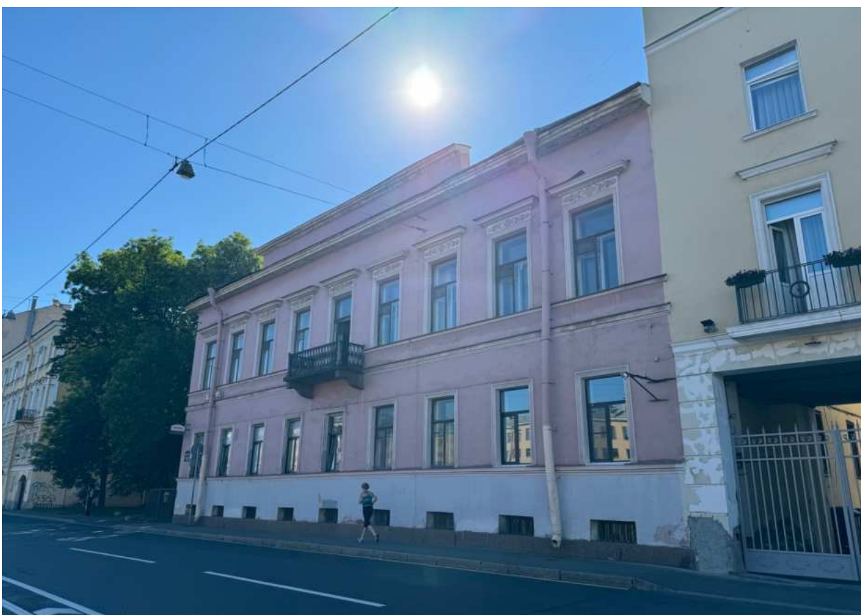
Фото 4. Лицевой фасад объекта культурного наследия по набережной реки Фонтанки.
