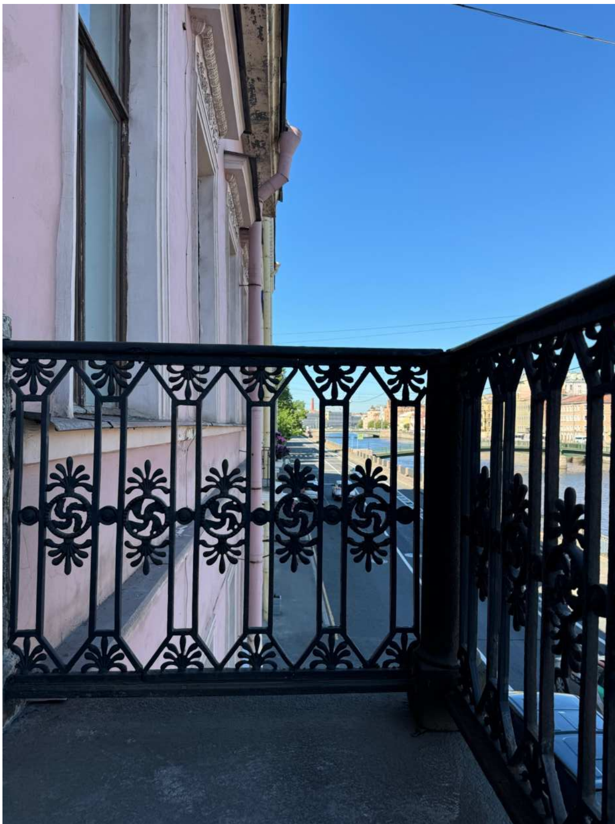
Фото 36. Вид на балконное ограждение квартир № 3-4 объекта культурного наследия.
