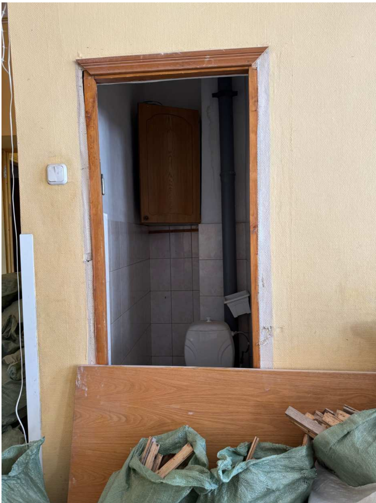
Фото 51. Вид на помещение квартир № 3-4 объекта культурного наследия.
