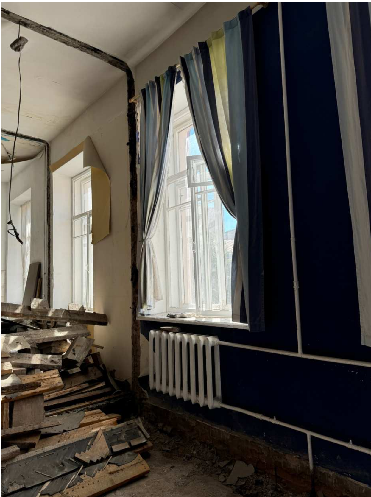
Фото 47. Вид на помещение квартир № 3-4 объекта культурного наследия.
