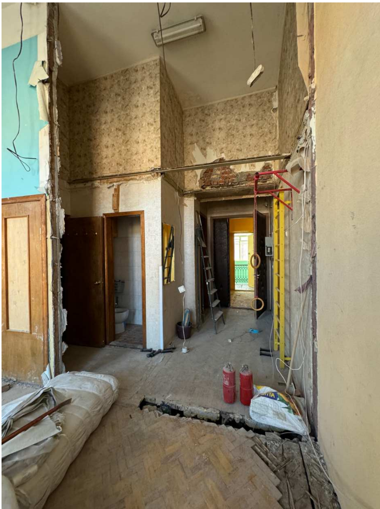
Фото 31. Вид на помещение квартир № 3-4 объекта культурного наследия.
