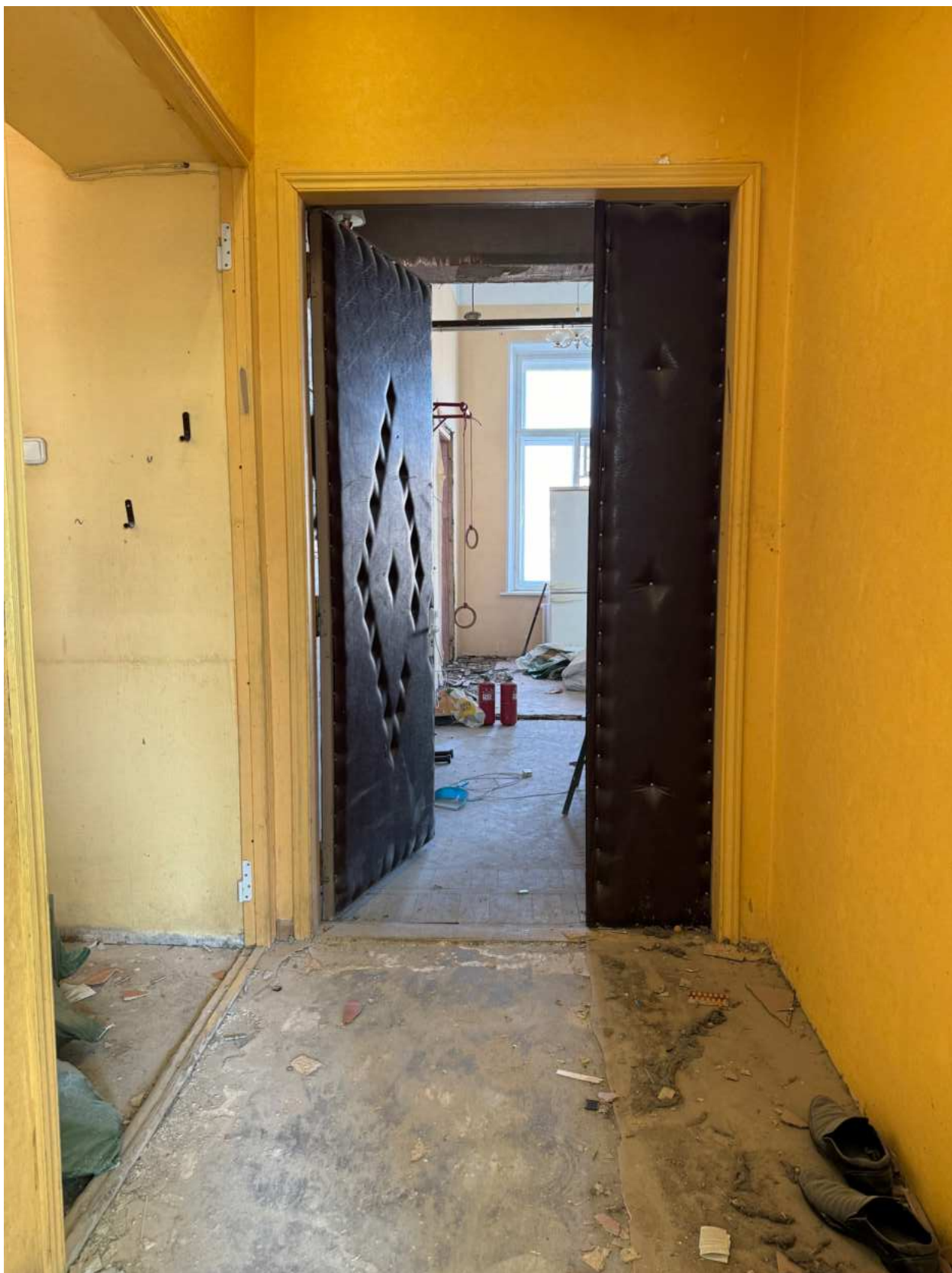
Фото 17. Вид на помещение квартир № 3-4 объекта культурного наследия.
