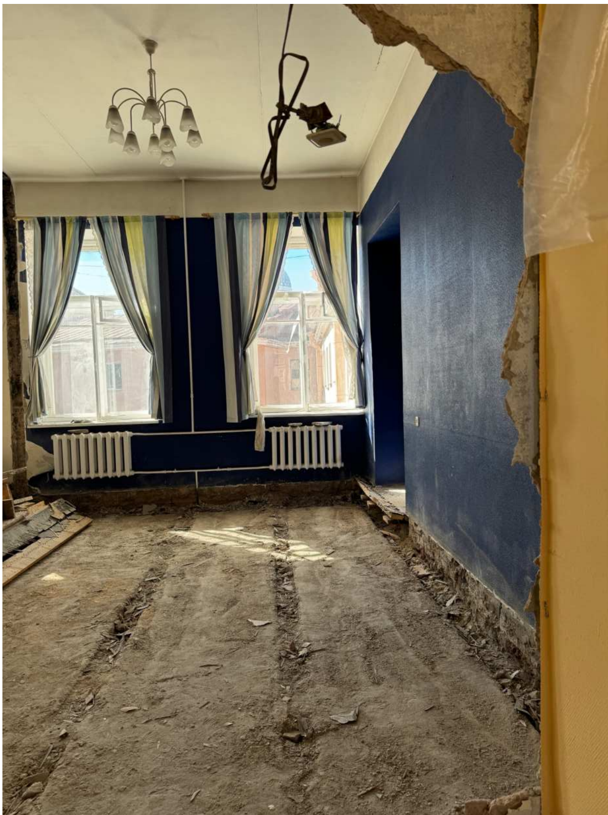
Фото 45. Вид на помещение квартир № 3-4 объекта культурного наследия.
