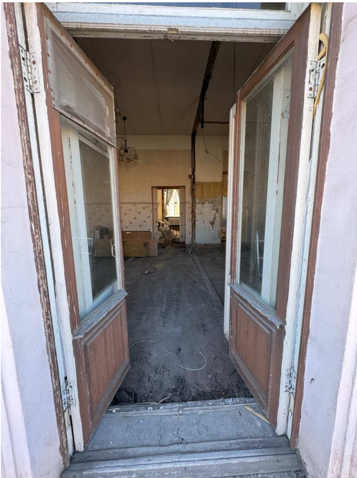
Фото 38. Вид на дверное заполнение балкона квартир № 3-4 объекта культурного наследия.
