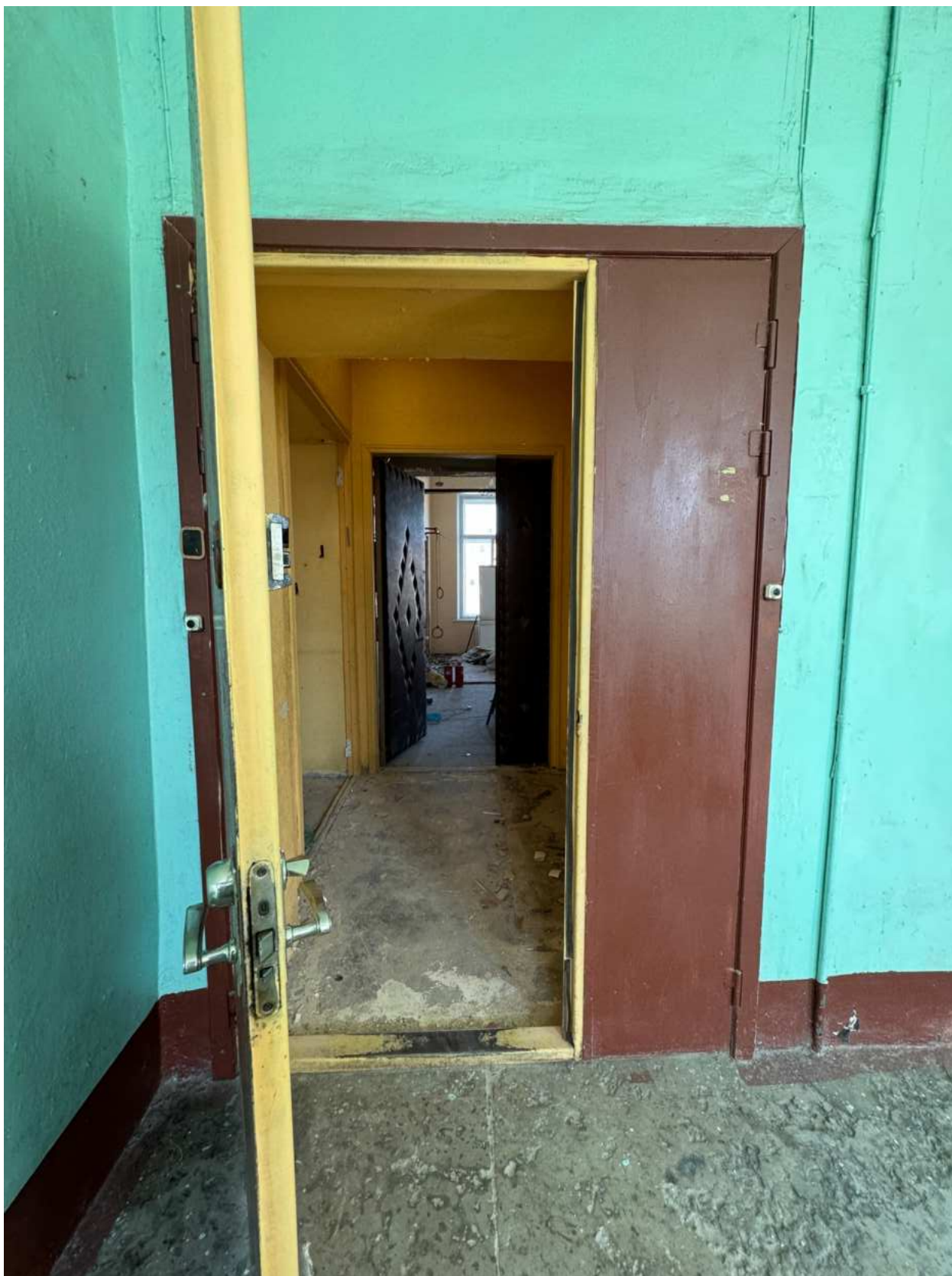
Фото 16. Вид на дверное заполнение, ведущее в квартиры № 3-4 объекта культурного наследия.
