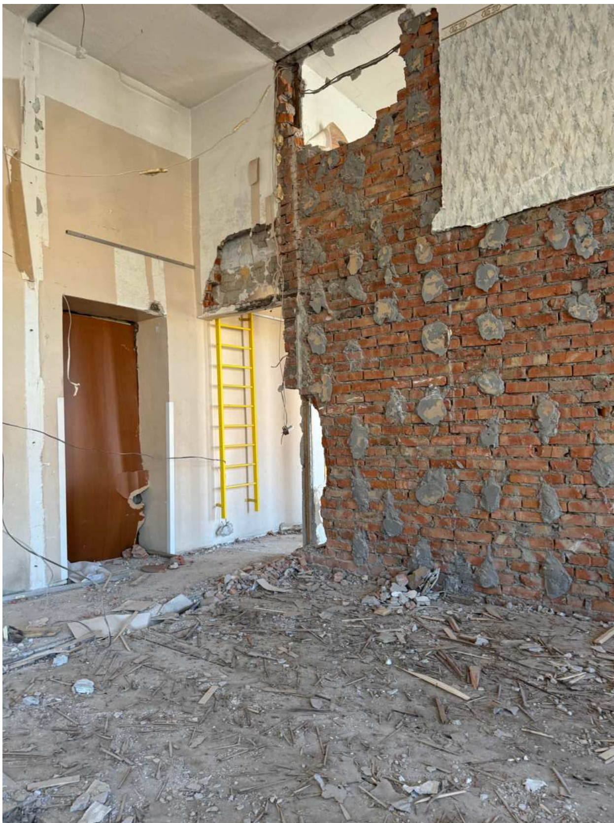
Фото 40. Вид на помещение квартир № 3-4 объекта культурного наследия.
