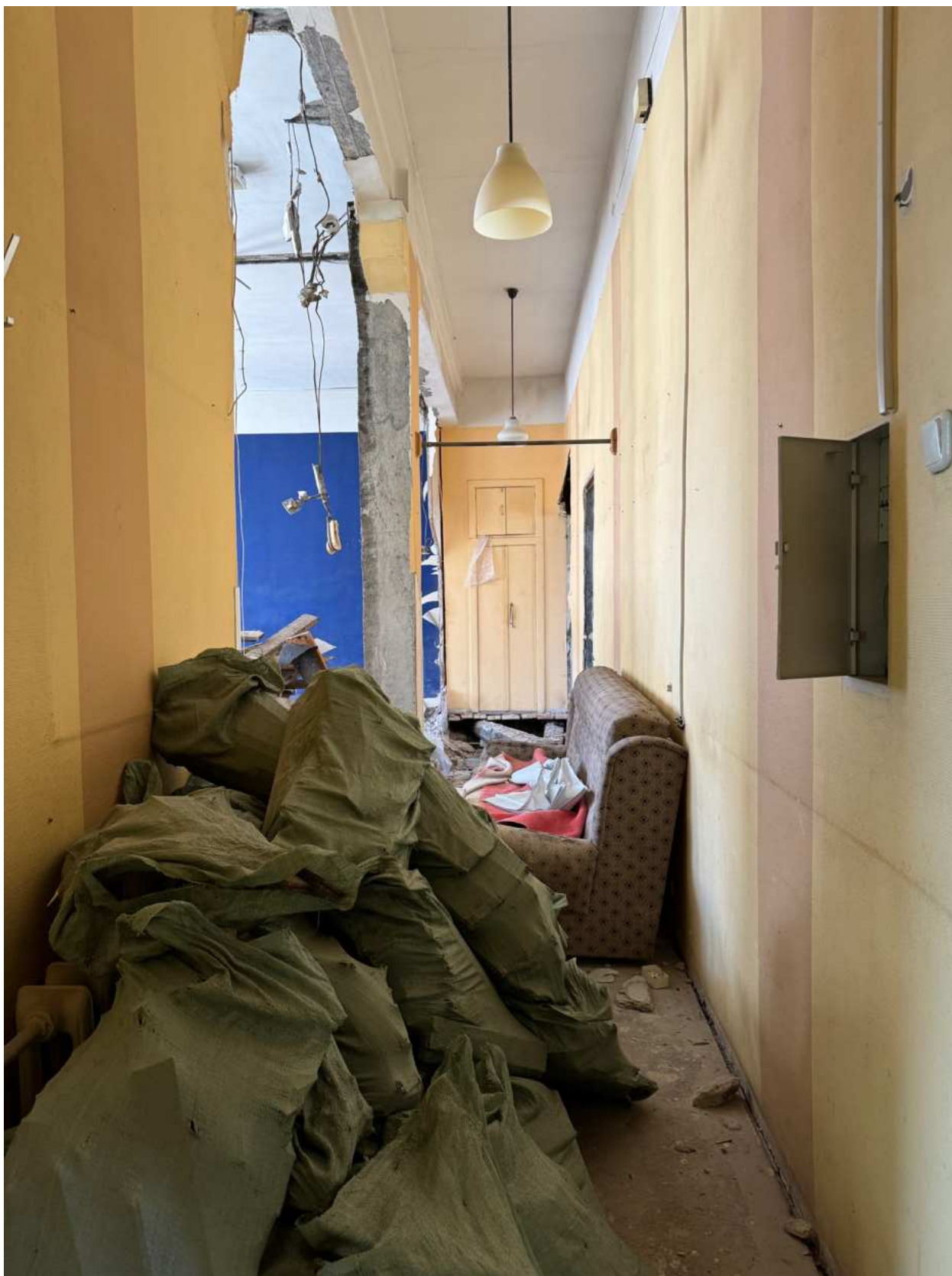
Фото 19. Вид на помещение квартир № 3-4 объекта культурного наследия.
