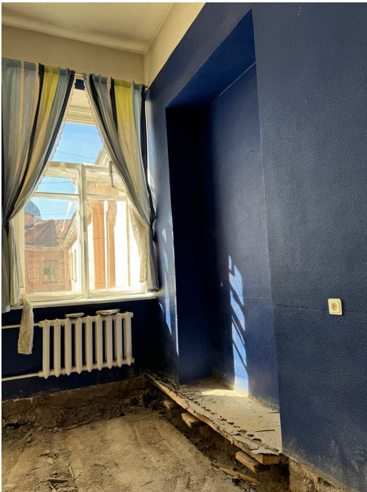
Фото 46. Вид на помещение квартир № 3-4 объекта культурного наследия.
