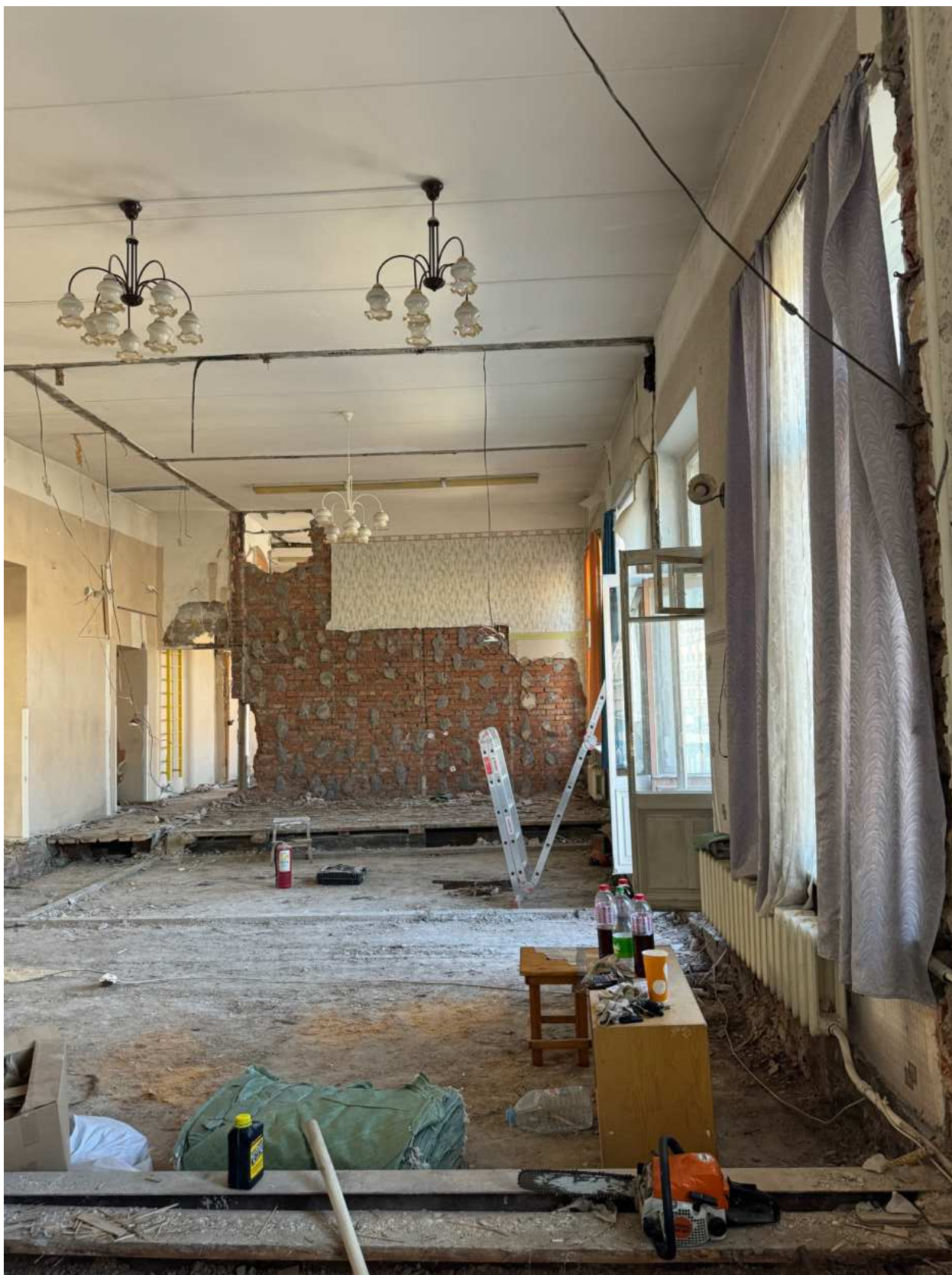
Фото 32. Вид на помещение квартир № 3-4 объекта культурного наследия.
