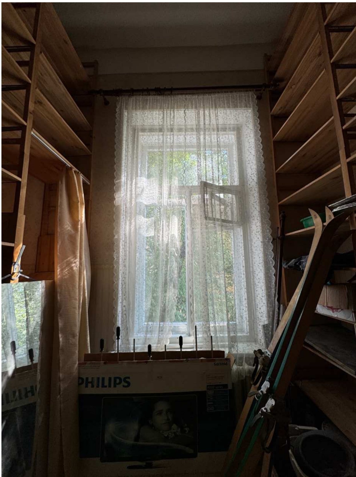
Фото 22. Вид на помещение квартир № 3-4 объекта культурного наследия.
