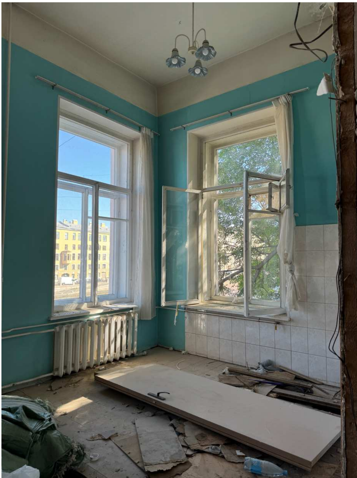
Фото 25. Вид на помещение квартир № 3-4 объекта культурного наследия.
