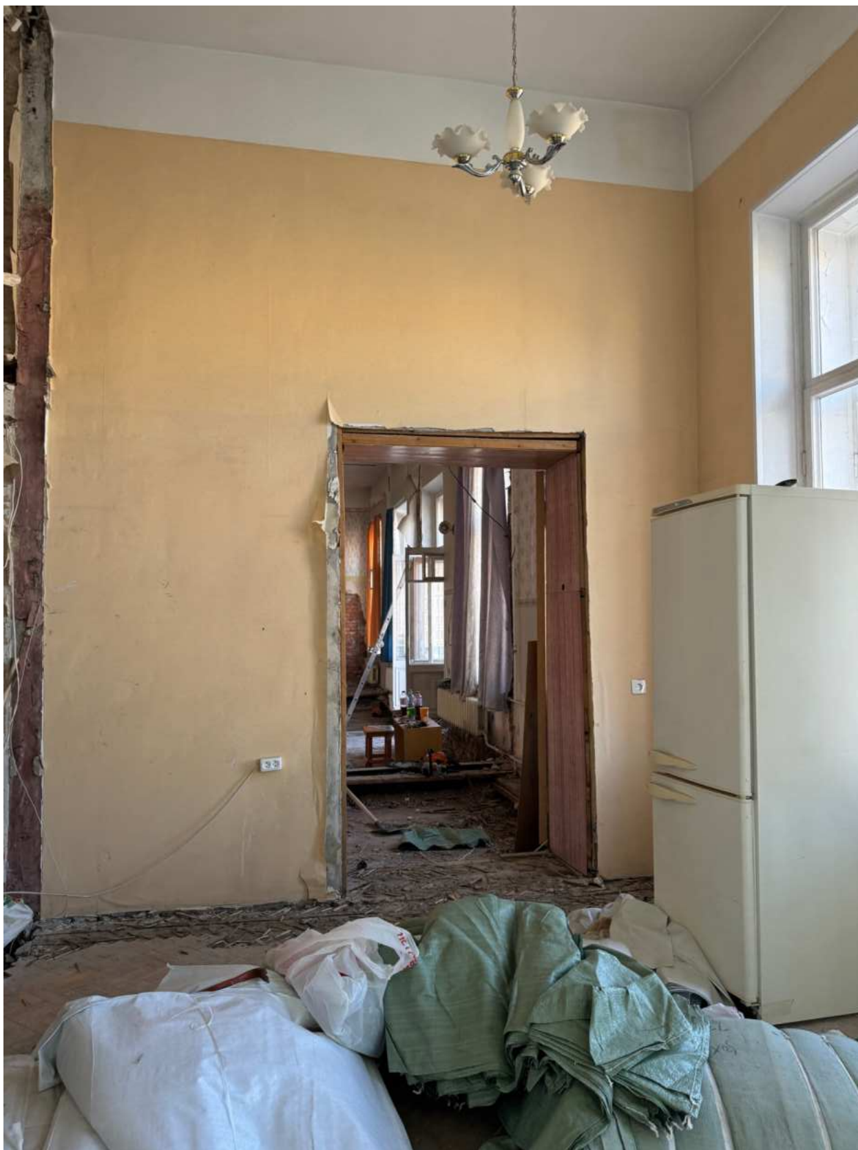
Фото 28. Вид на помещение квартир № 3-4 объекта культурного наследия.
