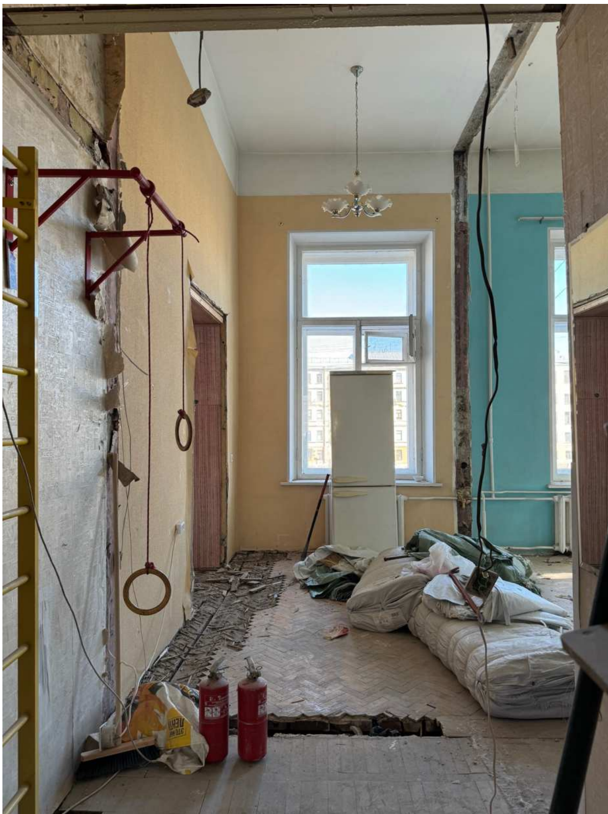
Фото 23. Вид на помещение квартир № 3-4 объекта культурного наследия.
