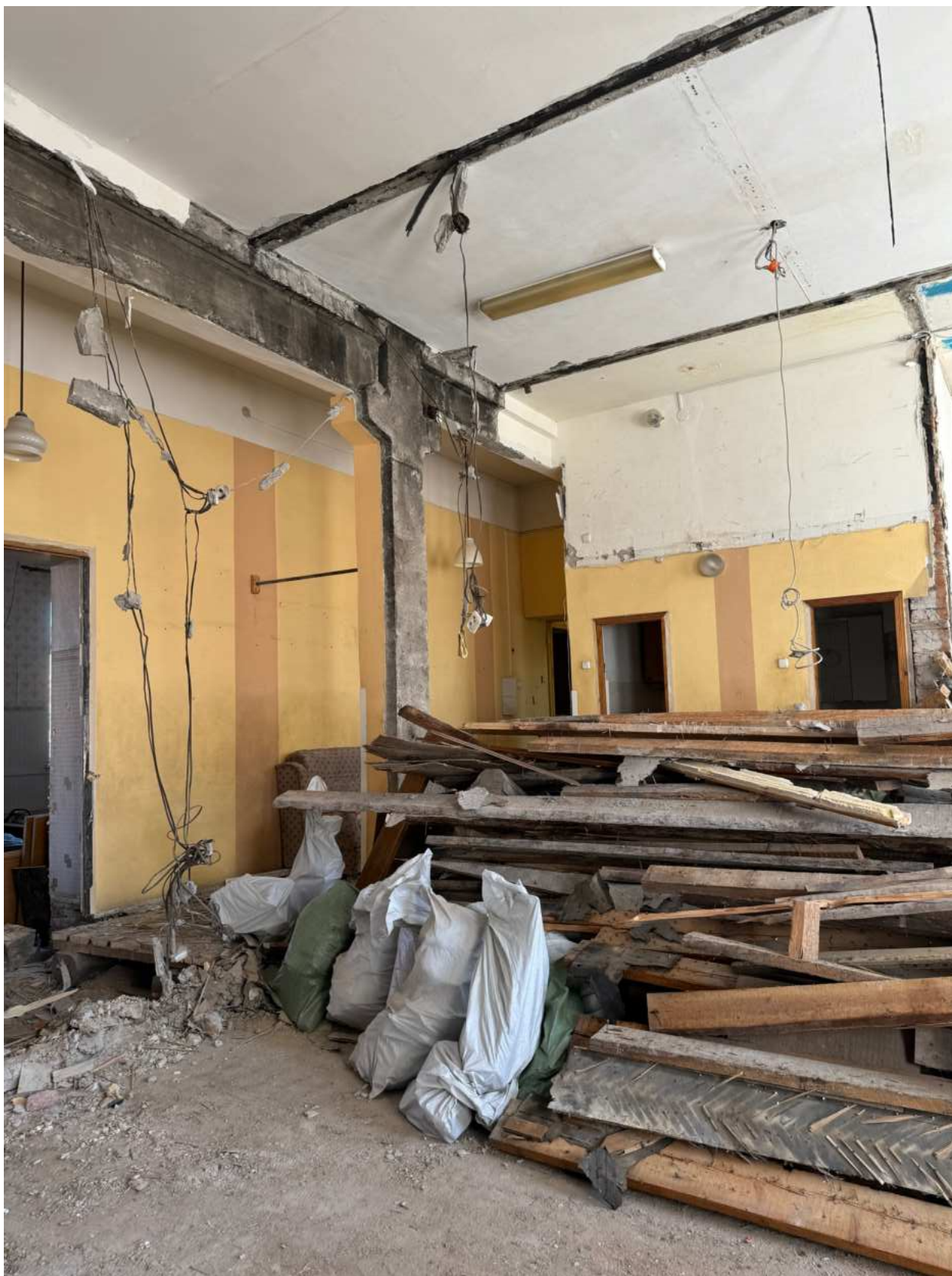
Фото 49. Вид на помещение квартир № 3-4 объекта культурного наследия.
