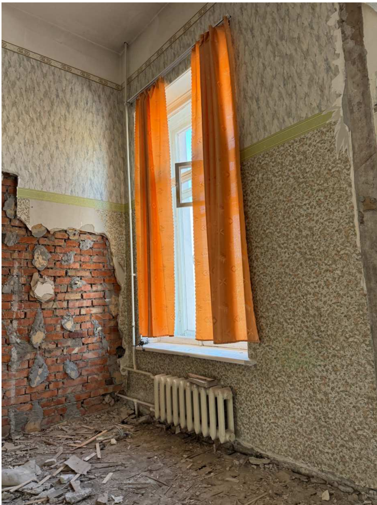
Фото 39. Вид на помещение квартир № 3-4 объекта культурного наследия.
