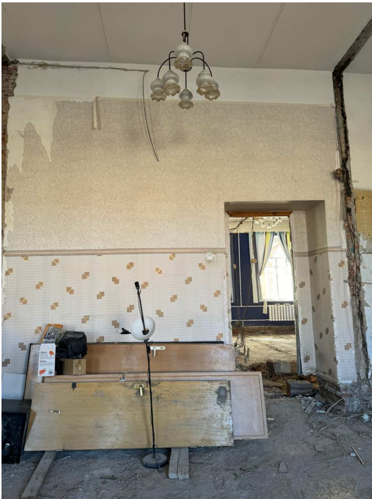
Фото 34. Вид на помещение квартир № 3-4 объекта культурного наследия.
