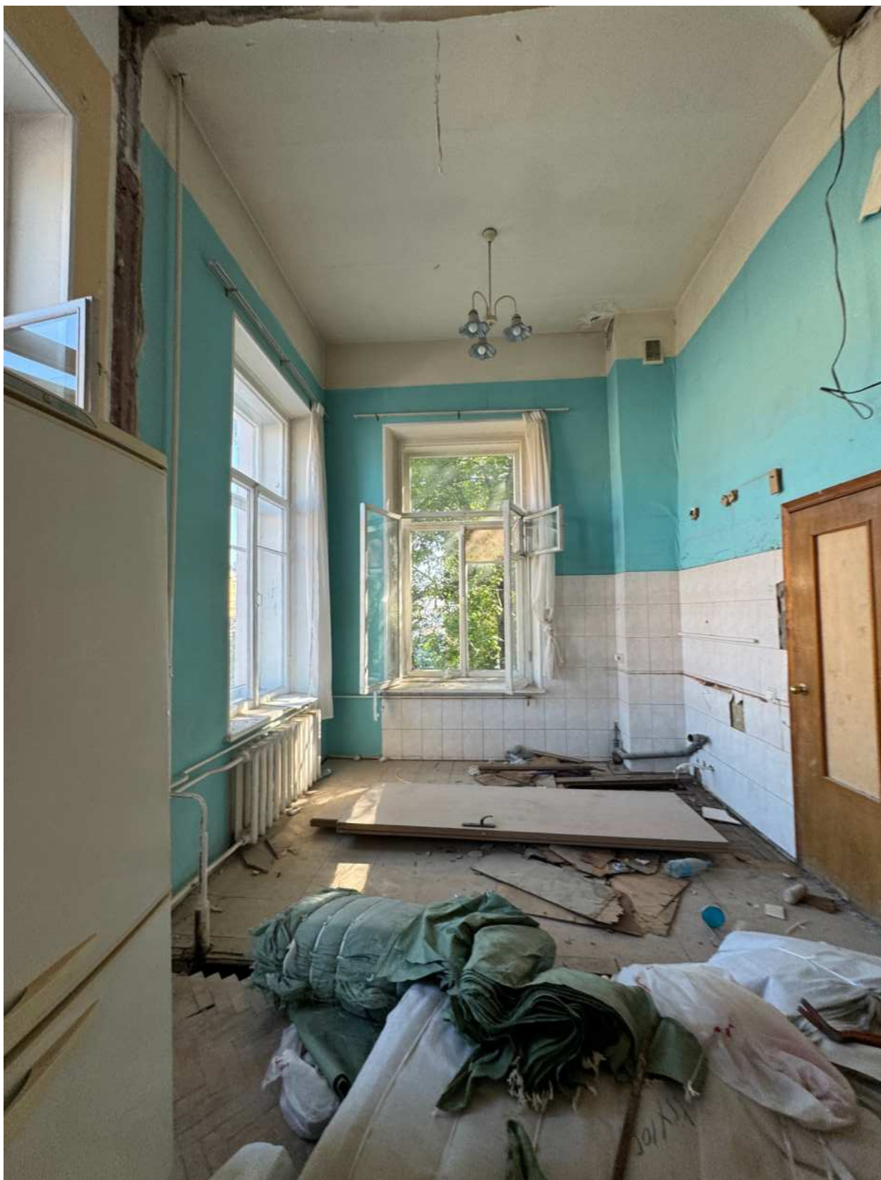
Фото 30. Вид на помещение квартир № 3-4 объекта культурного наследия.
