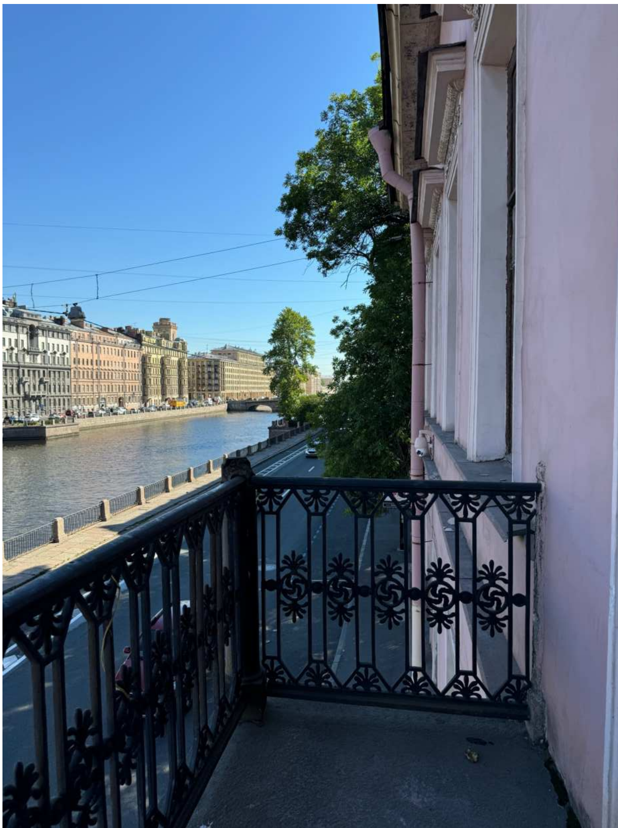
Фото 37. Вид на балконное ограждение квартир № 3-4 объекта культурного наследия.
