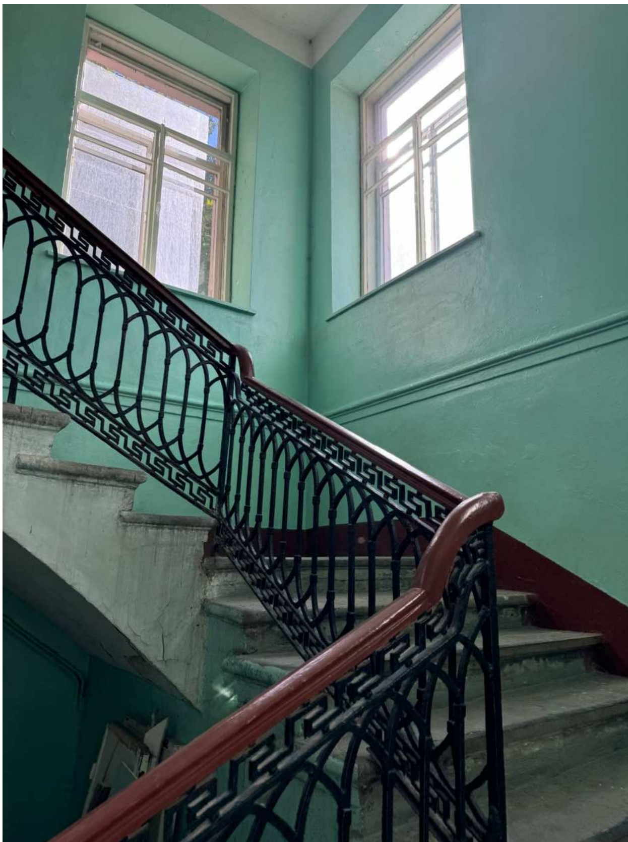
Фото 14. Интерьер лестницы парадной объекта культурного наследия.
