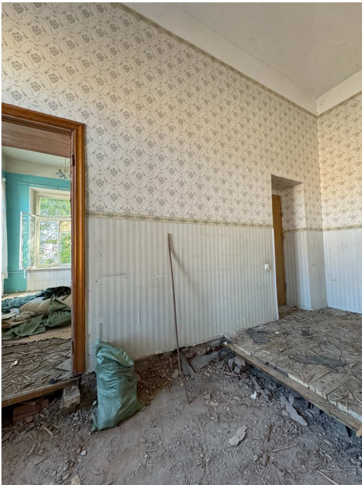
Фото 33. Вид на помещение квартир № 3-4 объекта культурного наследия.
