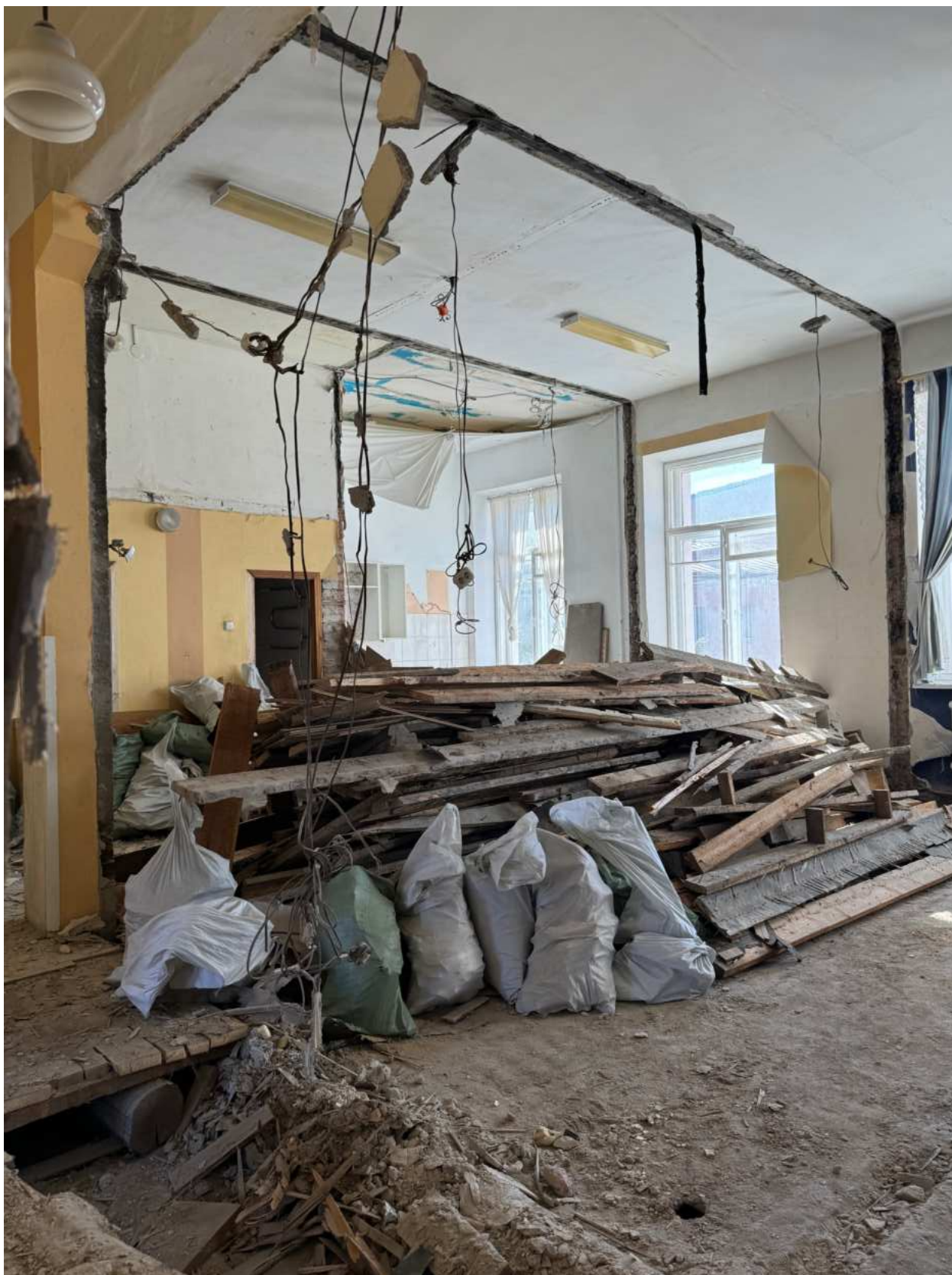
Фото 44. Вид на помещение квартир № 3-4 объекта культурного наследия.
