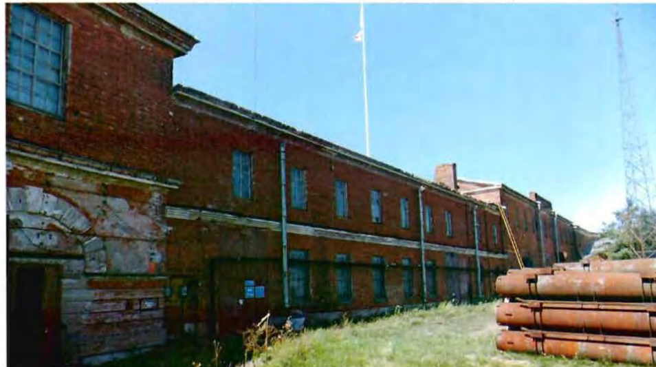
5. Правифланговая куртина с надстроенными объемами (северный фасад).
