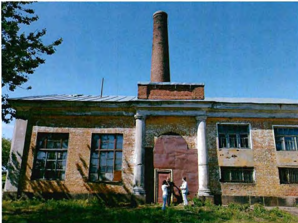
10. Котельная (восточный фасад).
