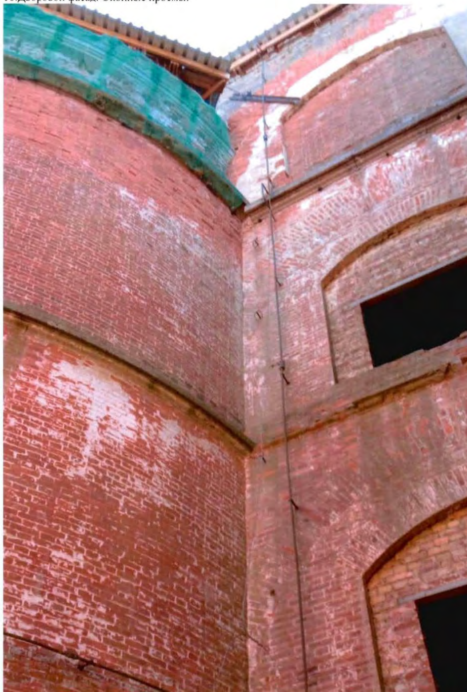
16. Дворовой фасад. Оконные проемы.
