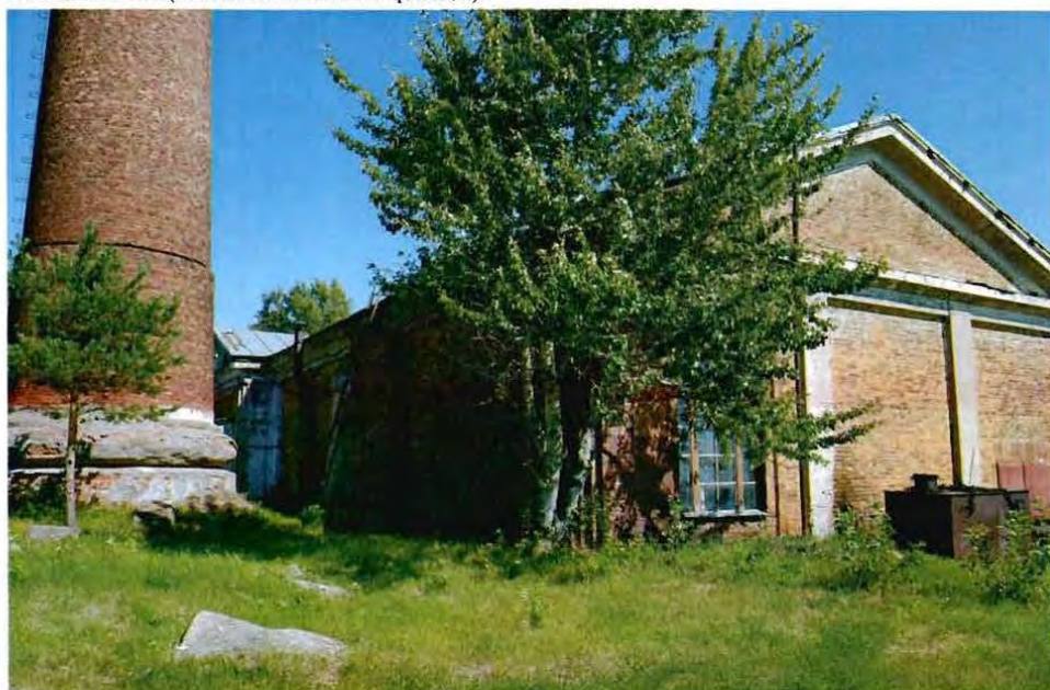
11. Котельная (западный и южный фасады).
