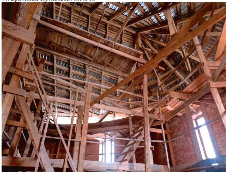
14. Временная стропильная система.
