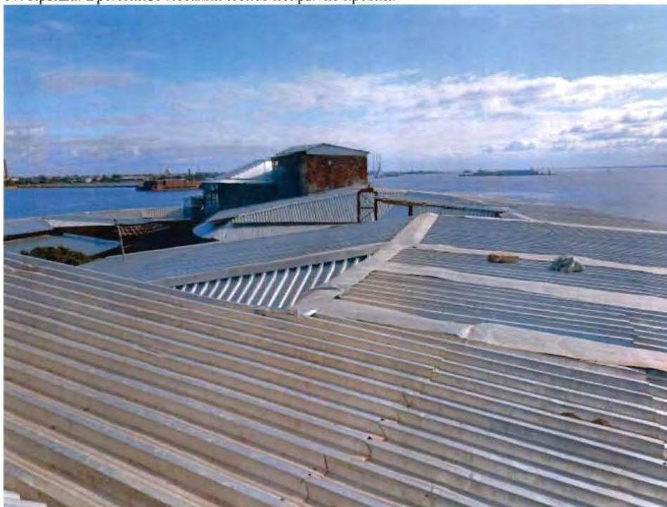
18. Крыша. Временное металлическое покрытие кровли и полубашня.
