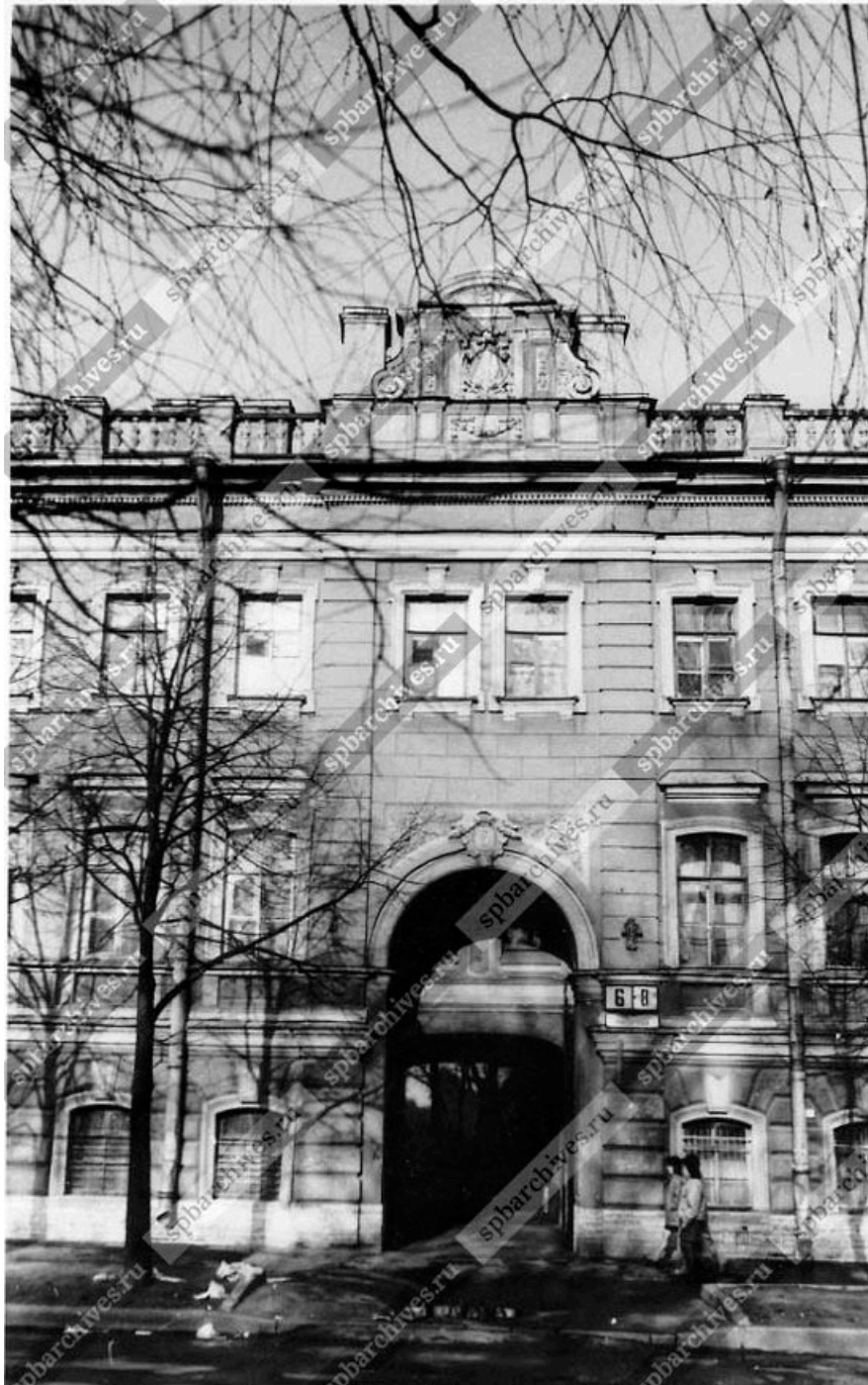
Илл. 16. Вид части центрального фасада с арочным въездом во двор дома № 6-8 на улице Писарева (бывший запасной дом великого князя Павла Александровича, архитектор В.П. Слупский, 1889-1891 гг.). 9 мая 1992 г. ЦГАКФФД СПб. Фотодокументы. Опись 1АР-157. Ед. хр. 225151.
