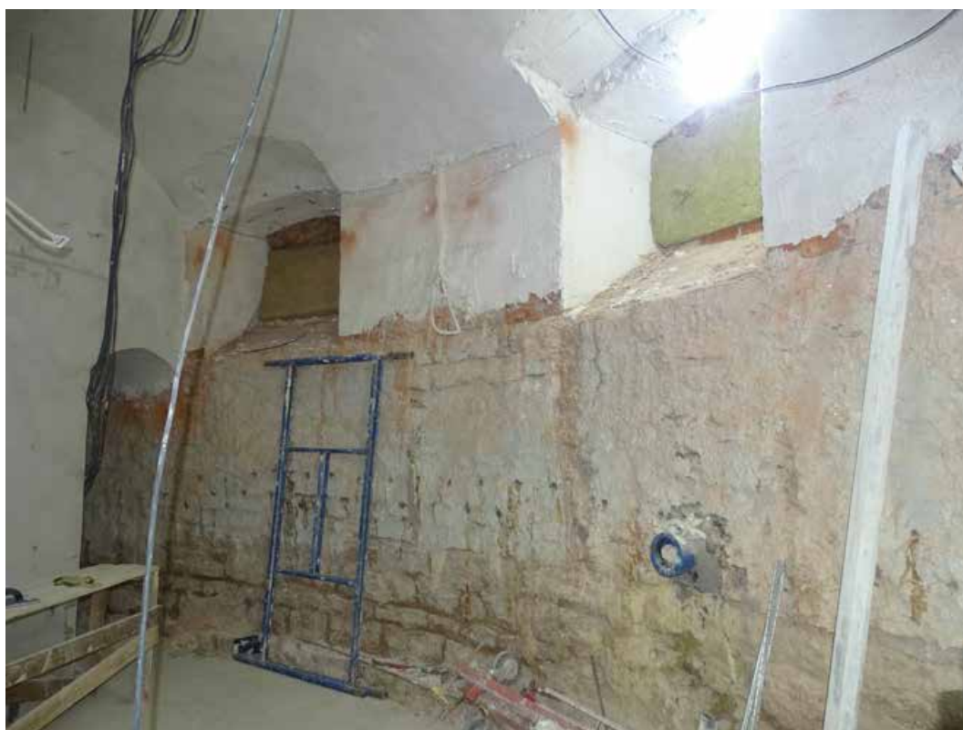
Фото 4. Помещение подвала. Съемка 01.10.2024 г. Полетайкин В.В.
