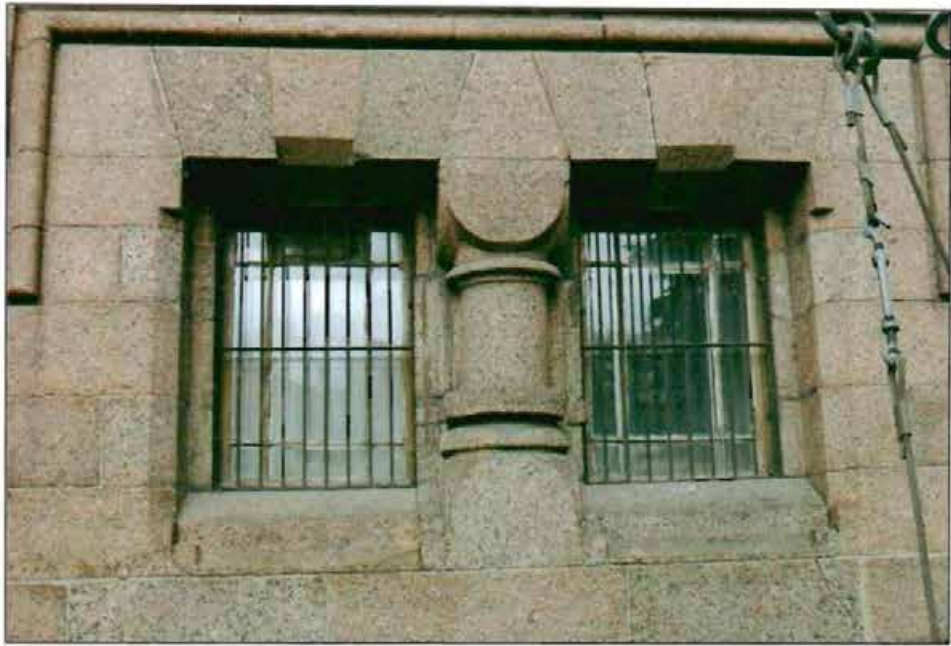
8. Южный фасад. Фрагмент. Окна притвора первого яруса.
