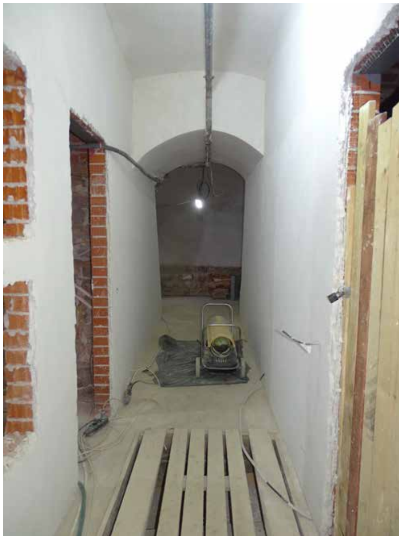
Фото 7. Помещение подвала. Съемка 01.10.2024 г. Полетайкин В.В.
