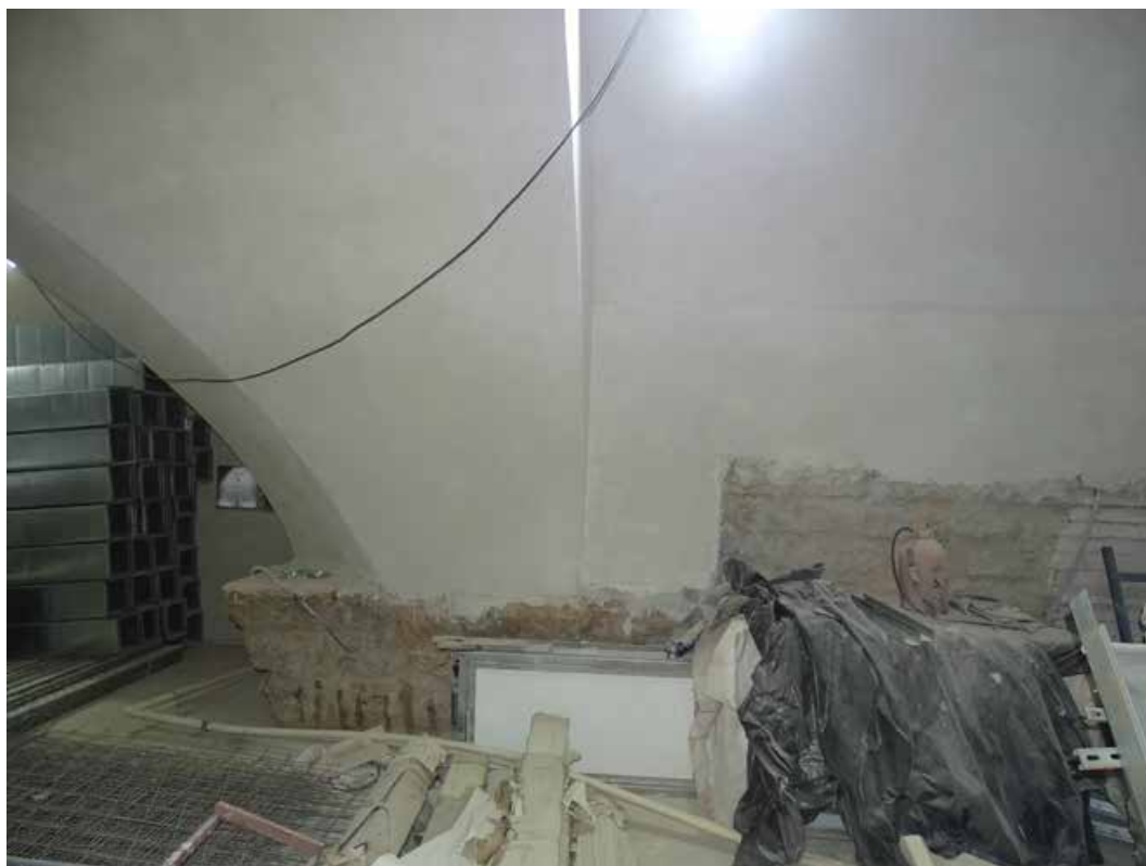
Фото 3. Помещение подвала. Съемка 01.10.2024 г. Полетайкин В.В.
