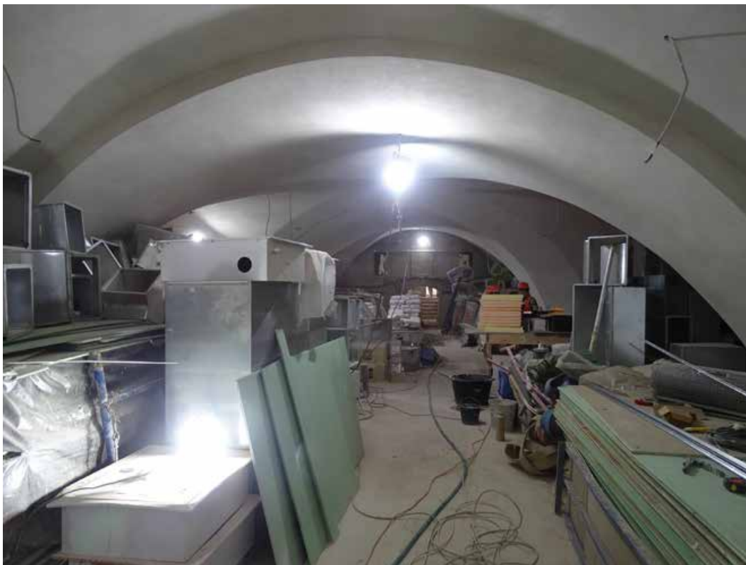
Фото 1. Помещение подвала. Съемка 01.10.2024 г. Полетайкин В.В.
