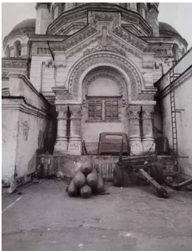
53. Церковь Божией Матери Милующей. Входной портал северного придела. Фотография 1999 г. Фотограф: В. Ф. Егоровский. КГИОП. П-356. Л. 25.
