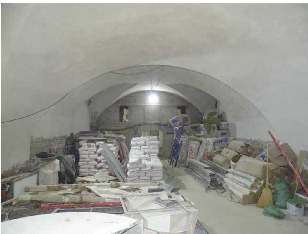
Фото 2. Помещение подвала. Съемка 01.10.2024 г. Полетайкин В.В.
