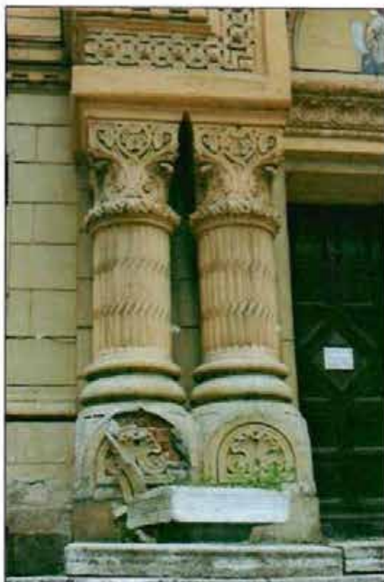
10. Западный фасад. Фрагмент.
