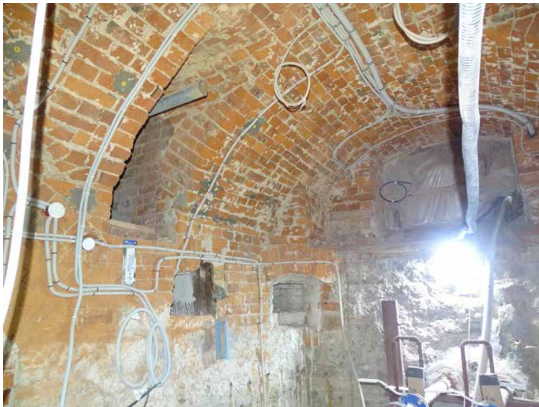
Фото 5. Помещение подвала. Съемка 01.10.2024 г. Полетайкин В.В.
