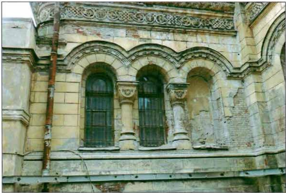
9. Западный фасад. Фрагмент.
