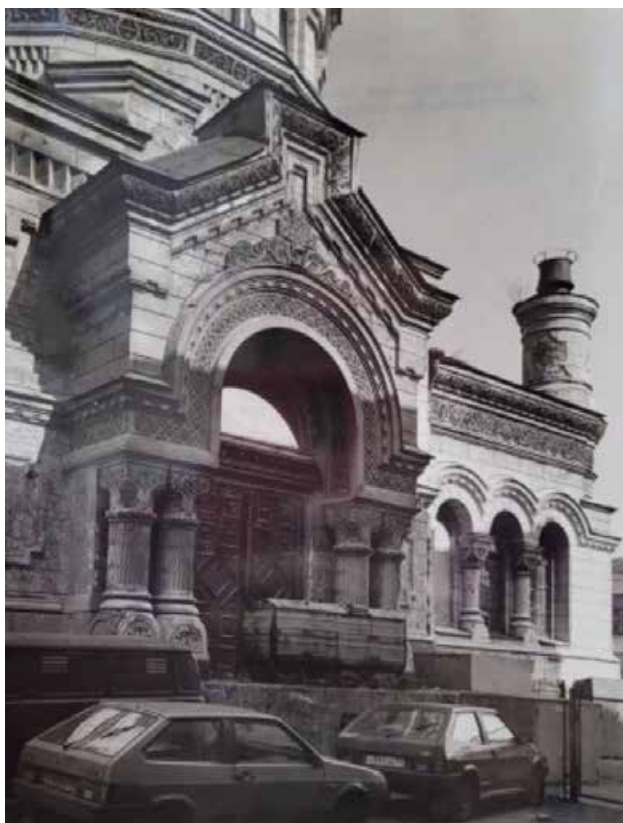
51. Церковь Божией Матери Милующей. Фасад южного придела. Входной портал. Фотография 1999 г. Фотограф: В. Ф. Егоровский. КГИОП. П-356. Л. 23.
