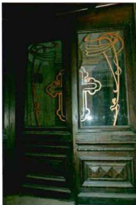
22. Интерьер. Фрагмент. Входные двери тамбура притвора.
