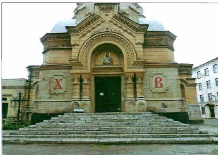
5. Западный фасад. Фрагмент.
