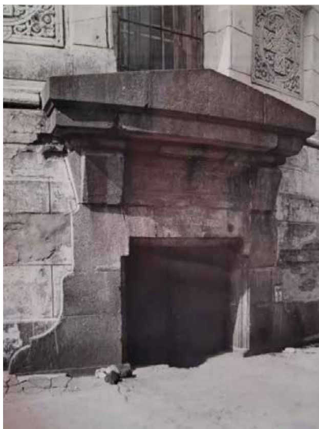
52. Церковь Божией Матери Милующей. Дверь входа в портал апсиды с обрамлением из гранита. Фотография 1999 г. Фотограф: В. Ф. Егоровский. КГИОП. П-356. Л. 24.
