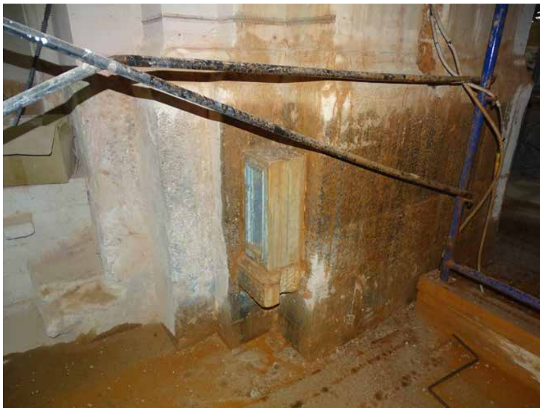
Фото 13. 1-й этаж. Фрагмент отделки. Съемка 01.10.2024 г. Полетайкин В.В.
