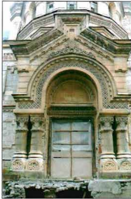
6. Южный фасад. Фрагмент.
