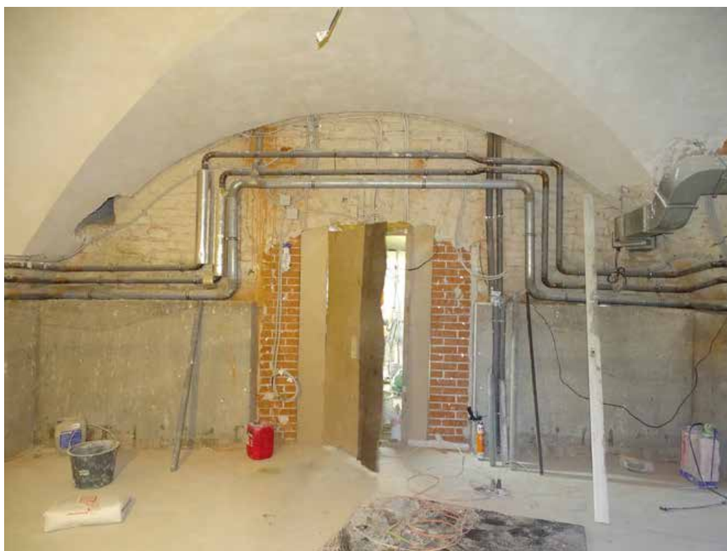
Фото 6. Помещение подвала. Съемка 01.10.2024 г. Полетайкин В.В.
