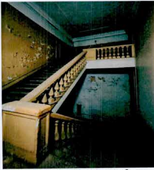
25. Лестница с ограждением в виде балясин.
