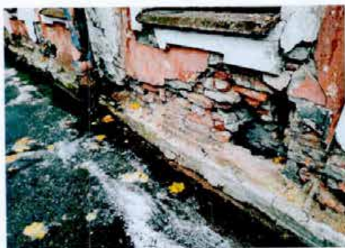
13. Фрагмент восточного фасада.
