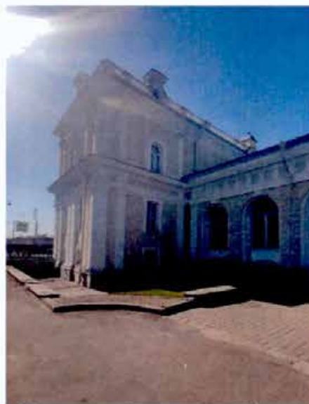
5. Фрагмент северо-восточного фасада объекта культурного наследия.
