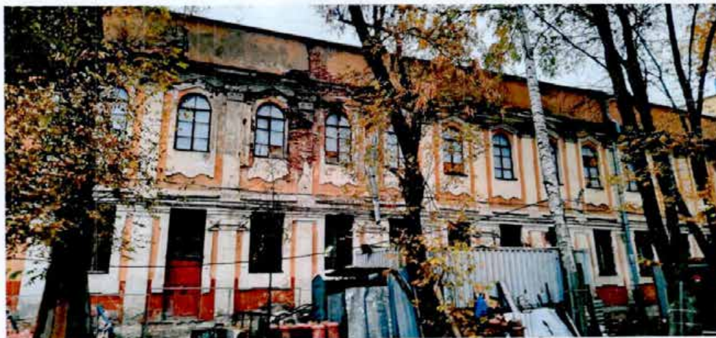
17. Фрагмент дворового фасада.
