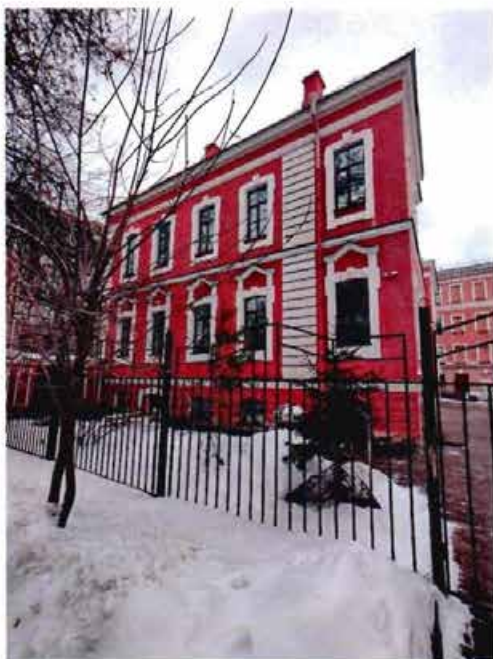
4. Общий вид на юго-восточный фасад объекта культурного наследия.
