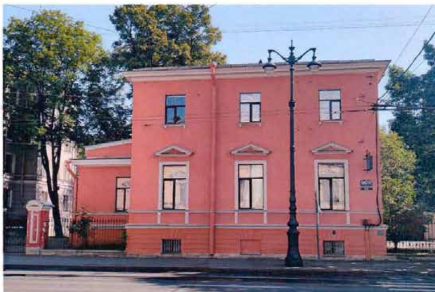
1. Лицевой фасад объекта культурного наследия.
