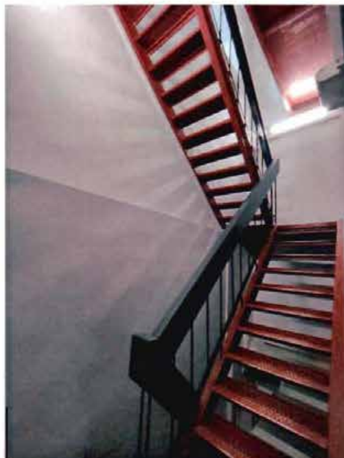
10. Лестница объекта культурного наследия.
