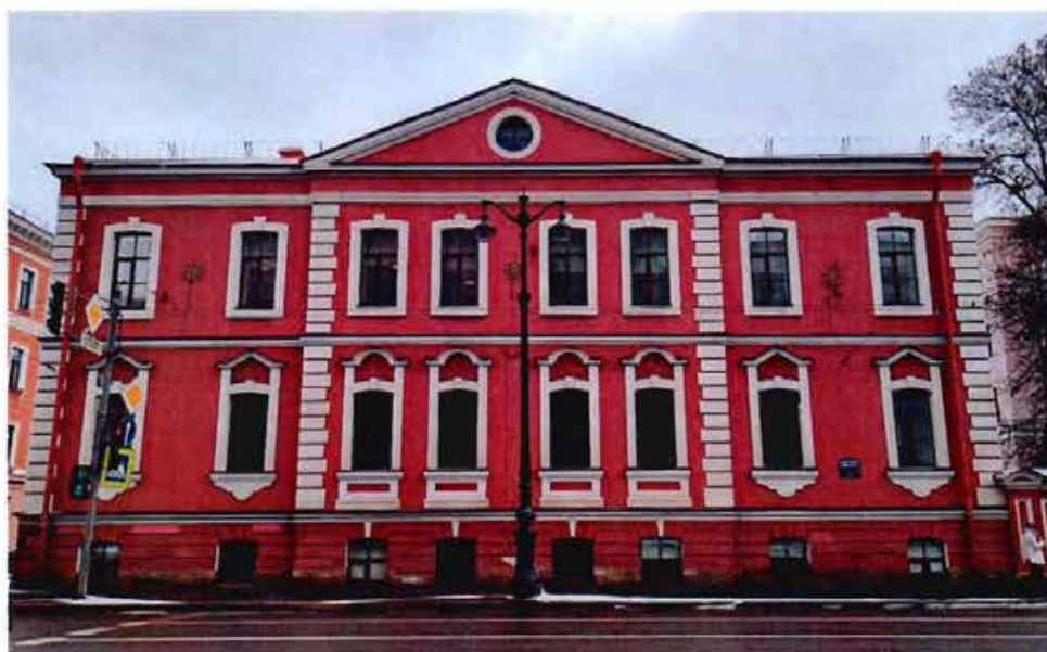
1. Общий вид на юго-западный фасад объекта культурного наследия.
