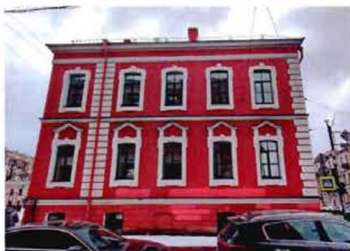
2. Общий вид на северо-западный фасад объекта культурного наследия.
