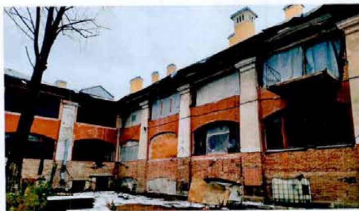
18. Фрагмент дворового фасада.
