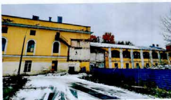
15. Фрагмент восточного фасада.
