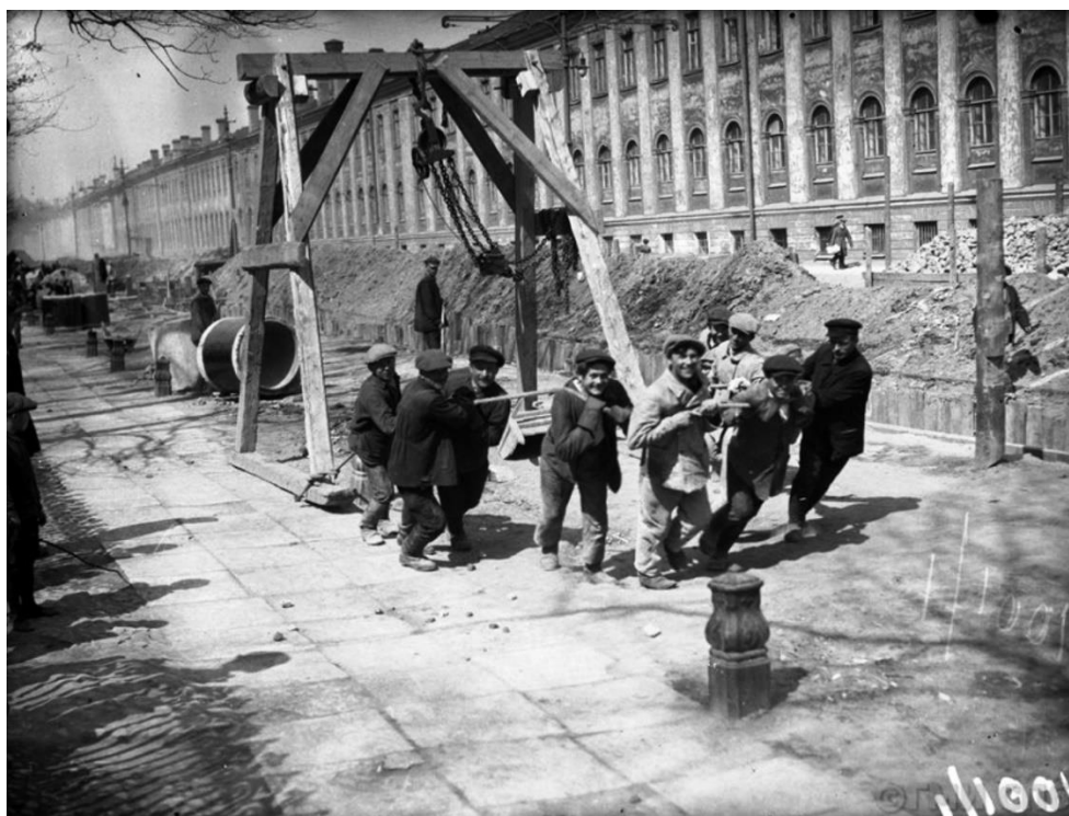
15. Первый Кадетский корпус. Вид со стороны Съездовской (Кадетской) линии. Канализационные работы на Съездовской линии. Фотография 1930 – 1935 гг. Приведено на: https://www.citywalls.ru/
