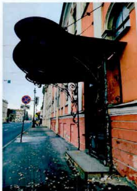
8. Фрагмент западного фасада. Козырек на кронштейнах.
