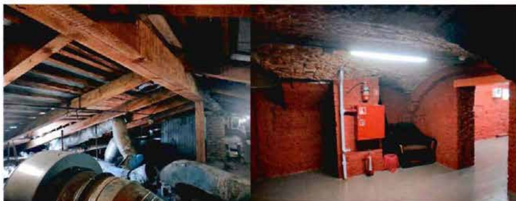
5. Стропильная система объекта культурного наследия.
