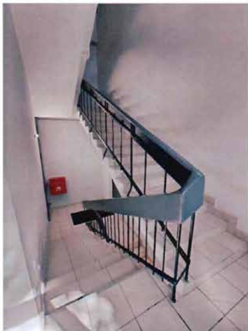
9. Лестница объекта культурного наследия.
