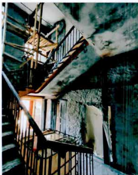
35. Крайняя лестница восточного корпуса. Усиление конструкций.
