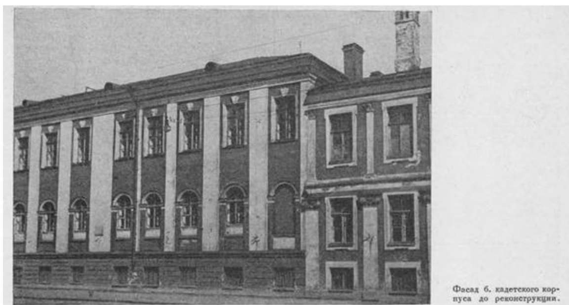
17. Фасад б. Первого Кадетского корпуса до реконструкции. Фотография. 1930-х гг. Опубликовано в: Архитектура Ленинграда. 1937. № 2. С. 72.
