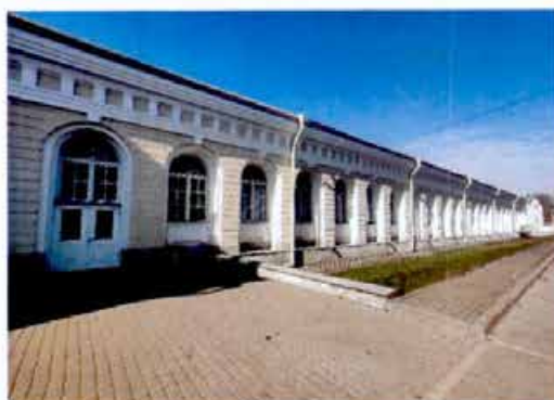
6. Фрагмент северо-восточного фасада объекта культурного наследия.
