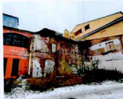
16. Фрагмент дворового фасада.
