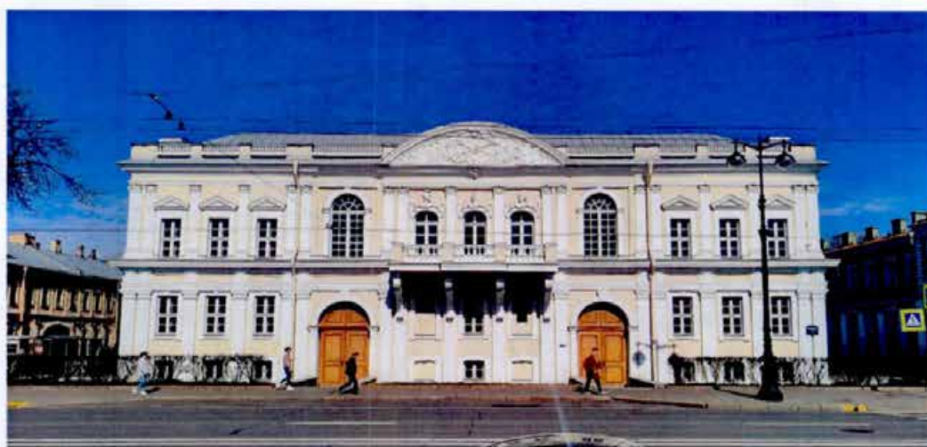
1.Общий вид на южный фасад объекта культурного наследия.
