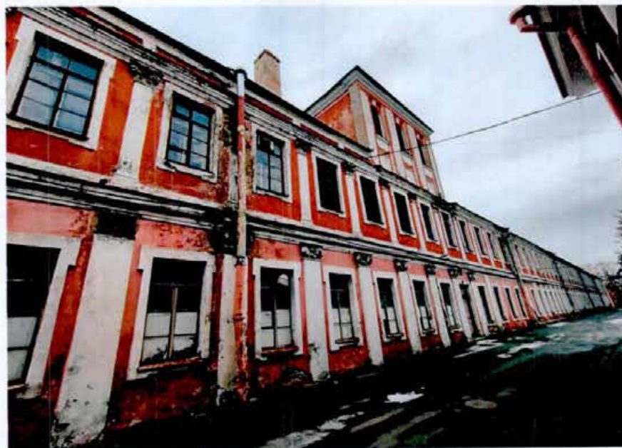
12. Фрагмент восточного фасада.
