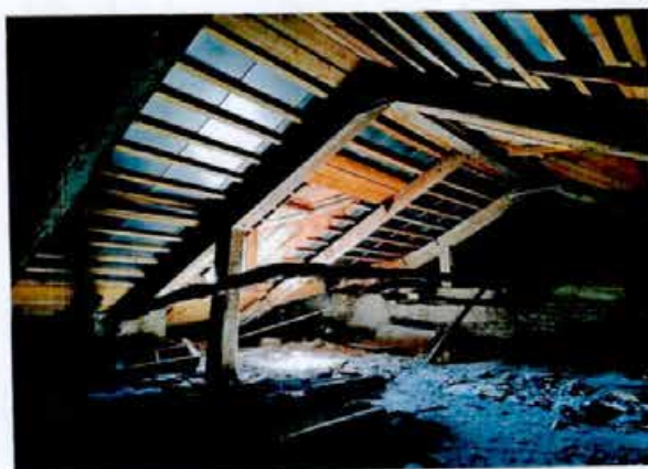
21. Стропильная система.
