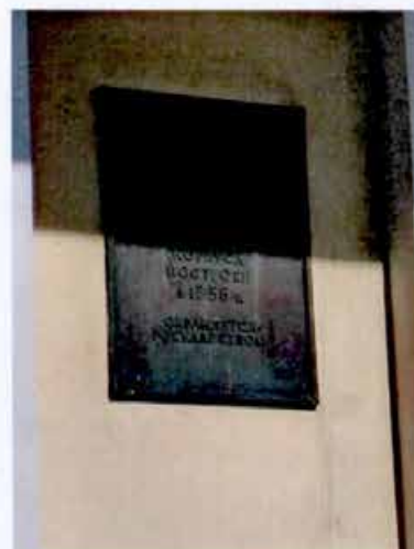
3.Фрагмент южного фасада объекта культурного наследия. Информационная табличка.
