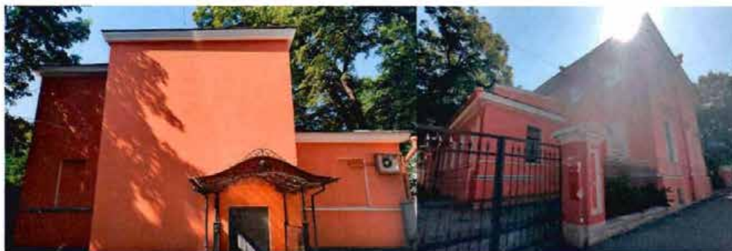
3. Северо-восточный фасад объекта культурного наследия.
