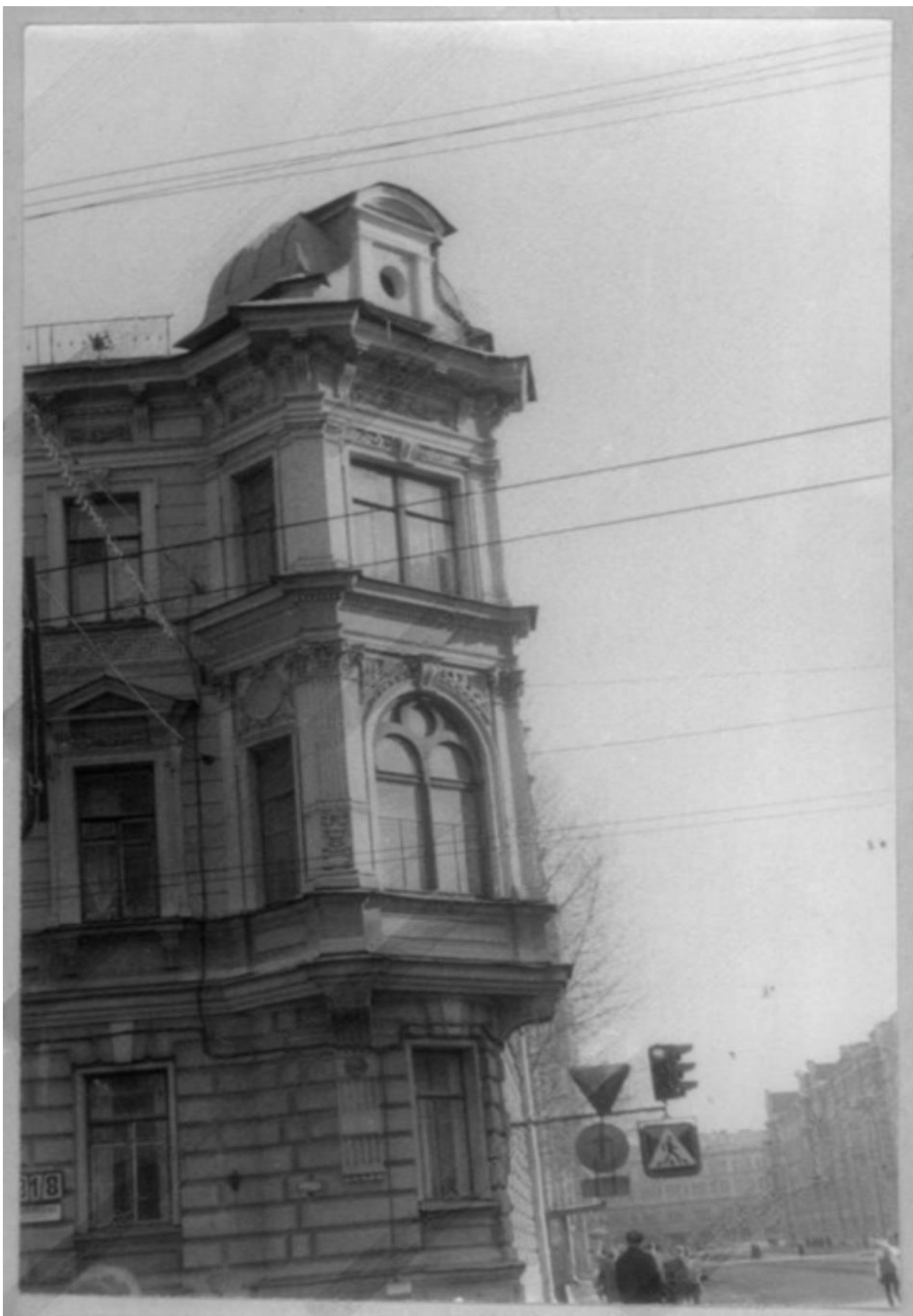
Илл.18. Фрагмент углового фасада бывшего доходного дома М. А. Панова на пересечении 2-й Советской улицы и Суворовского проспекта.. Дата:1983г. Автор:Громов С.Р. Источник:ЦГАКФФД СПб Ар 120960
