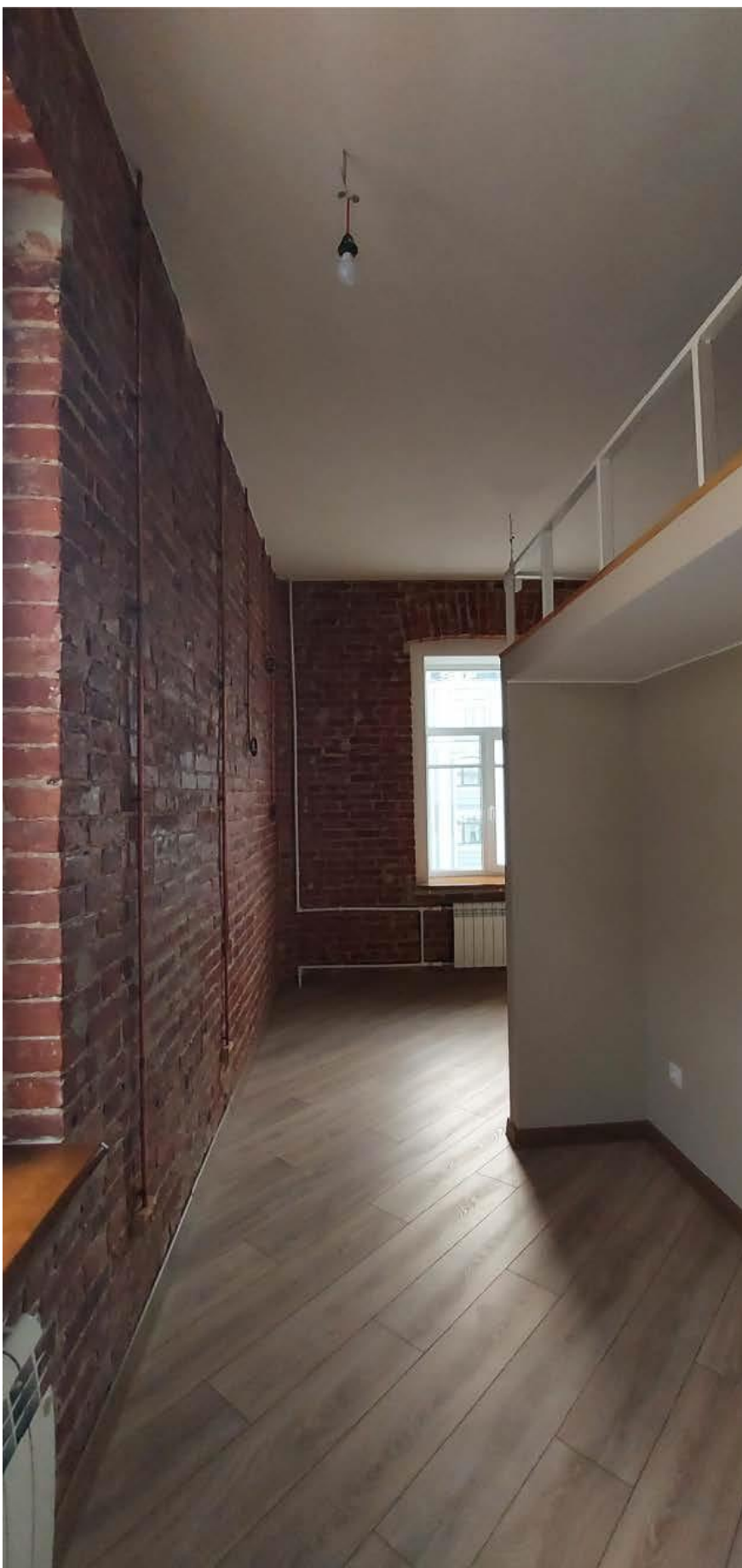
Фото 10. Помещение 8 (по плану ПИБ, после приспособления – помещение 3).
