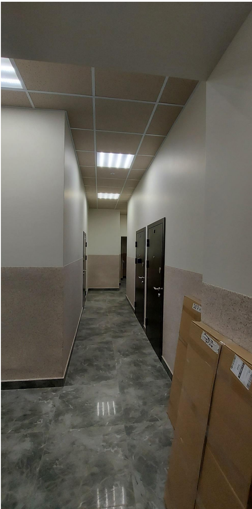
Фото.4 Выявленный объект культурного наследия «Дом М.А.Панова», Санкт-Петербург, Суворовский пр., 1/8, лит.А. Помещение 1 (по плану ПИБ), коридор.
