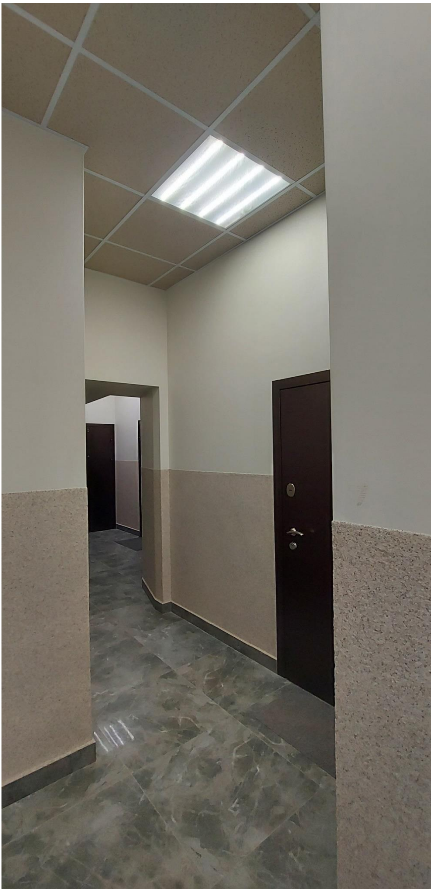
Фото.5 Выявленный объект культурного наследия «Дом М.А.Панова», Санкт-Петербург, Суворовский пр., 1/8, лит.А. Помещение 7 (по плану ПИБ), коридор.
